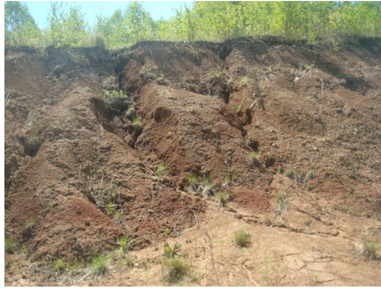
Фото 27.2020.0016. Плоскостная эрозия, 116 км автодороги А370 Хабаровский край
