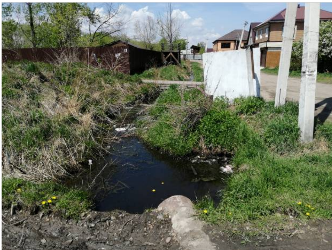
Фото 38.2020.0003. Дренажная канава по ул. Главная Кировская в п. Кирова Ново-Ленинского района г. Иркутска, Иркутская область
