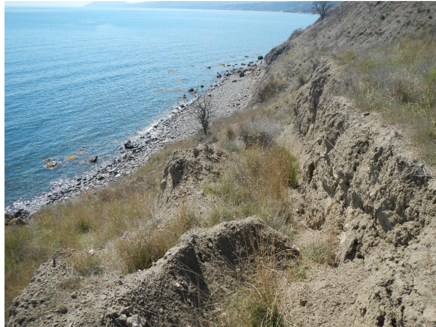
Фото 91.2020.0046. Формирование блоков обрушения по трещине закола в зоне обрушения в абразионной части оползня в районе с. Солнечногорское, городской округ Алушта, приводящее к деформациям дорожного полотна. Республика Крым. (Фото ГАУ РК «ЦЛАТИ»)
