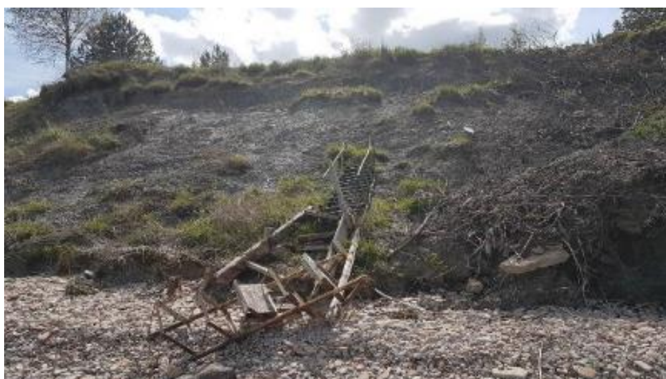
Фото 53.2020.0004 Разрушенная в результате активизации оползневого процесса лестница в д. Пустош. Новгородская область
