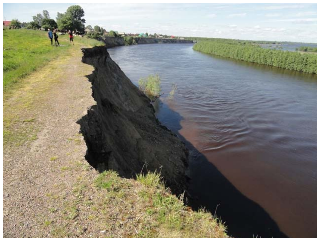
Фото 70.2020.0011. Разрушение берегового уступа в районе ул. Центральная, 32, с. Каргасок, Каргасокский район, Томская область
