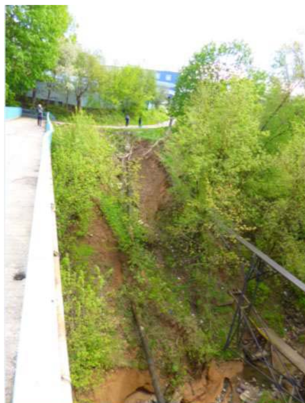
Фото 67.2020.0001 Сместившийся оползневой блок породы по ул. Запольная, г. Смоленск, Смоленская область
