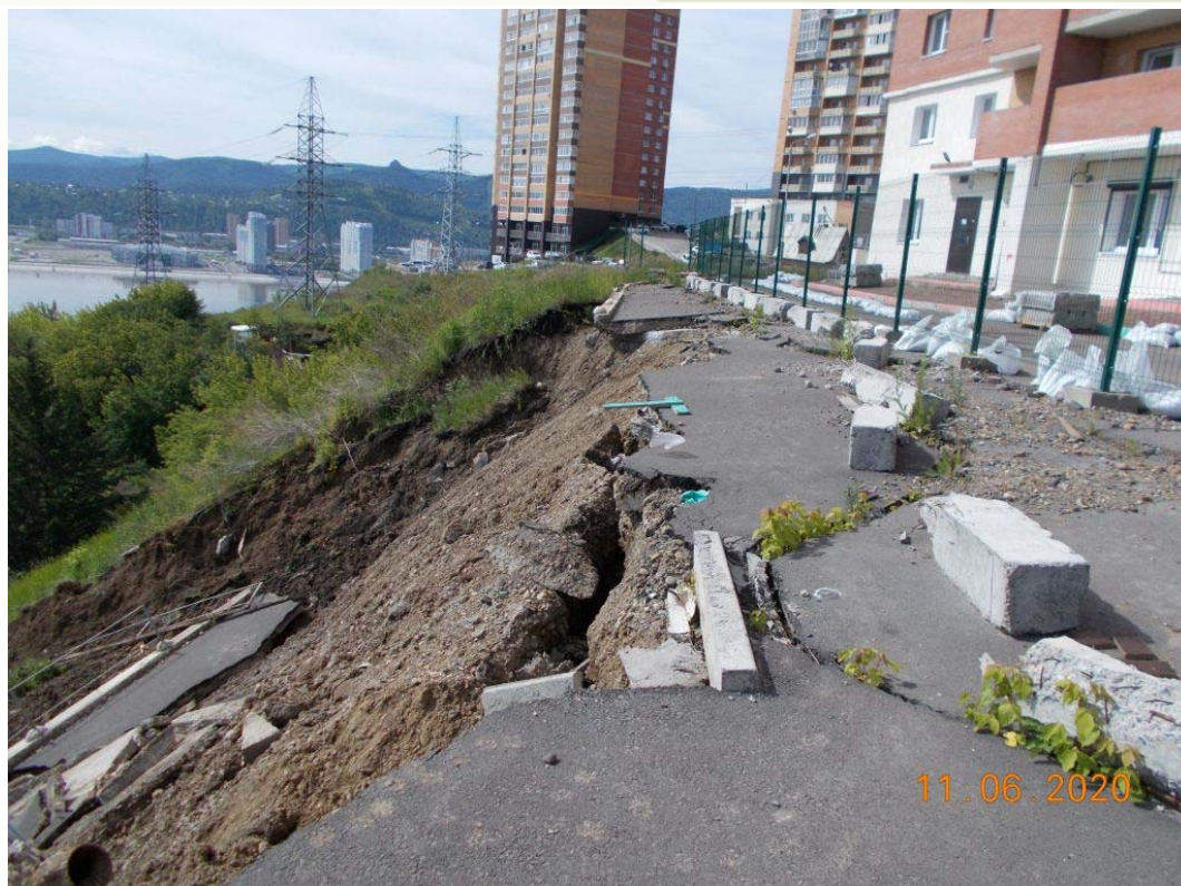
Фото 24.2020.0003. Оползень вблизи жилого дома по ул. 2-я Огородная, 22а, Октябрьский район, г. Красноярск
