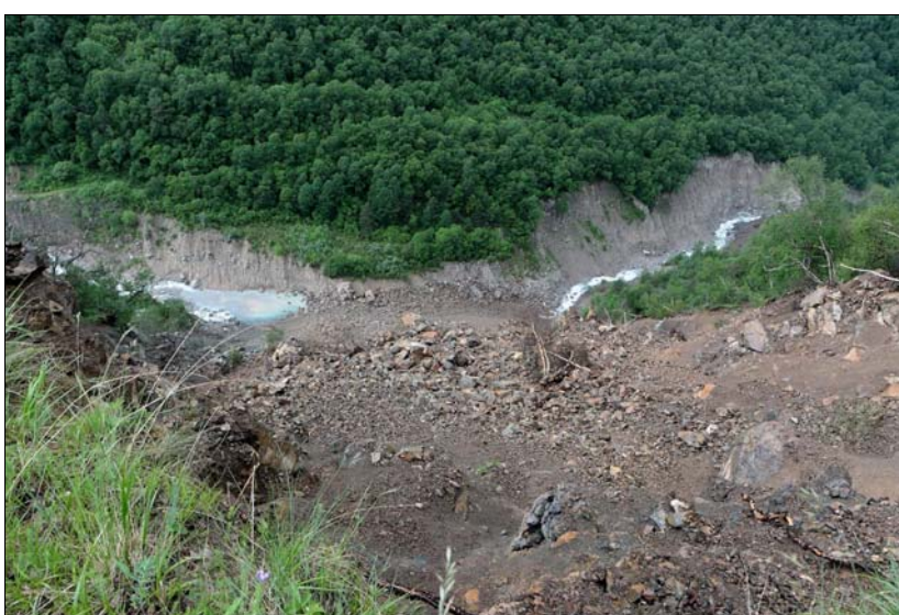
Фото 07.2020.0005. Вид с оползневой бровки отрыва на южном фланге участка Бузулган. В центре снимка – оползневой завал в русле р. Герхожансу. Объем завала порядка 10 тыс. м 3 , протяженность около 100 м. Кабардино-Балкарская Республика. (Фото ООО «Каббалкгеомониторинг»).
