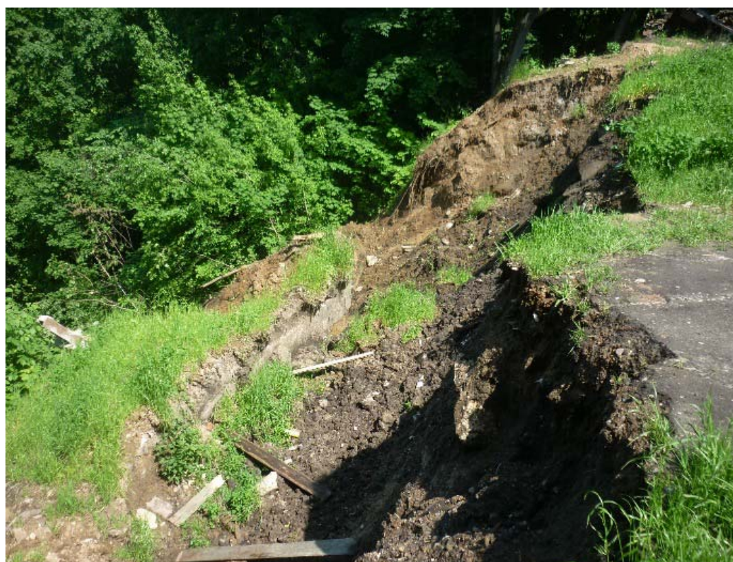
Фото 77.2020.0001 Оползень в пределах Филевской излучины, рядом с домом отдыха «Крылатское», на правом берегу р. Москвы, г. Москва
