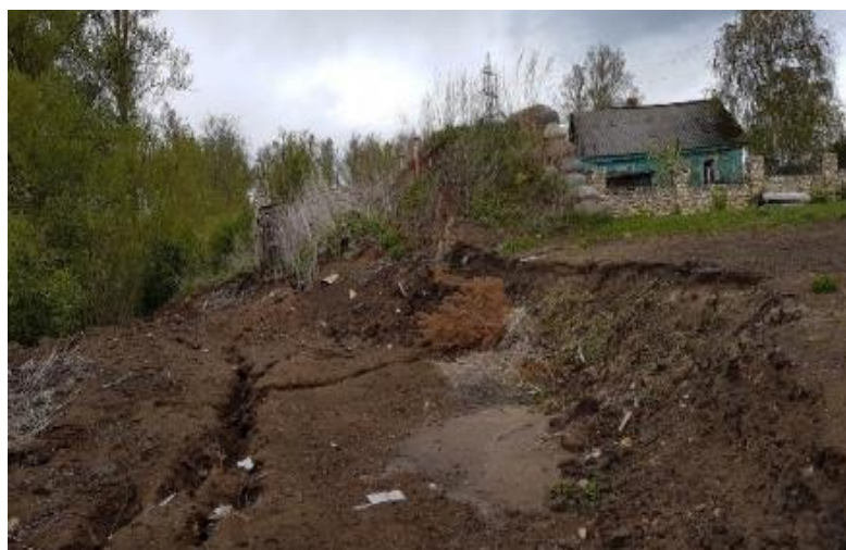
Фото 53.2020.0009 Развивающийся оползневой процесс на правом берегу р. Мста в г. Боровичи. Новгородская область
