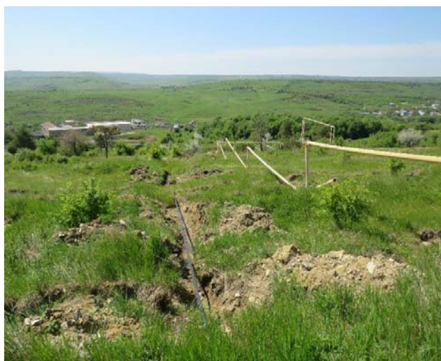
Фото 26.2020.01 Деформация газопровода на участке 50м и грунтовой дороги на участке 40м вследствие активизации оползневого процесса в г. Ставрополь Ленинского района. Ставропольский край. (Фото ГБУ СК «Ставропольский ЦГЭМ» и ЦГЭМ»)
