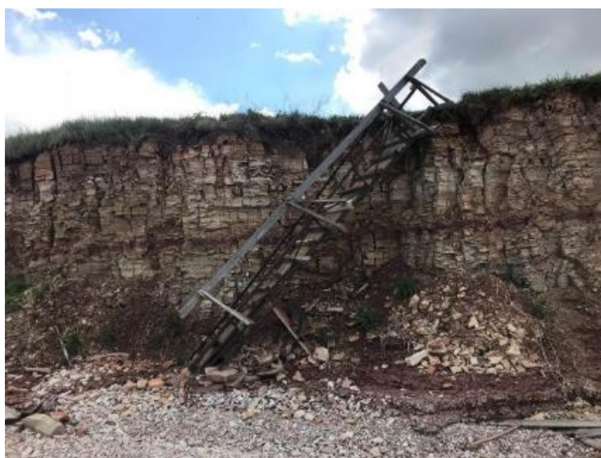
Фото 53.2020.0002 Обрушенные горные породы и деформированная спусковая лестница на береговом склоне вдоль ул. Заводская в д. Устрека. Новгородская область
