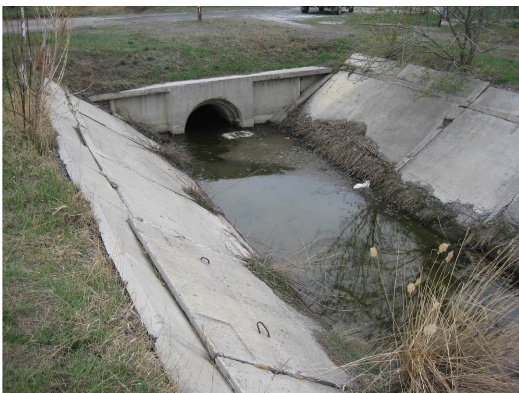
Фото 54.2020.0004. Боковой канал по ул. Поверхностные и грунтовые воды находятся на одной отметке - ниже дневной поверхности около 1 м. С. Баган, Баганский район, Новосибирская область
