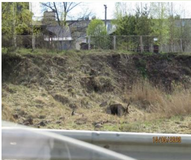
Фото 47.2020.0003 Развивающийся оползневой процесс на правом берегу реки Тосна в пределах территории расположения церкви царя Николая в г. Никольское Тосненского района Ленинградской области
