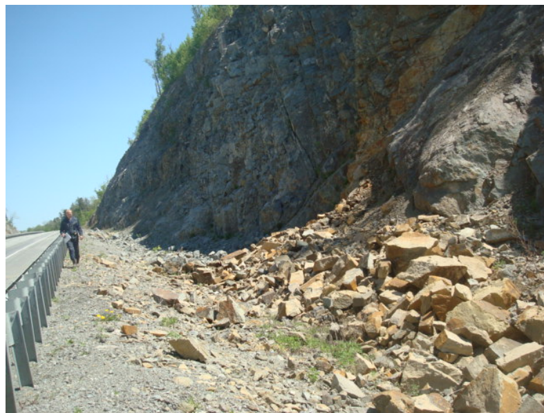
Фото 27.2020.0016. Обвально-осыпные процессы на 146 км автодороге А370 Хабаровский край
