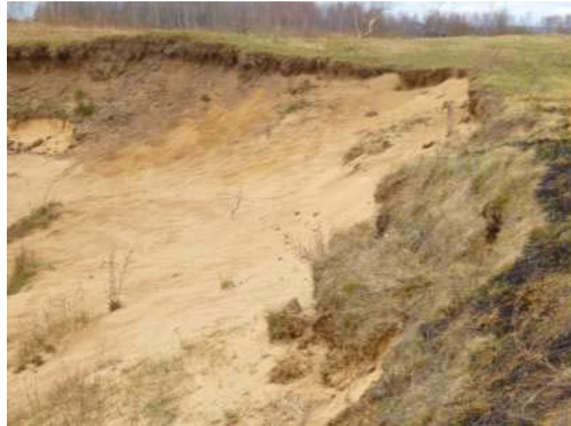
Фото 67.2020.0004 Активная часть оползневого склона 0,5 км на юго.запад от д. Дорогобуж, Дорогобужский район, Смоленская область
