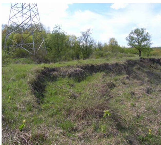
Фото 21.2020.0003. Оползневой процесс у линии ЛЭП с. Порецкое, Чувашская Республика
