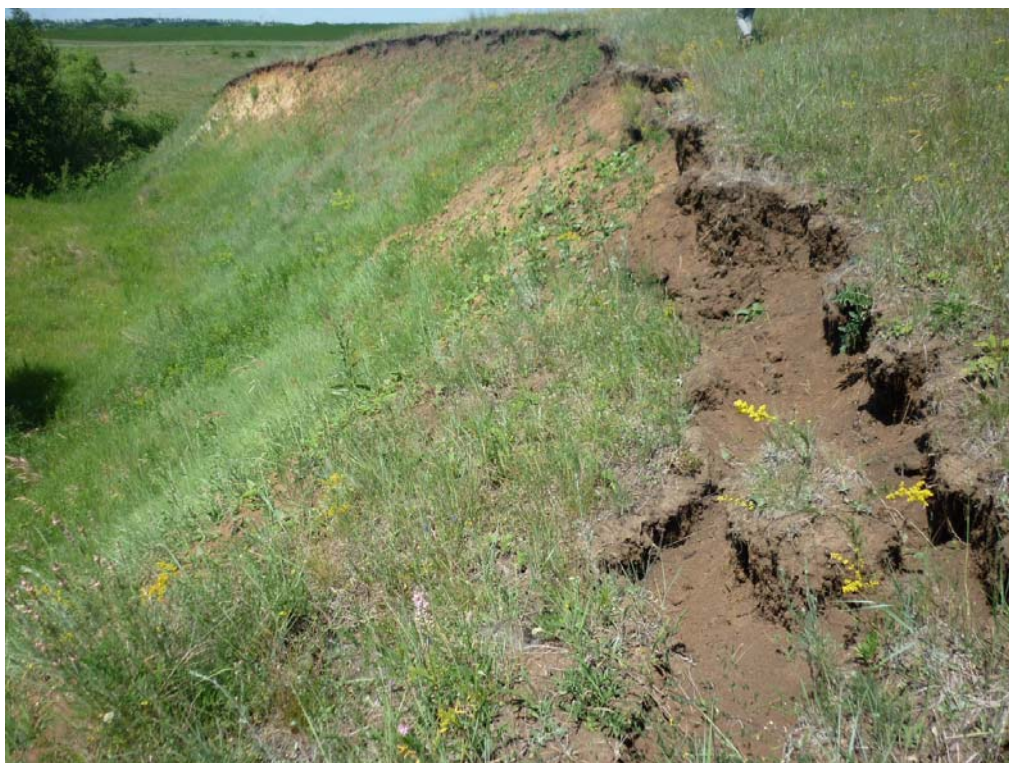
Фото 31.2020.0003 Сместившийся оползневой блок пород в с. Воробьево, Алексеевский район, Белгородская область
