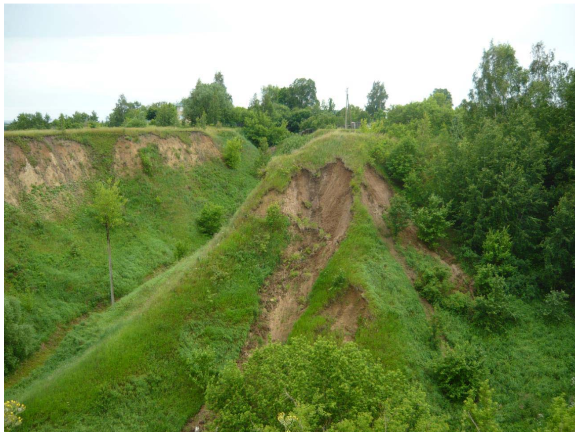
Фото 62.2020.0002 Сместившийся оползневой блок породы в с. Троица, Спасский район, Рязанская область
