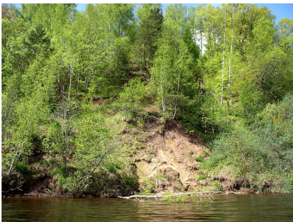
Фото 76.2020.0003 Обвальнo-осыпной склон в п. Алтыново, Угличский район, Ярославская область
