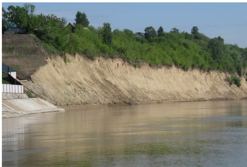
Фото 22.2020.0001. Эрозионный оползень на левом береговом склоне долины р. Оби, напротив СНТ «Энергетик». г. Барнаул, Алтайский край
