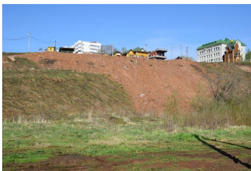
Фото 43.2020.0007. Выполненная отсыпка грунта на склон р. Вятка, г. Киров, Кировская область
