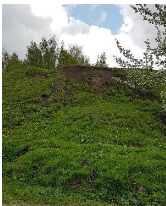
Фото 53.2020.0006 Развивающийся оползневой процесс на склоне оборонительного сооружения Окольного города вдоль ул. Черняховского в г. Великий. Новгородская область
