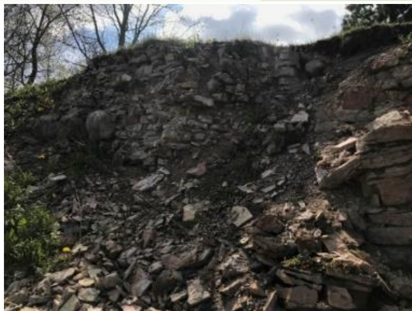
Фото 53.2020.0003 Проявление осыпного процесса и остатки фундамента церкви Святого Духа на склоне. Новгородская область
