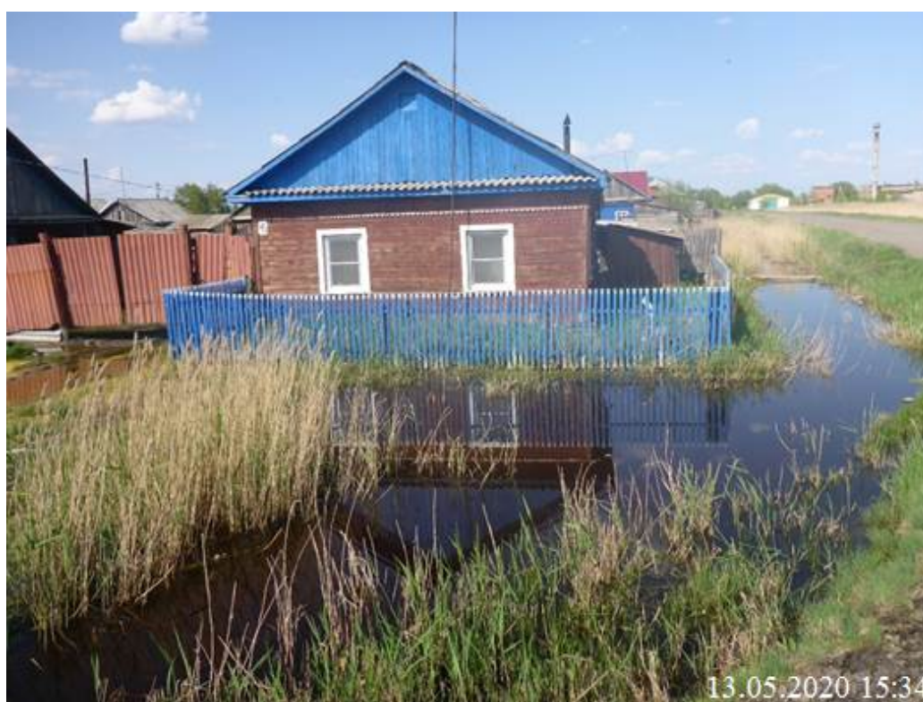
13.05.2020 15:34 Фото 55.2020.0003. Подтопление юго-восточной окраины г. Называевск, Омская область
