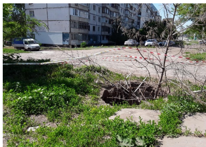
Фото 63.2020.0003. Карстовый провал между 9-ти этажными домами №№ 41/1 и 43 по ул. Дачная, г.Самара, Самарская область
