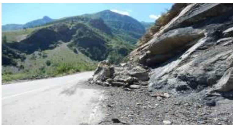
Фото 05.2020.14. Проявление обвального процесса в 0,8 км южнее по дороге от устья р.Ратлуб. Республика Дагестан. (Фото ООО «Даггеомониторинг»).
