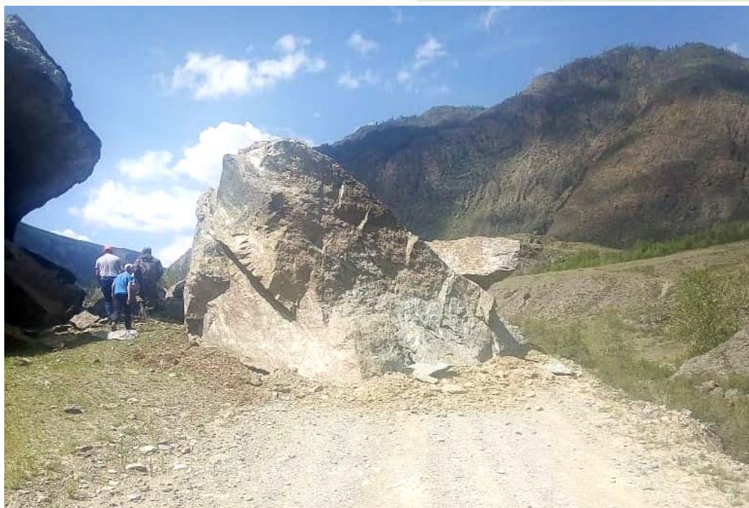
Фото 04.2020.0009. Обвал скальных пород на участке автодороги (41 км) Балыктуоль – Балыкча 1.06.2020 г. Улаганский район, Республика Алтай
