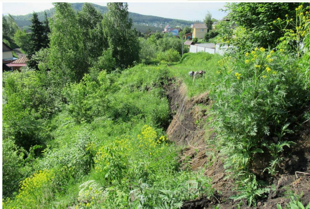
Фото 04.2020.0004. Надоползневый уступ оползня № 19. Усадьба по ул. Гагарина, 45 полностью разрушена, в опасной близости от бровки – усадьба № 43/2, г. Горно-Алтайск, Республика Алтай
