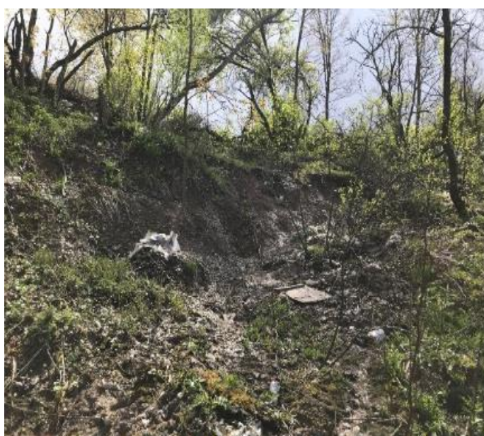
Фото 53.2020.0008 Развивающийся оползневой процесс на правом берегу р. Кереть у кладбища в г. Чудово Чудовского района. Новгородская область
