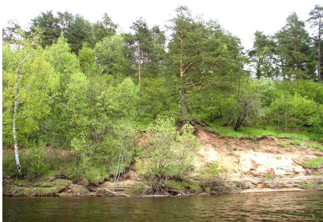
Фото 76.2020.0004 Сместившийся оползневой блок породы в п. Шашково, Рыбинский район, Ярославская область
