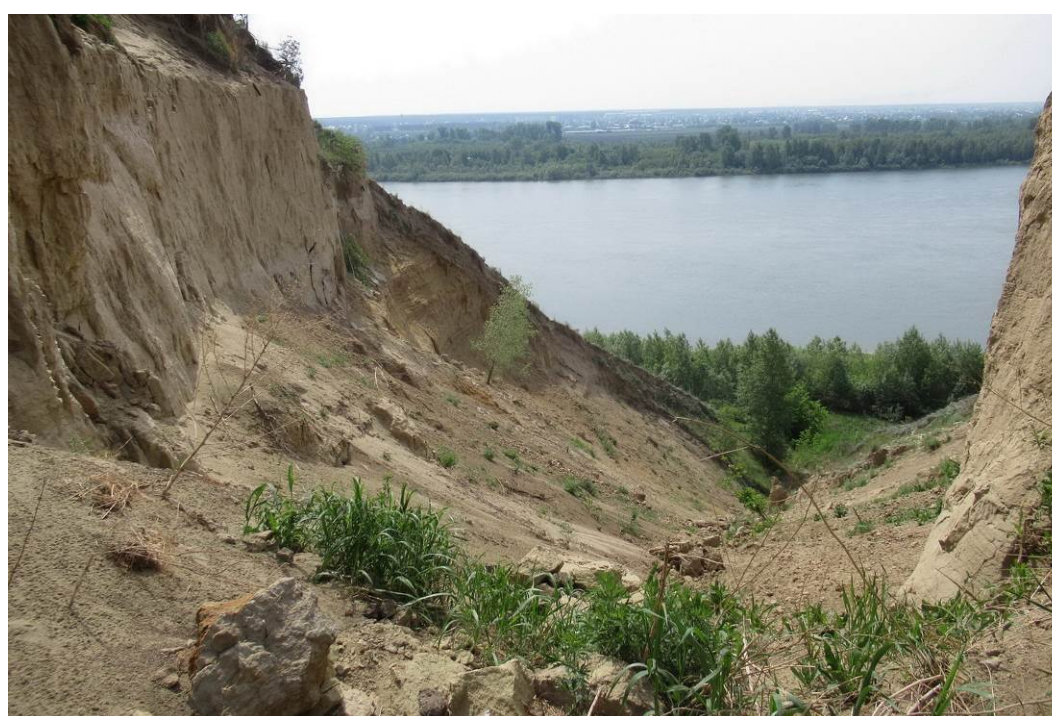
Фото 22.2020.0015. Эрозионный оползень на правом борту долины р. Бии на пункте Бийский в г. Бийск, Алтайский край
