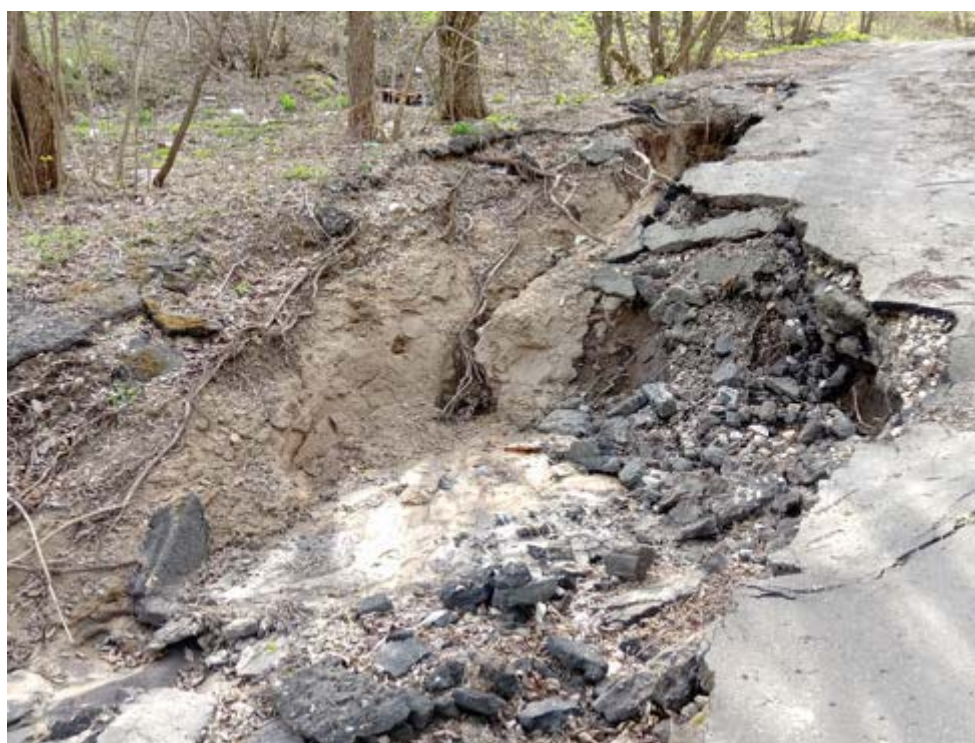
Фото 32.2020.0002 Разрушенное асфальтированное дорожное покрытие, в результате активизации процесса овражной эрозии на территории памятника природы овраг «Верхний Судок», Советский район, г. Брянск, Брянская область
