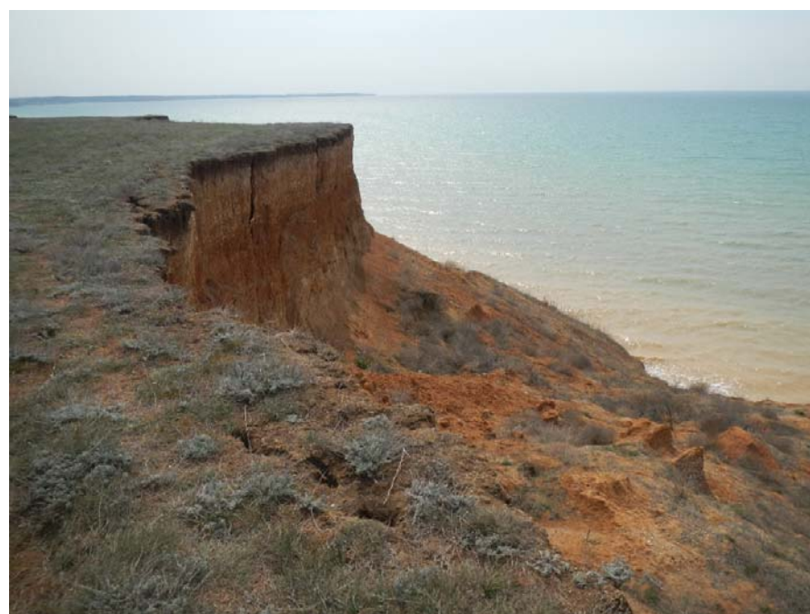
Фото 91.2020.0005. Вдоль стенки срыва сформированы трещины закола с образованием новых блоков обрушения в районе п. Береговое Бахчисарайского района. Республика Крым. (Фото ГАУ РК «ЦЛТИ»)
