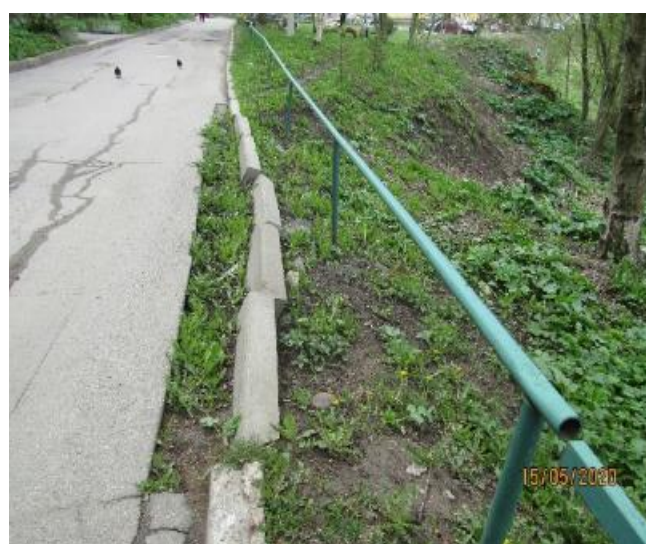
Фото 47.2020.0002 Воздействие оползневого процесса вблизи многоквартирного на придомовую территорию в пгт. Войскорово Тосненского района. Ленинградская область
