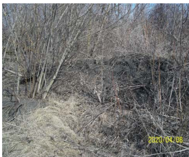
Фото 13.2020.0001. Оползневой цирк на языке оползня за домом № 6 по ул. Набережная, п. Ромоданово, Республика Мордовия
