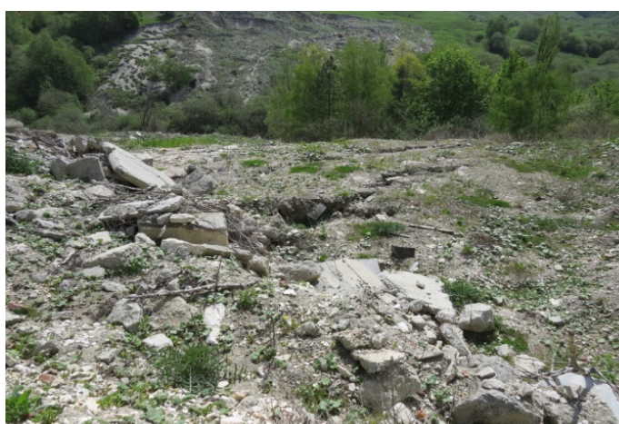
Фото 26.2020.0019. Активный оползень в левом борту р. Белая (г. Кисловодск). Ставропольский край. (Фото филиала «Южный региональный центр ГМСН» ФГБУ «Гидроспецгеология»)
