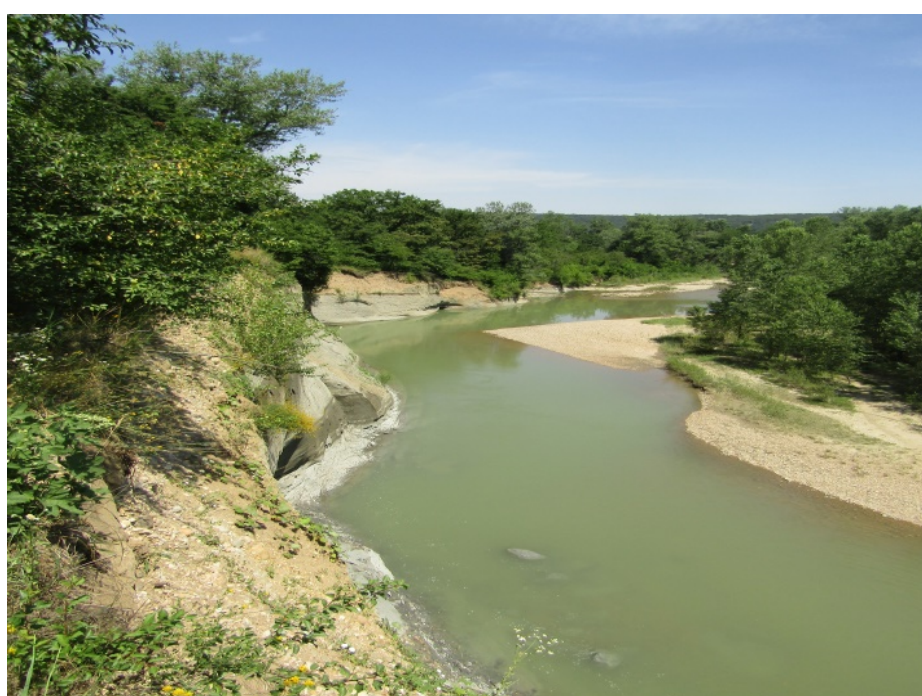
Фото 01.2020.0008. Отрезок оползневого уступа на левом берегу р. Курджипс в пределах жилой застройки пос. Табачный (ул. Короткая, 3). В створе с домовладением выявлена свежая оползневая активность. Майкопский район, Республика Адыгея
