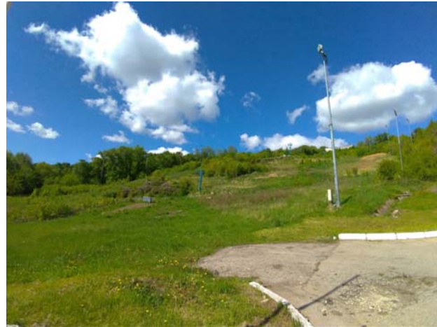
Фото 73.2020.0002. Оползневой процесс около фуникулера, Ленинский р-н, г. Ульяновск, Ульяновская область
