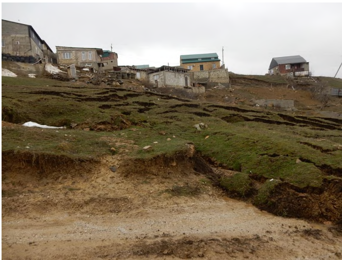
Фото 05.2021.0004 Активное проявление оползневого процесса. Карабудахкентский район СНТ "Агачаульский", северо-западный склон г. Тарки-Тау.
