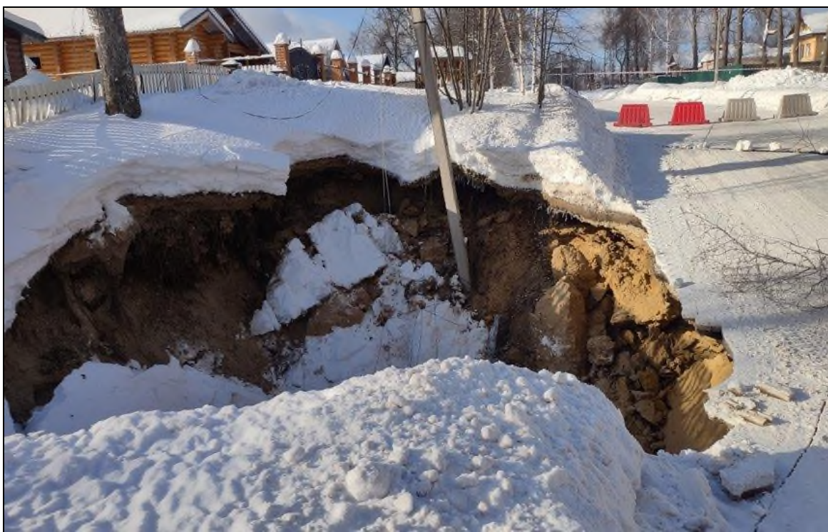
Фото 52.2021.0001 Сместившаяся в карстовый провал опора ЛЭП. Павловский район, Нижегородская область
