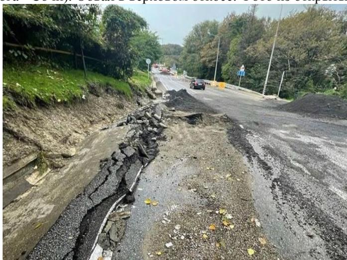
Фото 23.2021.0120. МО г.Сочи, Лазаревский район, п.Мамайский перевал, 168 км +850 м федеральной трассы А147 (Джубга - Сочи). Разрушение дорожного полотна в ходе активизации оползневых процессов. Фото из открытых источников СМИ.
