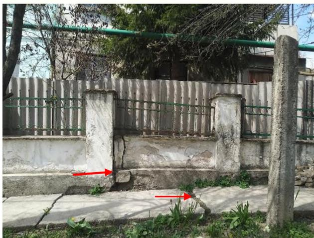
24.04.2021г. Трещины растяжения шириной до 4 см в ограждении и бетонной отмостке частного домовладения по ул. Б. Хохлова №39
