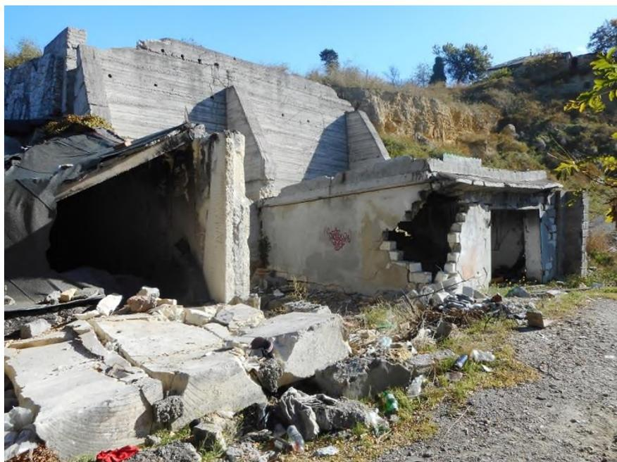
Фото № 67.2021.0002-2. Правый борт оползня. Полуразрушенные и разрушенные гаражные боксы. Деформация подпорной стенки, осыпавшийся грунт из-за подпорной стены. Трещины в подпорной стене, стена потеряла свои конструктивные свойства. Смещения фундамента гаража. Разрушение гаражных боксов продолжается (октябрь 2021 г.)
