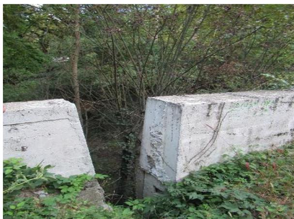
Фото 91.2021.0042. Сместившийся блок низовой подпорной стены
