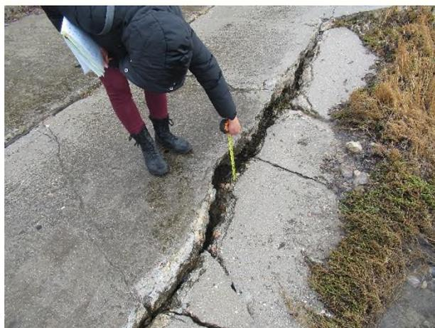
Фото 91.2021.00030. Провал бетонного покрытия набережной 2,5x1,0 м глубиной до 18 см (у гидротехнической стены до 26 см). С 13.08.21г. по 13.10.21 г. размеры провала увеличились
