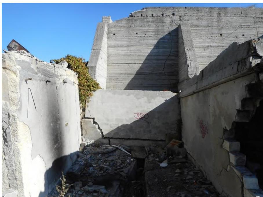
Фото № 67.2021.0002-3. Трещины в подпорной стене, стена потеряла свои конструктивные свойства. Ул. Теннисная- ж.д. 67-1110-0004 (октябрь 2021 г.)
