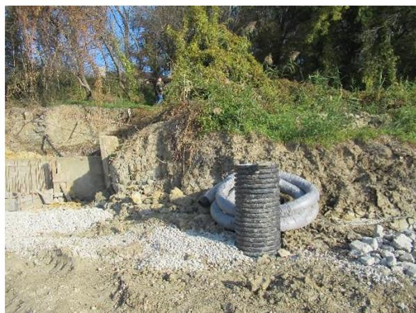
Фото 91.2021.0041. Свежий срыв в головной части оползня, высотой до 2,0 м в непосредственной близости от грунтовой дороги и жилых построек. Срыв образовался после проведения первого круга обследований 30.06.2021 г. Ширина активного очага 12,0 м. На момент обследования площадка расчищена, ведутся работы по укреплению склона.
