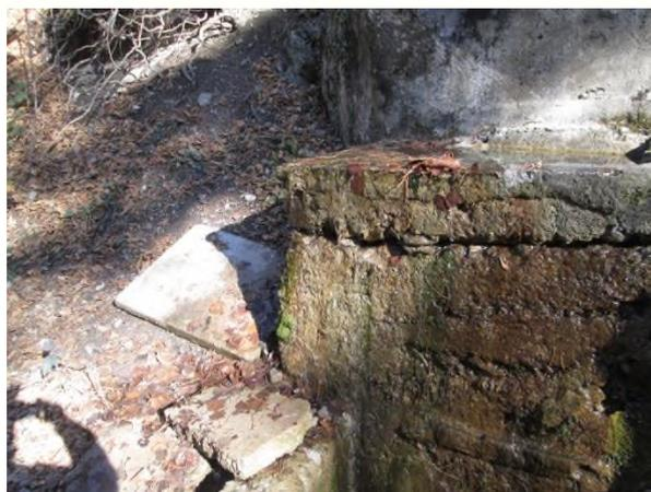
Фото 91.2021.0043. Источник №896. Водоотводящие каналы забиты, вода изливается через верх (~0,5л/сек) и течет по дороге, замачивает и размывает рельеф. Конструкция каптажа не нарушена
