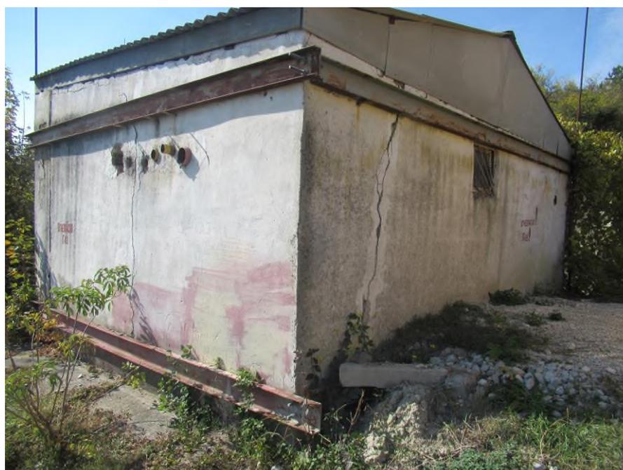
Фото 91.2021.00027. Многочисленные деформации газорегуляторного (ГРП) пункта, ширина деформаций до 5,0 см. По всему периметру здания установлена металлическая стяжка.
