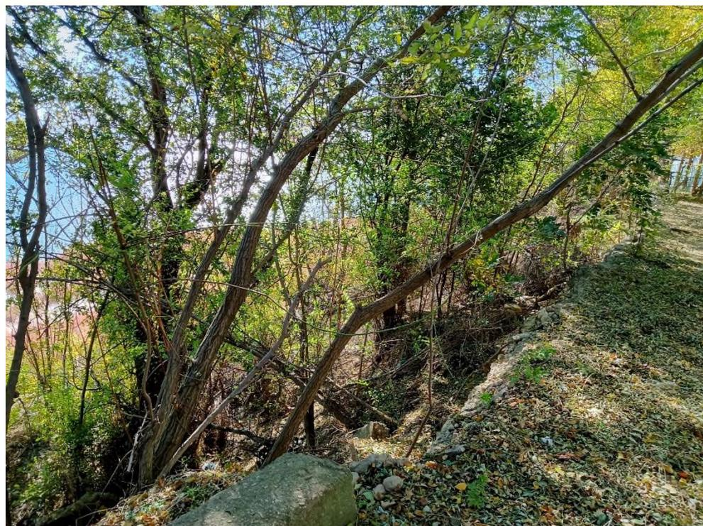
Фото 91.2021.0037. В результате проведения противооползневых работ в языковой части оползня, в головной части образовался свежий срыв и обрушение низового откоса пешеходной дорожки на протяжении 15,0 м.
