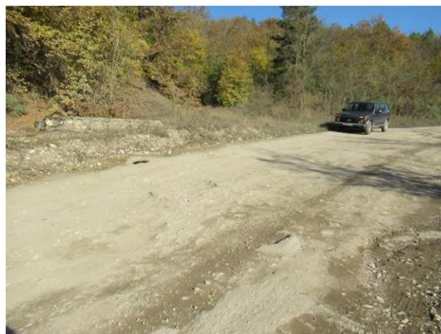
14.10.2021 г. Просадка автодороги до 0,2 м. Водоотводной колодец под автодорогой разрушен.
