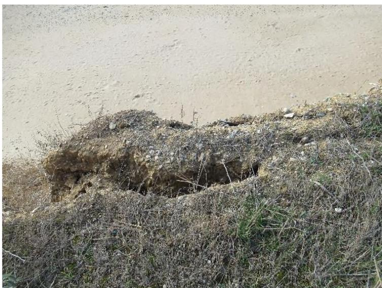
Фото 91.2021.0044. Блок обрушения шириной до 45,0 см по трещине закола шириной 10,0 – 40,0 см.
