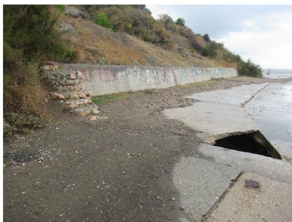
Фото 8. 91.2021.00031. Ранее проявившееся обрушение подпорной стены в языковой части оползня. Вновь образовавшийся провал в бетонном покрытии набережной. Подмыв гидротехнической стены и вынос обломочного материала на набережную.
