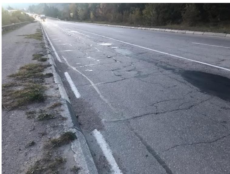
Фото 91.2021.00032. Пересечение активной части оползня и Южнобережного шоссе. У верхней обочины наблюдаются следы многочисленных деформаций дорожного полотна.
