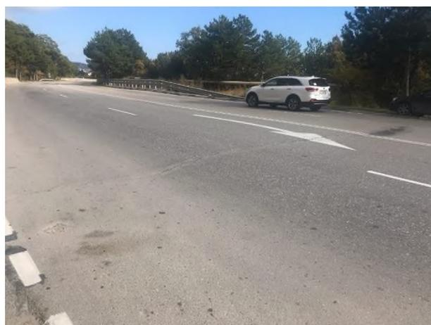
20.10.202 г. В верхней части левого борта оползня, в свежотремонтированном полотне автодороги «Ялта-Севастополь» наблюдается свежая трещина шириной до 0,02 м и просадка до 0,03 м.
