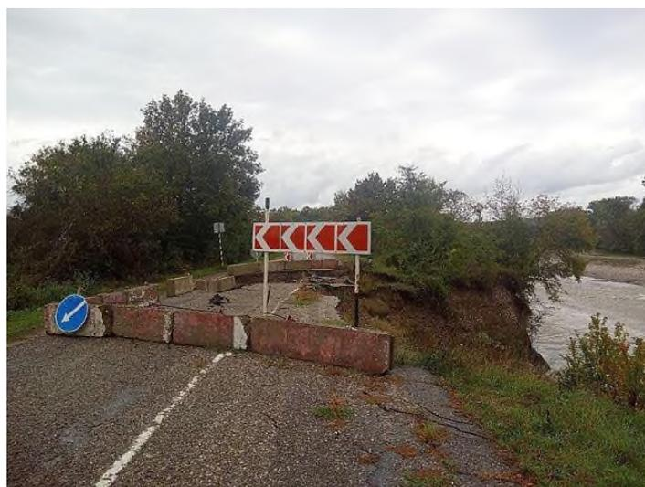
Фото 23.2021.0117. Апшеронский район. Разрушение дорожного полотна под воздействием оползневых процессов в низовом откосе автодороги г. Апшеронск – х. Горный Луч. Фото из открытых источников СМИ
