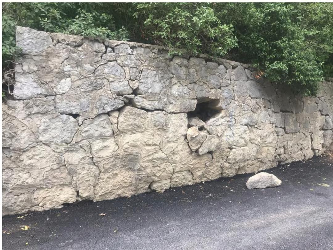
Фото 91.2021.0033. Свежие деформации подпорной бутовой стены с вывалом материала.
