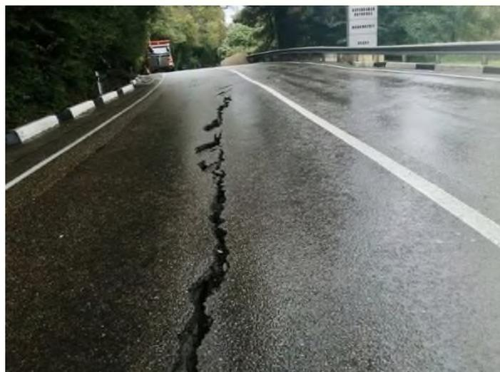
Фото 23.2021.0122. МО г. Сочи, Лазаревский район, к югу от п. Кучук-Дере. Разрушение участка федеральной трассы А 147 (Джубга - Сочи), под воздействием оползневых процессов. Фото из открытых источников СМИ.
