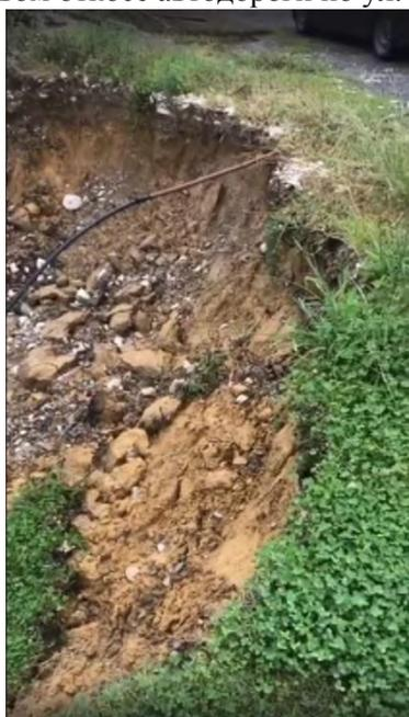
Фото. 23.2021.0127. МО г. Сочи, Адлерский район, с. Нижняя Шиловка. Активная стенка срыва в низовом откосе автодороги. Фото из открытых источников СМИ
