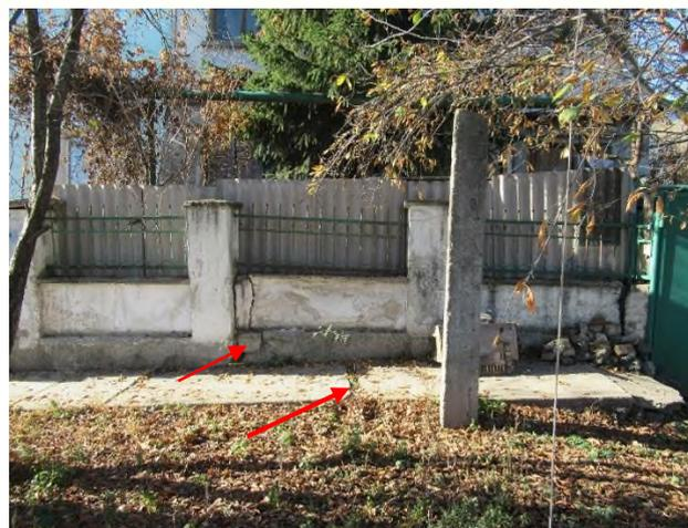
12.11.2021 г. Трещины растяжения до 10,0 см и сдвига шириной до 14 см в бетонной отмостке и ограждении частного дома по ул. Б. Хохлова № 39
