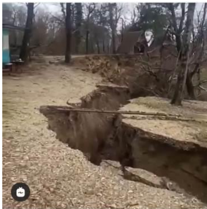
Фото 23.2022.0017. Сместившийся оползневой блок на береговом уступе Черного моря, в кемпинге «Лесная сказка». Туапсинский район, п. Агрива (к северо-востоку от с. Ольгинка).
