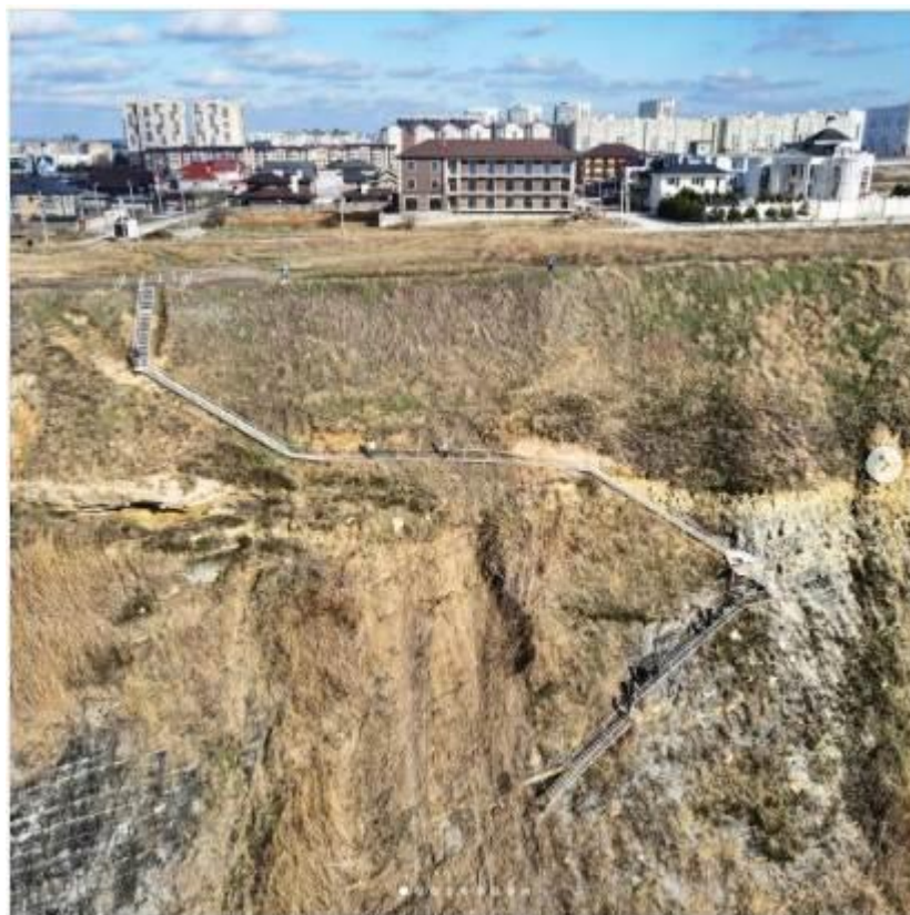
Фото 23.2022.0023. Разрушенная в результате активизации оползневой процесса часть лестницы, ведущая к пляжевой полосе. г. Анапа.
