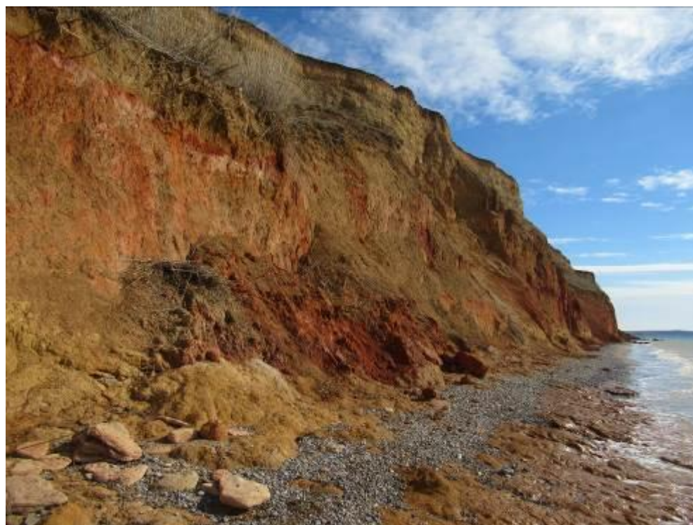
Фото 91.2022.0009. Горные породы, сместившиеся в результате активизации оползневого процесса. Бахчисарайский район, с. Береговое
