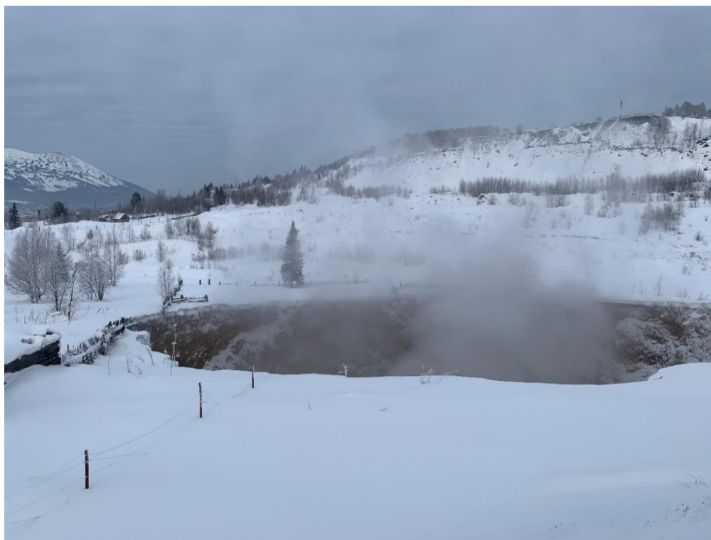
Фото 42.2022.0014. Обрушение поверхности над горной выработкой на ул. Первомайская, пгт. Шерегеш, Кемеровская область-Кузбасс
