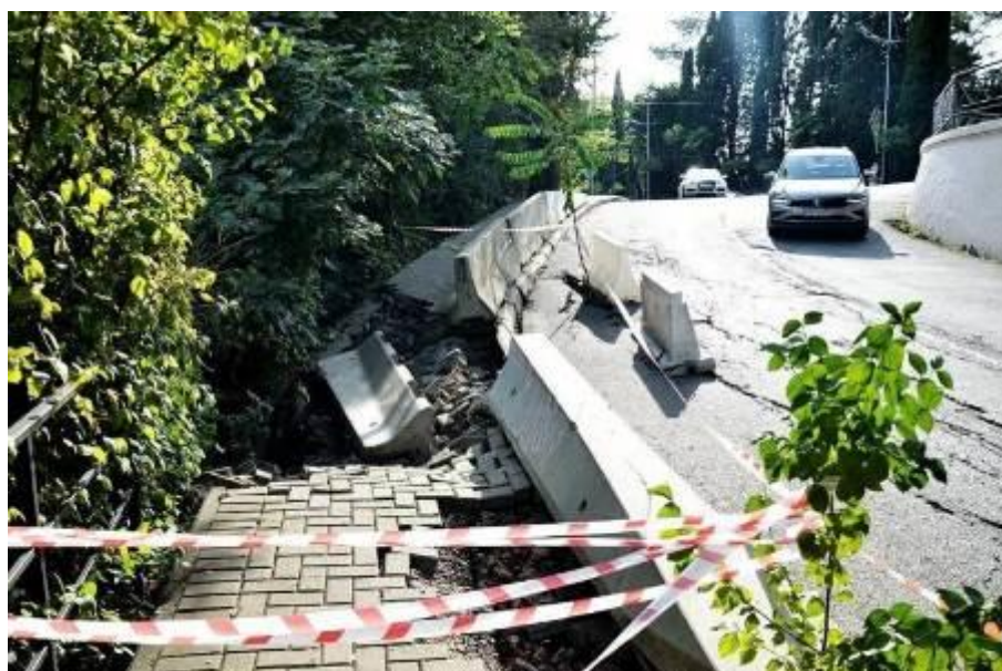
Фото 23.2022.0282. Активизация оползневого процесса в районе ул. Гагарина/Виноградная в Центральном районе МО Сочи
