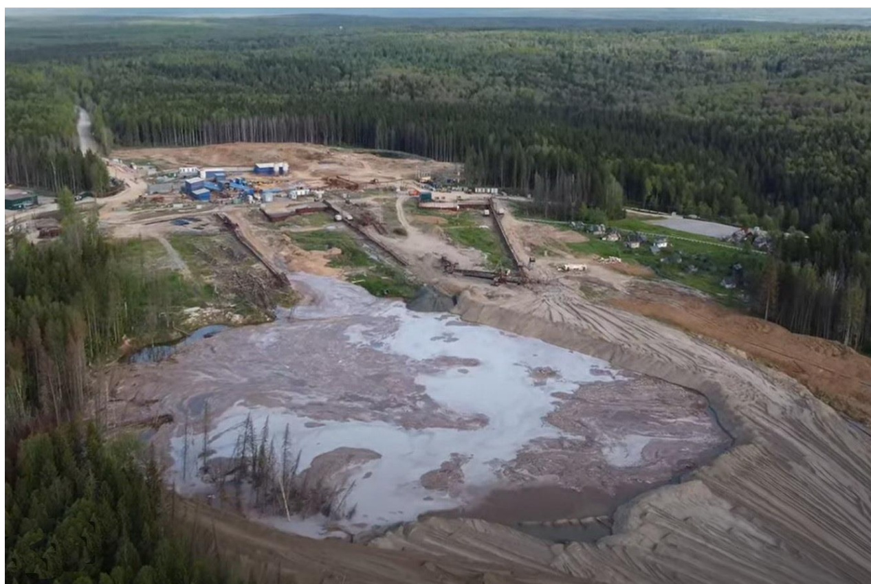
Фото 59.2022.0002. Провал на аварийном участке СКРУ-2, СНТ «Ключики»,
