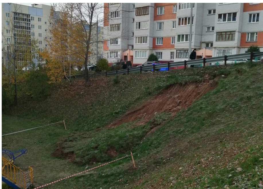
Фото 21.2022.0004. Развитие оползневого процесса на проспекте Тракторостроителей, 58 корп. 1. г. Чебоксары. Чувашская Республика
