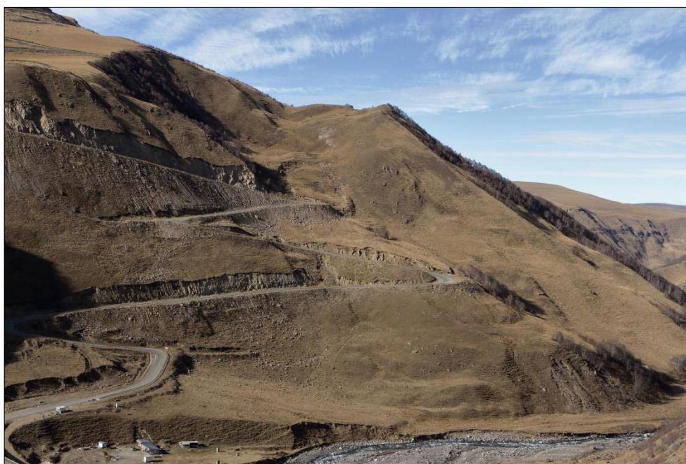
Фото 07.2022.0019. Активный участок оползня на откосе автодороги Кисловодск - Долина нарзанов - Джилысу в правом борту долины р. Харбас, Кабардино-Балкарская Республика, 27.10.2022г.
