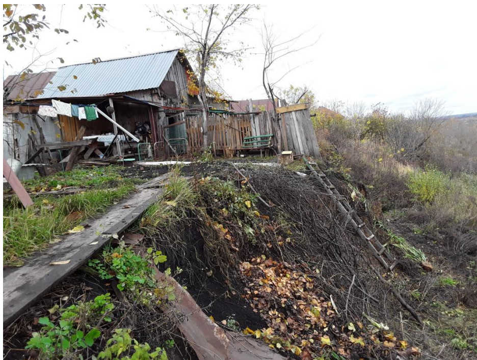
Фото 21.2022.0005. Оползневой процесс в с. Порецкое ул. Комсомольская. Чувашская Республика
