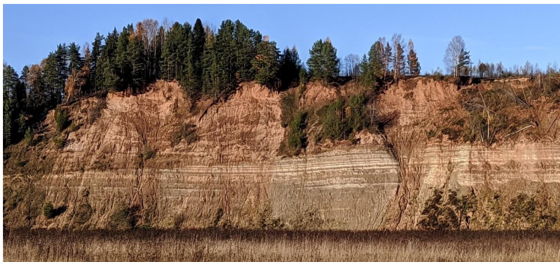
Фото 35.2022.0004. Общий вид оползневого склона вблизи д. Вострое, Нюксенский МО, Вологодская область
