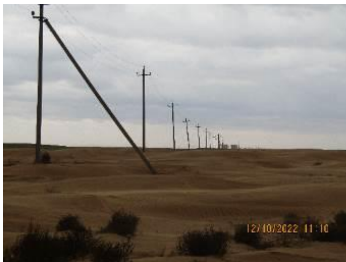
Фото 08.2022.0004. Черноземельский район, участок грунтовой а/дороги в 4,8 км северо-восточнее п. Цува, Республика Калмыкия
