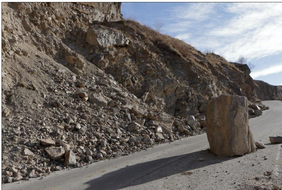
Фото 07.2022.0021 - Обвальный участок на верховом откосе а/д Кисловодск - Долина нарзанов - Джилысу в правом борту р. Малка, в 0,4 км выше моста, Кабардино-Балкарская Республика, 29.10.2022г.
