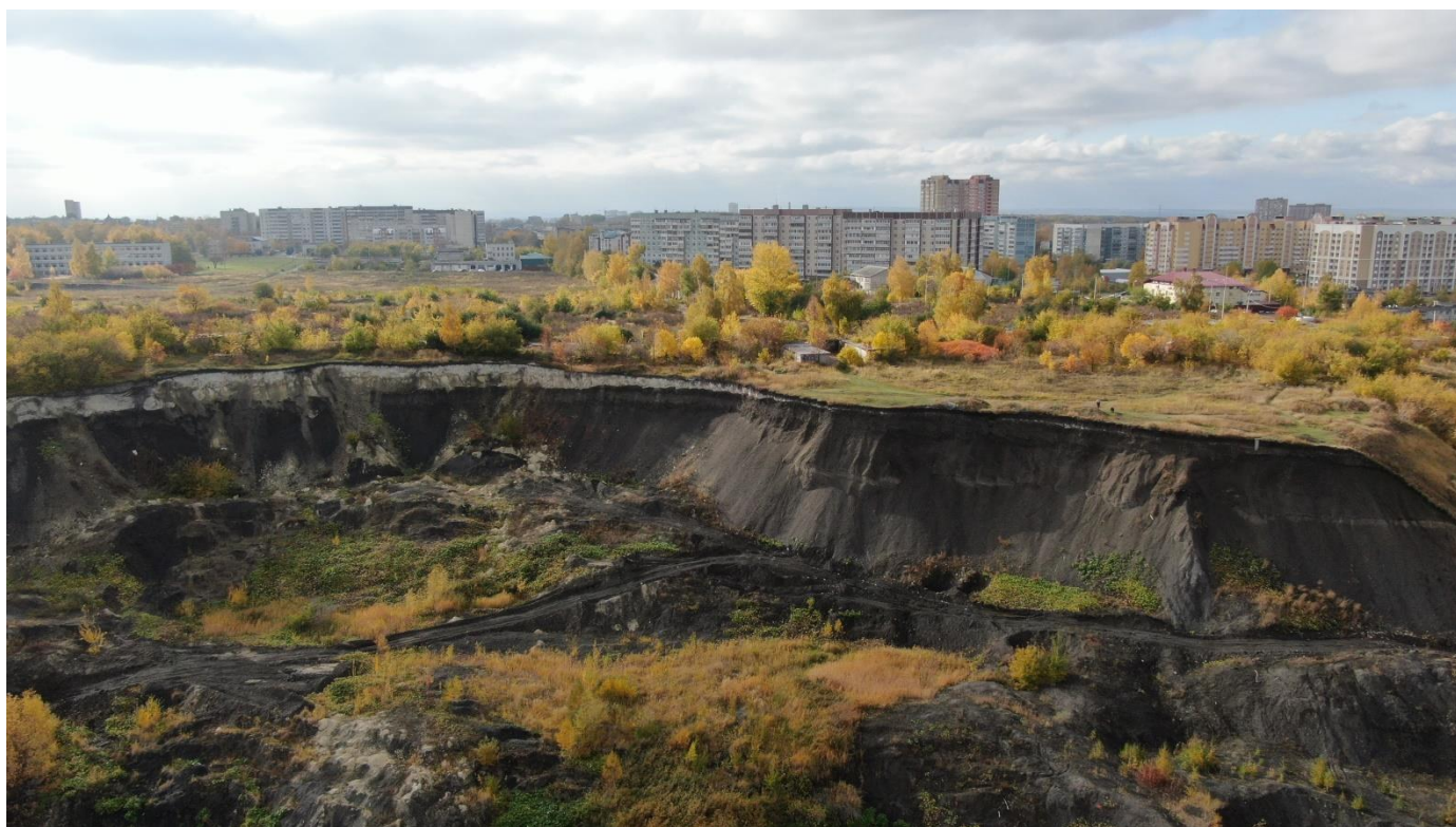
Фото 73.2022.0002. Общий вид оползневого смещения, оползневые срывы, уступы, застои грунтовых вод, ул. Мостостроителей, г. Ульяновск, Ульяновская область.
