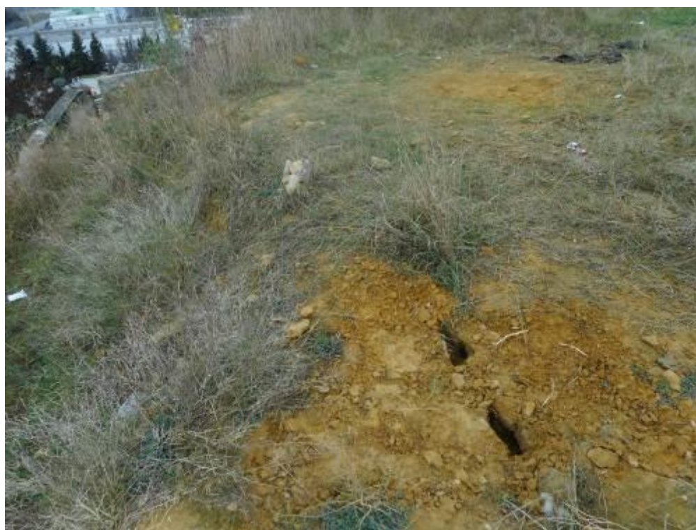
Фото № 67.2022.0002-3. Головной срыв. Трещина растяжения, г. Севастополь, Нахимовский район (ноябрь 2022 г.)
