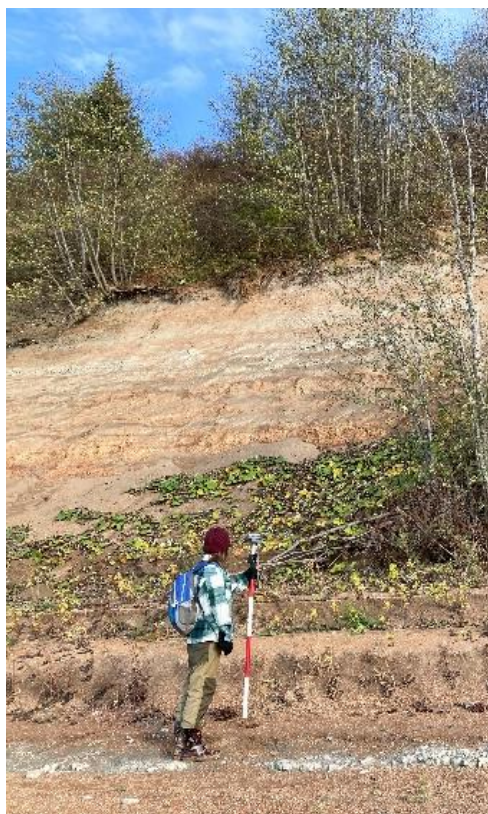
Фото 29-2022-0006. Оползень в г. Котлас, ДОК, ж/д станция Заовражье, Архангельская область, 14.10.2022 г.
