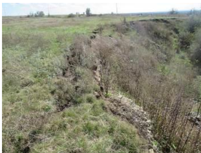
Фото 26.2022.0061. Оп. №302. Смещения на локальном участке в головной части оползня, свежие трещины растяжения, Северная окраина с.Козьминского Кочубеевского МО, Ставропольский край
