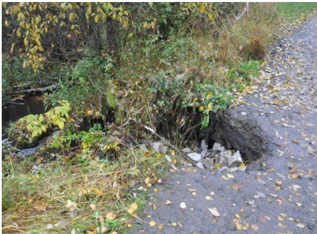
Фото 58.2022.0009. Новый размыв откоса автодороги, уч. «Сердобск». ЮВ окраина г. Сердобск, Пензенская область
