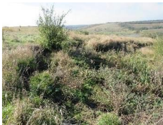
Фото 26.2022.0062. Оп. №287. Смещения на локальном участке в головной части оползня, свежие трещины растяжения, северная окраина с. Козьминского Кочубеевского МО, Ставропольский край
