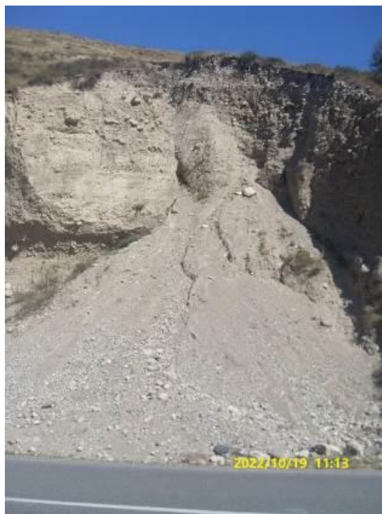
Фото 06.2022.0006. Республика Ингушетия. Джейрахский район. С. Джейрах. Осыпь объемом смещенных масс 480м 3
