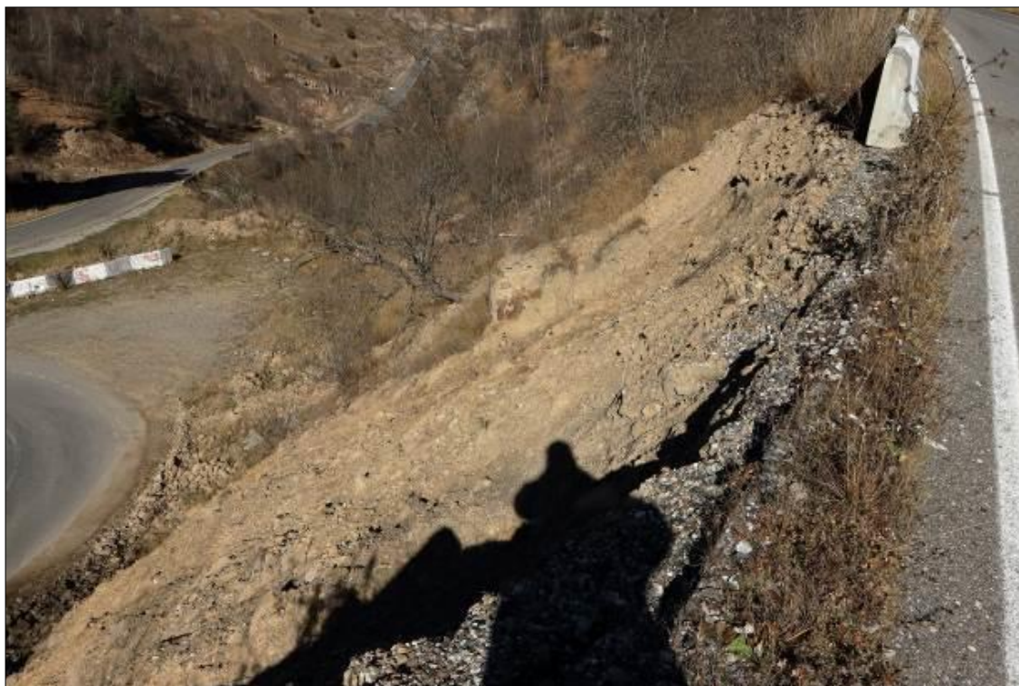
Фото 07.2022.0019. Активный участок оползня на откосе автодороги Кисловодск - Долина нарзанов - Джилысу в правом борту долины р. Харбас, Кабардино-Балкарская Республика, 27.10.2022г.
