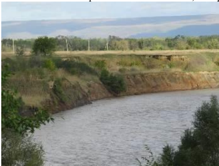
Фото 26.2022.0055. Оп. №1209. Смещения на локальных участках в откосах и у их основания, Кочубеевский МО, в 1,5 км севернее с. Кочубеевского, Ставропольский край
