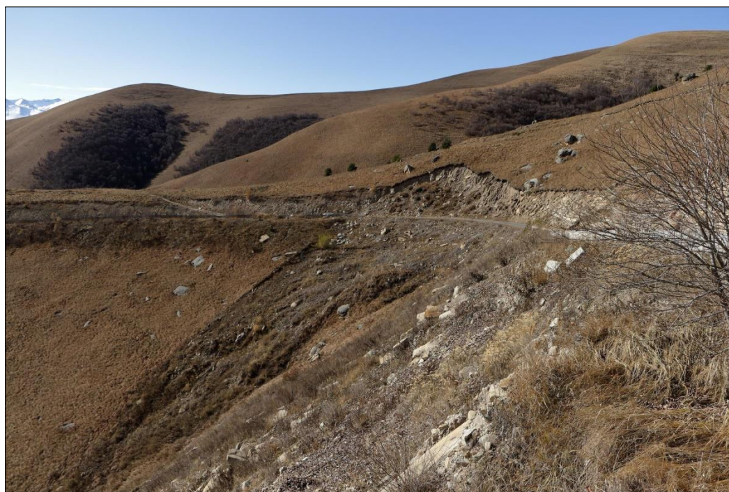
Фото 07.2022.0018. Оползень на нижнем откосе автодороги Кисловодск - Долина нарзанов - Джилысу на правом борту долины левого притока р. Харба, Зольский район, Кабардино-Балкарская Республика, 21.10.2022г.
