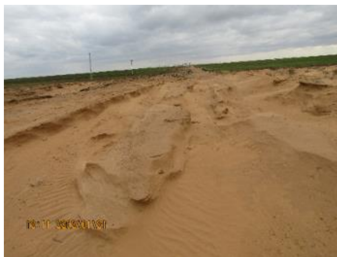
Фото 08.2022.0005. Черноземельский район, участок грунтовой а/дороги в 3,5 км северо-восточнее п. Цува, Республика Калмыкия
