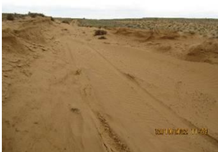
Фото 08.2022.0006. Черноземельский район, участок грунтовой а/дороги в 6,95 км восточнее п. Цува, Республика Калмыкия
