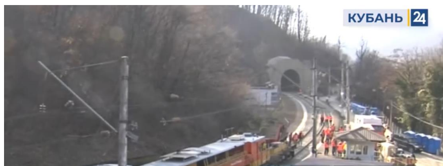
Фото 23-11-00214. Смещенные на ж/д пути горные породы, в результате активизации оползневой процесс в районе станции «Туапсе», Туапсинский район, Краснодарский край. Фото из открытых источников СМИ
