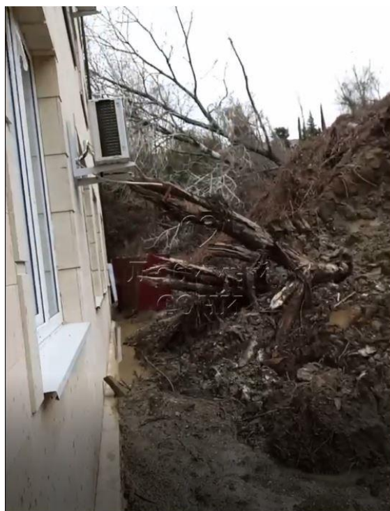
Фото 23-11-00355. Сместившиеся на придомовую территории гронные породы, в результате активизации оползневого процесса на территории МО г. Сочи, Хостинский район, ул. Яна Фабрициуса 66/6. Фото из открытых источников СМИ
