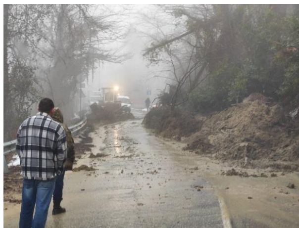
Фото 23-11-00351. Горные породы, сместившиеся на полотно автодороги, в результате активизации оползневого процесса в верховом откосе дороги 03К-452 МО г. Сочи, Адлерский район, участок дороги 03К-452, между селами Калиновое Озеро и Илларионовка. Фото из открытых источников СМИ
