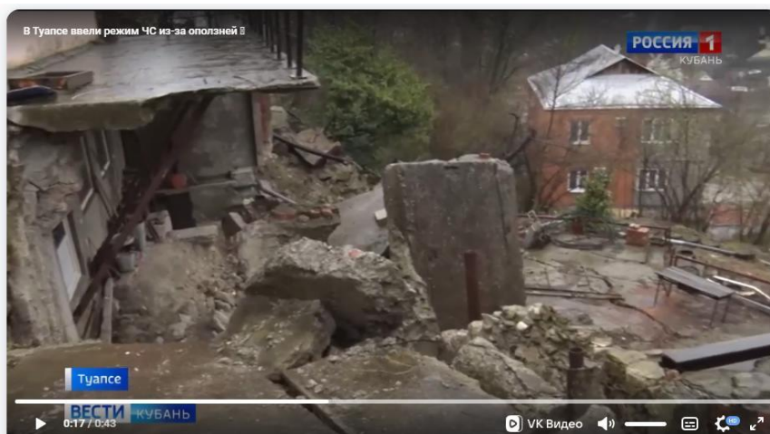
Фото 23-11-00193. Разрушенные в результате активизации оползневой процесс дома в г. Туапсе в микрорайоне Звездный ул. Пархоменко. Туапсинский район, Краснодарский край. Фото из открытых источников СМИ
