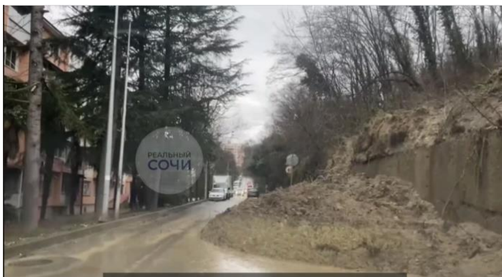
Фото 23-11-00359. Сместившиеся на полотно автодороги горные породы, в результате активизации оползневого процесса на территории МО г. Сочи, Адлерский район, мкр. Блиново, ул. Лесная, 13. Фото из открытых источников СМИ
