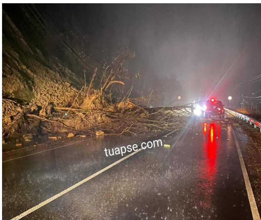
Фото 23-11-00209. Сместившиеся на полотно автодороги горные породы, в результате активизации оползневой процесс на 130-м км трассы 03К-003 (Туапсе-Майкоп). Туапсинский район, в 400 м к северо-востоку от с. Мессажай Фото из открытых источников СМИ
