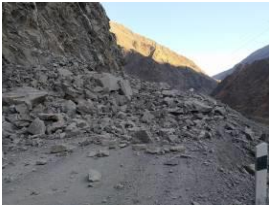
Фото 05-10-0001. Сместившиеся в результате активизации обвального процесса горные породы на 11-м км автодороги «Курукал–Хнов», в 2,7 км ЮЗ с. Смугул, Республика Дагестан.
