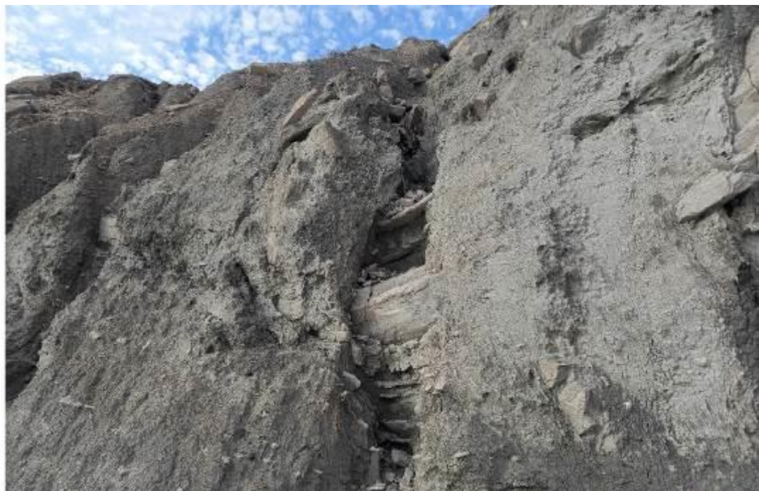
Фото 91-11-01836 Абразионный клиф между оползнями б/н и № 1836. Эрозионная промоина на всю высоту клифа.
