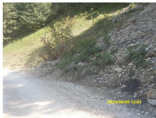
Фото 20-11-00576. с. Байтарки. Активизация оползня
