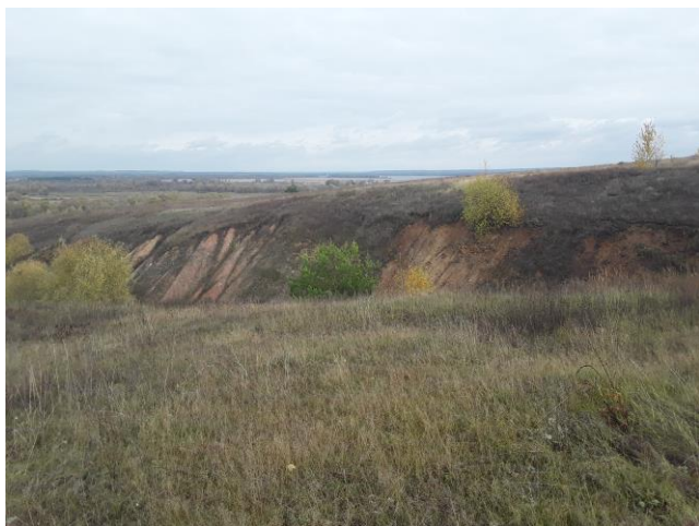
Фото 21.22.00037. Развитие овражной эрозии на восточной окраине д. Пиндиково Козловского мун. округа, Чувашская Республика
