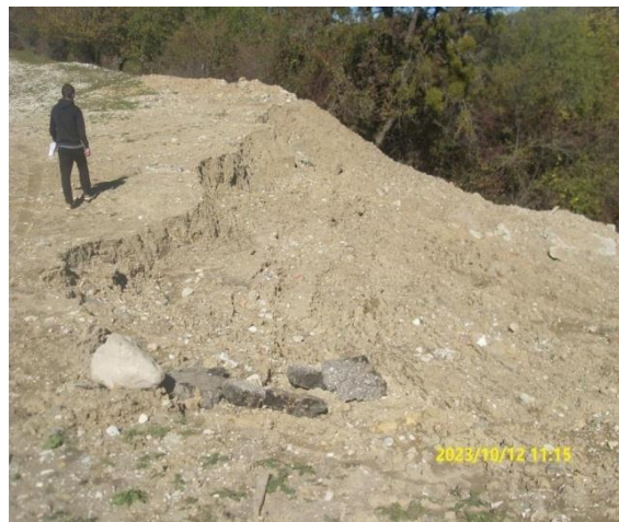
Фото 20-11-00517. С. Беной. Активизация оползня
