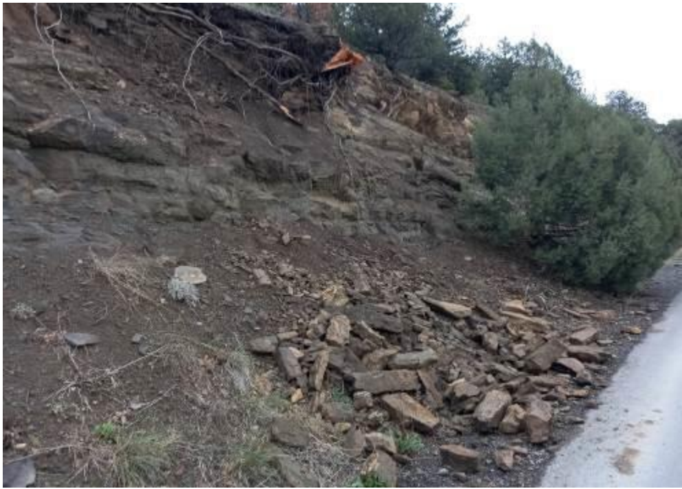
Фото 91-12-06002 Осыпь дресвяно-щебнисто-глинистой фракции в верхней обочине автодороги западнее с. Веселое.
