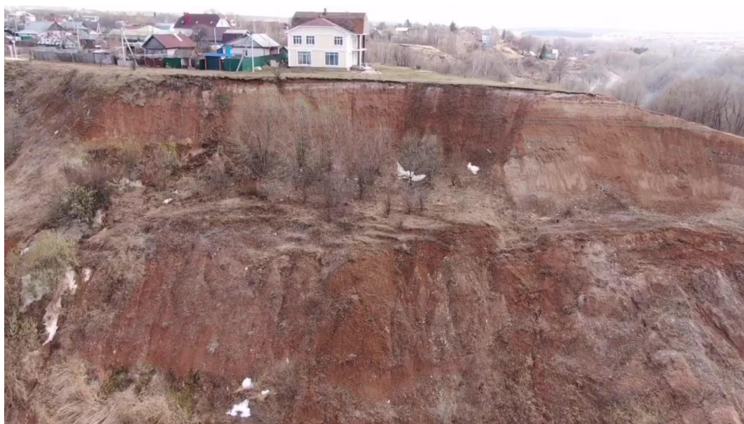
Фото. 21.11.00042. Развитие оползневого процесса в северной части г. Мариинский-Посад (государева гора) , Чувашская Республика
