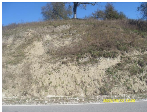
Фото 20-11-00368. С. Беной. Активизация оползня
