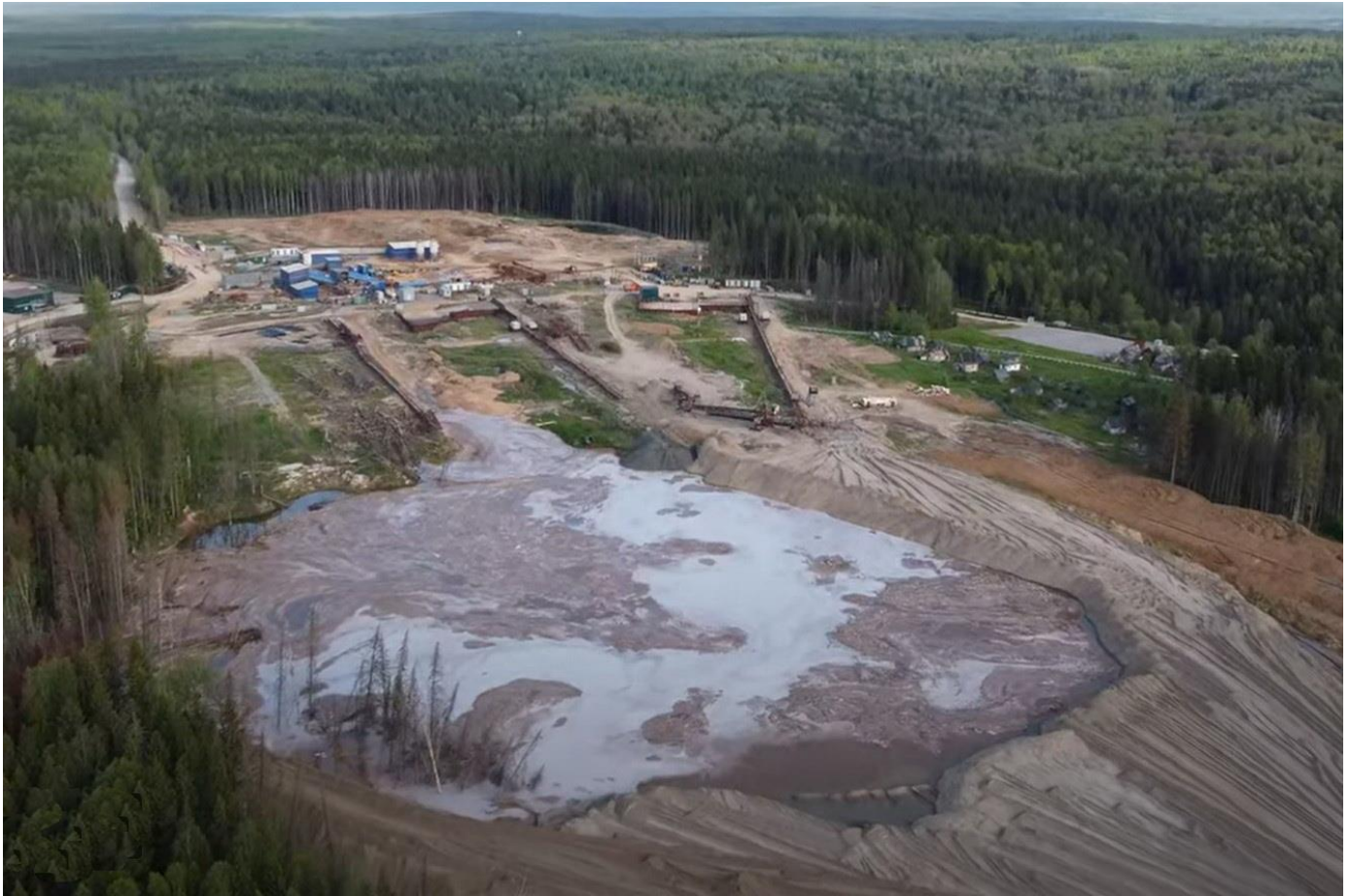
Фото 59-26-00010. Провал на аварийном участке СКРУ-2, июнь 2022 г., СНТ «Ключики», г. Соликамск, Пермский край.
