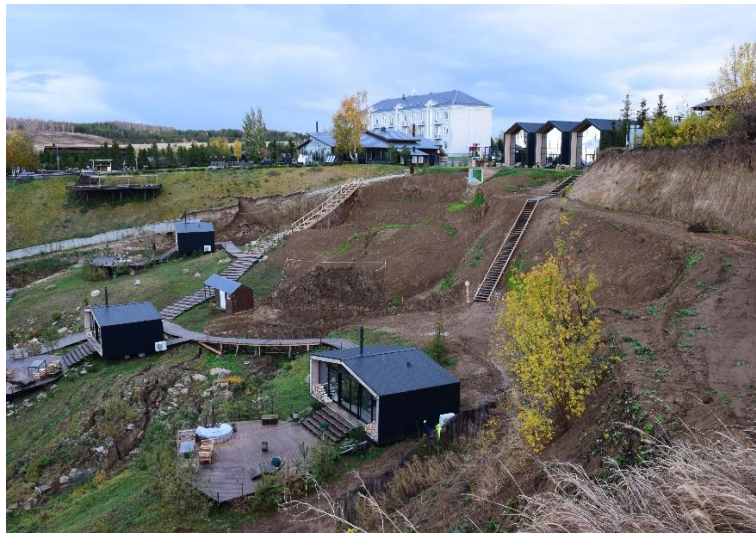
Фото 16-11-00058 Воздействие оползня скольжения на гостиничный комплекс «the Камский», октябрь 2023 г., пгт. Камское Устье, Камско – Устьинский муниципальный район, Республика Татарстан
