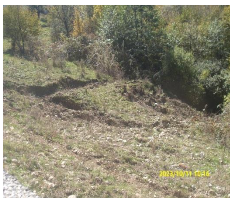
Фото 20-11-00581. С. Беной. Активизация оползня
