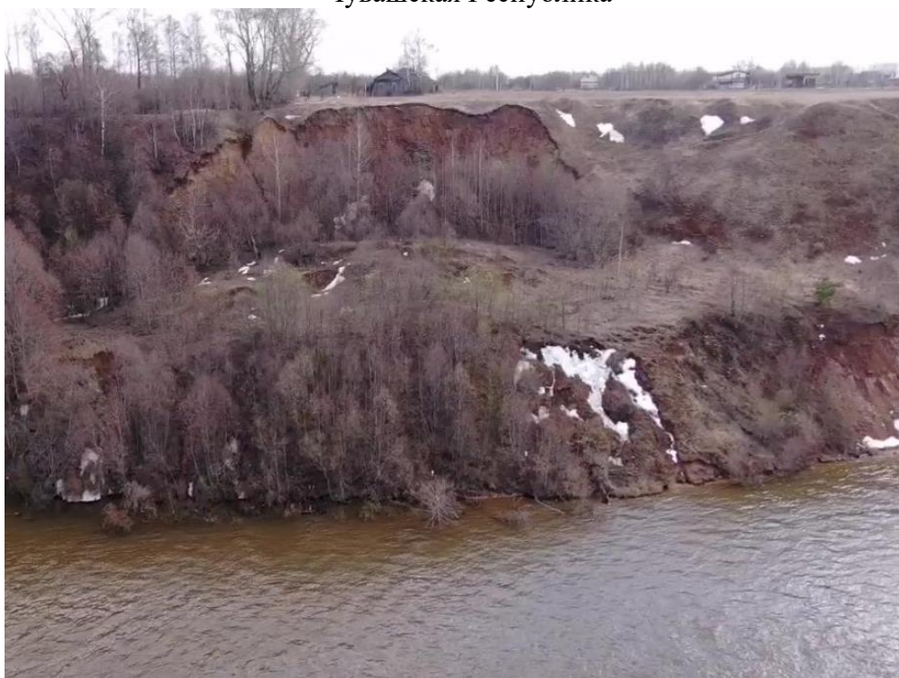
Фото. 21.11.00040. Развитие оползневого процесса в северной части г. Мариинский-Посад (государева гора), Чувашская Республика
