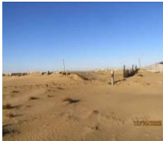
Фото 08 -21 -00065. Воздействие на хозяйственные постройки фермерского хозяйства.
