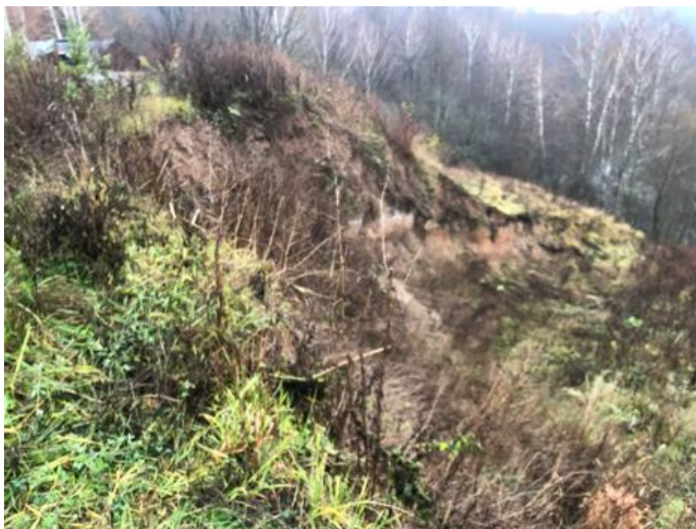
Фото 50-11-00857 Активный оползневой склон, 02.11.2023 г., ул. Верхняя Тополиная, с. Никитское, Московская область
