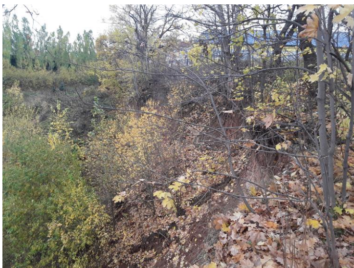
Фото. 21.22.00009. Развитие овражной эрозии в северо-западной части г. Чебоксары, Чувашская Республика
