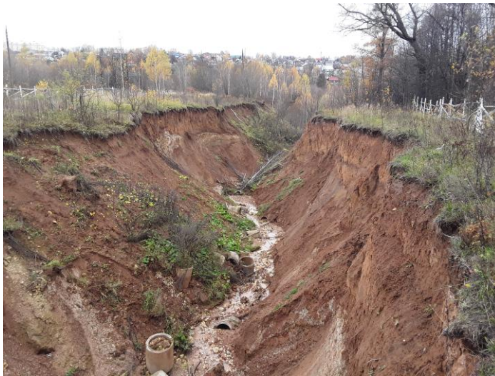
Фото. 21.22.00012. г. Развитие овражной эрозии в центральной части г. Чебоксары, Чувашская Республика
