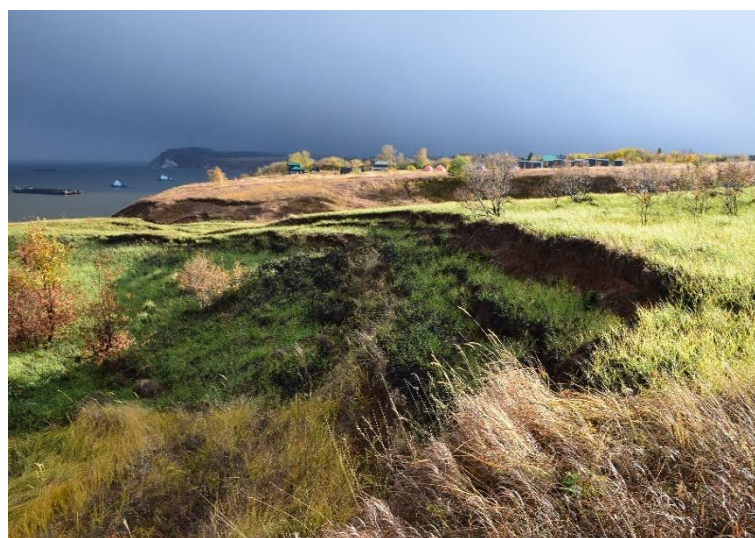
Фото 16-11-00282 Оползень скольжения между створами 1 и 2, октябрь 2023 г., пгт. Камское Устье, Камско – Устьинский муниципальный район, Республика Татарстан
