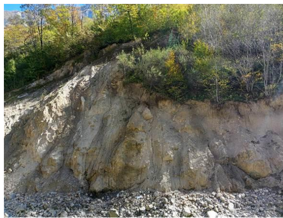
15-11-00032. Фронт Пионерного оползня
