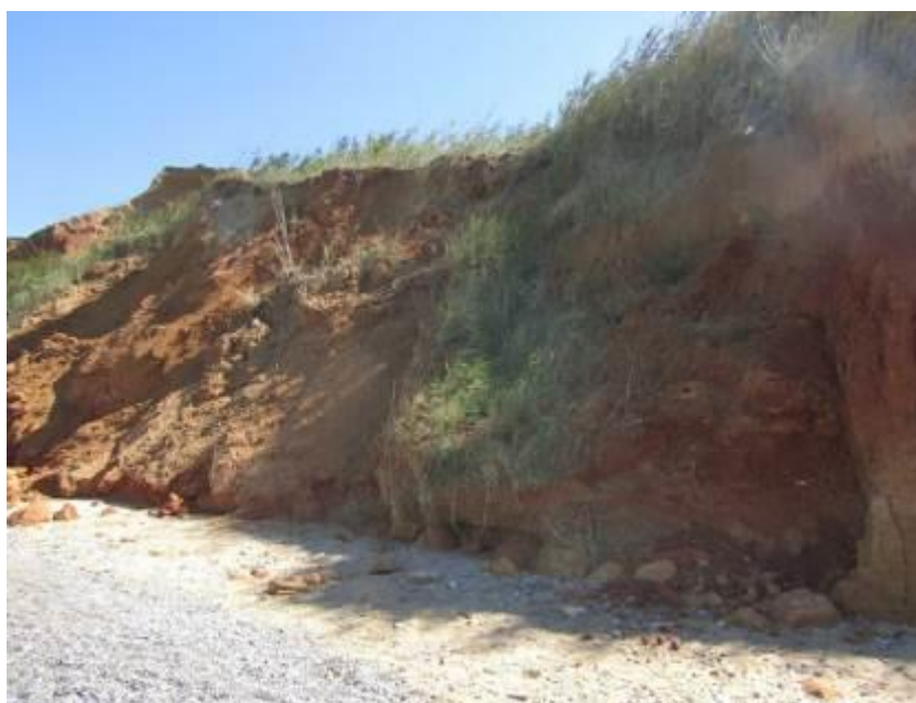
Фото 91-11-00904 Многочисленные обвалы и оплывины в языке оползня № 904. Мощность языка в центральной части оползня 5-6 м.
