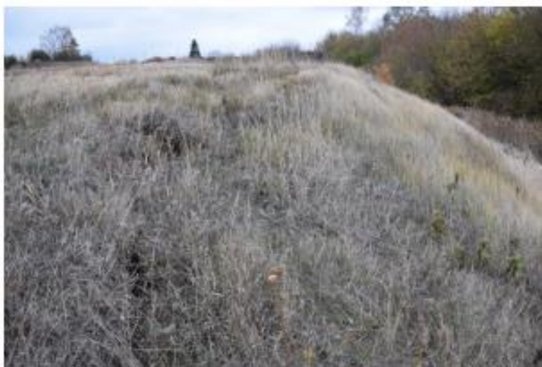
Фото 16-11-00159 Трещина на правом отворжке оврага Западный, октябрь 2023 г., пгт. Рыбная Слобода, Рыбно – Слободский район, Республика Татарстан
