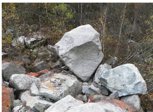
15-12-00051. Среднеобломочная осыпь на км 8,6 автодороги Бурон – Цей
