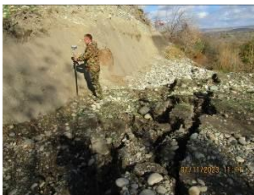
Фото 09-1110-0007 - 1. Подножие стенки срыва оползня. Абазинский район, а. Псыж
