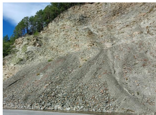
15-12-00116. Среднеобломочная осыпь на км 6 автодороги Бурон - Цей
