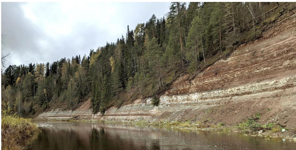
Фото 35.27.0002. Оползневой процесс на береговом склоне в д. Студёное Великоустюгского района, Вологодская область. 11.10.2023 г.
