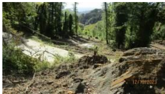
Фото 23.11.00455. Активизация оползневой процесса в районе ул. Фундучная с. Богушевка города курорта Сочи
