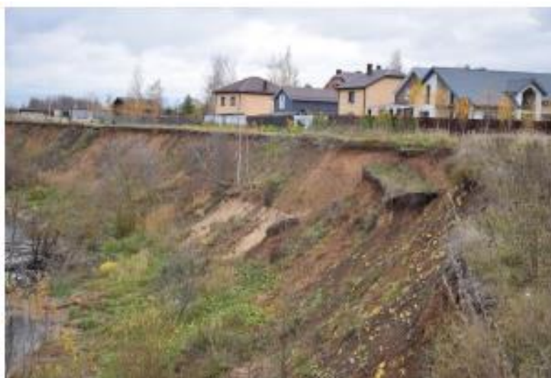
Фото 16-11-00215 Оползень скольжения на правом коренном берегу р. Казанка по ул. Зеркальная, октябрь 2023 г., Советский район, г. Казань, Республика Татарстан
