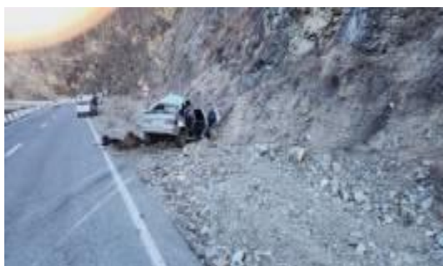
Фото 05-10-00036. Авария в результате активизации обвального процесса на 47км+900м автодороги «Буйнакск-Гимри-Чирката», Унцукульский район
