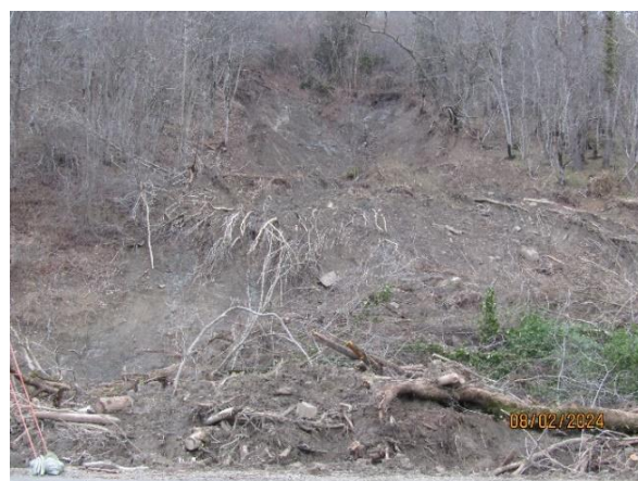
Фото 23-11-00274. Оползень на участке 1427 км автодороги М-4 «Дон» в 2,4 км к северу от с.Дефановка, Туапсинский район. Фото ЮРЦ ГМСН «Гидроспецгеология»
