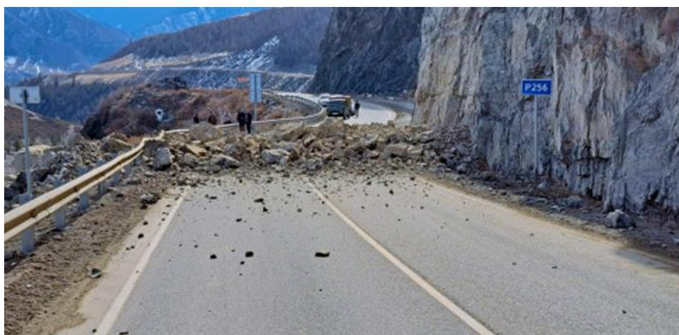
Фото 04-10-00004. Перекрытие автодороги обвальным материалом на отрезке 10 м (а/дорога Р-256, 686 км). Онгудайский район, Республика Алтай, 27.03.2024 Фото из открытого источника https://04.mchs.gov.ru/deyatelnost/press-centr/vse_novosti/5241544
