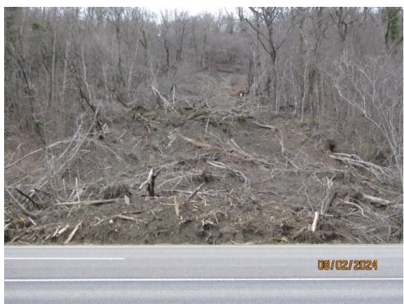
Фото 23-11-00275. Оползень на участке 1427 км автодороги М-4 «Дон» в 2,1 км к северу от с.Дефановка, Туапсинский район. Фото ЮРЦ ГМСН «Гидроспецгеология»
