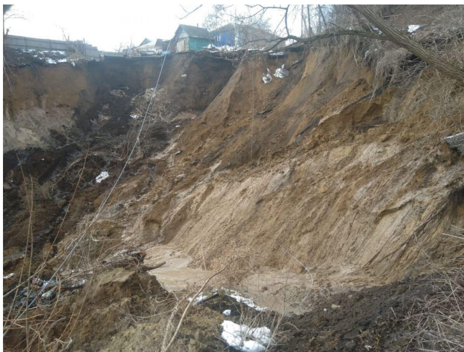
Фото 36-11-00541 Оползень в г. Новохоперск, Воронежской области.
