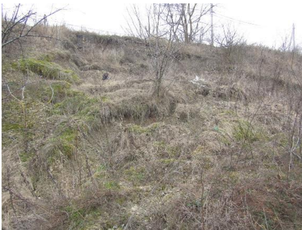
Фото 91-11-01003 Небольшой оползень в южном борту карьера шириной до 20 м. Выпор на полку карьера. Головной срыв до 2,5м. г. Симферополь, р-н. мкр-н Марьино
