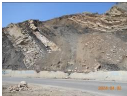
Фото 05-10-00038. Обвал на автодороге «Буйнакский перевал» 6 км + 100 м, Кумторкалинский район.
