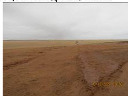
Фото 08-21-00072. В 3,6 км северо-восточнее п. Хулхута, около 1,0 км грунтовой дороги выдуто ветром глубиной 0,5 - 0,7 м, местами частично засыпана песком. Фото ЮРЦ ГМСН Гидроспецгеология
