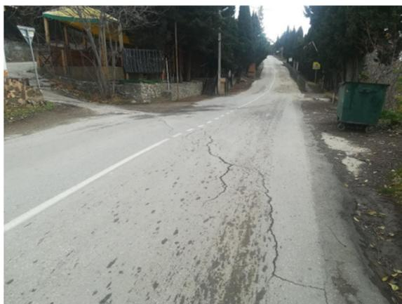
Фото 91-11-05601. Оползень № 732, нижняя часть, правый борт. Трещины и деформации на а/д 35 ОП РЗ 35К-005. г.о. Алушта, с. Приветное
