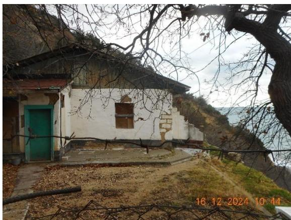
Фото 92-11-0005. Деформации каменного строения на террасе выше подпорной стены (16.12.2024 г.). г. Севастополь, Балаклавский район, микрорайон Фиолент, спуск на Яшмовый пляж
