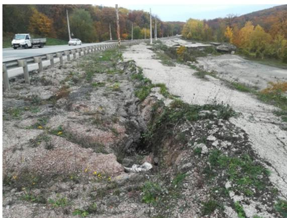
Фото 91-11-04702. Оползень. Деформирование (проседание) асфальта из-за суффозии вдоль свайного ростверка на старом неэксплуатируемом участке а/д 35 ОП РЗ 35А-002 (км 163-164), г.о. Алушта.
