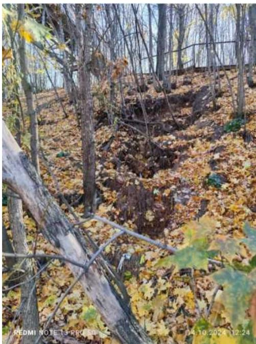
Фото 02-22-00023 Эрозионная промоина у основания опоры пешеходного моста над железнодорожными путями. Участок «Северный» Уфимского косогора, г. Уфа Республика Башкортостан
