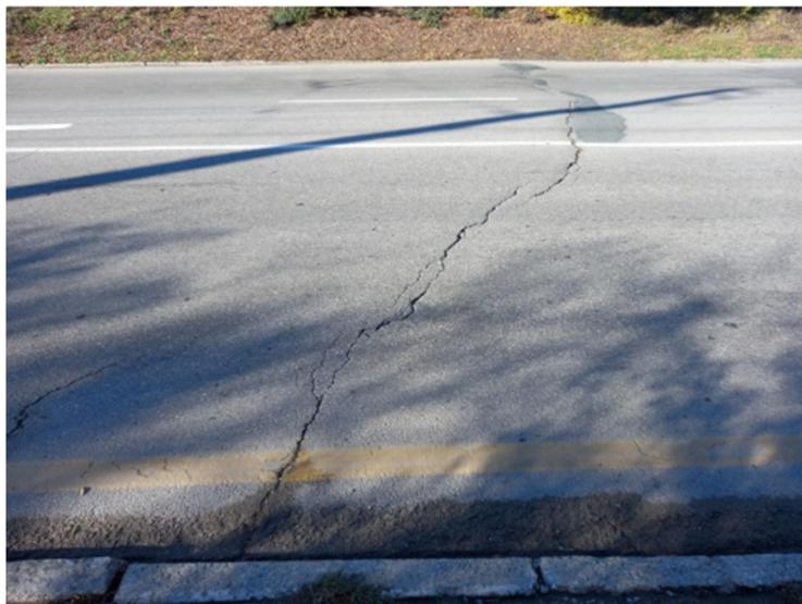
Фото 10. Проявление 91-11-04401. Южнобережное шоссе. Левый борт оползня. Трещины и деформации на дорожном полотне
