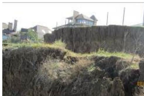
Фото 23-11-00011. Отседание оползневой ступени на западной окраине п. Пересыпь. Фото ЮРЦ ГМСН Гидроспецгеология
