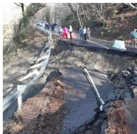
Фото 23-11-00645. Оползнем разрушена дорога в с. Семеновка. Фото из открытых источников СМИ
