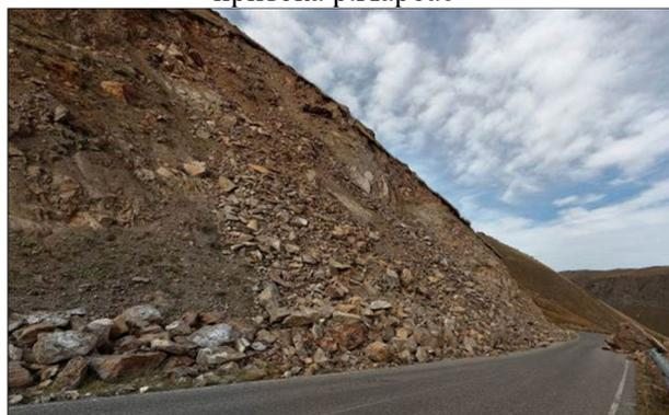
Фото 07-10-00014. Обвальный участок на верх. откосе а/д Кисловодск- Долина Нарзанов – Джилы-Су, дорога частично расчищена
