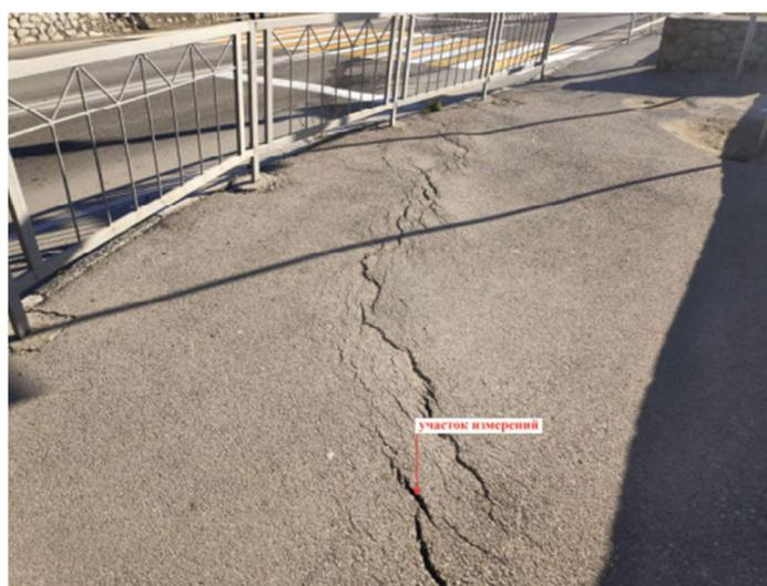
Фото 91-11-04201. Оползень № 408, головная часть, правый борт. Трещины на асфальте а/д35 ОП РЗ 35А-002. г.о. Ялта, пгт. Никита
