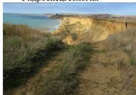
Фото 23-11-00027. Оползневая активизация на уступе побережья Черного моря в 250м к югу от п. Таманского. Разрушена грунтовая автодорога на протяжении 100м. Фото ЮРЦ ГМСН Гидроспецгеология
