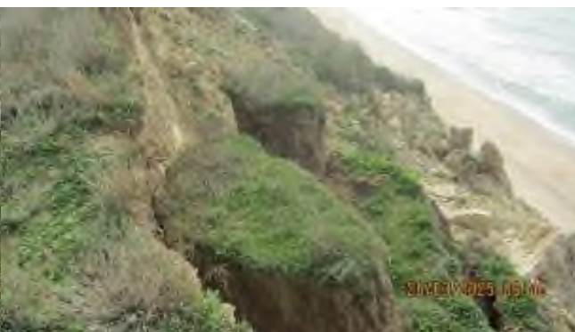
Фото 23-11-00034. Оползневой процесс на восточной окраине коттеджного поселка Янтарный берег, Темрюкский район
