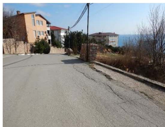
Фото 91-11-01101. Обрушение подпорной стены на правом борту оползня (а); деформации автодороги по ул. Северная, г.о. Ялта., пгт. Форос
