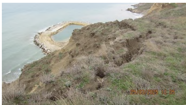
Фото 23-11-00292. Оползневой процесс в 5 км к северо-западу от п. Волна, Темрюкский район
