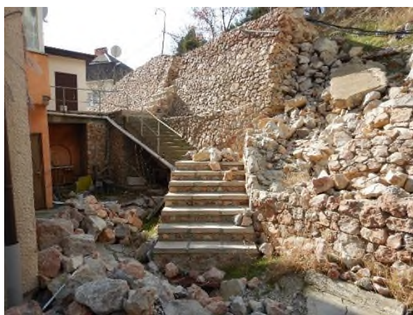
Фото 91-11-01101. Обрушение подпорной стены на правом борту оползня (а); деформации автодороги по ул. Северная, г.о. Ялта., пгт. Форос
