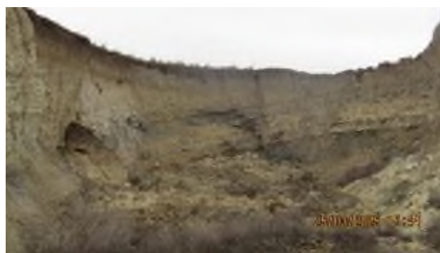
Фото 23-11-00018. Оползневой склон в центральной части станции Тамань у этно-туристического комплекса «Атамань».
