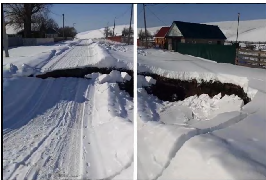
Фото 02-05-00256. Карстовый провал на юго-западной окраине д. Арметрахимово Ишимбайского района
