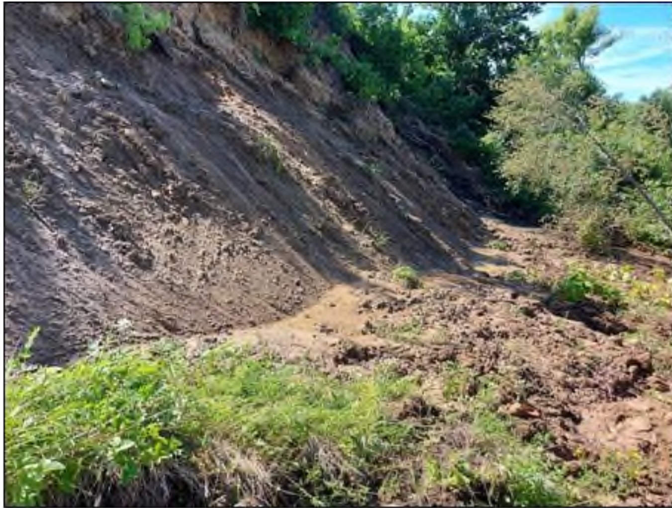
Фото 33-11-00139. Оползень в Суздальском районе, в с. Сельцо, в пределах улиц Красноармейская з/у №15 и 2-ая Красноармейская д.№22, правый склон долины р. Каменка, Владимирская область
