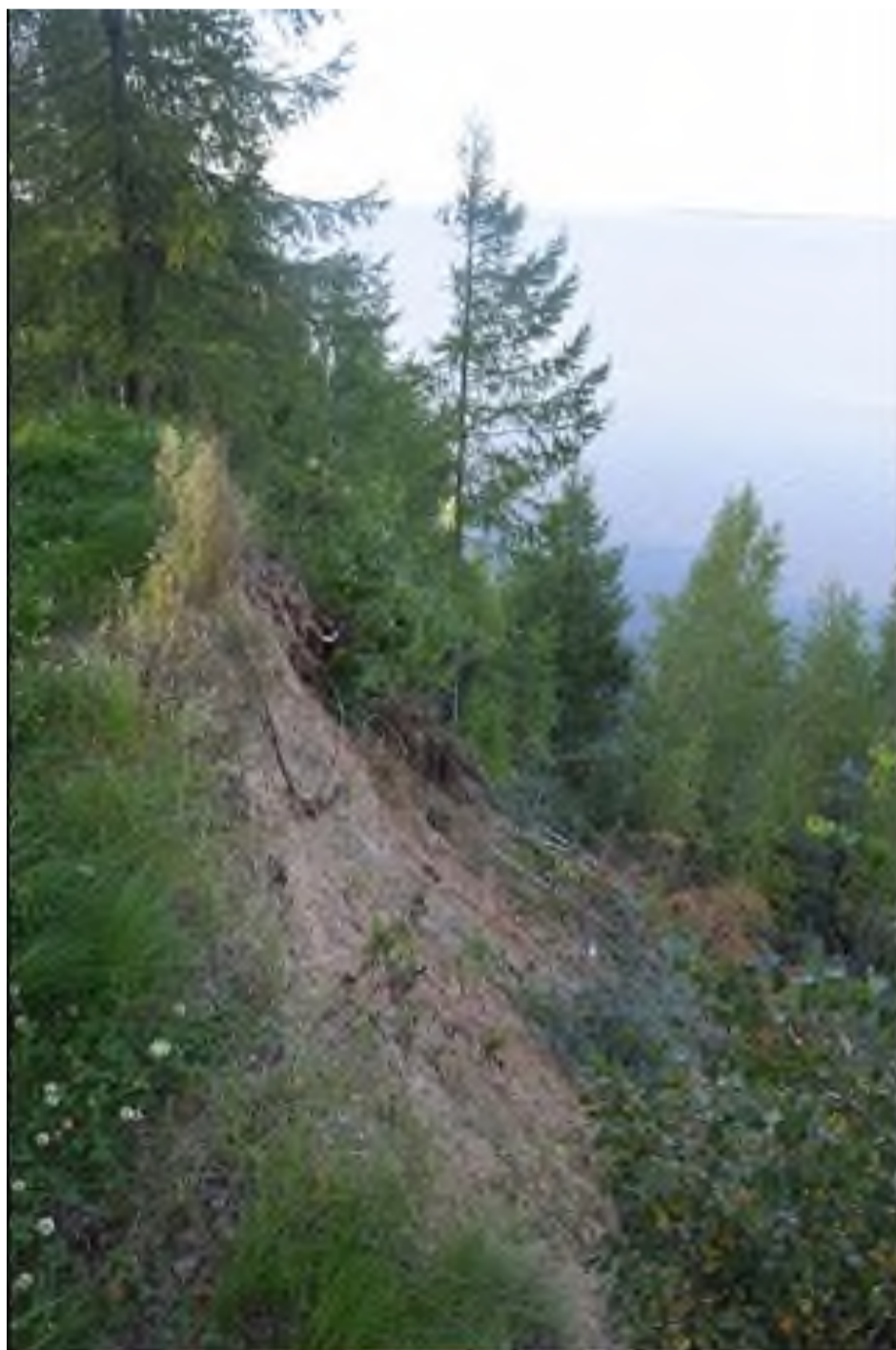
Фото 37-11-00004. Оползень в Пучежском районе, северная окраина г. Пучеж, северо-восточнее спортивной площадки «Воркаут», вдоль правобережного склона р. Волга (Горьковское вдхр.), Ивановская область
