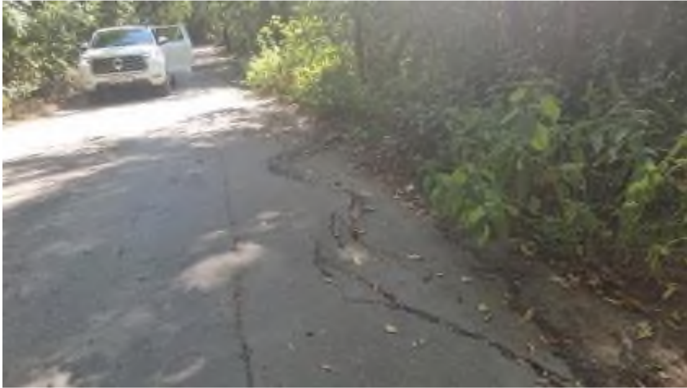
Фото 77-11-00048. Активный оползень в г. Москве в районе Хорошево-Мневники возле Троицкой Церкви
