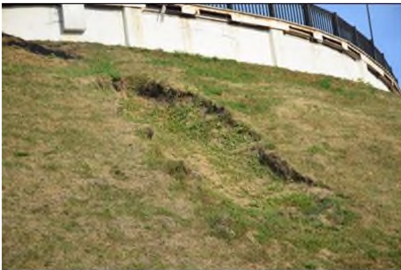
Фото 33-11-00138. Оползень в г. Владимире, южная окраина парка им. Пушкина, под смотровой площадкой у памятника Князю Владимиру и святителю Федору, Владимирская область
