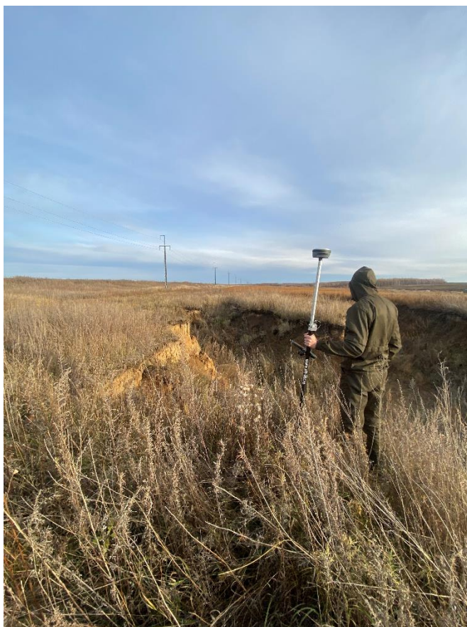
Фото 28-22-001-001. Овражная эрозия, 1517 км автодорога Р-297, Октябрьский район Амурская область.
