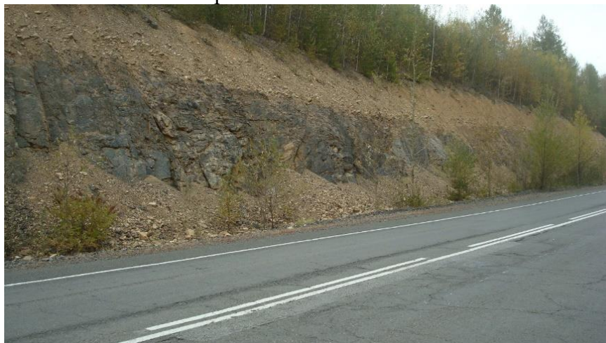
Фото 27-23-0017 Проявления осыпного процесса на 213 км А 376 (левая сторона), Ванинский район 16.09.2024г.
