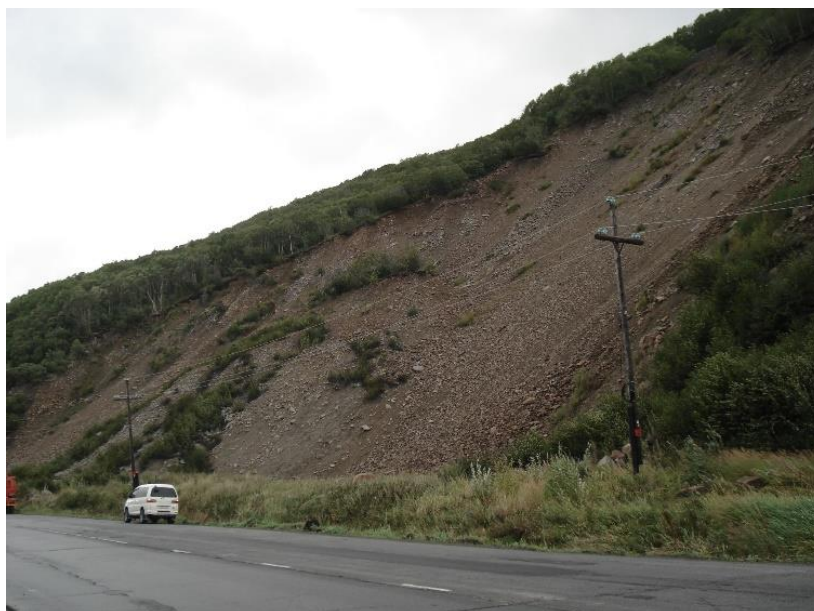
Фото 49.12.0001. Активизация осыпного процесса в г. Магадан, ул. Портовое шоссе, напротив строения 209 по состоянию на 01.09.2024 г (фото Приморского отделения филиала «Дальневосточный региональный центр ГМСН»)
