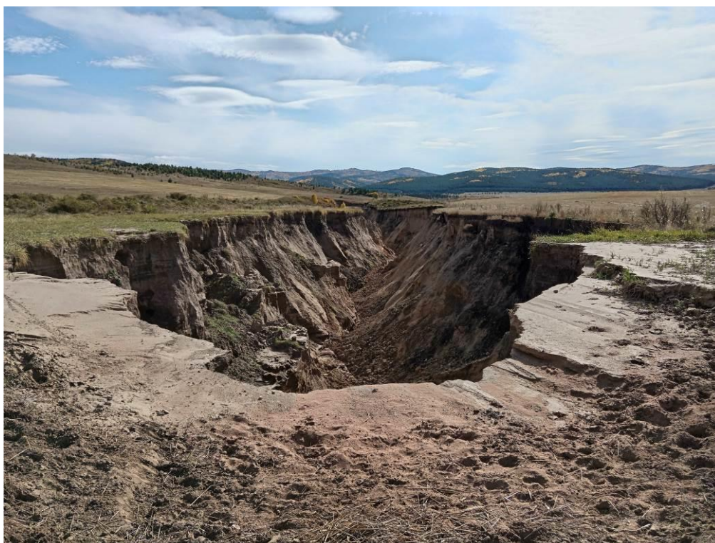
Фото 03-22-00007. Вид на вершину оврага №2. Осыпание грунта, с. Хонхолой, Мухоршибирский район, Республика Бурятия, 20.09.2024
