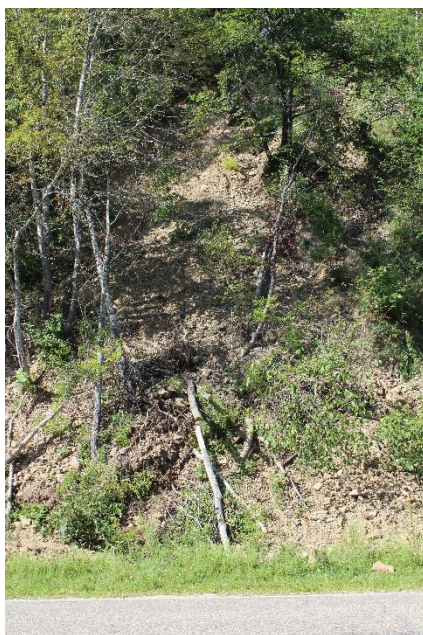
Фото 25.11.0008. Активизация оползневого процесса на участке 404,2 км автодороги Находка-Ольга-Кавалерово по состоянию на 28.08.2024 г
