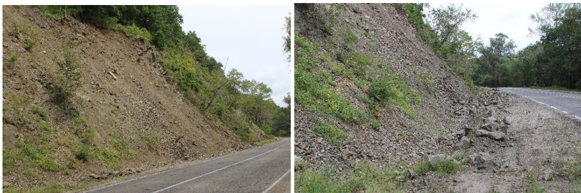
Фото 25.12.0006. Продолжение активизации осыпного процесса на участке 244,3 км автодороги Осиновка-Р. Пристань по состоянию на 27.08.2024 г
