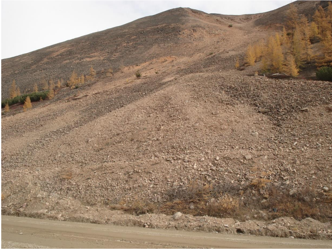
Фото 49.12.0002. Хасынский муниципальный округ, севернее 30,28 км от п. Атка. Активизация осыпного процесса на участке 1792, 0 км автодороги Р-504 «Колыма» по состоянию на 04.09.2024 г. (фото Приморского отделения филиала «Дальневосточный региональный центр ГМСН»)
