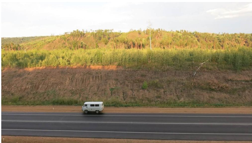
Фото 75-11-00004. Оползень на выположенном в 2022 г. склоне а/дороги Чита-Хабаровск, 70 км (левая сторона), Карымский район, Забайкальский край, 31.07.2024
