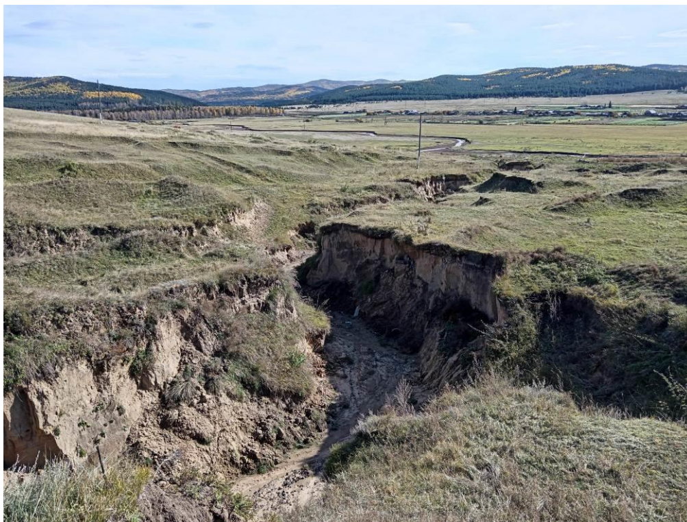
Фото 03-22-00006. Вид на стенку оврага №1. Осыпание грунта, с. Хонхолой, Мухоршибирский район, Республика Бурятия, 20.09.2024
