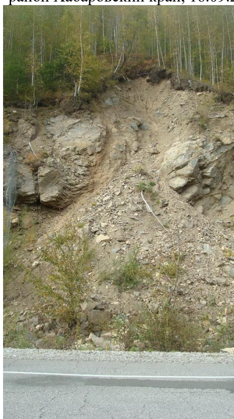
Фото 27-27-0013, Обвально-осыпной шлейф на участке 86 км А 376, Нанайский район Хабаровский край, 16.09.2024г.
