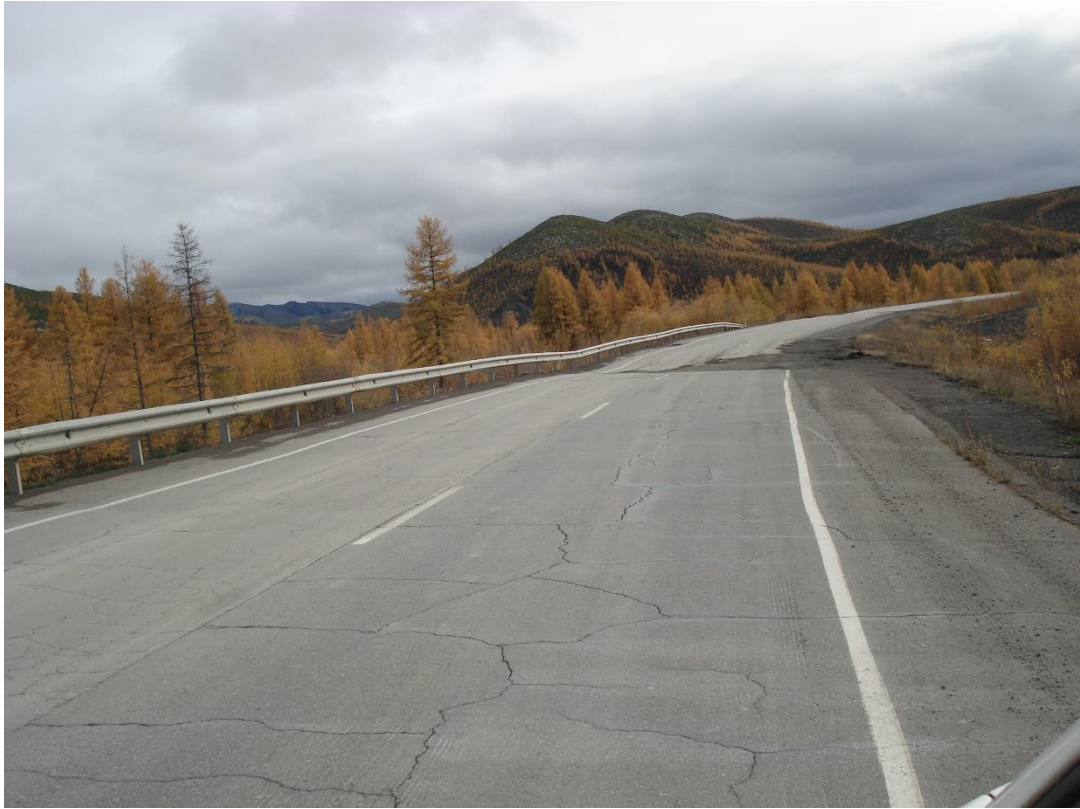
Фото 49.6.0004. Хасынский муниципальный округ, п. Стрелка. Активизация криогенеза (пучение) на участок 1713, 3 км автодороги Р-504 «Колыма» по состоянию на 05.09.2024 г. (фото Приморского отделения филиала «Дальневосточный региональный центр ГМСН»)
