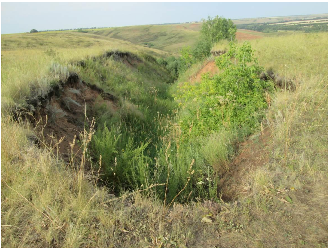
Фото 56-22-00002. Верховье наблюдаемого оврага. Вид северном направлении. 0,8 км севернее с. Верхнеигнашкино, Грачевский район, Оренбургская область
