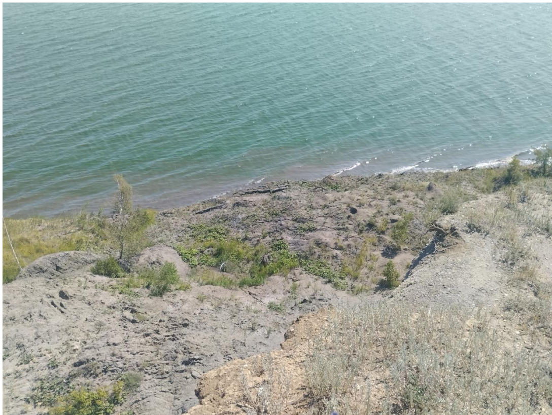
Фото 73-11-00033. Разжижение и сплывы грунта в центральной части Ульяновская обл. Ульяновский р-н, п. им. Карамзина, р-н кладбища
