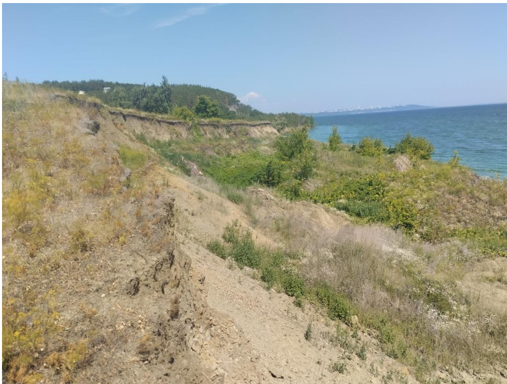
Фото 73-11-00048. Осыпание бровки оползня Ульяновская обл. Ульяновский р-н, снт. Родничок
