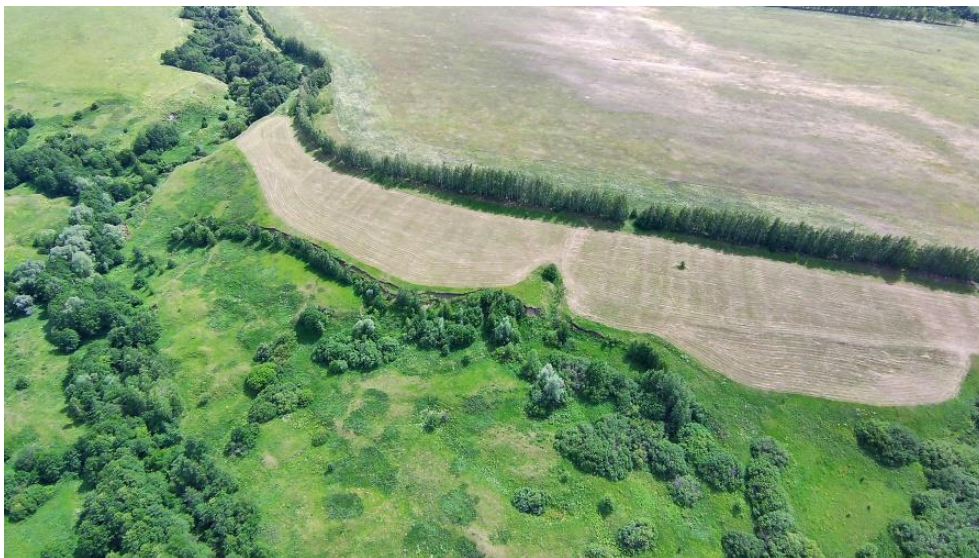
Фото 73-11-00037. Осыпание грунта по бровке оползня. Ульяновская обл. Ульяновский р-н. с. Максимовка
