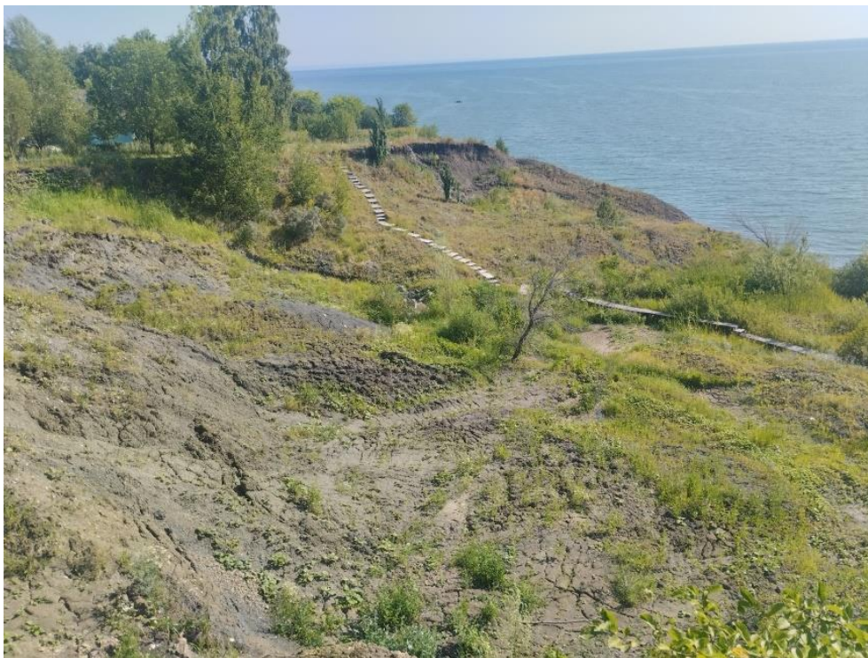
Фото 73-11-00089. Оплывание грунта в центральной части оползня. Ульяновская обл. п. Сланцевый Рудник
