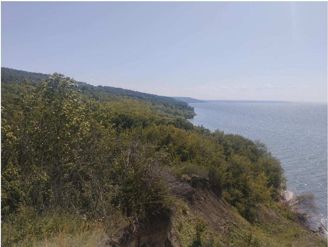
Фото 73-11-00032. Осыпание бровки оползня Ульяновская обл. Ульяновский р-н, п. им. Карамзина, ул. Береговая
