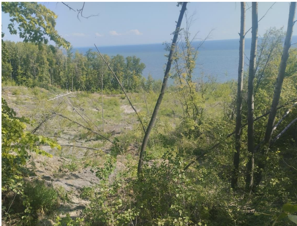
Фото 73-11-00042. Общий вид оползневого смещения в центральной части оползня, оползневые, вспучивание грунта, поваленные деревья Ульяновская обл. г. Ульяновск. Ул. Уютная
