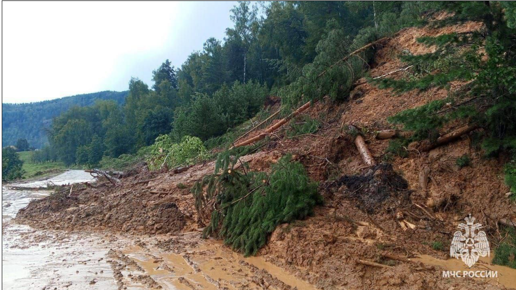
Фото 02-11-00005 Оползень - поток на въезде в д. Мурадымово, Бурзянский район, Республика Башкортостан
