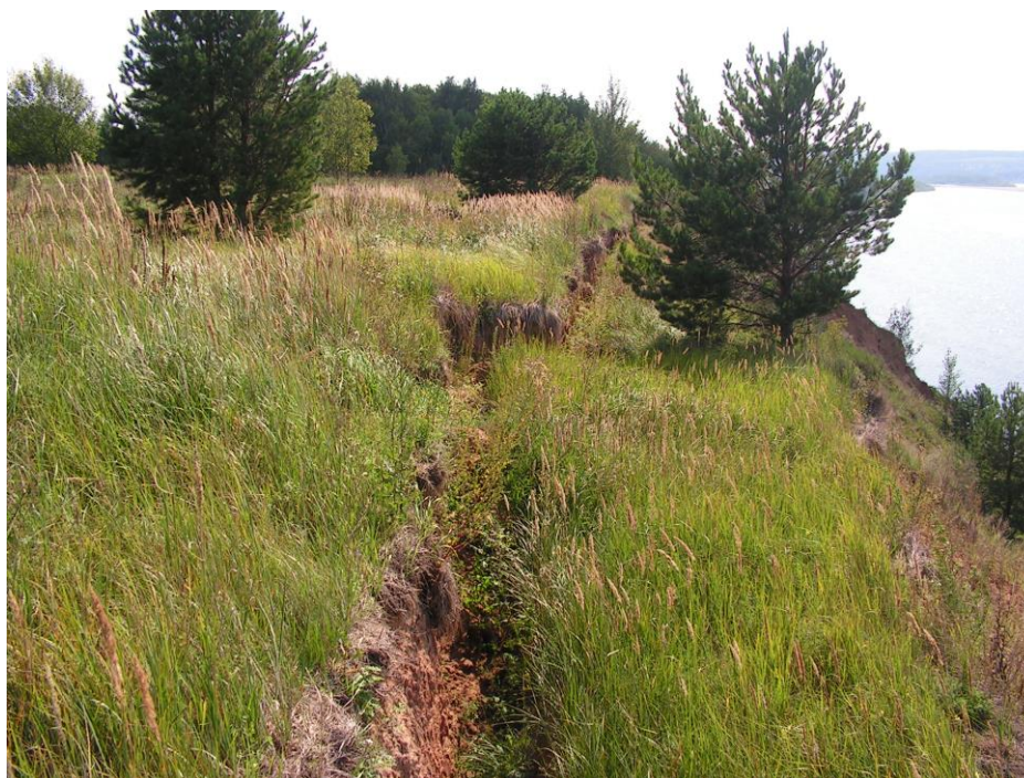
Фото 18-11-00031. Участок дежурных инженерно-геологических обследований «Крымская Слудка», Кизнерский район, Удмуртская Республика. Август 2024 г. Оползневая трещина растяжения
