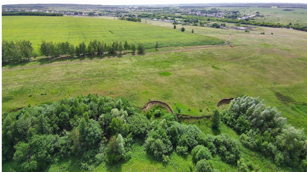
Фото 73-11-00040. Осыпание грунта по бровке оползня. Ульяновская обл. Ульяновский р-н. с. Максимовка
