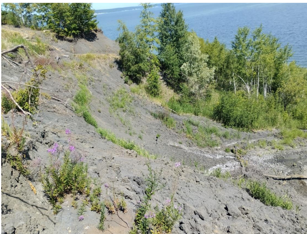
Фото 73-11-00130. Левый борт оползня, оползневые сплывы в центральной части оползня Ульяновская обл. Ульяновский р-н, п. Городищи. Городищенский разрез
