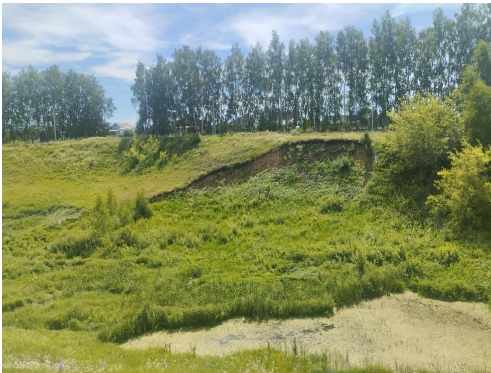
Фото 73-11-00141. Общий вид, срывы грунта по бровке оползня Ульяновская обл. Ульяновский р-н, п. Ундоры, ул. Молодежная
