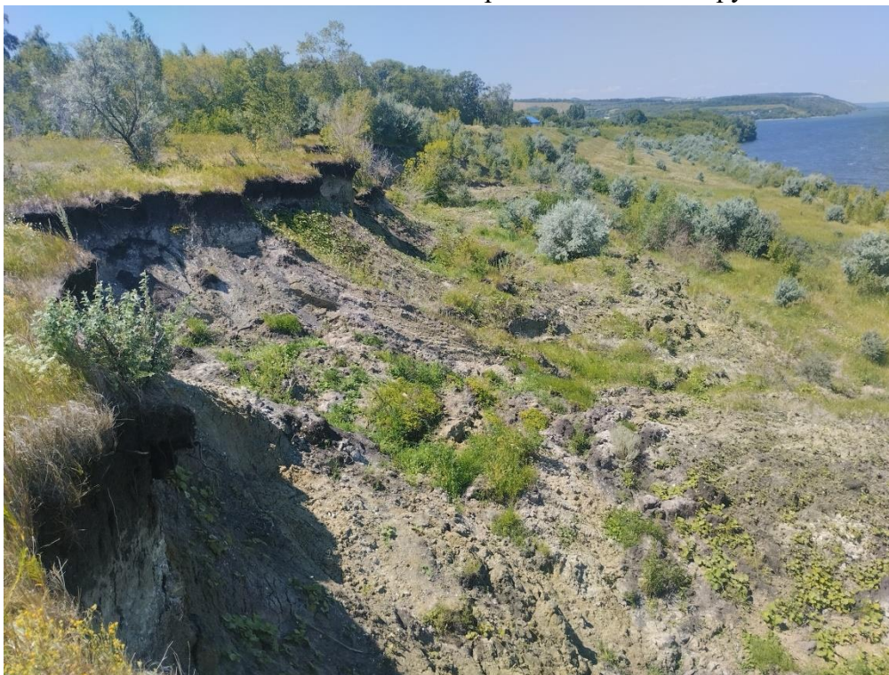
Фото 73-11-00096. Общий вид оползневых смещений, Оползневые блоки, осыпание грунта Ульяновская обл. Сенгилеевский р-н. г. Сенгилей
