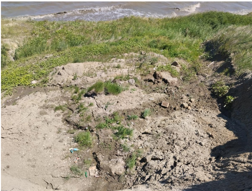
Фото 73-11-00135. Срывы на бровке оползня, осыпи Ульяновская обл. г. Новоульяновск, ул Портовая
