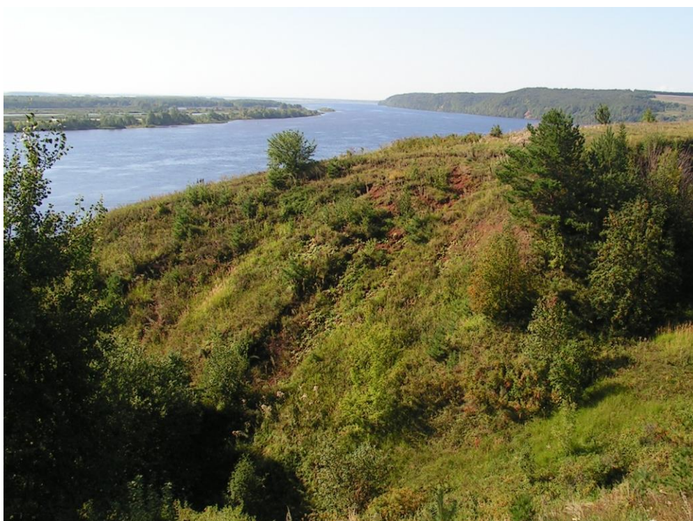
Фото 18-11-00037. Участок дежурных инженерно-геологических обследований «Колесниково», Каракулинский район, Удмуртская Республика. Август 2024 г. Оползень разжижения
