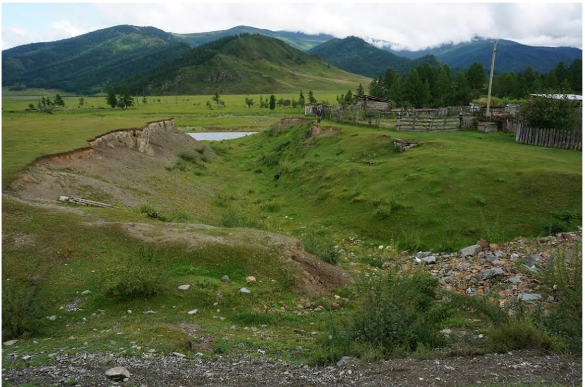
Фото 04-22-00008. Вершина оврага № 3 достигает откосов дороги, уч. а/дороги Туекта – Усть-Кан, 20,05 км, с. Кара-Кобы, Онгудайский район, Республика Алтай, 20.07.2024
