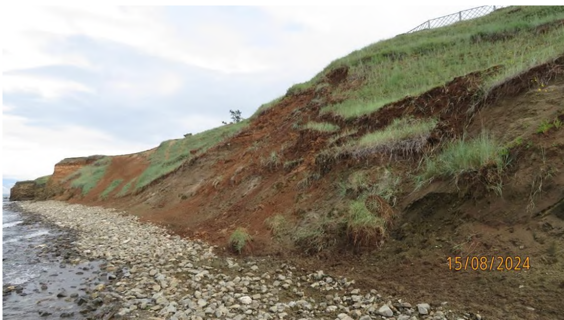
Фото 38-11-00003. Оползень №3, побережье залива Сарайский оз. Байкал, Ольхонский район, Иркутская область, 15.08.2024
