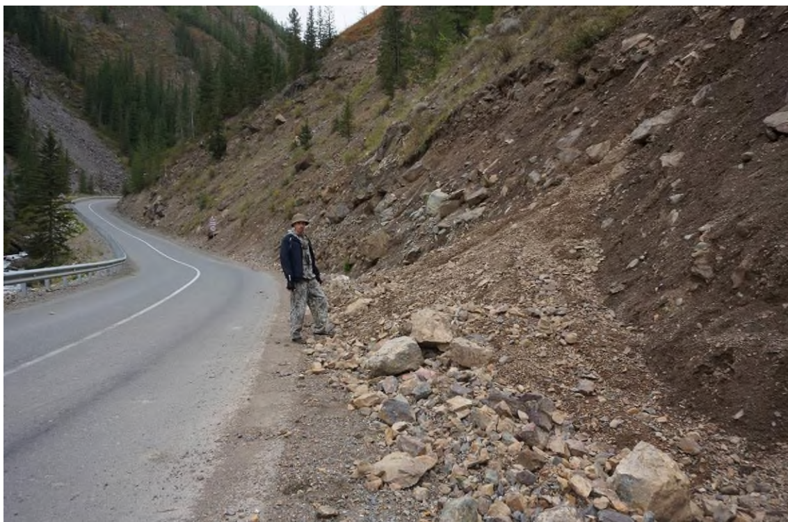
Фото 04-12-00003. Осыпной конус перекрывает обочину а/дороги, уч. а/дороги Акташ – Улаган, 5,33-5,55 км, Улаганский район, Республика Алтай, 03.09.2024
