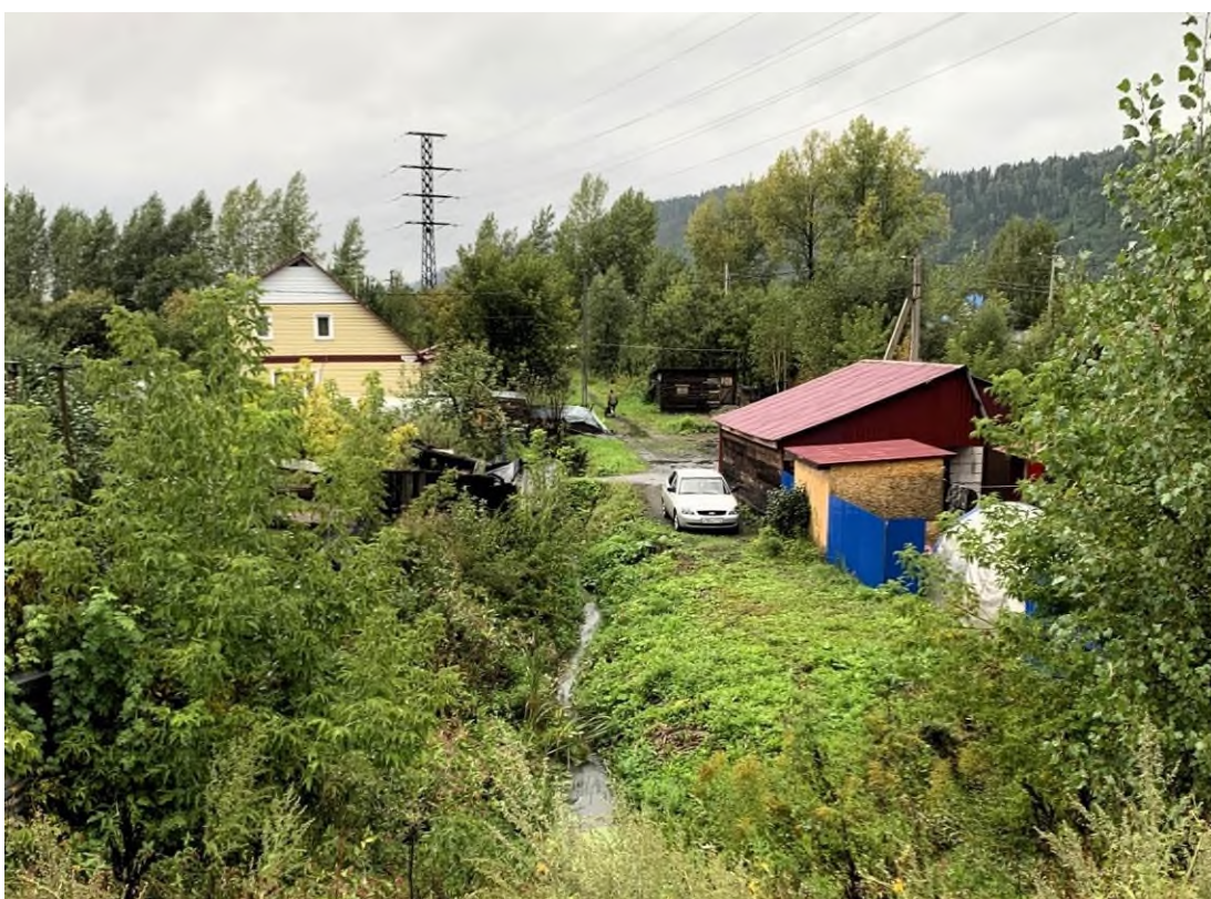
Фото 42-13-00010. Дренажная канава по ул. Леонова, 42, уровень воды 0,86 м, г. Междуреченск, Кемеровская область-Кузбасс, 04.09.2024
