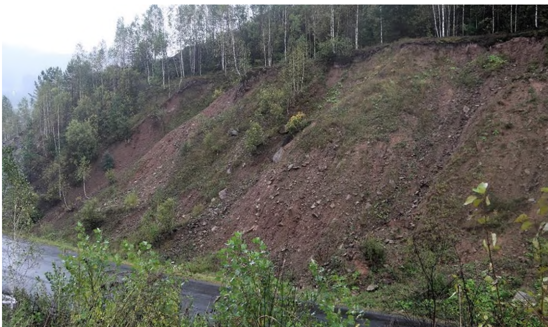
Фото 42-12-00001. Общий вид на юго-восточную часть осыпного склона, по склону наблюдаются осыпные конусы, промоины, смещенные деревья, обнажены отдельные крупные валуны, уч. а/дороги Кузедеево - Таштагол, 24-25 км, пгт. Мундыбаш, Таштагольский район, Кемеровская область-Кузбасс, 03.09.2024
