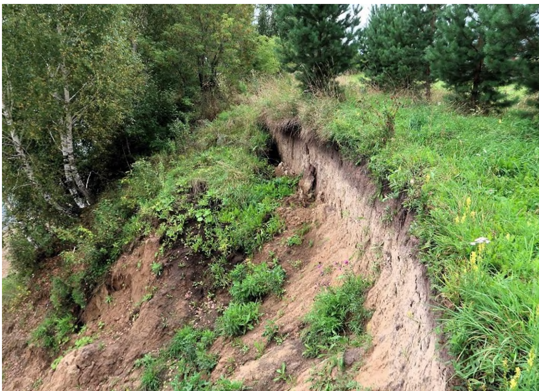
Фото 42-10-00003. Обвальный процесс, обрушение уступа в районе ул. Томская, 10, пгт. Крапивинский, Крапивинский район, Кемеровская область-Кузбасс, 07.09.2024
