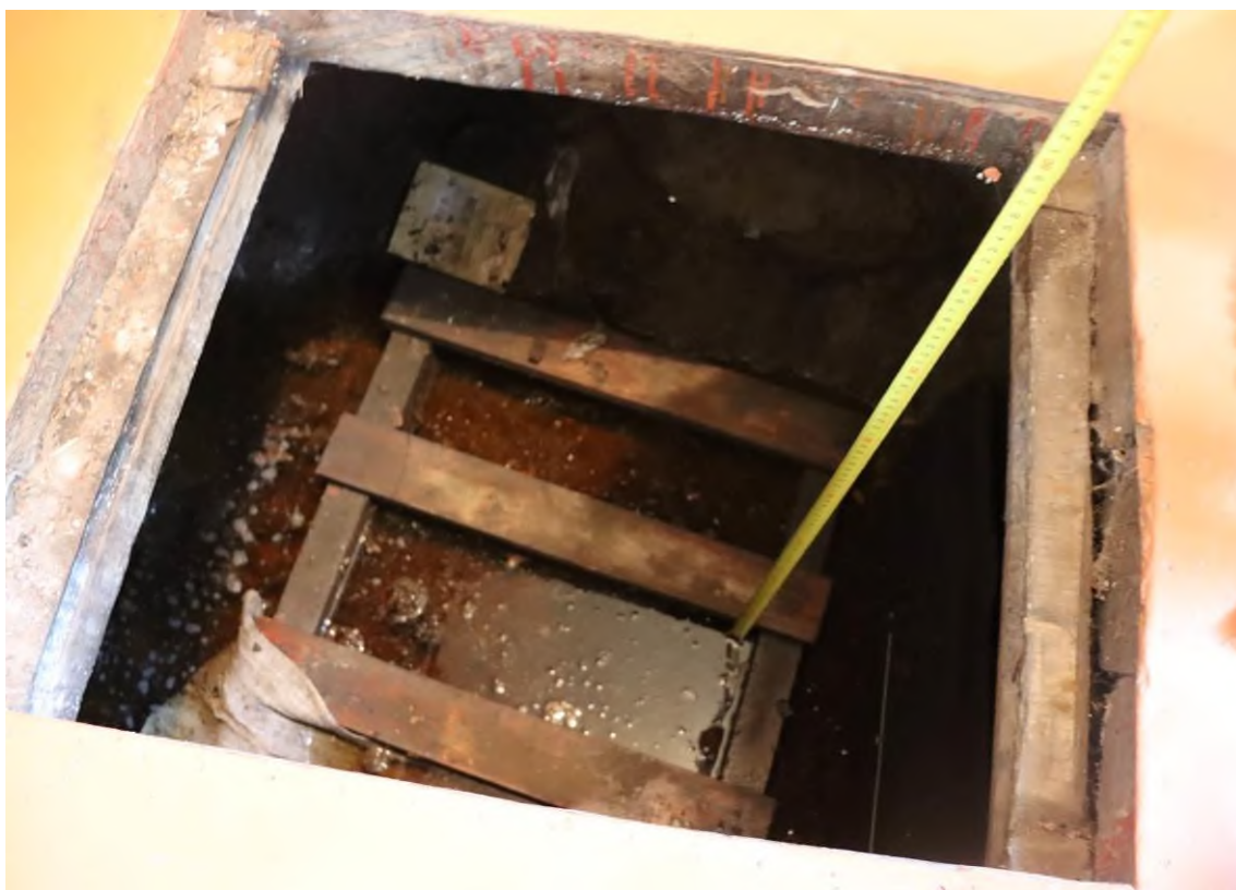
Фото 38-13-00002. Подтопленное подполье по ул. Калинина, 28. УГВ составляет 0,73 м от поверхности, г. Тулун, Иркутская область, 01.08.2024
