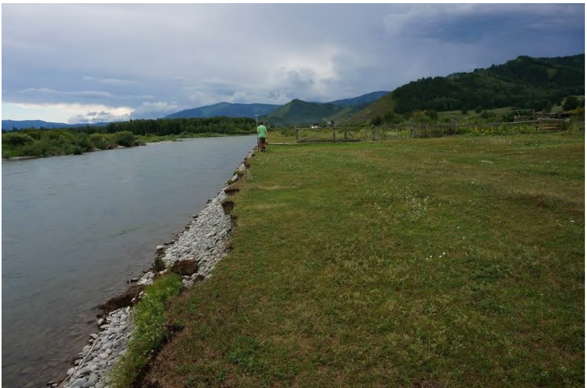
Фото 04-10-00006. Козырьки ПРС, блоки отпора размером до 0,5*0,5*1,5 м, с. Березовка, Усть-Коксинский район, Республика Алтай, 21.07.2024
