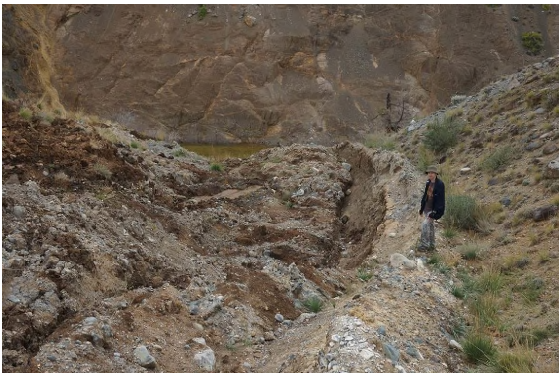
Фото 04-11-00059. Транзитная часть оползня № 04-11-00059 с элементами скольжения рыхлых пород перед фронтальной частью языка, в 10 км ЮЗ с. Чаган-Узун, Кош-Агачский район, Республика Алтай, 29.08.2024
