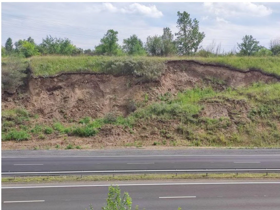
Фото 19-11-00006. Общий вид на оползень 4 на участке а/дороги Р-257, Братский мост, Алтайский район, Республика Хакасия, 19.07.2024
