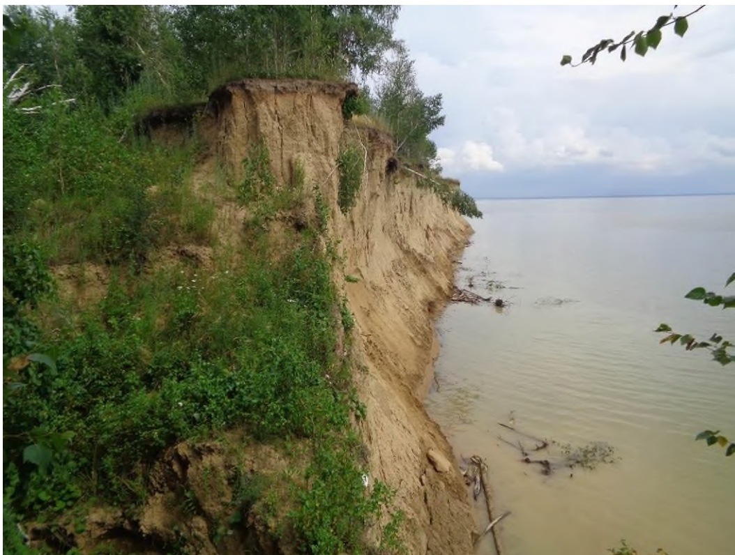
Фото 54-22-00048. Овраг № 30 у устья много столбчатых отслоений, осыпаний, козырьки ПРС. с. Ленинское, Новосибирский район, Новосибирская область, 18.07.2024
