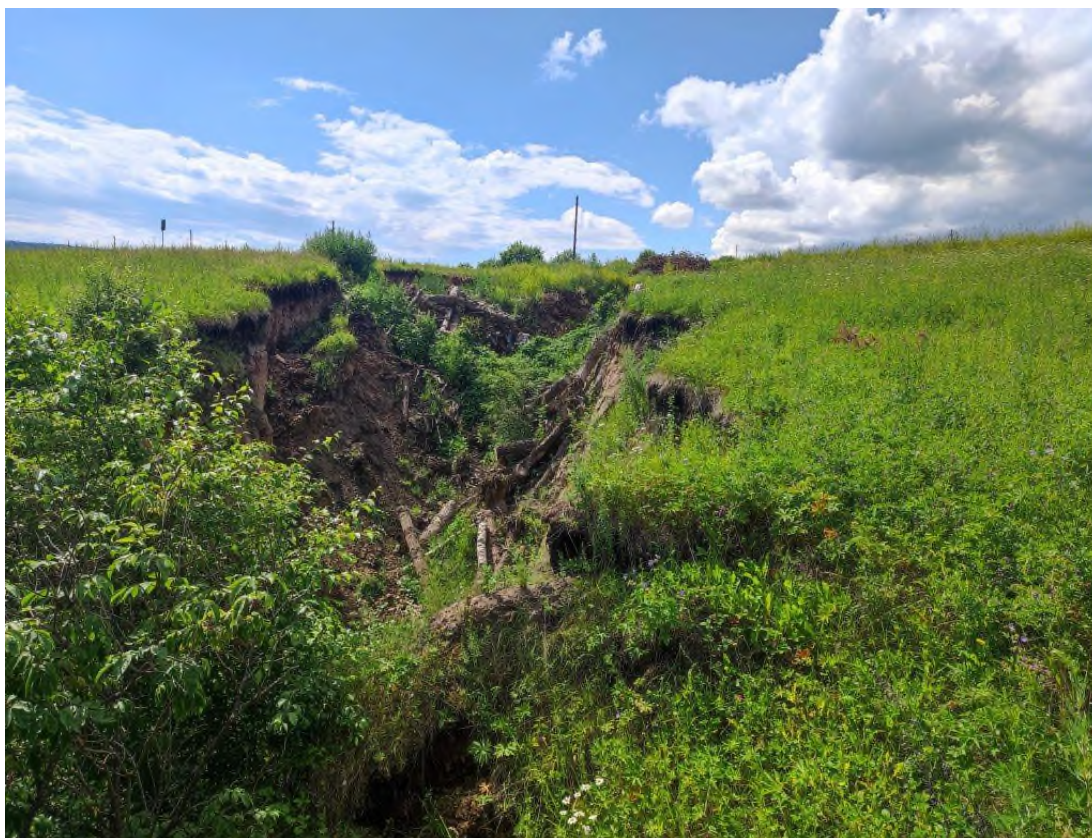
Фото 24-22-00004. Активное обрушение бортов левого отвершка I порядка оврага 4, ПН Приморск. п. Приморск, Балахтинский район, Красноярский край, 12.07.2024
