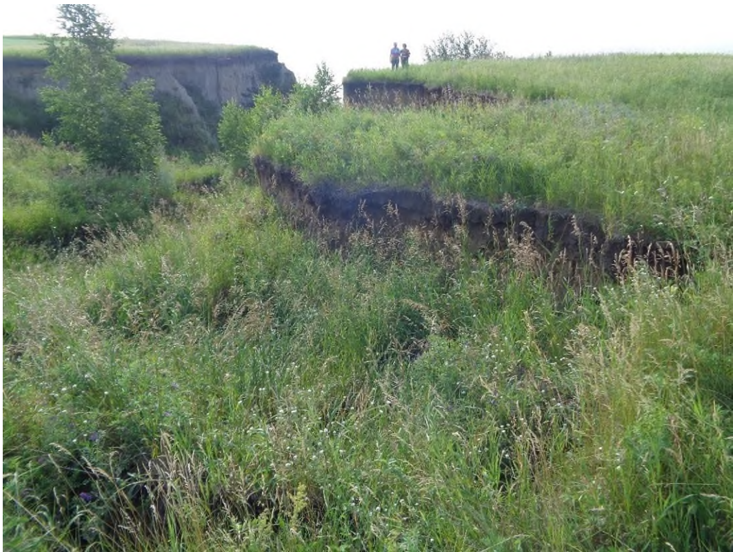
Фото 55-22-00014. Овраг № 5 середина, общий вид. с. Ленинское, Новосибирский район, Новосибирская область, 18.07.2024
