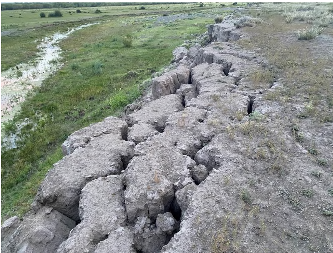
Фото 17-10-00002. Участок уступа с трещинами отседания и обрушения грунта, с. Хорум-Даг, Дзун-Хемчикский район, Республика Тыва, 10.08.2024
