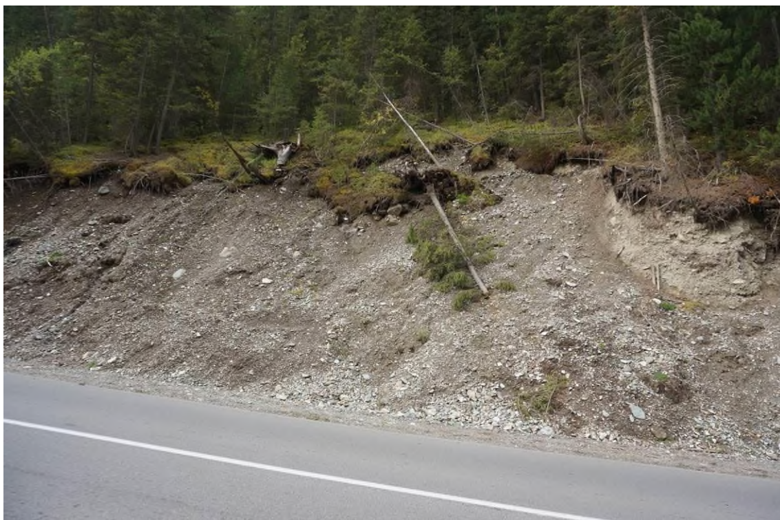
Фото 04-12-00010. Осыпные шлейфы перекрывают обочины а/дороги Акташ – Улаган, 6,11-6,79 км, Улаганский район, Республика Алтай, 03.09.2024
