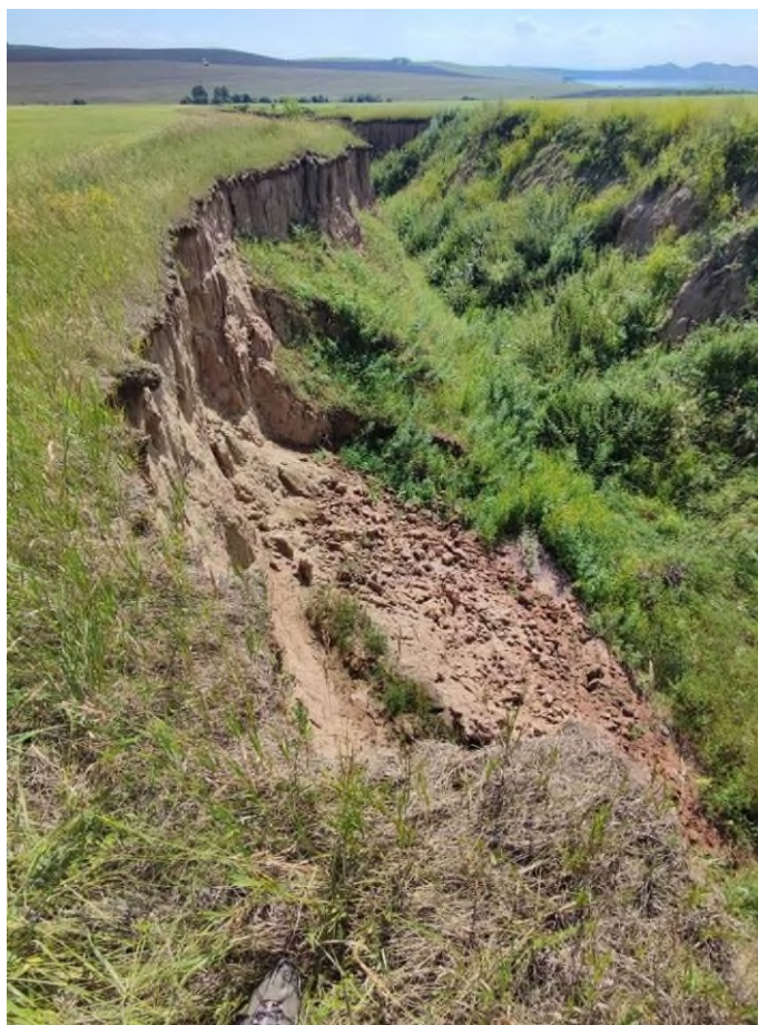
Фото 24-22-00041. Участок с обрушениями по левому борту оврага, ПН уч. а/дороги Минусинск-Беллык, 93 км, 2,8 км СЗ д. Белоярск, Краснотуранский район, Красноярский край, 13.07.2024
