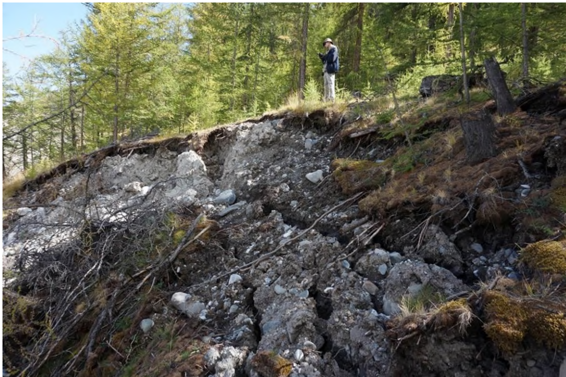
Фото 04-11-00014. Трещины растяжения в надоползневом уступе по левому флангу оползня, в 9,2 км ЮЗ с. Бельтир, Кош-Агачский район, Республика Алтай, 31.08.2024
