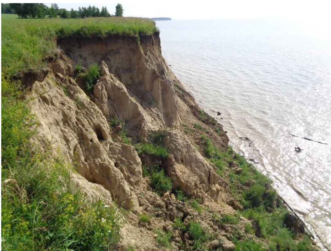
Фото 54-10-00002. Уступ высотой 12-15 м неустойчив, много столбчатых отслоений. У подножья свежий обвалившийся грунт. Повсеместно наблюдаются трещины отрыва с шириной раскрытия до 10-25 см, козырьки ПРС. с. Ленинское, Новосибирский район, Новосибирская область, 18.07.2024
