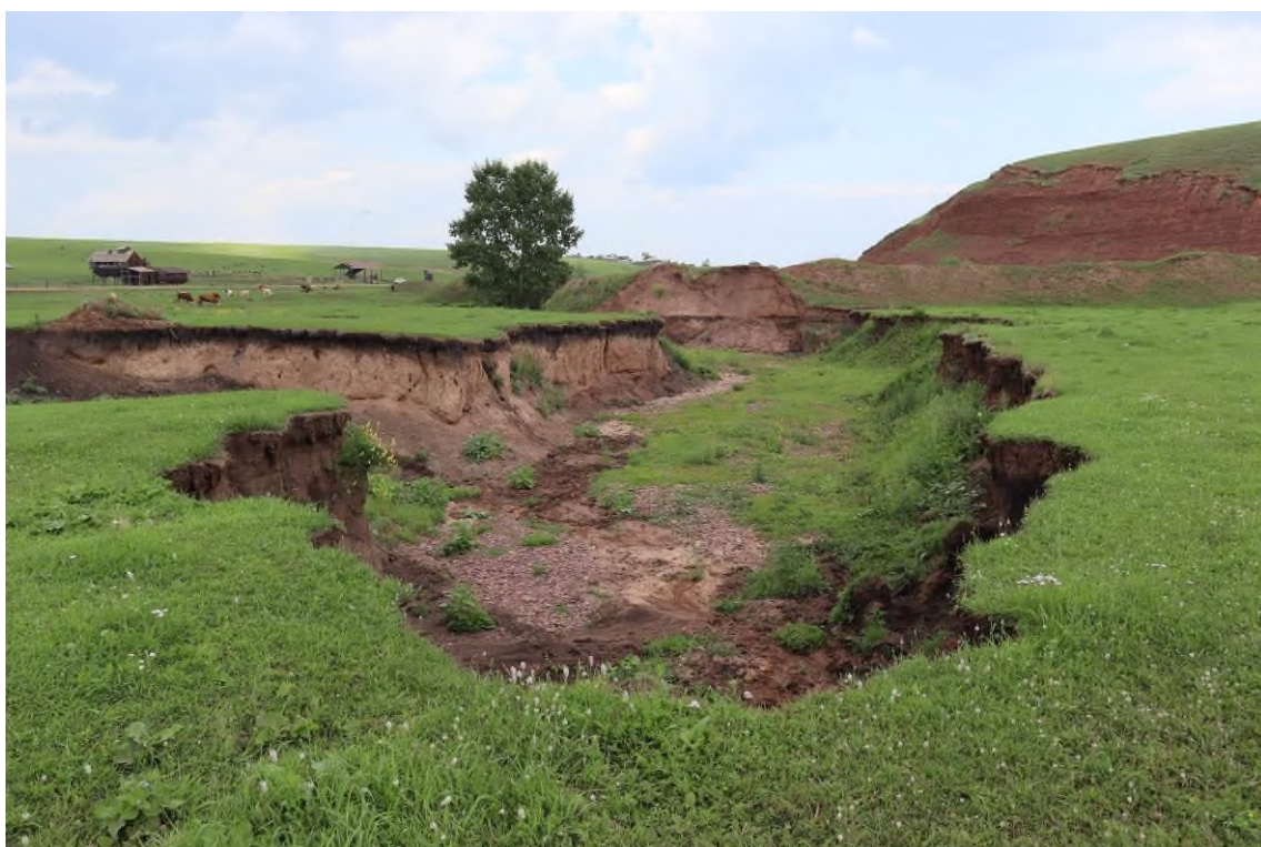
Фото 38-22-00021. Овраг № 8 ПН Закулей вблизи с. Закулей, Нукутский район, Иркутская область, 16.07.2024
