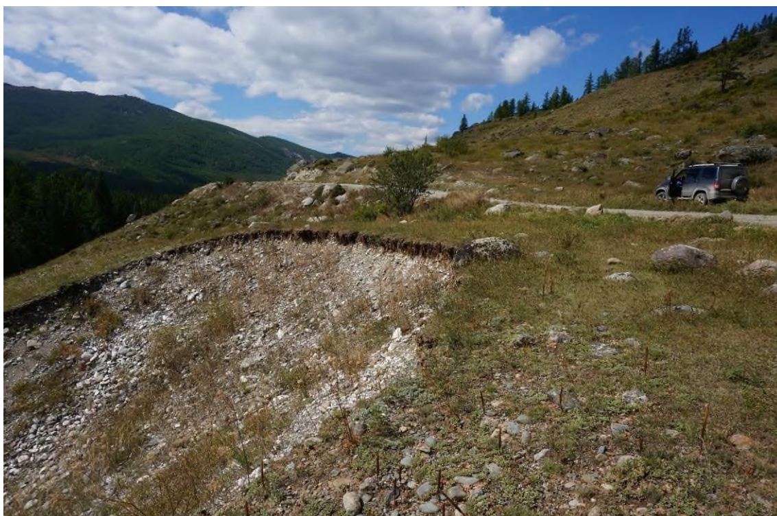
Фото 04-22-00003. Вершина оврага в 5,8 м от дороги, уч. а/дороги Кош-Агач – Джазатор, 128,06 км, Кош-Агачский район, Республика Алтай, 30.08.2024
