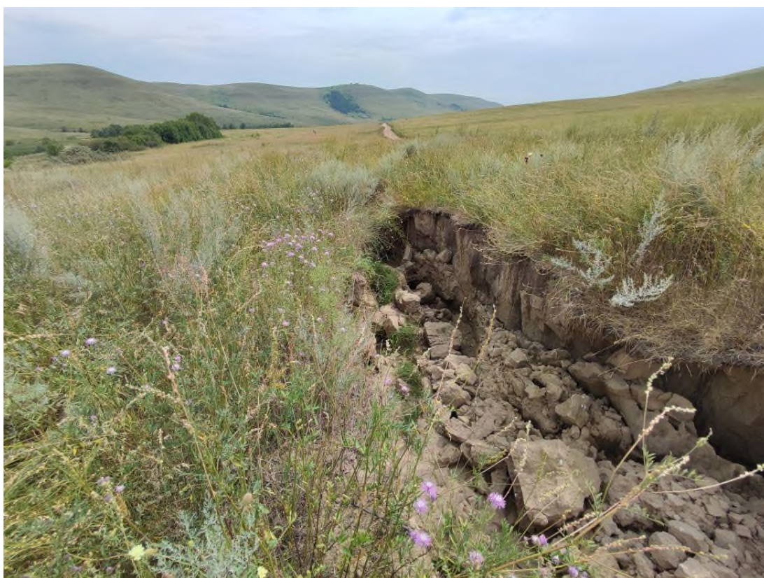
Фото 24-22-00087. Участок свежих обрушений в русле оврага №3, ПН Зубаревский, в 4,6 км СВ д. Быстрая, Минусинский район, Красноярский край, 17.07.2024
