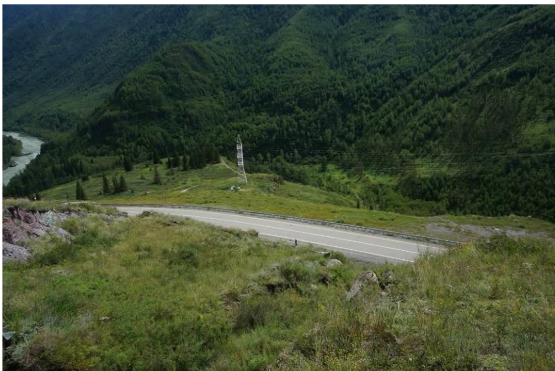
Фото 04-11-00063. Мелкий блоковый оползень с характерным грядовым рельефом и четко выраженными в рельефе границами в виде боковых уступов, уч. а/дороги в Алтайское подворье, 19,5 км, Республика Алтай, Онгудайский район, 19.07.2024
