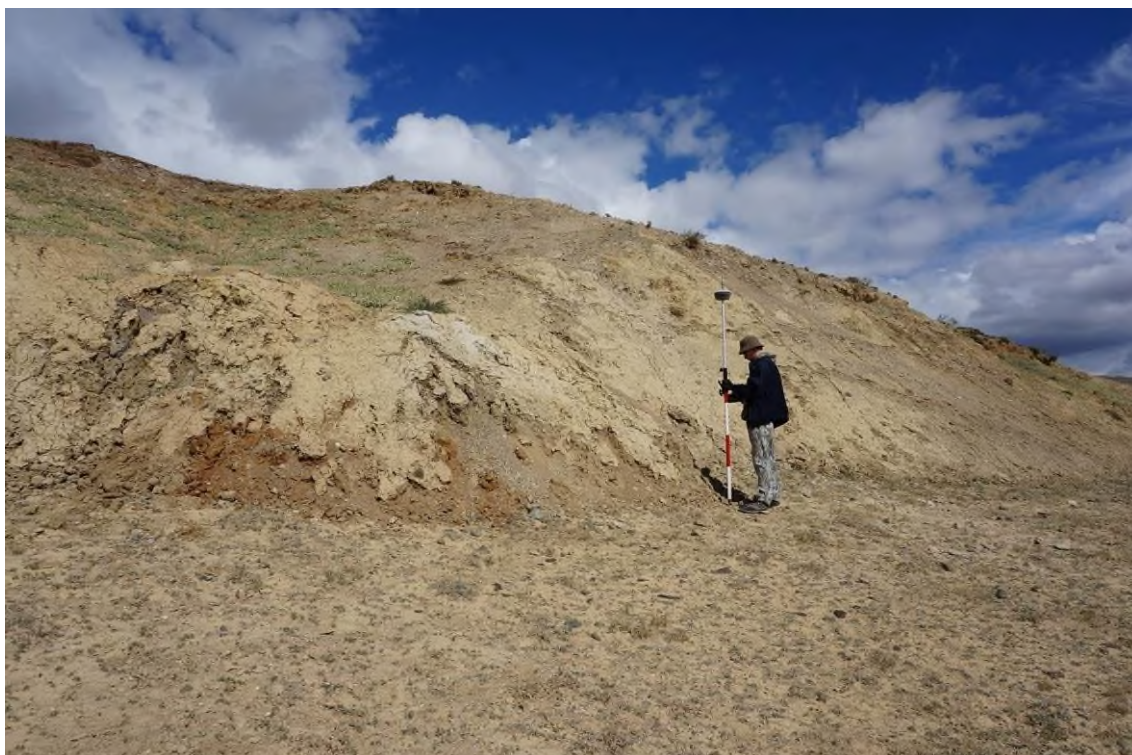
Оползень № 04-11-00016. Фронтальный уступ языка оползня со следами оползания, в 4,5 км севернее с. Ортолык, Кош-Агачский район, Республика Алтай, 02.09.2024
