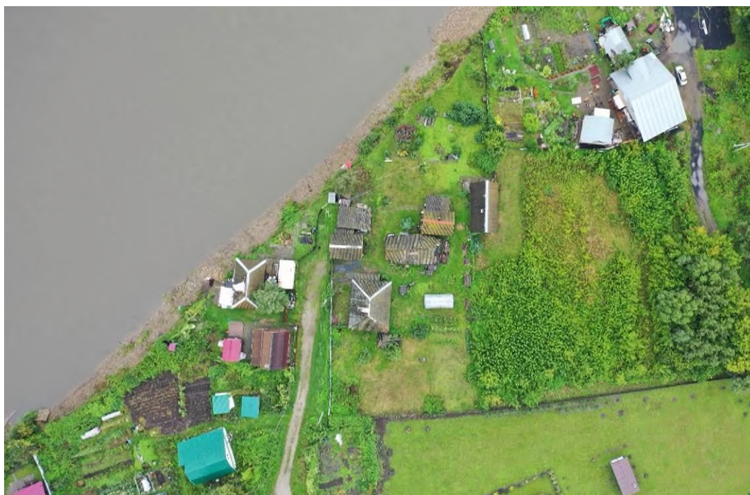
Фото 42-10-00001. Обвальный процесс, разрушение дома и строений по ул. Школьная, 2, с. Боровково, Новокузнецкий район, Кемеровская область-Кузбасс, 04.09.2024
