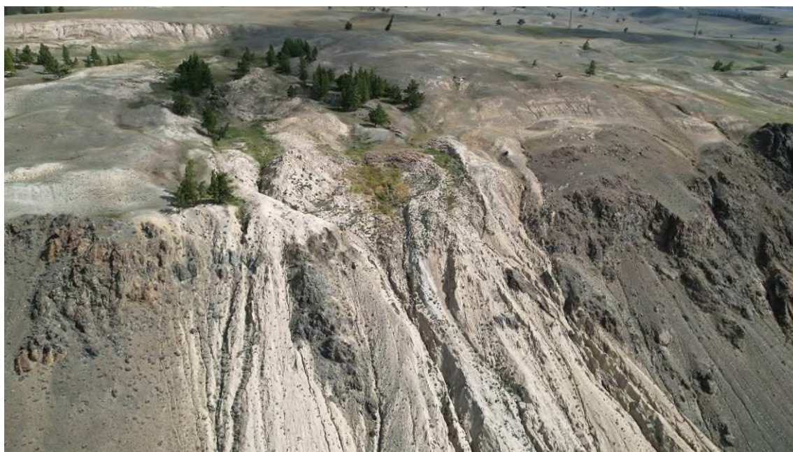
Фото 04-11-00049. Оползень II порядка № 04-11-00049 в языковой части оползня № 04-11-00022, в 0,17 км СВ с. Чаган-Узун, Кош-Агачский район, Республика Алтай, 01.09.2024
