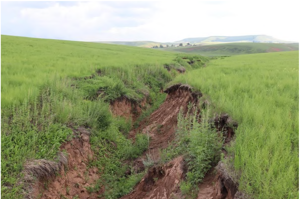
Фото 38-22-00024. Овраг № 11 ПН Закулей вблизи с. Закулей, Нукутский район, Иркутская область, 16.07.2024
