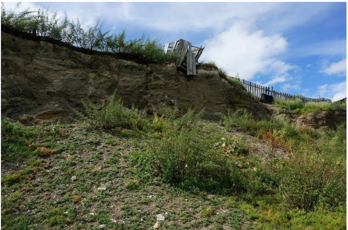
Фото 04-12-00019. Хозпостройки и ограждения усадьбы по ул. Шоссейная, 17 разрушены, с. Кара-Кобы, Онгудайский район, Республика Алтай, 20.07.2024
