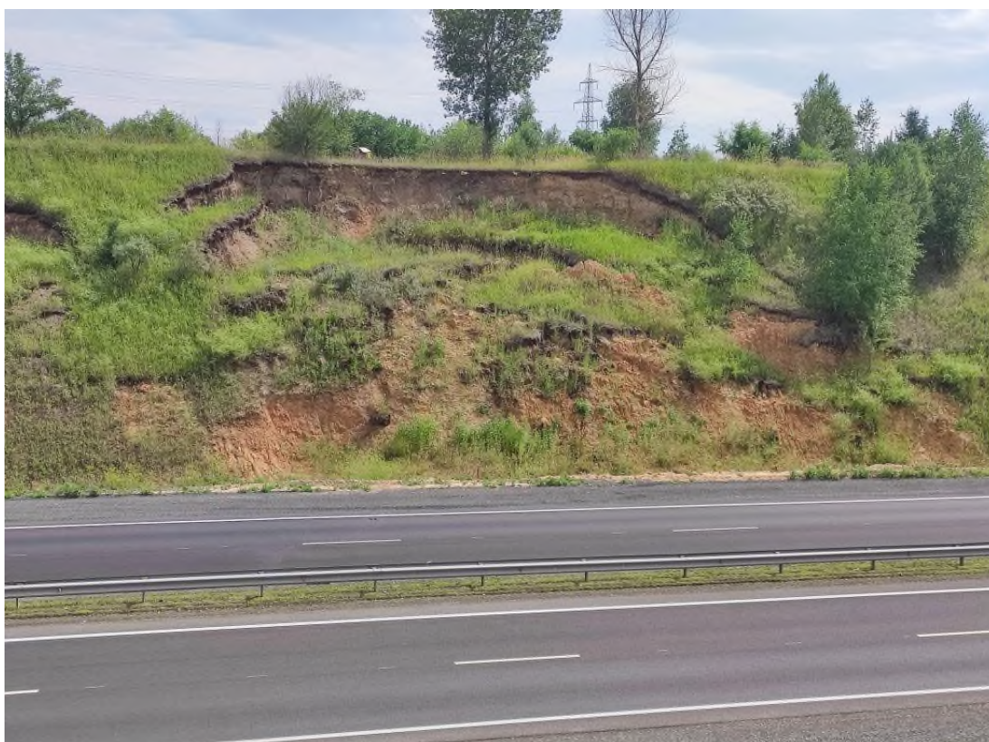
Фото 19-11-00005. Общий вид на оползень 3 на участке а/дороги Р-257, Братский мост, Алтайский район, Республика Хакасия, 19.07.2024
