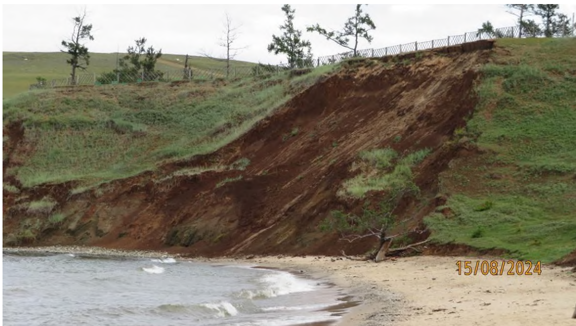
Фото 38-11-00004. Оползень №4, побережье залива Сарайский оз. Байкал, Ольхонский район, Иркутская область, 15.08.2024
