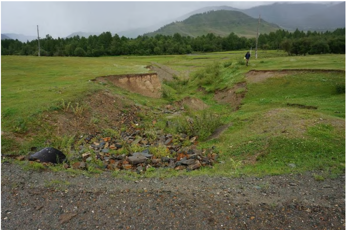
Фото 04-22-00007. Вершина оврага № 1 достигает откосов дороги, уч. а/дороги Туекта – Усть-Кан, 21,08 км, с. Кара-Кобы, Онгудайский район, Республика Алтай, 20.07.2024
