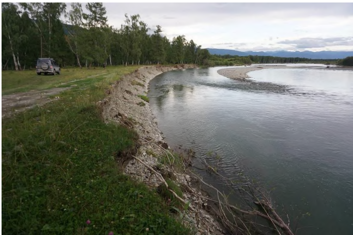
Фото 04-10-00010. Крупный блок оползания шириной до 3,5 м, с глубиной отседания 0,5-0,85 м, в 1,5 м от а/дороги Усть-Кокса – Мараловодка, 2-3 км, Усть-Коксинский район, Республика Алтай, 22.07.2024
