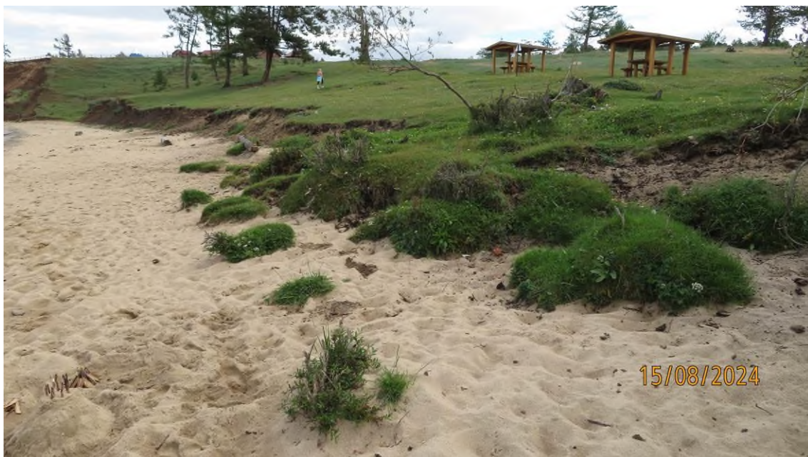
Фото 38-11-00002. Оползень №2, побережье залива Сарайский оз. Байкал, Ольхонский район, Иркутская область, 15.08.2024
