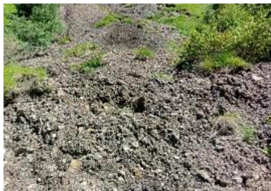
15-11-00135. Оползень-поток в правом борту р.Льядон, км2
