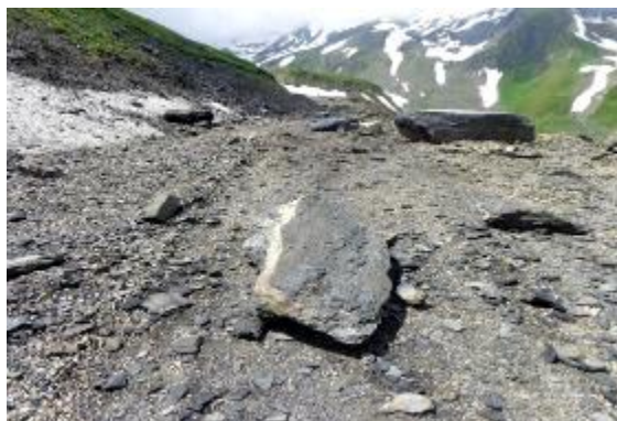
15-12-00041. Подвижная среднеобломочная осыпь на серпантинах технологической дороги газопровода Дзуарикау-Цхинвал, км 95,5
