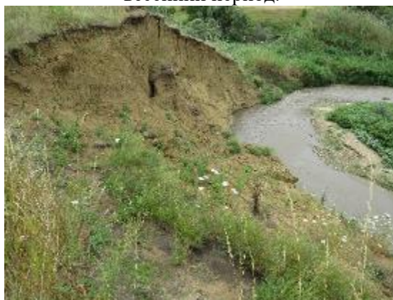
Фото. 26-11-00144. Смещения в левой части оползня.
