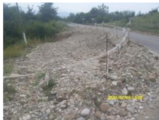
Фото 20-11-00219. 09.07.24. Чеченская Республика. Ножай-Юртовский район, автодорога с. Малые Шуани - с. Бас-Гордали 7,01км. Разрушено полотно дороги покрытием на участке длиной 30м, шириной 2м.
