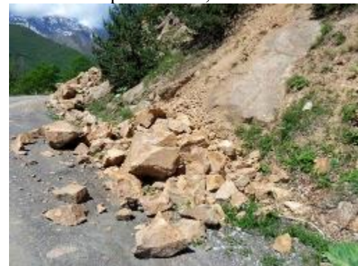
15-12-00027. Крупнообломочная осыпь на км 8,5 автодороги Турбина - В.Згид
