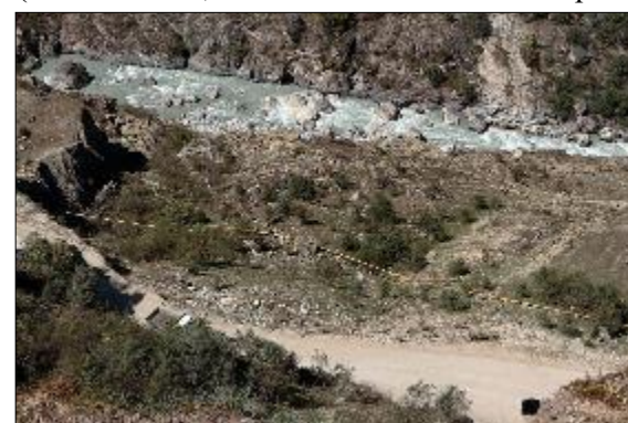
Фото 07-11-00028 – активный участок оползня на верхнем откосе а/д Хуштосырт - Булунгу, в левом борту р. Чегем в 7,6 км ниже с. Эльтюбю Чегемского района. Нижняя часть оползня подрезана при проведении работ по устройству берегозащитных и подпорных сооружений. (30.08.2024 г., ООО «Каббалкгеомониторинг»)
