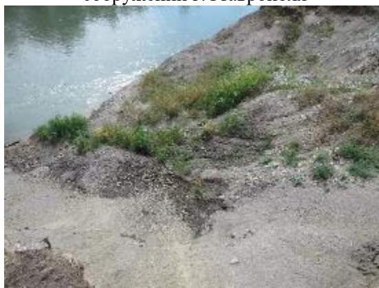
Фото. 26-11-00043. Смещения низкой интенсивности на локальных участках в центральной и левой частях оползня.
