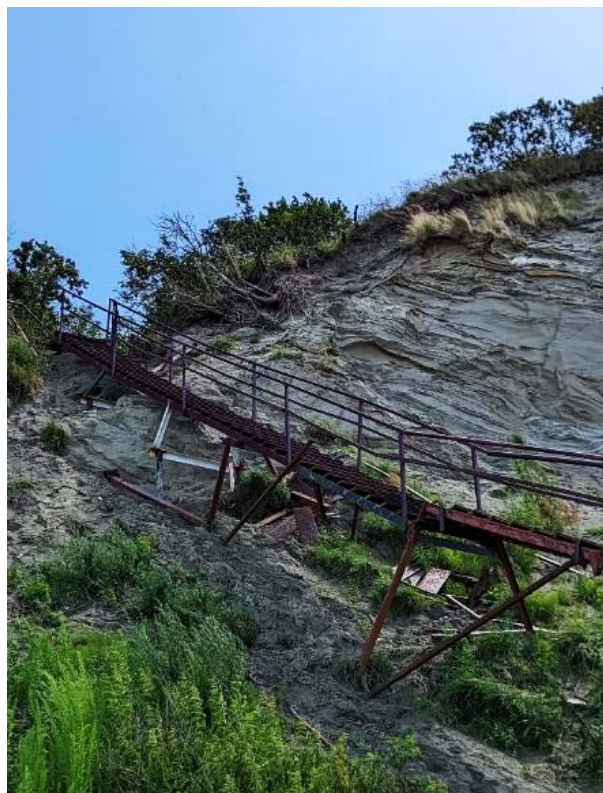
Фото 9, 10. Металлическая спусковая лестница в аварийном состоянии, пгт. Донское.
