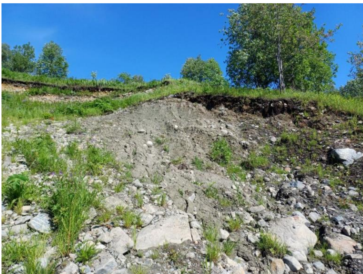
Фото 75, 76. Свежие натёки грунта на теле оползня. Нижне-Ростинское шоссе, 200 м от автобусной остановки «Контейнерная»
