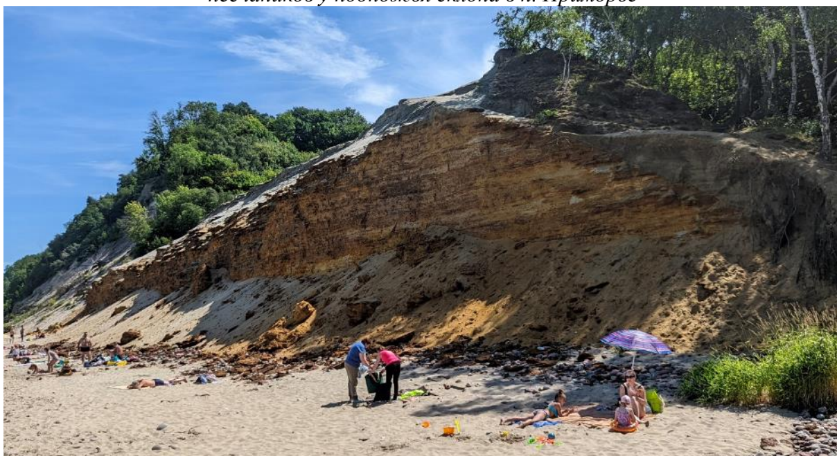
Фото 28. Обвално-осыпные массы и сплывы суглинистых прослоек в п. Приморье
