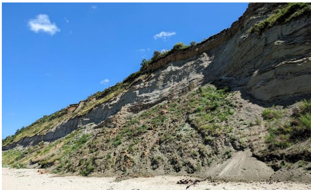
Фото 11. Крупный оползень на береговом склоне в пгт. Донское
