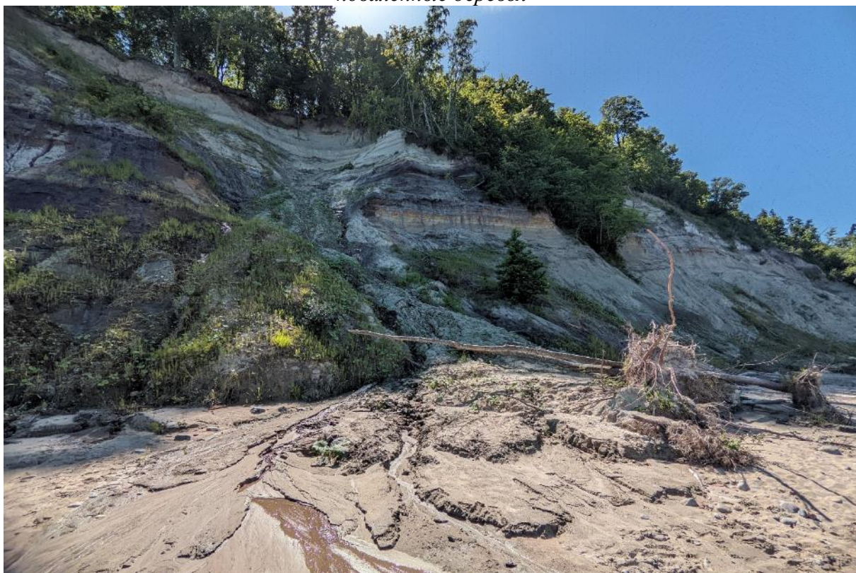
Фото 40. Сплыв на оползневом склоне с поваленными деревьями
