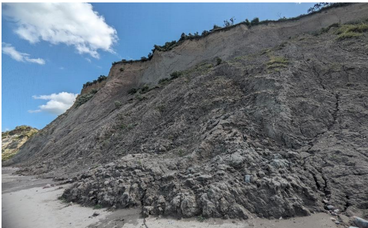
Фото 8. Свежие оползневые массы у подножья берегового склона в пгт. Донское
