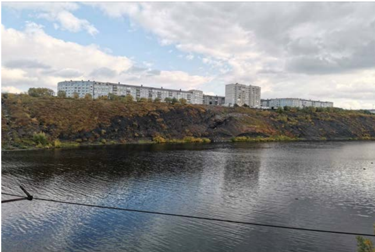
Фото 102. Общий вид на оползневой процесс, МО ГО "Воркута", Участок Шахтёрская набережная
