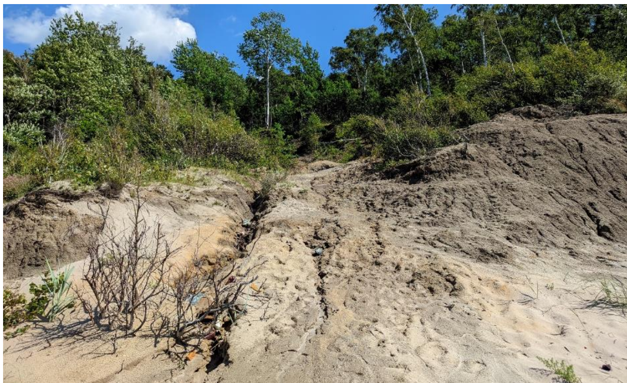
Фото 18. Промоины и бугры перед оползневым цирком, ТН 4, д. Маяк, 05.07.24 г.
