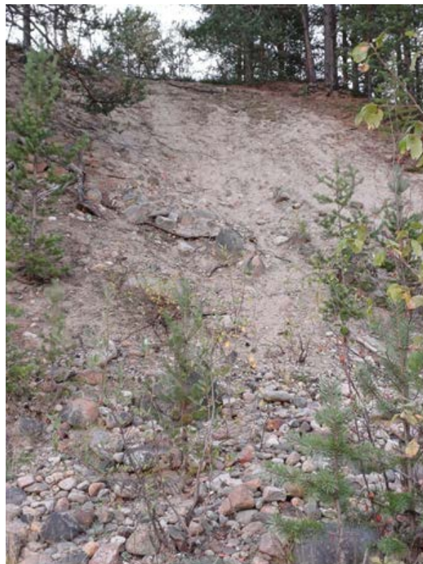
Фото 68. Незадернованный оползневой склон, свежие отрывы бровки, оголённые корни деревьев. Кольский р-он, пос. Лопарская, правый берег р. Кола у моста.
