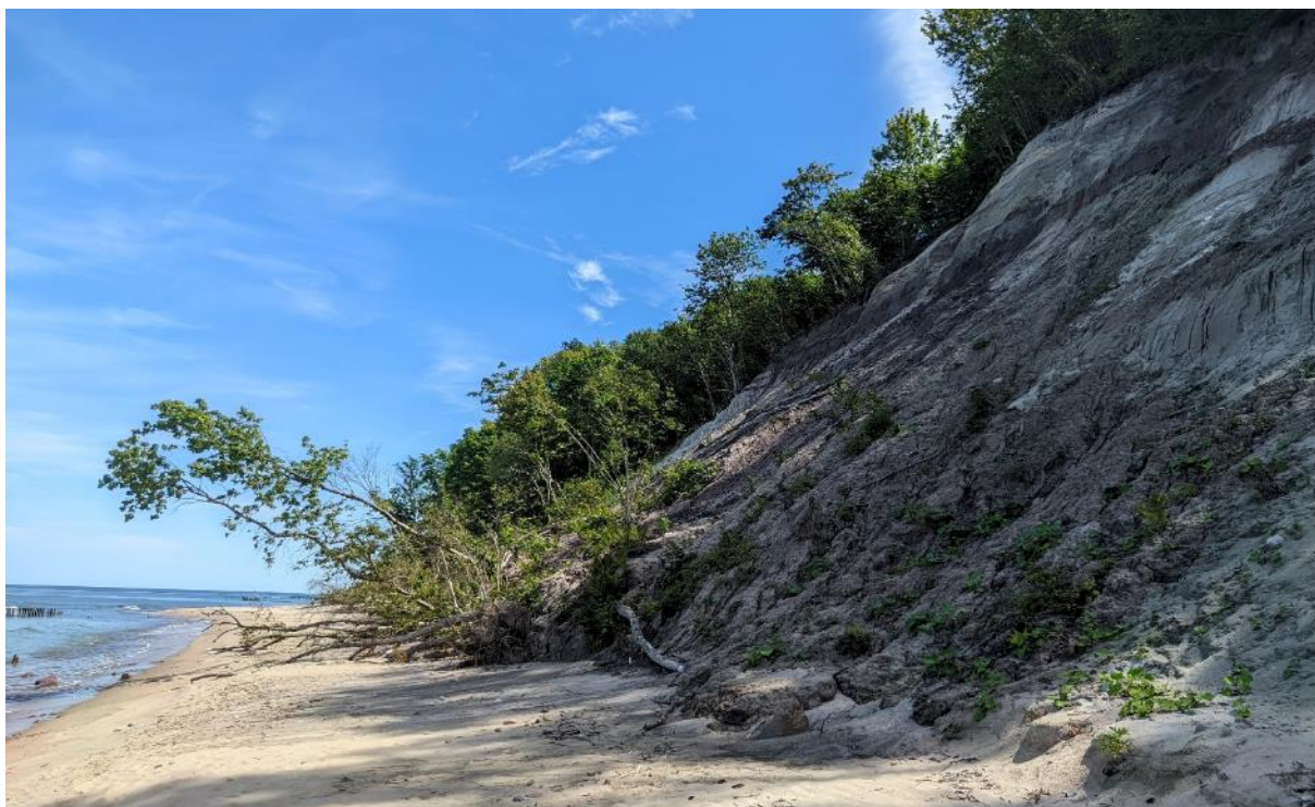
Фото 33. Свежие оползневые массы вдоль берегового склона в п. Приморье, делювиально-коллювиальные продукты и оползшие деревья.
