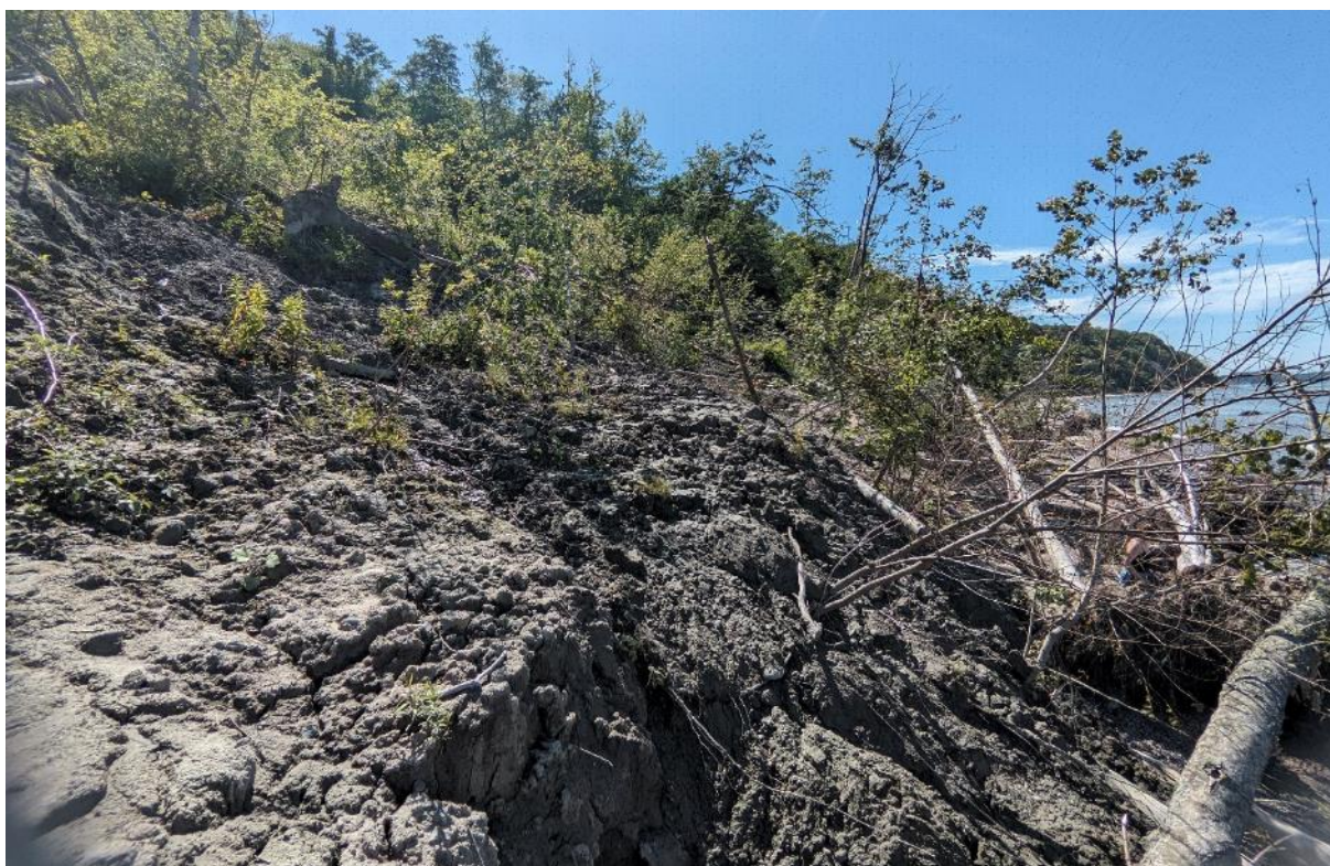
Фото 38. Крупные свежие оползневые массы с обилием поваленных деревьев и другой растительности, практически полностью перекрывшие территорию пляжа до уреза воды
