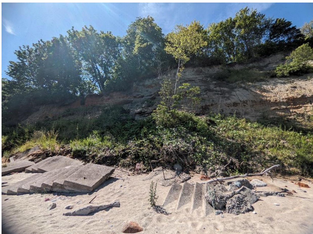
Фото 21. Разрушенная бетонная лестница у нижней бровки склона в п. Филино
