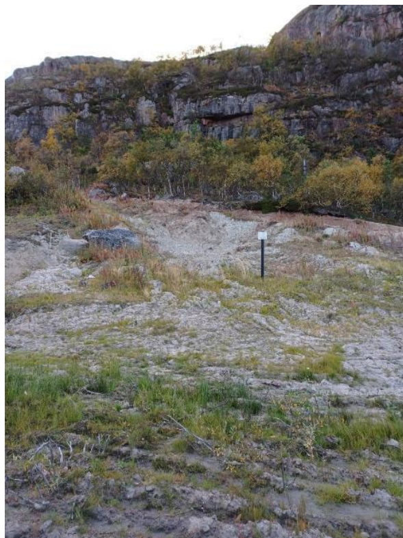
Фото 77. Проявление овражной эрозии на придорожном склоне. Кольский район дорога на Териберку 47К-051, 5 км от пос. Териберка.
