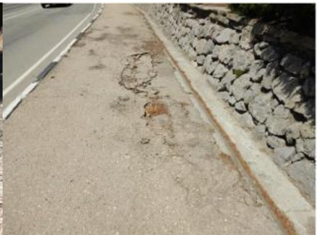
Фото 24. Деформации асфальтового покрытия тротуара и верховой подпорной стены, приуроченные к правому борту локального очага. Проявление опасного ЭГП № 91-11-01806.
