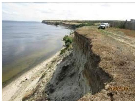
Фото 34-10-00015. Обвальное проявление вдоль берегового уступа в с. Горноводяное Дубовского р-на. Ширина обвалов на всем проявлении составила 1,5 м.
