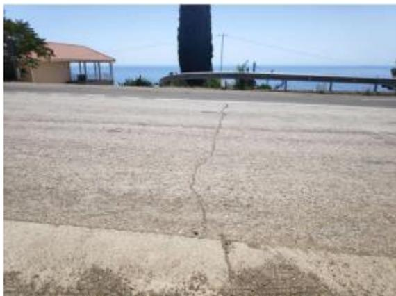
Фото 1. Оползень № 834, верхняя часть, левый борт. Трещина на асфальте а/д 35 ОП РЗ 35К-005. Проявление опасного ЭГП № 91-11-05201
