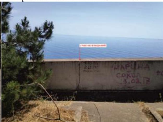
Фото 6. Оползень № 736, языковая часть. Трещины на анкерной подпорной стене. Проявление опасного ЭГП № 91-11-05506
