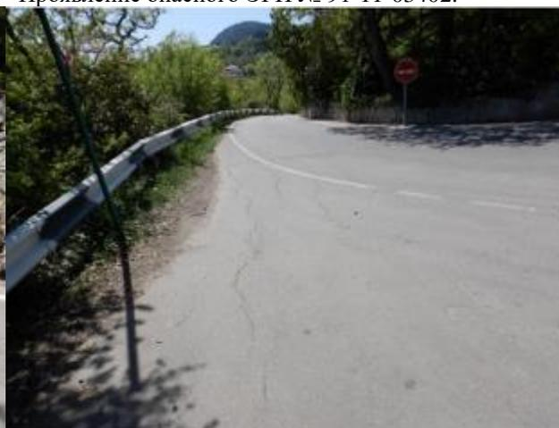
Фото 34. Деформации на асфальтовом покрытии дороги, приуроченные к головной части оползневого очага. Проявление опасного ЭГП № 91-11-03501.
