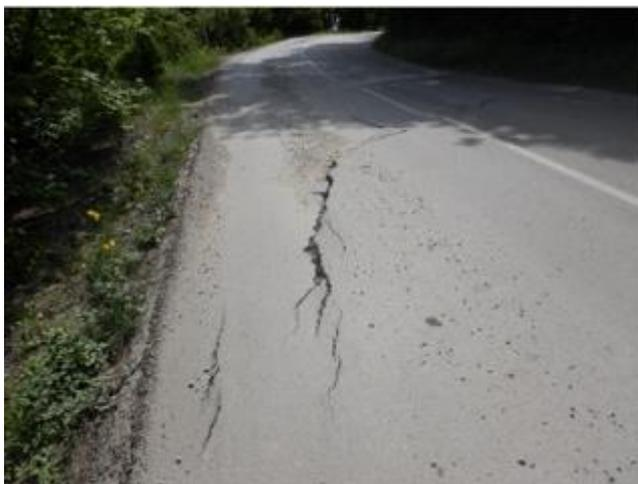
Фото 25. Свежие деформации асфальтового покрытия в районе левого борта оползневого очага оползня №20 Восточно-Кикенеизский. Величина опускания 8,0 см. Проявление опасного ЭГП № 91-11-01901
