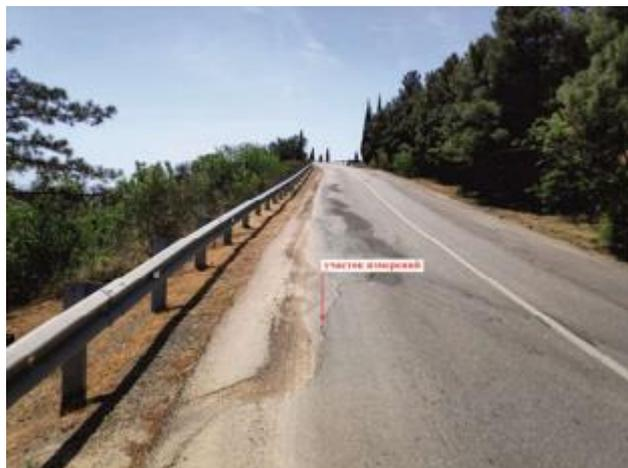
Фото 5. Оползень № 736, верхняя часть. Деформации и трещины шириной 5-10 мм на асфальте, а/д 35 ОП РЗ 35К-005. Проявление опасного ЭГП № 91-11-05506
