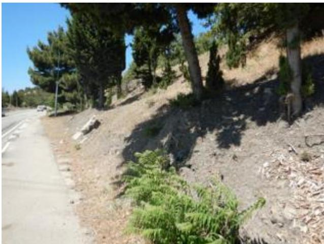
Фото 23. Языковая часть оползня со стороны верхового склона Южнобережного шоссе. Проявление опасного ЭГП № 91-11-01806.
