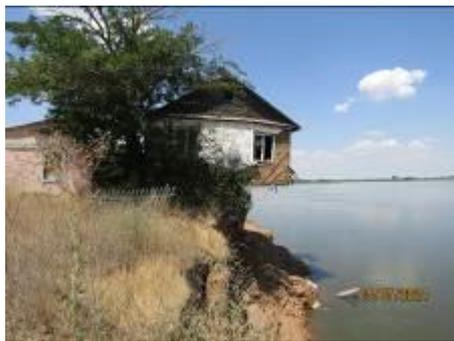
Фото 30-10-00015. Обвальное проявление на правом берегу р. Бахтемир, в с. Сергиевка Икрянинского района. Продолжается разрушение жилых домов вдоль кромки берегового уступа. Средняя ширина обвальной зоны берега составила 1,5 м. (Фото филиала ЮРЦ ГМСН ФГБУ «Гидроспецгеология»)
