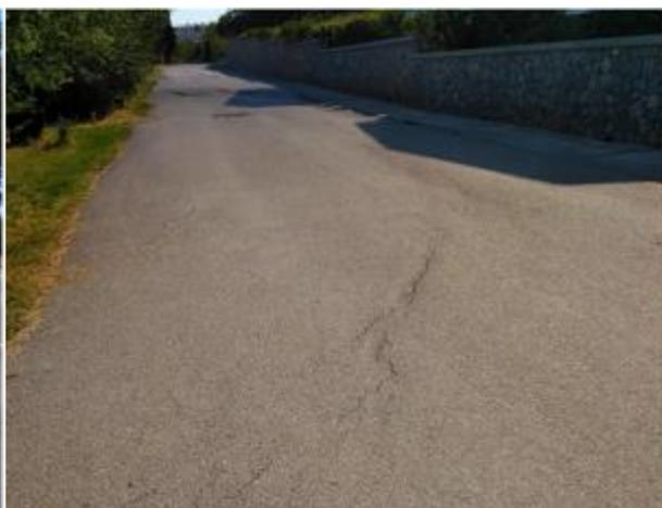
Фото 28. Деформации асфальтового покрытия в районе левого борта оползня №29. Ширина раскрытия 1 см. Проявление опасного ЭГП № 91-11-02306.
