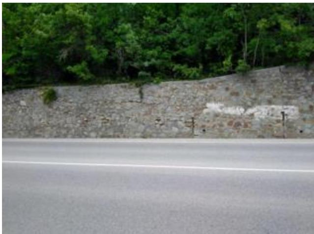
Фото 31. Деформации верхней стены, приуроченные к правому борту локального очага. Проявление опасного ЭГП № 91-11-03402.
