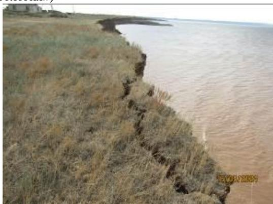
Фото 34-10-00008. Обвальное проявление в х. Рыбный Николаевского р-на. Вдоль бровки уступа видны трещины закола, по которым формируются блоки отрыва. Средняя ширина обвальной зоны берега составила 4,68 м. (Фото филиала ЮРЦ ГМСН ФГБУ «Гидроспецгеология»)
