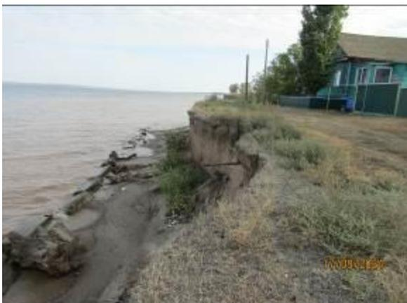
Фото 34-10-00006. Обвальный берег напротив средней части с. Кислово. Быковского района. Берег укреплен защитными бетонными блоками. Средняя ширина обвальной части берега составила 0,18 м.
