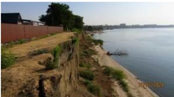
Фото 61-10-0062. Активизация обвального процесса в пределах берегового уступа. В верхней части уступа отмечаются свежие стенки срыва. Дата 19.07.2024. Неклиновский район, с. Петрушино, 2й-3й переулки.
