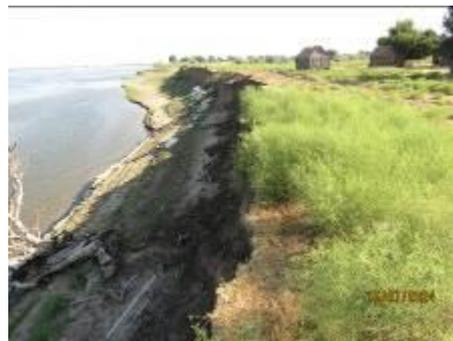
Фото 30-10-00016. Обвальное проявление на левом берегу р. Волги, в с. Петропавловка Наримановского района. Средняя ширина обвальной зоны берега составила 0,9 м. (Фото филиала ЮРЦ ГМСН ФГБУ «Гидроспецгеология»)
