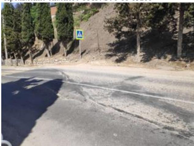
Фото 3. Оползень № 732, нижняя часть, левый борт. Трещины и деформации на а/д 35 ОП РЗ 35К-005. Проявление опасного ЭГП № 91-11-05501
