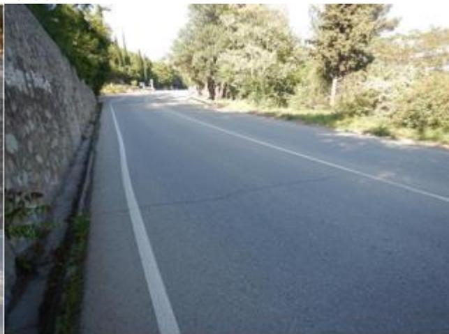
Фото 30. Свежие деформации на асфальтовом покрытии Алушкинского шоссе, приуроченные к левому борту оползня. Величина раскрытия - 1 см. Проявление опасного ЭГП № 91-11-03401.
