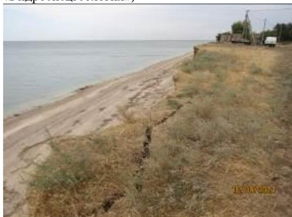
Фото 34-10-00024. Обвальный берег х. Веселый Котельниковского района. Вдоль бровки уступа происходит образование трещин закола и обвалы отдельных блоков пород. Ширина обвалов берегового уступа составила 2,54 м. (Фото филиала ЮРЦ ГМСН ФГБУ «Гидроспецгеология»)
