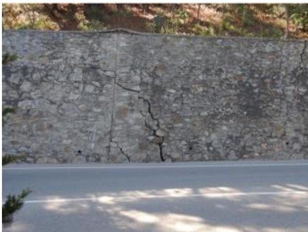
Фото 29. Деформации на верховой подпорной стене Алушкинского шоссе, приуроченные к левому борту оползня. В нижней части стены величина раскрытия - 7 см, в средней части стены величина раскрытия - 4 см, фронтальное смещение 3 см. Проявление опасного ЭГП № 91-11-03401.
