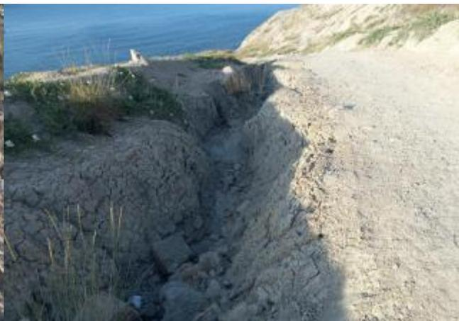
Фото 20. Эрозия грунтового проезда, частично попадающего на территорию оползня № 1836. Визуально – углубление оврага. Проявление опасного ЭГП № 91-11-06403.
