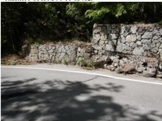
Фото 33. Частичное разрушение верхней подпорной стены, выполненной габионами, приуроченное к правому борту оползня №54. Проявление опасного ЭГП № 91-11-03501.
