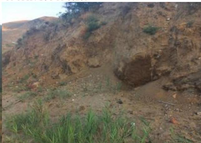
Фото 16. Мочажины в основании абразионного клифа между территориями оползней 637 и 1850, осыпь щебенистого грунта. Проявление опасного ЭГП № 91-11-06202
