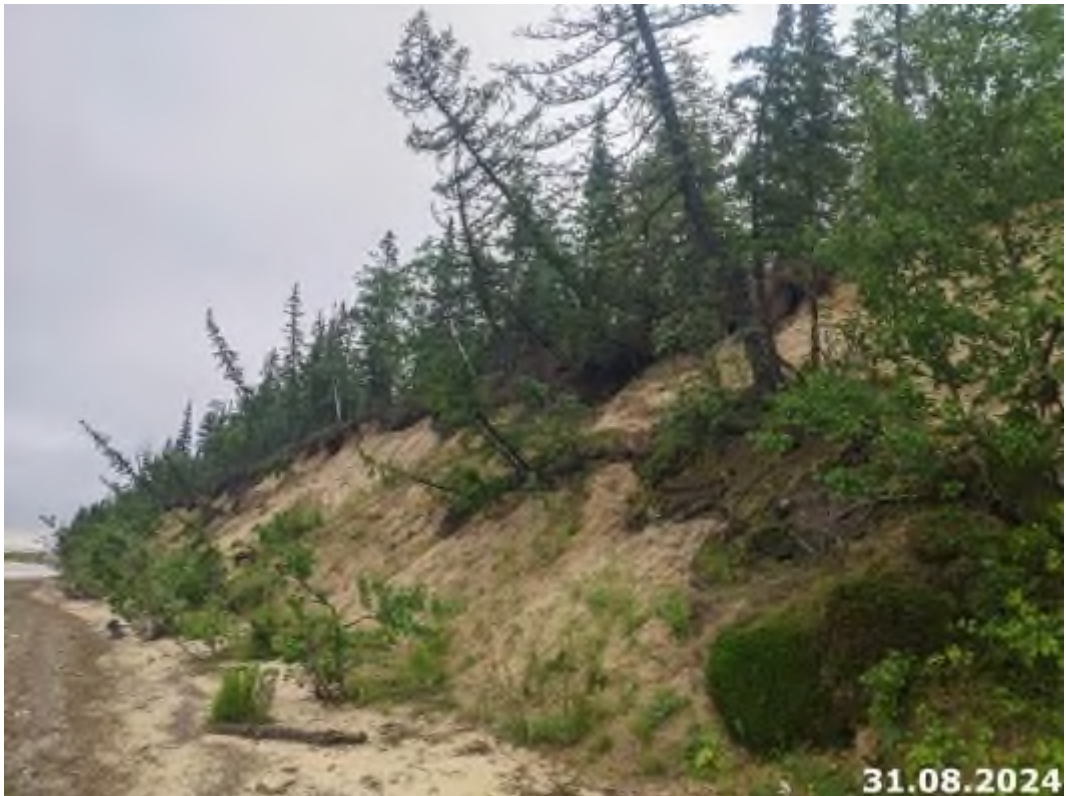
Фото 89-1210-0001-4. Осыпные и оползневые процессы вдоль правого берега р. Обь в ТН 805. Участок Обский, ЯНАО
