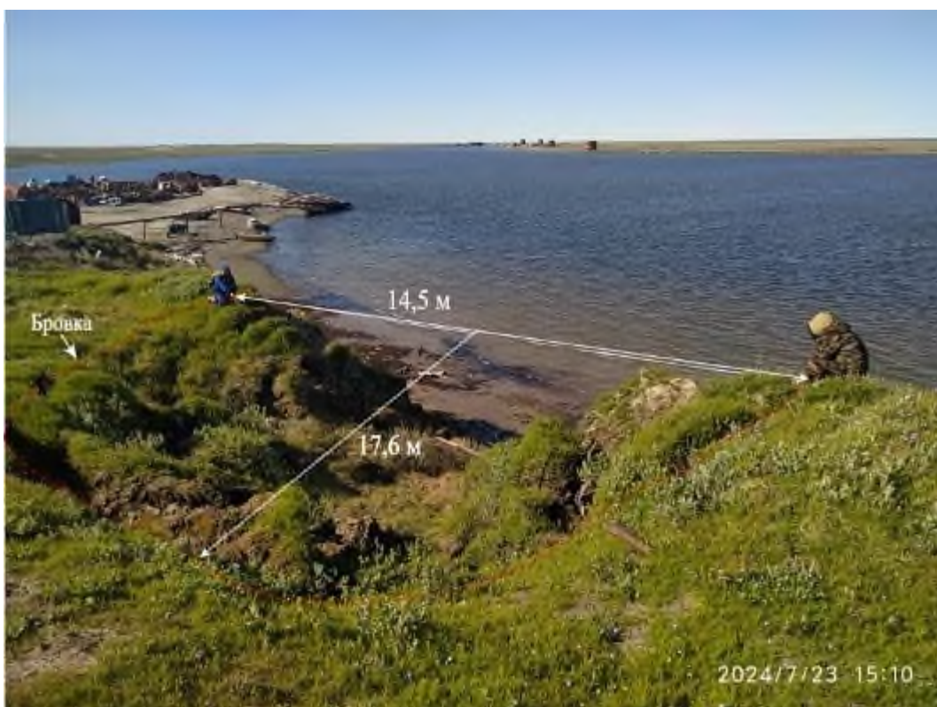
Фото 89-27-00233. Термоэрозионный процесс в районе причала в ТН 10. Участок Сеяхинский. ЯНАО
