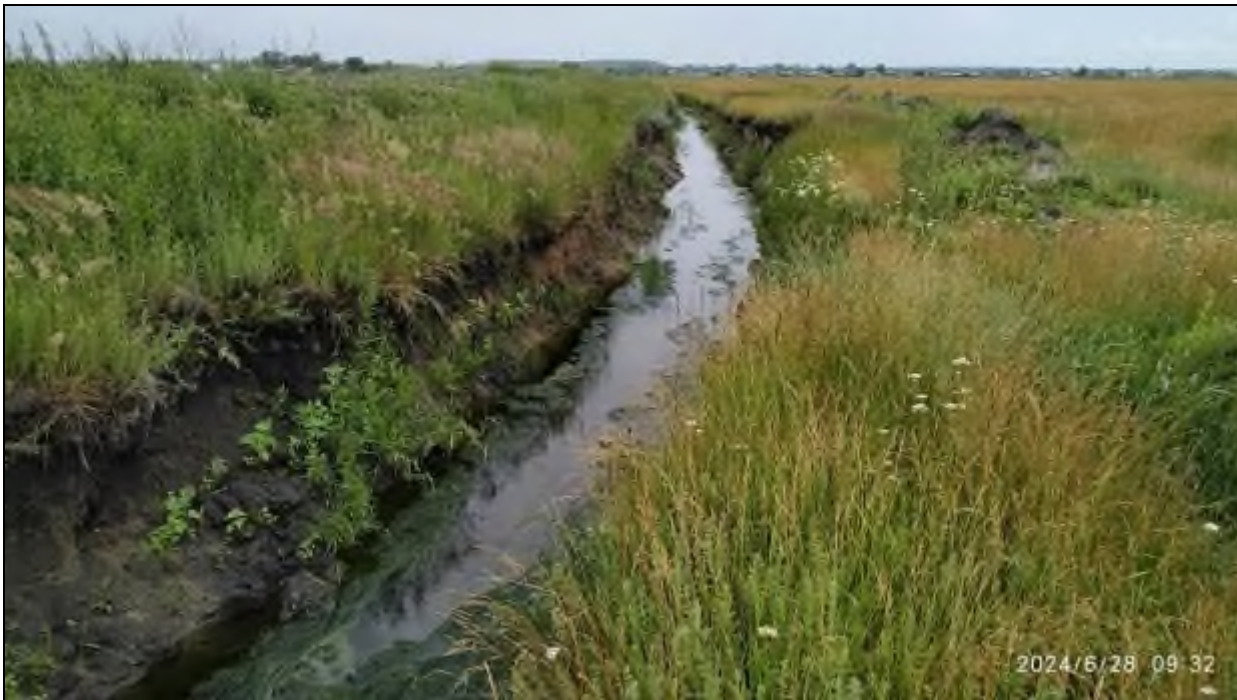
Фото 74-22-00023. Водоотводная канава вдоль рекультивированного оврага в ТН 4. Еманжелинский участок Челябинская область
