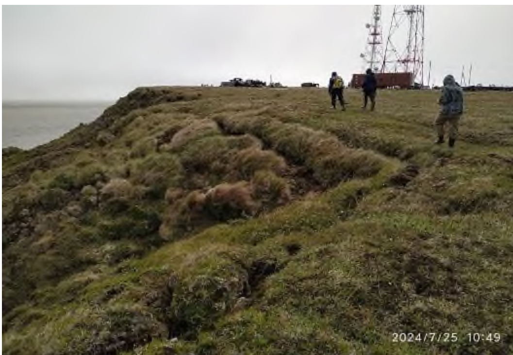
Фото 89-27-00228. Оползание оттаявшего грунта на побережье Обской Губы в районе вышек связи в ТН 5. Участок Сеяхинский, ЯНАО
