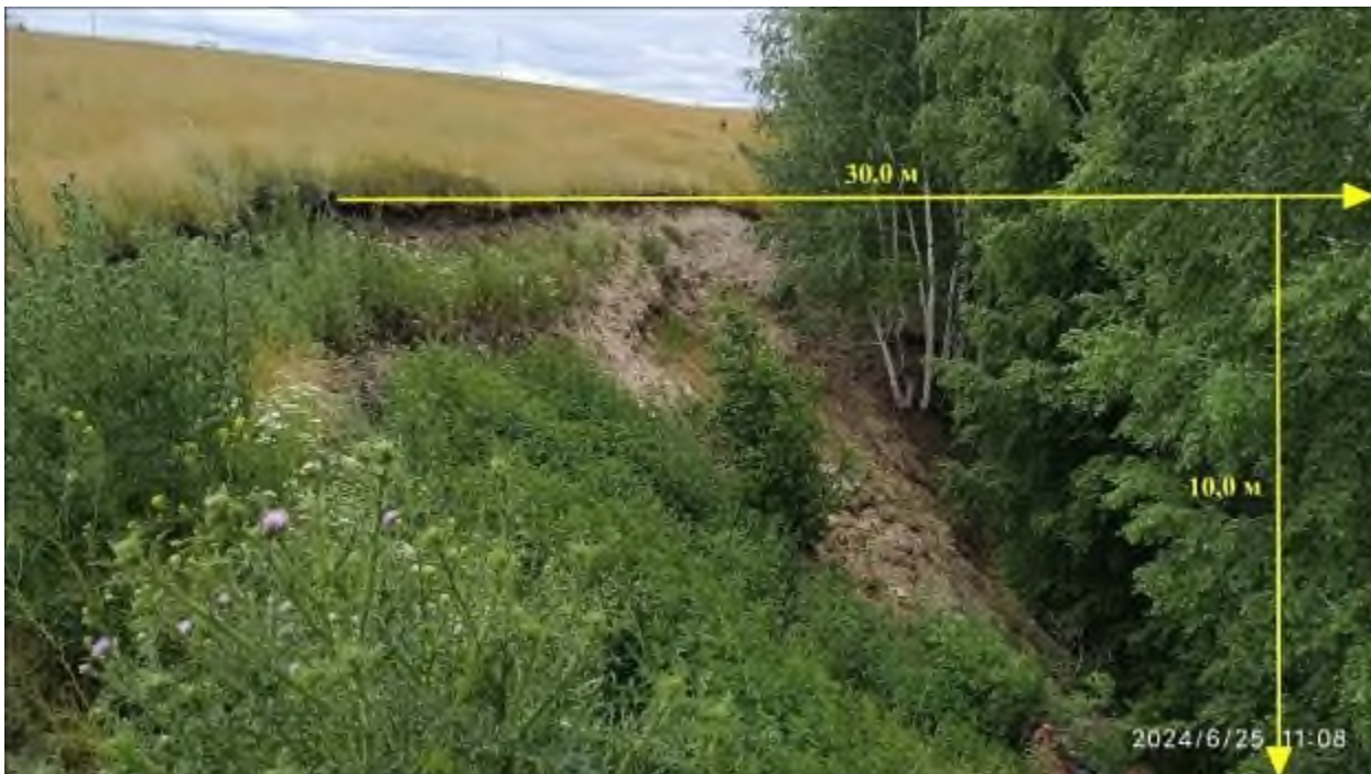
Фото 74-22-00256. Активный осыпающийся участок по правому борту оврага в ТН 19. Участок Троицкий Челябинской области
