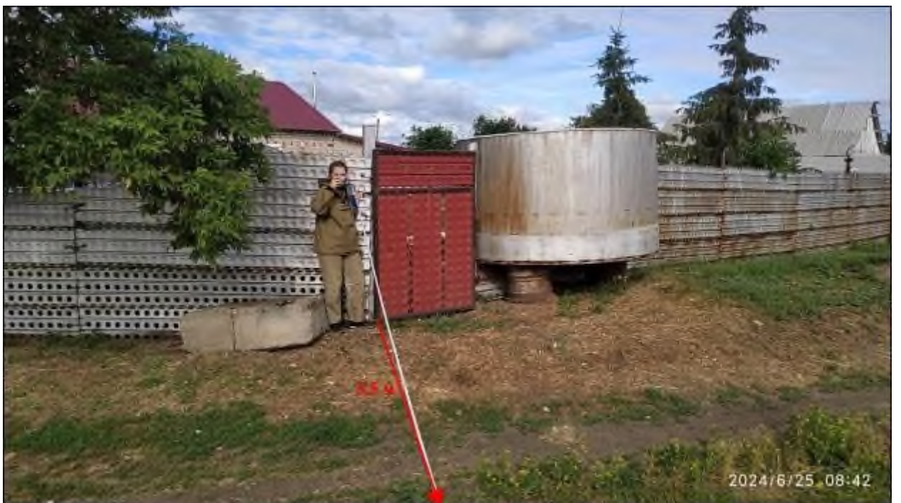
Фото 74-12-00240. Расстояние от калитки дома № 2 по ул. Южная в с. Клястицкое до отсыпанной бровки по правому берегу р. Солодянка, в ТН 3. Участок Троицкий Челябинской области
