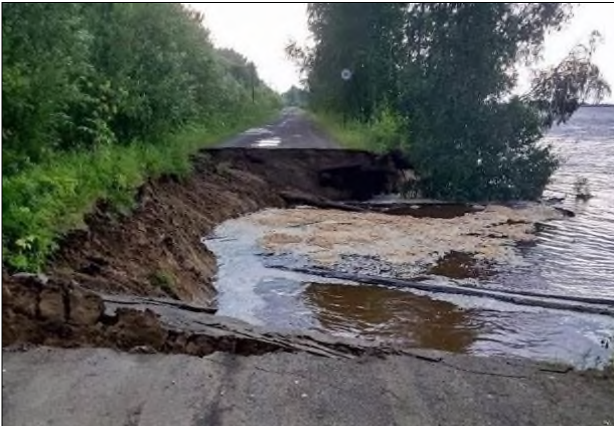
Фото 3. Разрушение эрозионным процессом автодороги Стрежевой-д. Соснина вблизи границы Нижневартовского района ХМАО-Югры и Томской области. Фото из телеграмм канала «Юграч» от 28.07.2024
