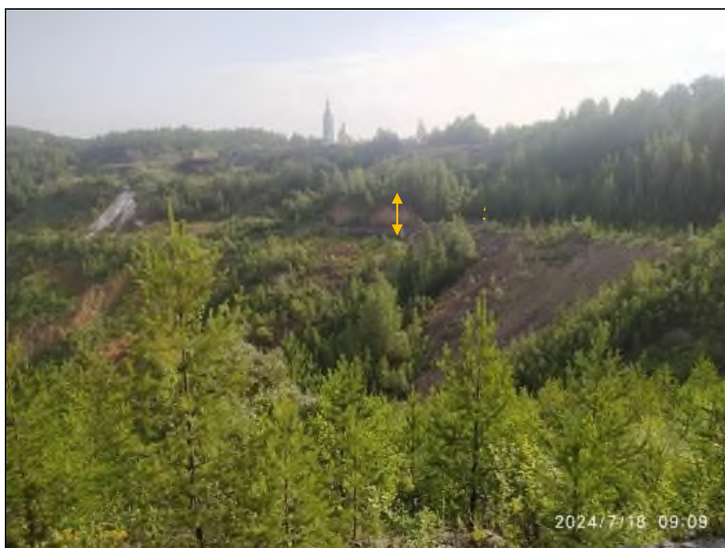
Фото 66-11-00554. Оползневой процесс на борту Меднорудянского карьера (ТН 80-1). Нижнетагильский участок Свердловская область
