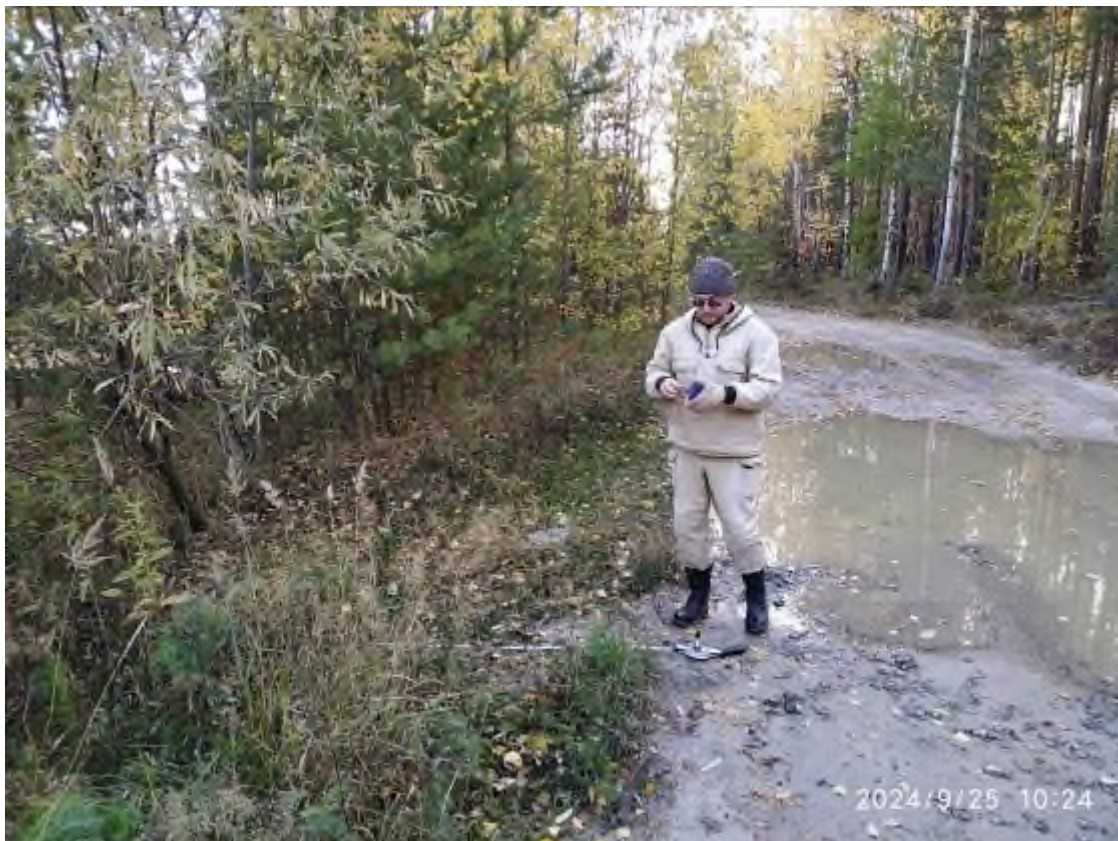
Фото 86-22-00128. Замеры расстояния от вершины оврага до грунтовой автодороги в ТН 8. Урайский участок ХМАО-Югра
