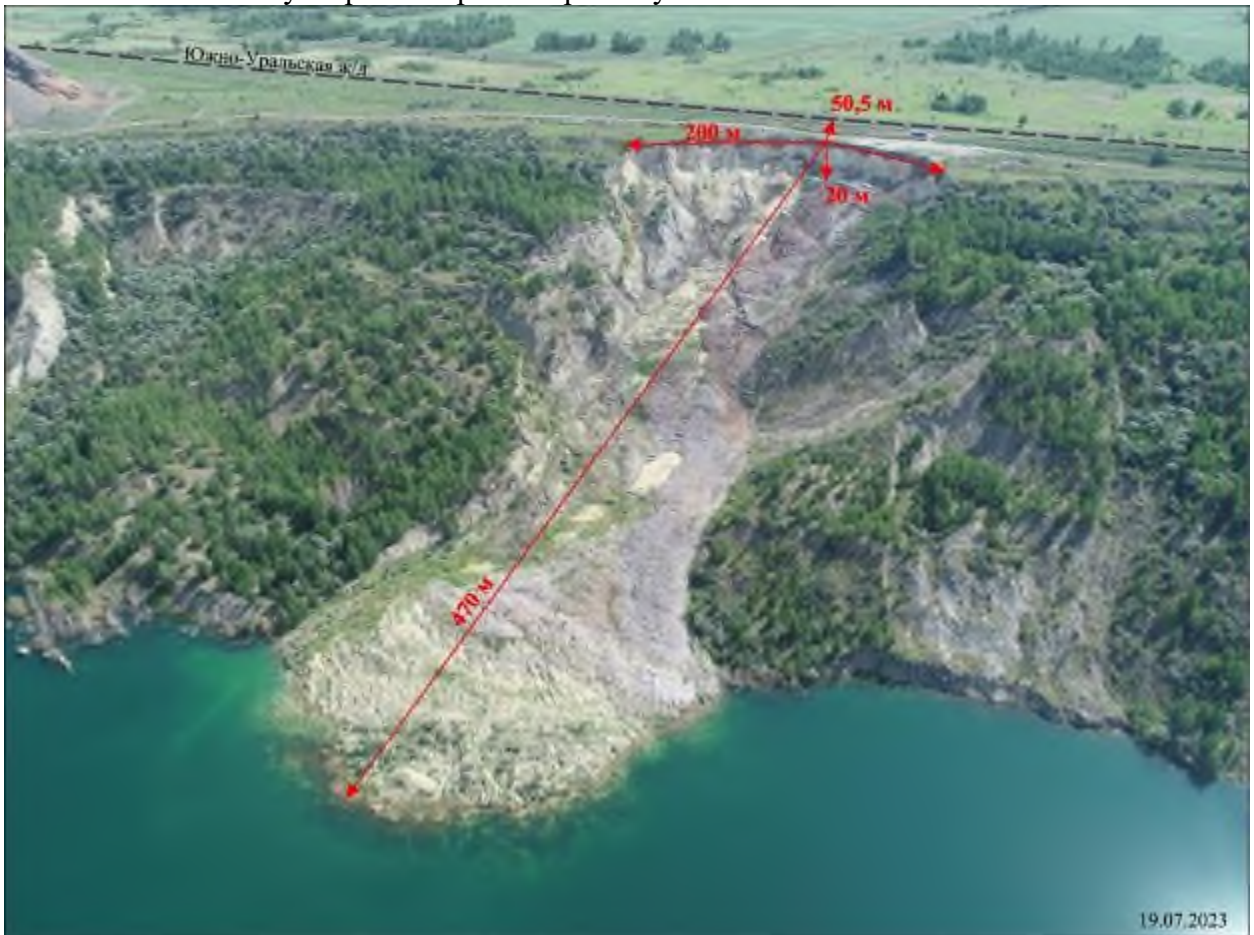
Фото 74-11-00172. Оползень, потенциально угрожающий железнодорожной линии в ТН 2. Красногорский участок Челябинская область
