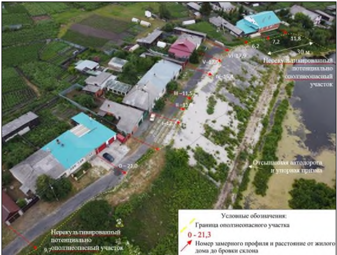
Фото 66-11-00310. Общий вид рекультивированного оползневого участка в с. Усть-Ницинское. Усть-Ницинский участок Свердловская область
