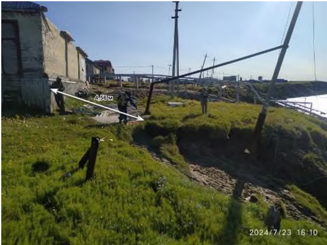
Фото 89-1210-0002-14. Термоцирк в ТН 14. Участок Сеяхинский, ЯНАО
