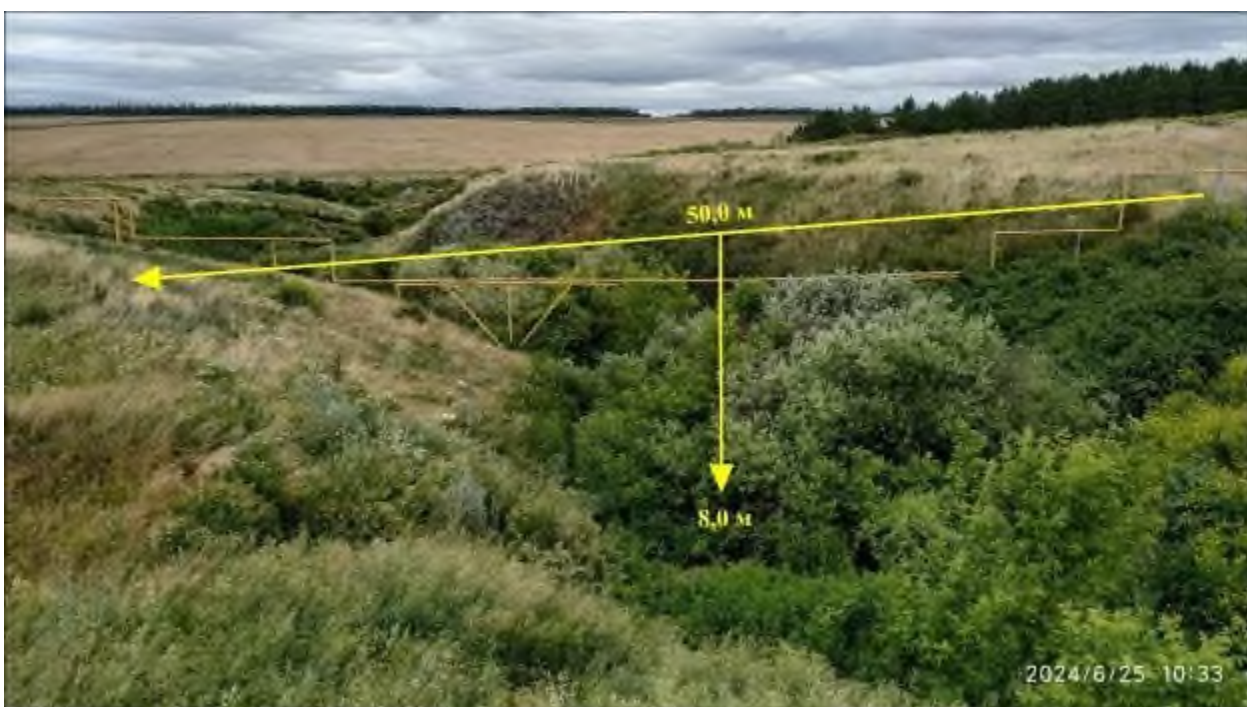
Фото 74-22-00252. Вид на устьевой участок оврага с дамбы в ТН 15. Участок Троицкий Челябинской области
