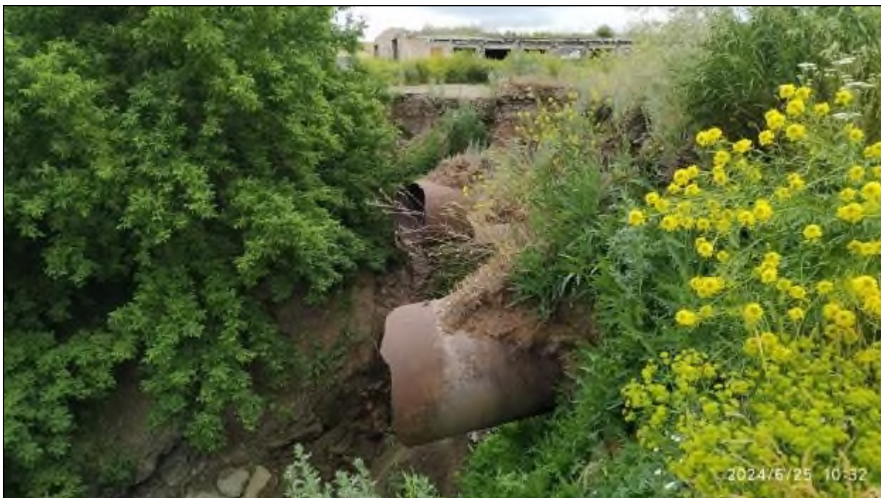
Фото 74-22-00252. Сбросные трубы под грунтовой автодорогой, в дамбе в ТН 15. Участок Троицкий Челябинской области
