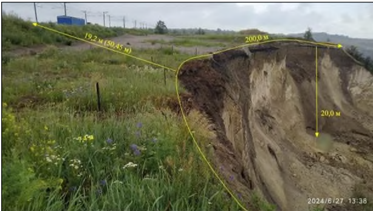
Фото 74-11-00172. Бровка отрыва и расстояние от железнодорожной линии в ТН 2. Красногорский участок Челябинская область
