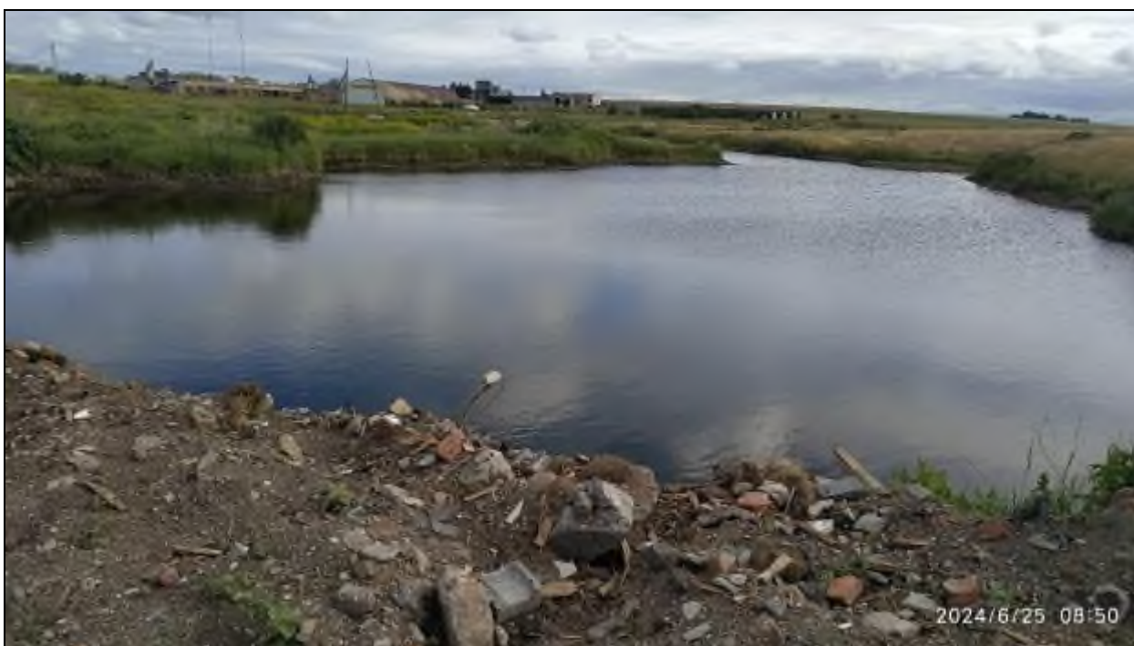
Фото 74-12-00241. Пруд и грунтовая дамба на р. Солодянка в с. Клястицкое, ТН 4. Участок Троицкий Челябинской области
