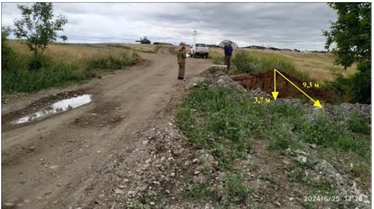
Фото 74-22-00262. Вершина оврага в пос. Тогузак в районе дома № 2 по ул. Правобережная, в ТН 25. Участок Троицкий Челябинской области
