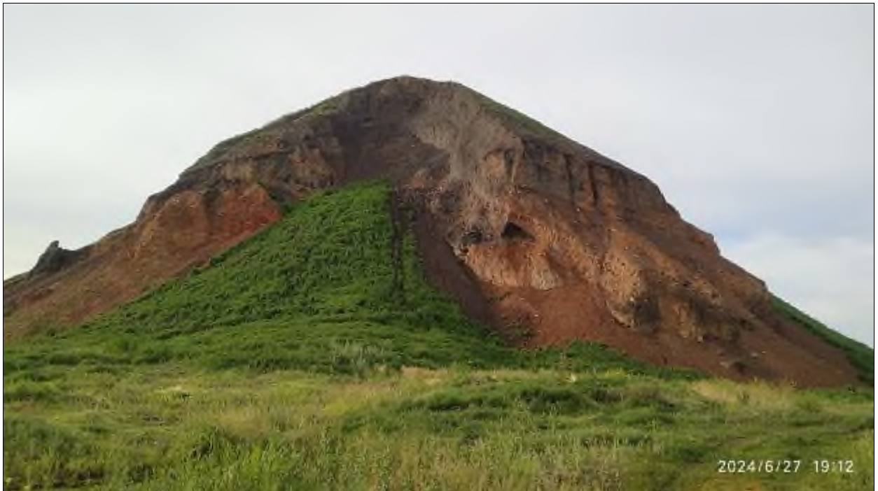
Фото 74-11-00233. Оползание и осыпание склонов террикона бывшей угольной шахты Куллярская. Красногорский участок Челябинская область
