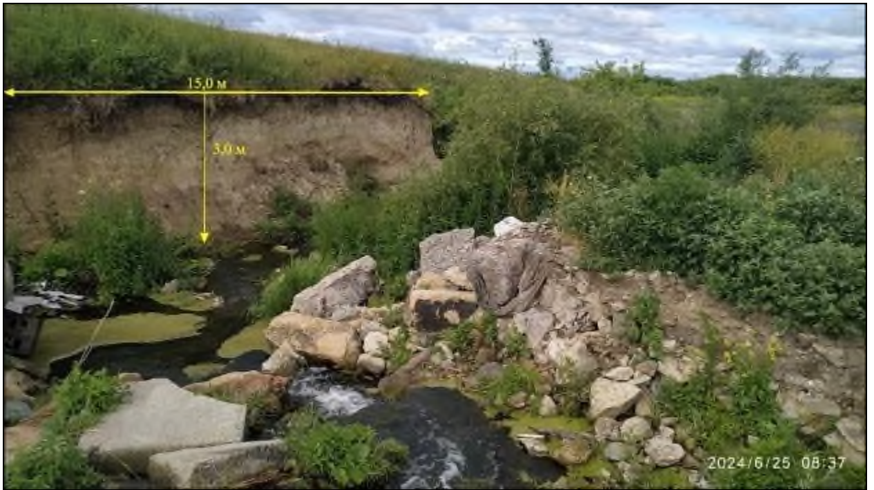
Фото 74-12-00239. Эрозионный врез по левому борту р. Солодянка, ниже дамбы в ТН 2, в с. Клястицкое. Участок Троицкий Челябинской области
