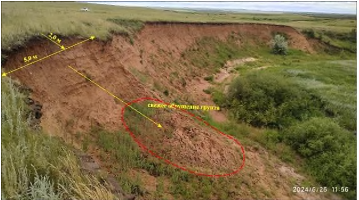
Фото 74-22-00176. Новое обрушение грунта с бровки эрозийного вреза по правому борту оврага большой Лог в ТН 9. Янгельский участок Челябинская область
