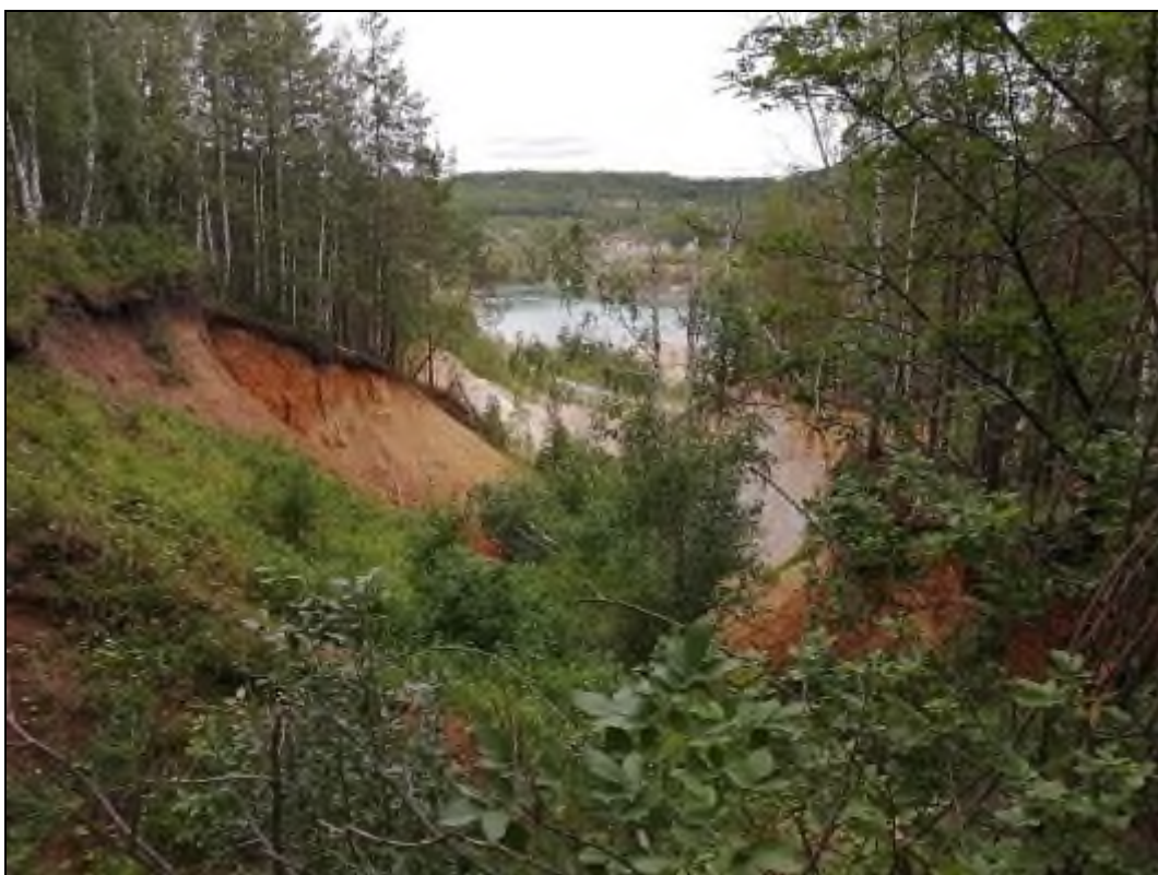
Фото 66-22-00421. Овражная эрозия по бортам карьеров. Липовский участок Свердловская область
