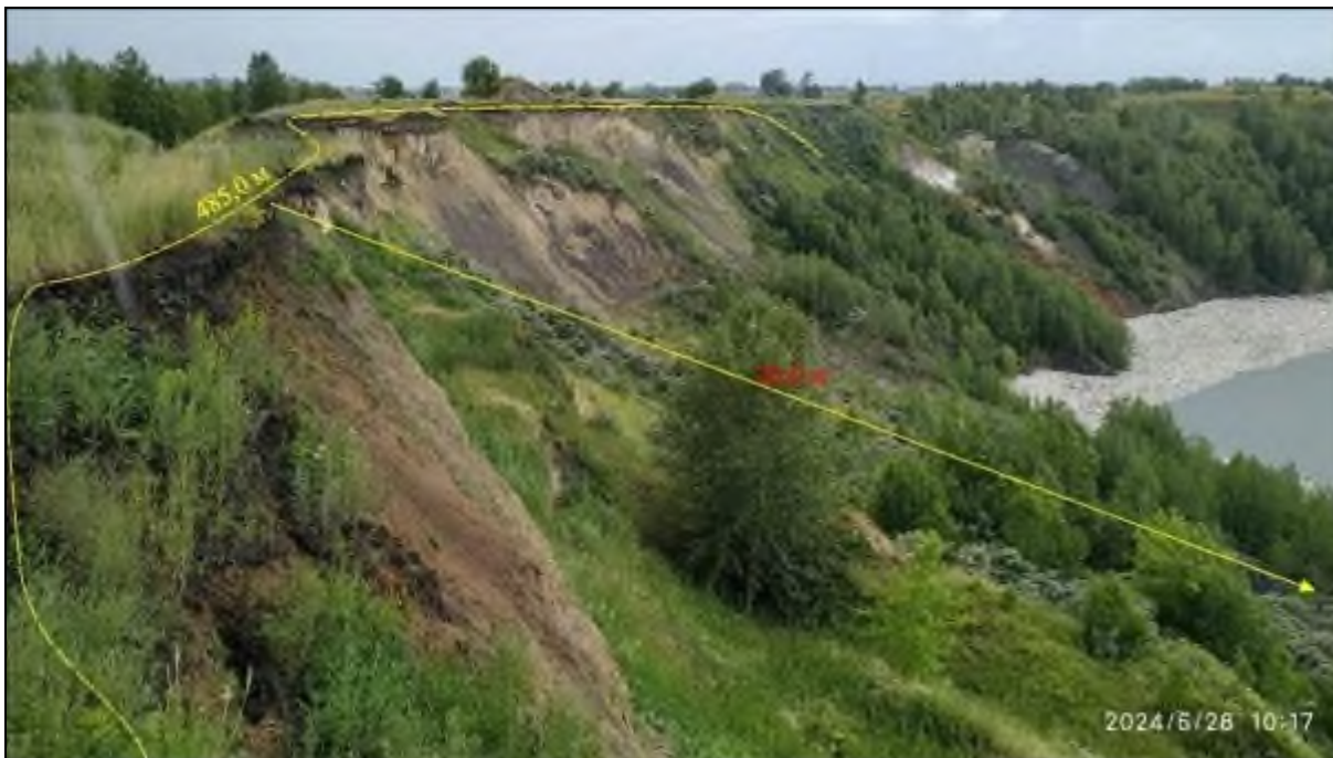
Фото 74-11-00061. Оползень на борту карьера № 2, в ТН 8. Еманжелинский участок Челябинская область
