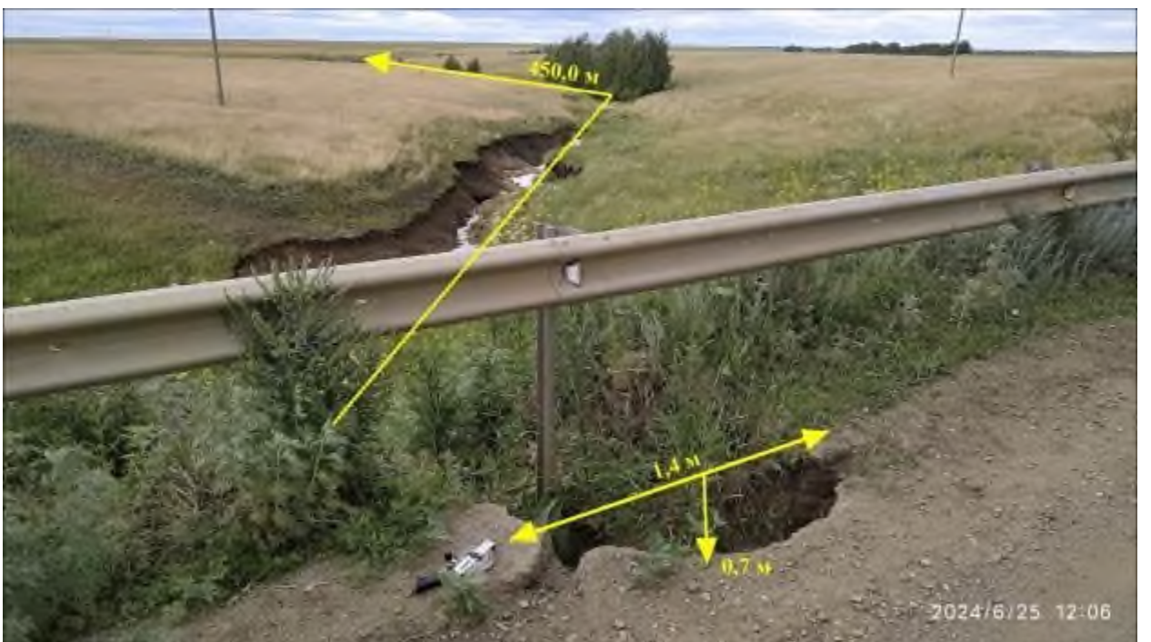
Фото 74-22-00261. Общий вид оврага и эрозийная промоина на обочине автодороги в ТН 24. Участок Троицкий Челябинской области
