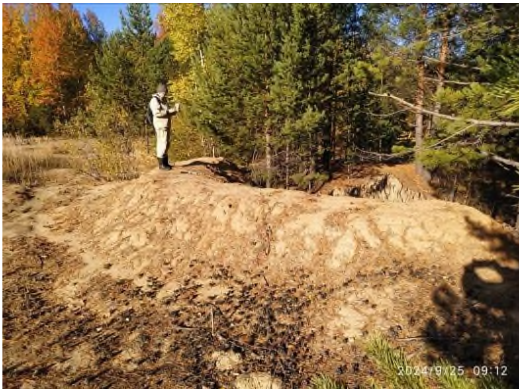
Фото 86-22-00122. Обваловка вершины оврага в ТН 2. Урайский участок ХМАО-Югра
