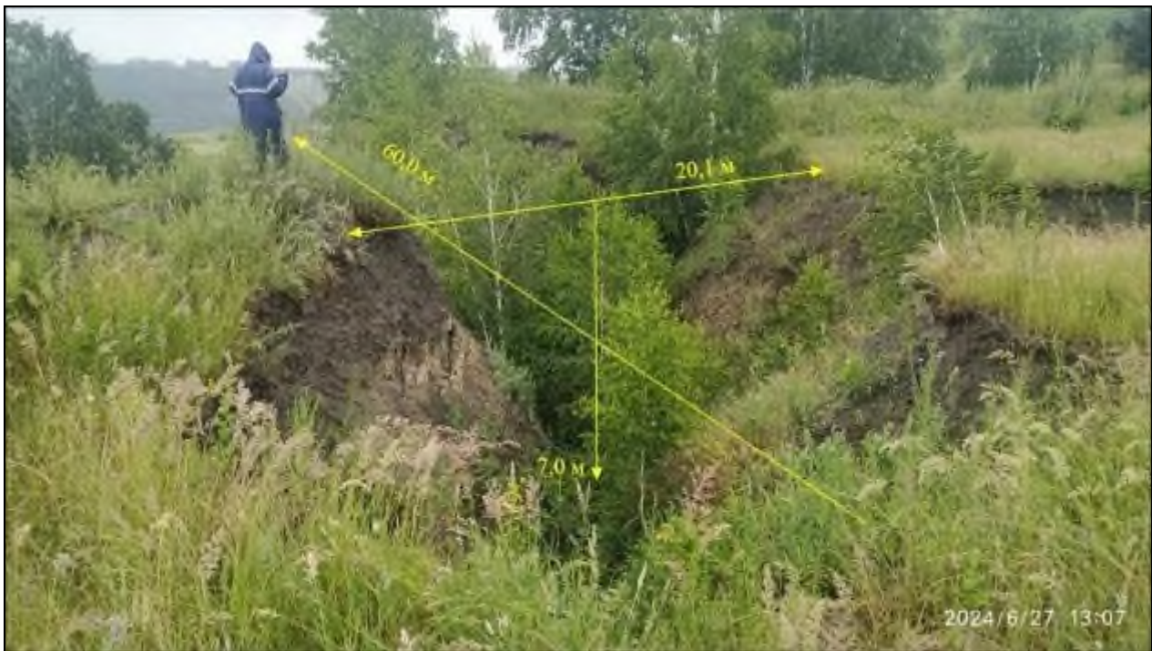
Фото 74-22-00175. Овражная эрозия в ТН 5. Красногорский участок Челябинская область
