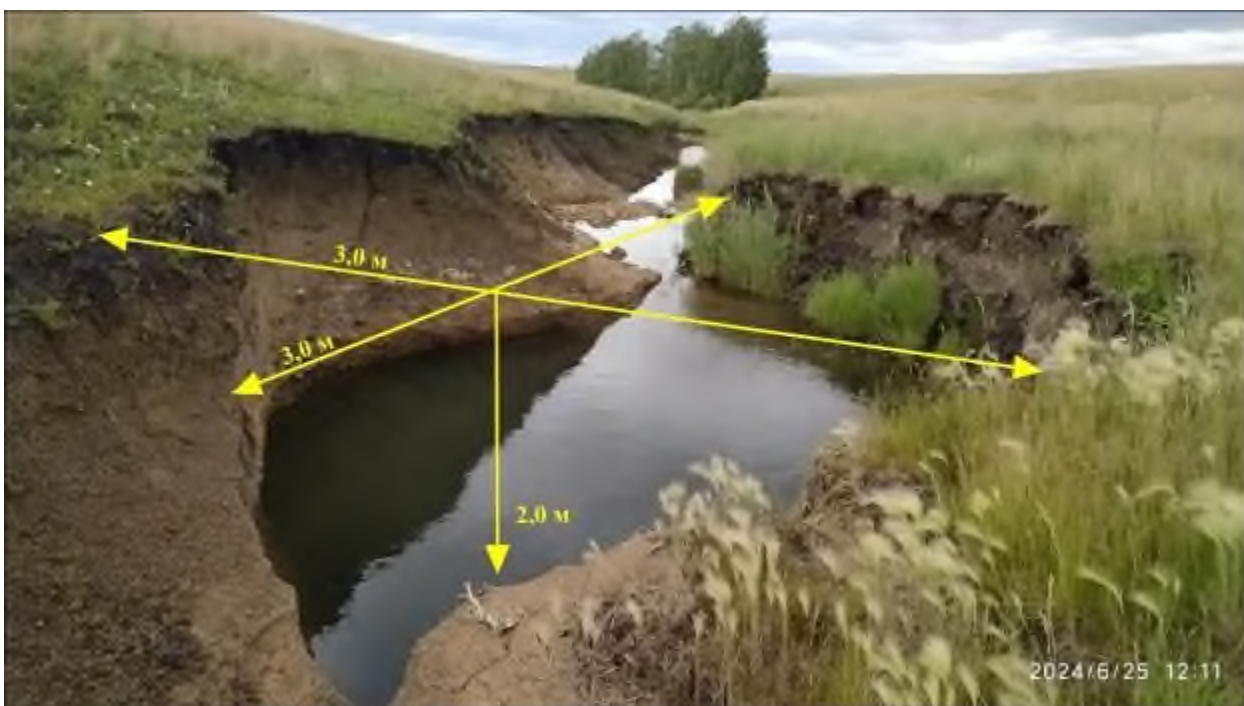
Фото 74-22-00261. Промоина в тальвеге оврага в ТН 24. Участок Троицкий Челябинской области
