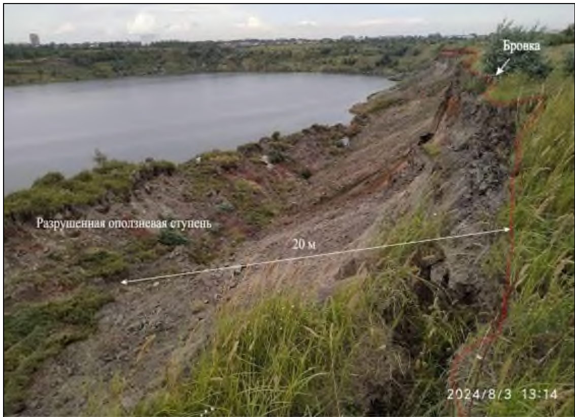
Фото 74-11-00067. Оползание борта Копейского разреза в ТН 12 с разрушенной оползневой ступенью. Копейский участок оперативного обследования, Челябинская область
