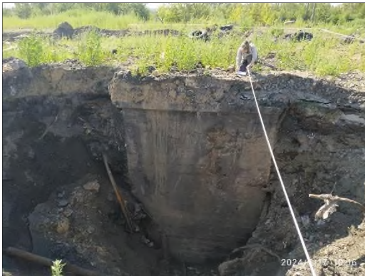
Фото 66-11-00556. Провал над шахтным полем рядом с территорией КМЗ в г. Артемовский, Свердловская область
