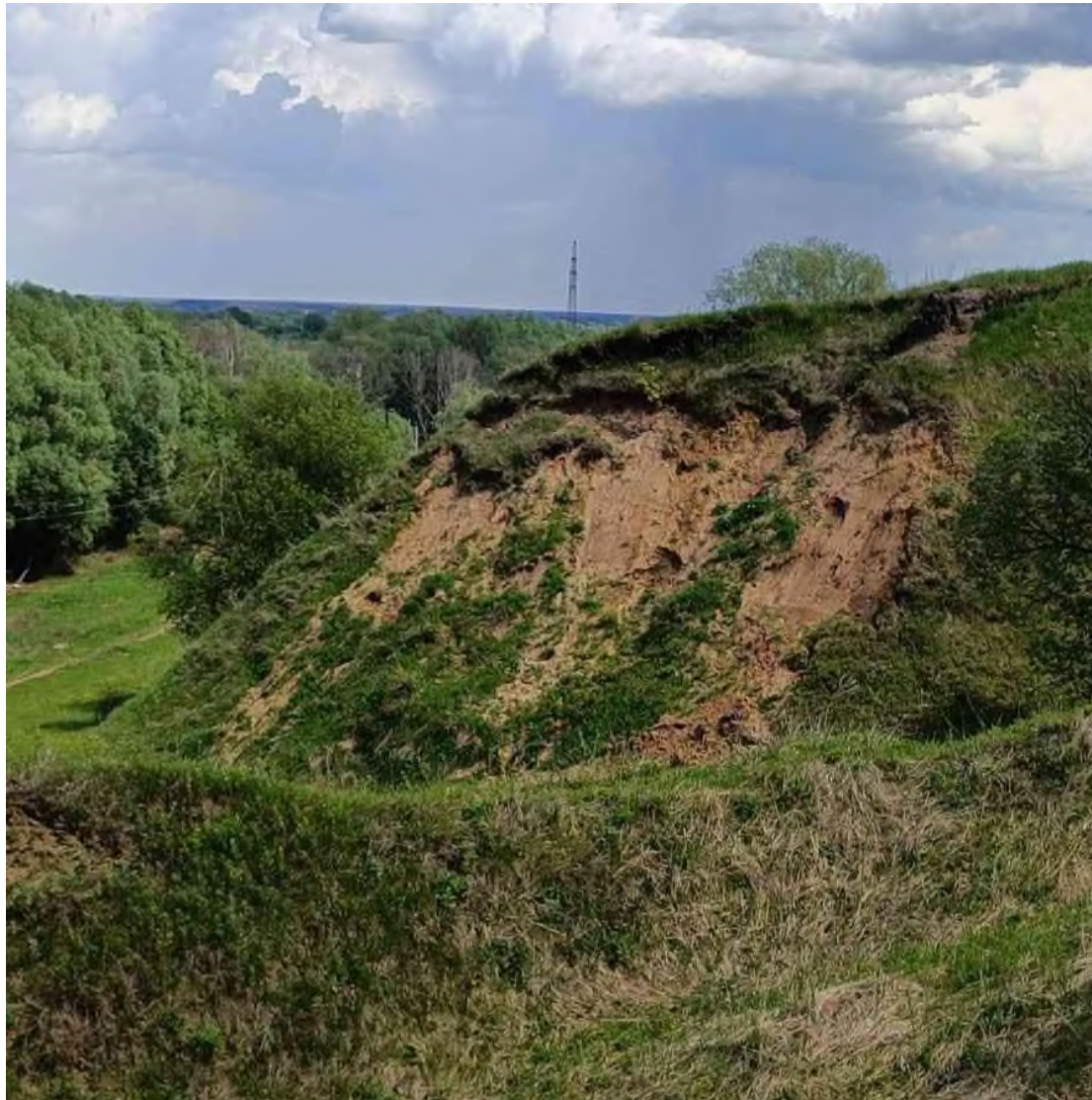
Фото 62-11-00585. Активный оползень в д. Дядьково, Рязанский район, Рязанская область
