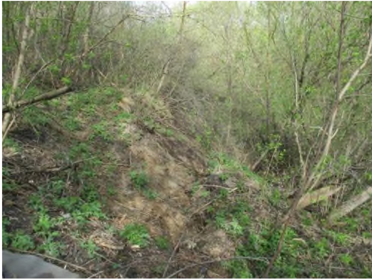
Фото 36-11-00533. Активный оползень р.п. Каменка, Каменский район, Воронежская область
