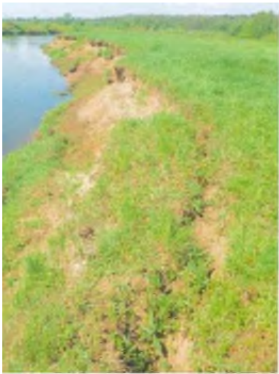
Фото 67-11-00158. Активный оползень 0,2 км на юго-восток от д. Бизюково, Дорогобужский район, Смоленская область
