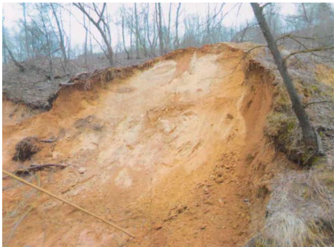
Фото 67-11-00147. Активный оползень по ул. Шевченко, г. Смоленск, Смоленская область
