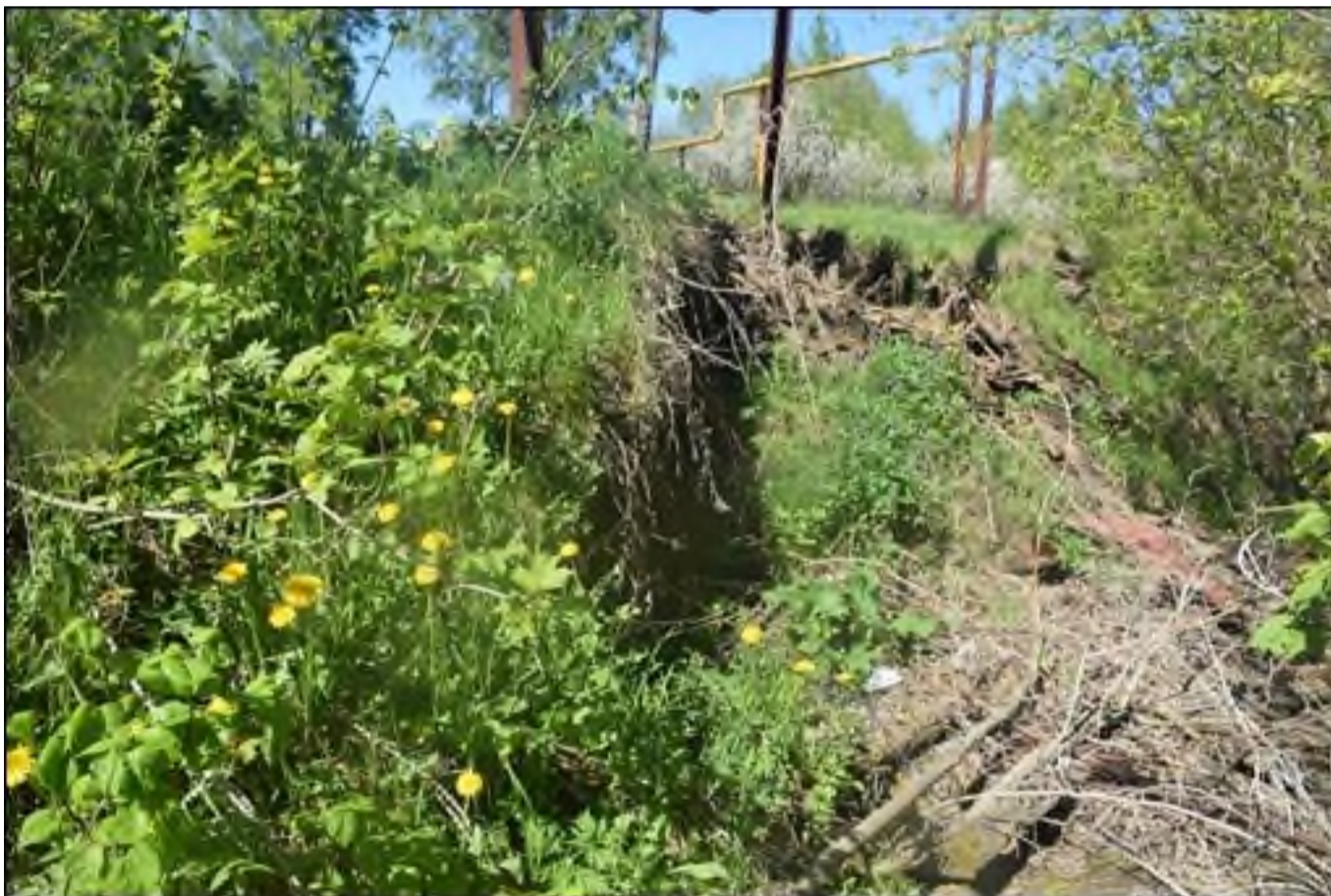
Фото 37.11.00023 Оползень в п. Новописцово Вичугского района вдоль ул. Нагорная, правобережный склон р. Сунжа, Ивановская область
