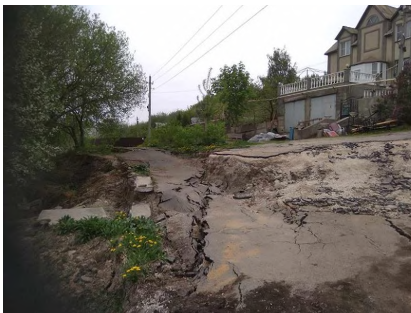
Рис. 1 Смещение оползневого блока пород в с. Сырское, ул. Речная д. 24, Липецкий район, Липецкая область
