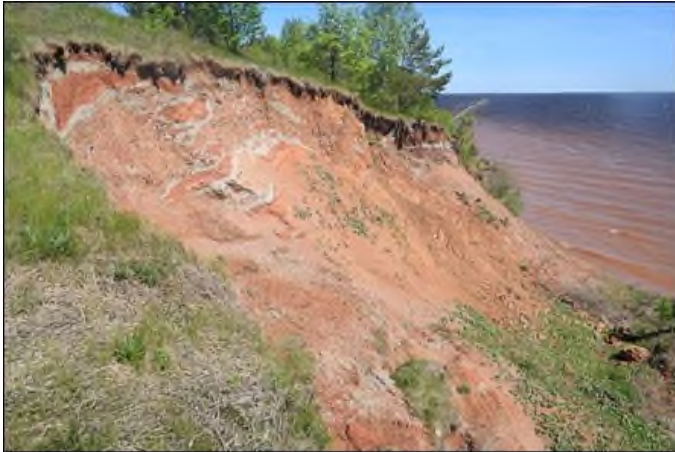
Фото 37.11.00094 Оползень расположенный северо-восточнее д. Красная Гора Пучежского района вдоль правобережного склона р. Волга (Горьковское вдхр.) Ивановская область
