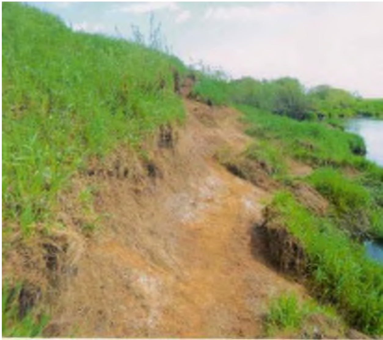
Фото 67-11-00153. Активный оползень 0,7 км на юго-восток от д. Бизюково, Дорогобужский район, Смоленская область
