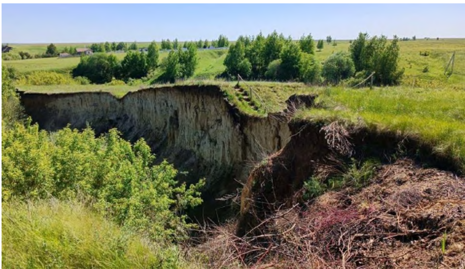
Фото 62-11-00587. Активный оползень в с. Троица, Спасский район, Рязанская область
