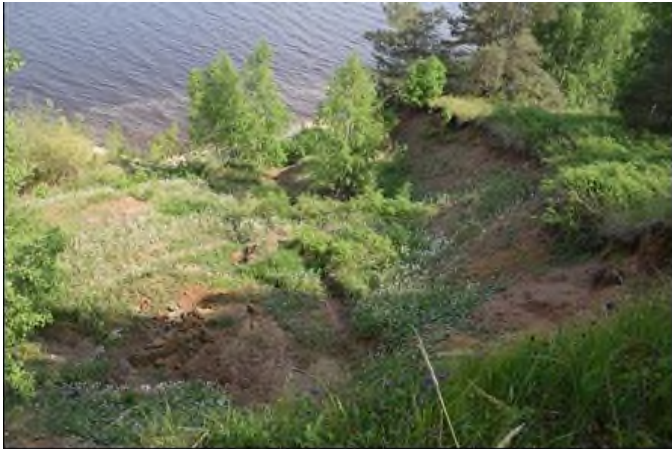
Фото 37.11.00020 Оползень расположенный северо-восточнее д. Красная Гора Пучежского района вдоль правобережного склона р. Волга (Горьковское вдхр.) Ивановская область
