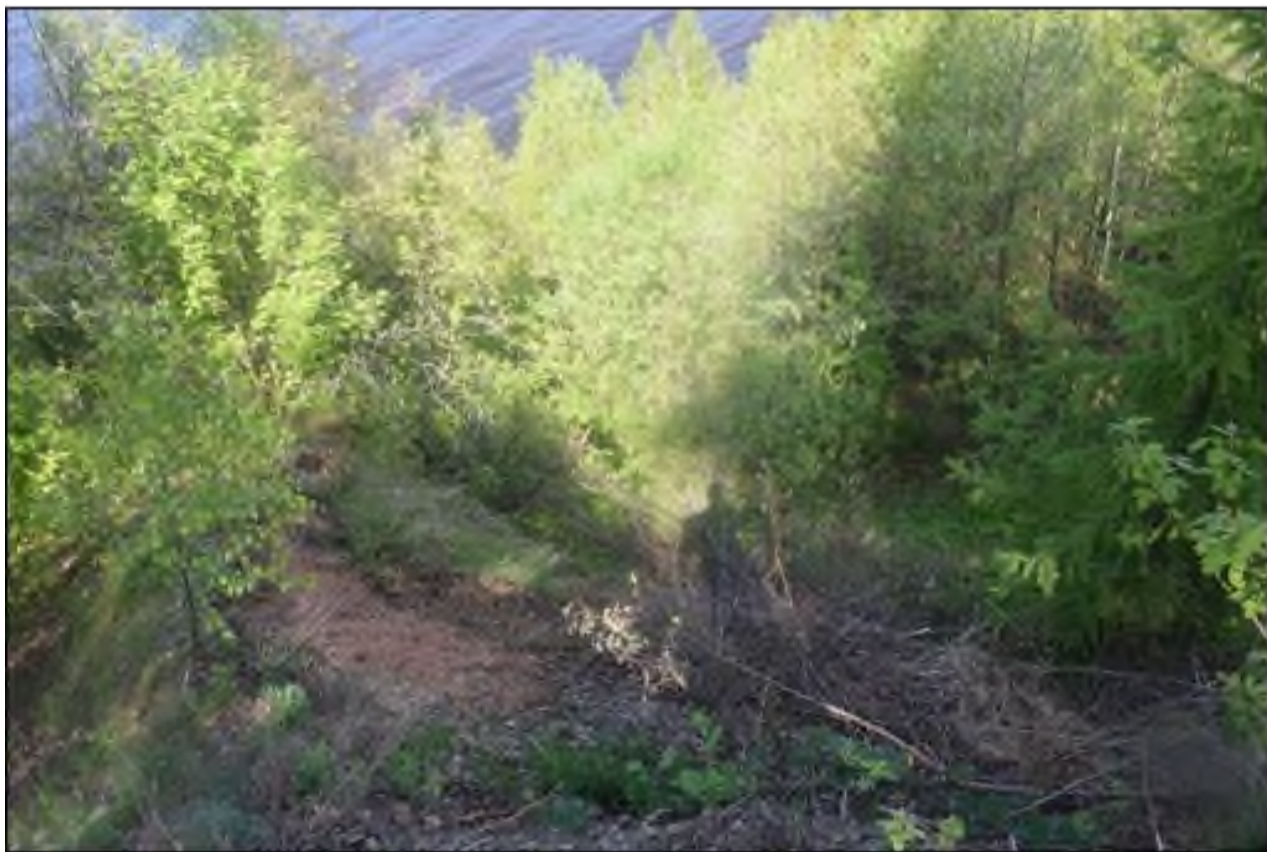
Фото 37.11.00002 Оползень на северная окраина г. Пучеж Пучежского района, (у памятника К.А. Журину на ул. Фрунзе), вдоль правобережного склона р. Волга (Горьковское вдхр.) Ивановская область
