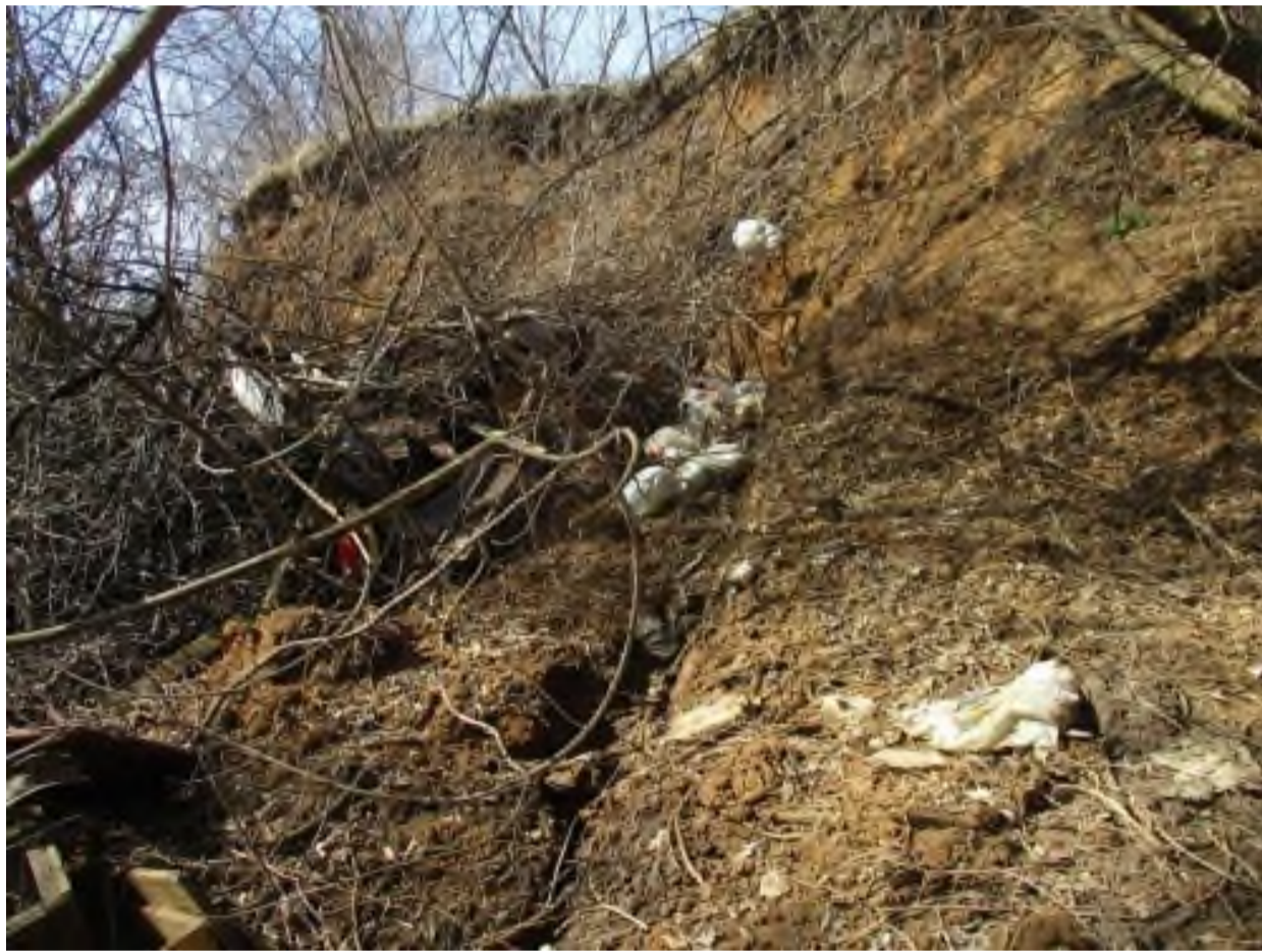
Фото 36-11-00530. Активный оползень в г. Семилуки, Семилукский район, Воронежская область
