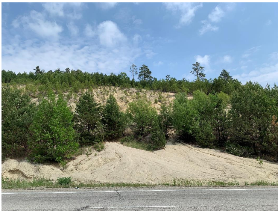
Фото 28-12-0001.Осыпные проявления и эрозионные промоины, 104 км автодорога Свободный-Благовещенск, Благовещенский район 06.06.2024г.
