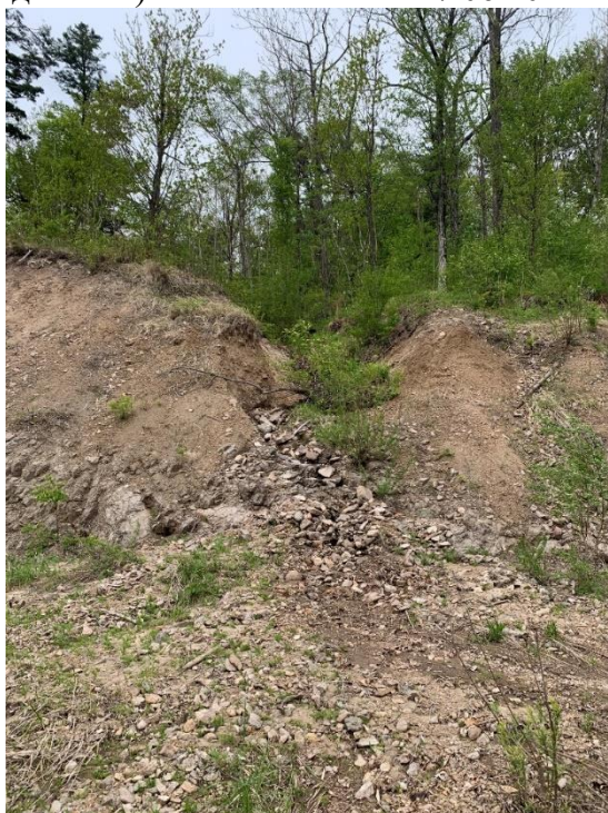
27-22-0004 Проявление овражной эрозии на участке 146км автодороги А-370, Вяземский район Хабаровского края 06.05.2024г.
