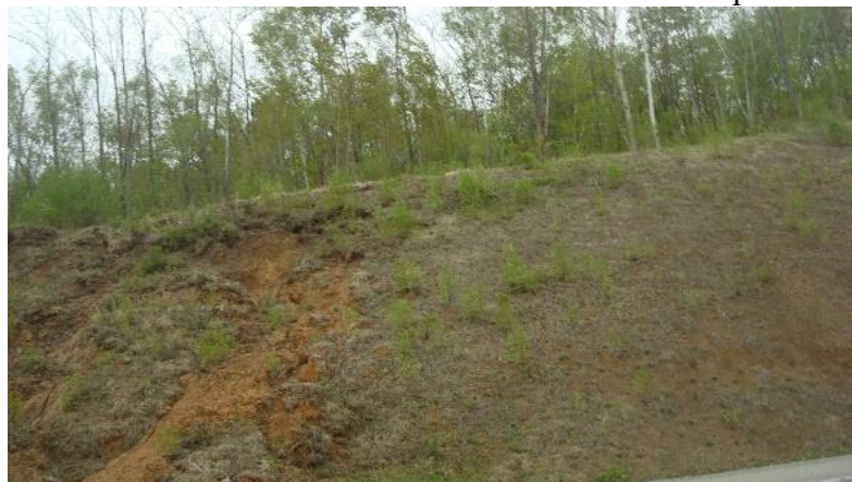
27-23-0002 Оползание откоса на 216 км А 370 в Бикинской районе 06.05.2024г.
