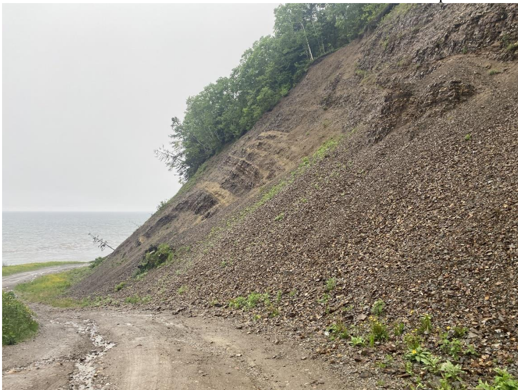
65-12-00002 Обвальнo-осыпной склон с обломочным материалом.
