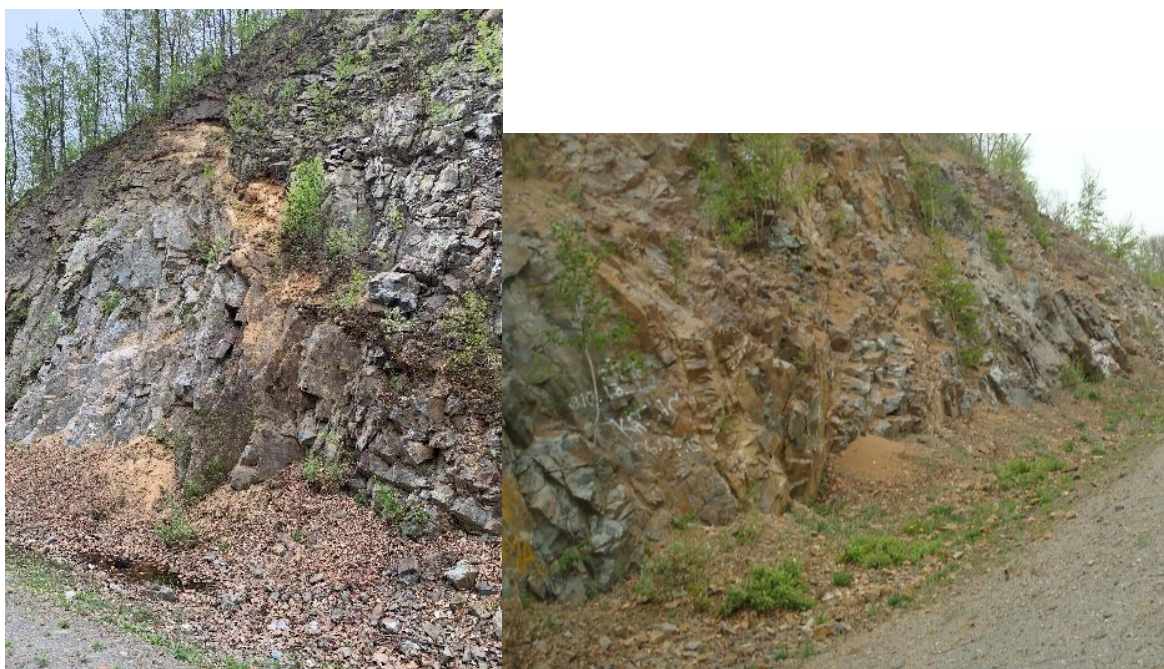
27-27-008 Проявления осыпного процесса на 220 км А 370 в Бикинской районе 06.05.2024г.
