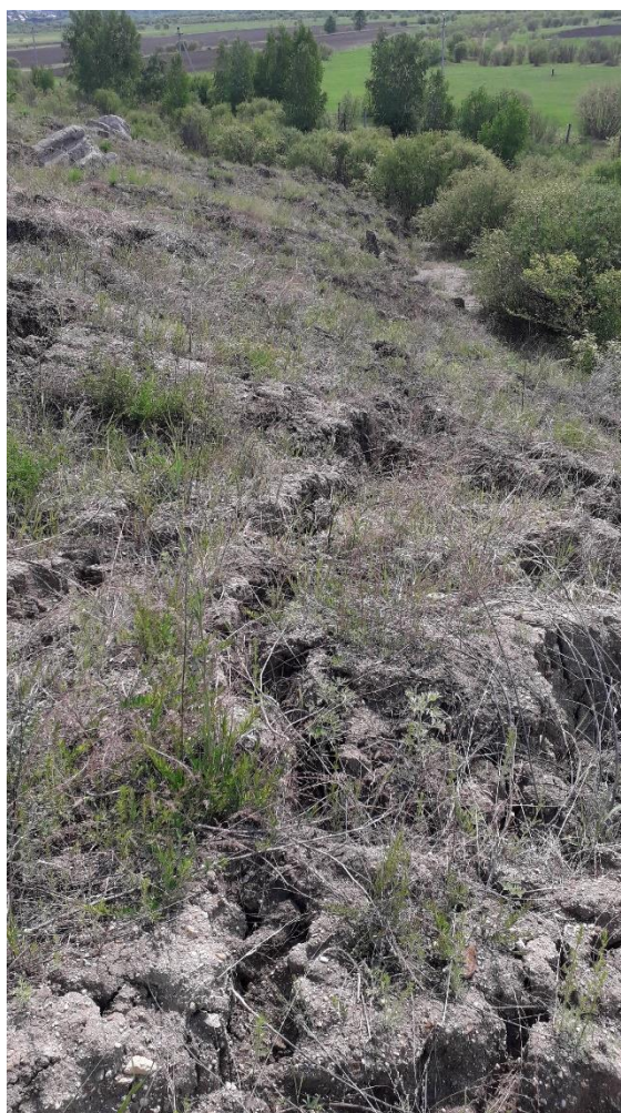
Фото 75-11-00002. Фронтальная часть оползня, перекрывшая временную обводную дорогу, с. Засопка, Читинский район, Забайкальский края, 14.06.2024 г.
