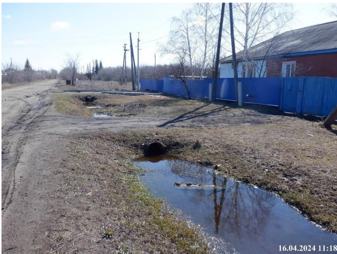
Фото 55-13-00006. Водоотводный канал по ул. Советская, 94, пгт. Павлоградка, Павлоградский район, Омская область, 16.04.2024
