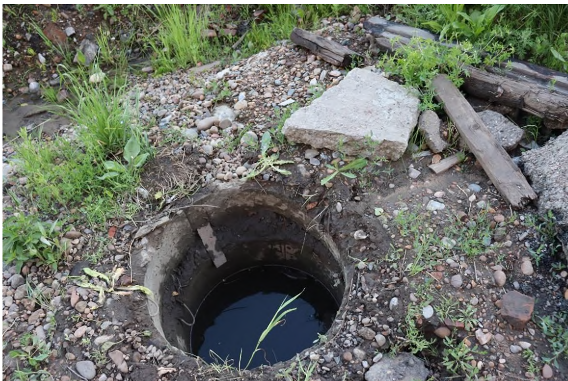
Фото 38-13-00014. Положение уровня грунтовых вод в смотровом колодце 0,5 м от поверхности на пересечении ул. Почтамтской и пер. Сюткина, мкр. Иркутск-2, г. Иркутск, Иркутская область, 21.06.2024
