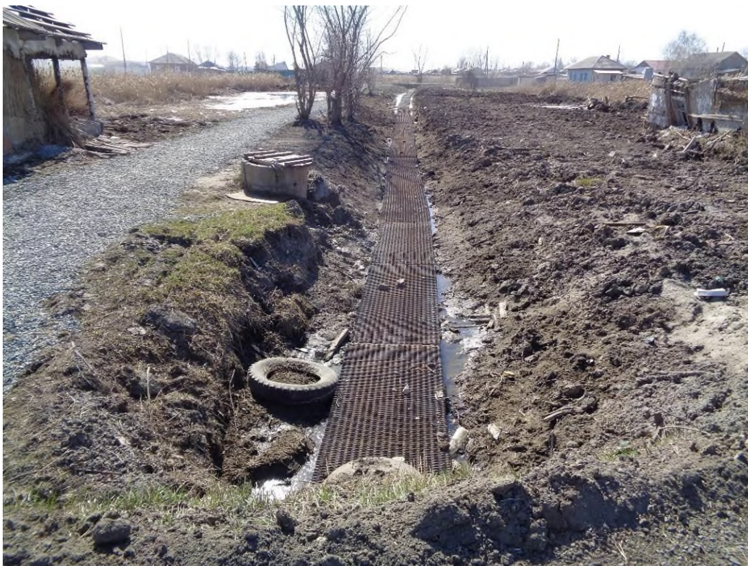
Фото 54-13-00012.а. Осушительный канал по ул. Рабочая. Поверхностная и грунтовая вода находится на одной отметке - ниже дневной поверхности около 0,5 м. пгт. Чистоозёрное, Чистоозёрный район, Новосибирская область, 26.04.2024
