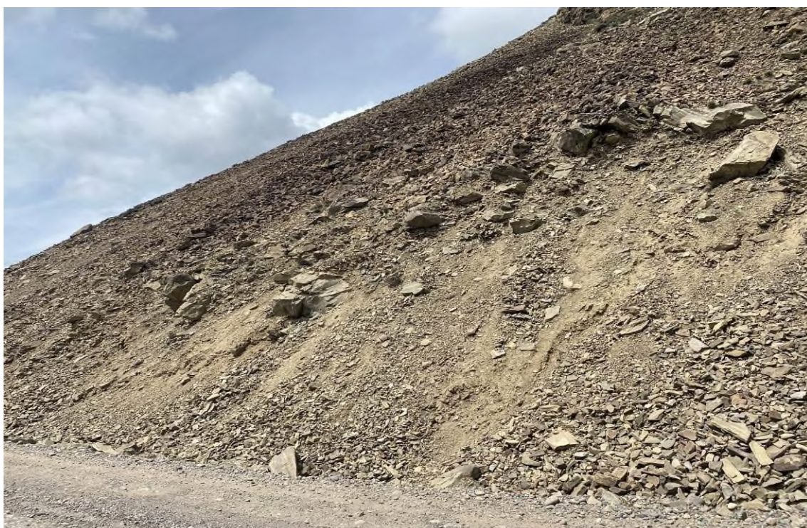
Фото 17-12-00002. Осыпной склон с подвижной осыпью, уч. а/дороги Кызыл – Баян-Кол, 24 км, Кызылский район, Республика Тыва, 05.06.2024
