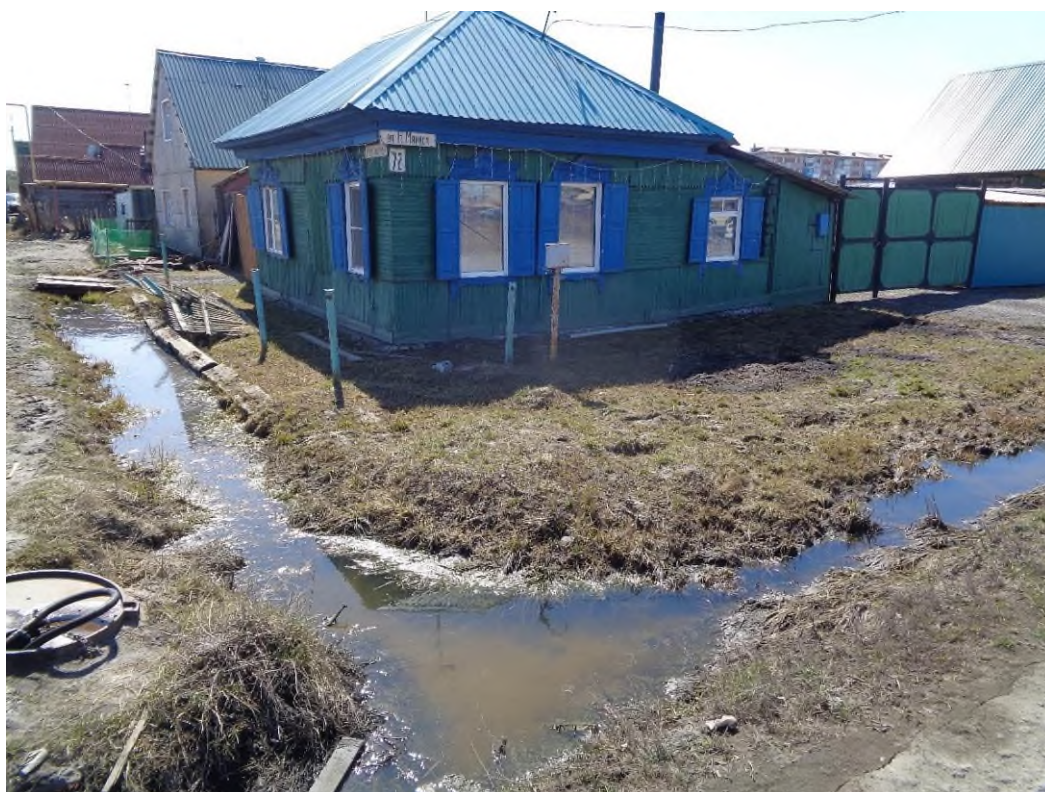
Фото 54-13-00001.а. По ул. Карла Маркса уровни воды в придорожных канавах находятся на тех же отметках, что и уровни грунтовых вод (порядка 0,5 м от дневной поверхности). г. Барабинск, Барабинский район, Новосибирская область, 27.04.2024
