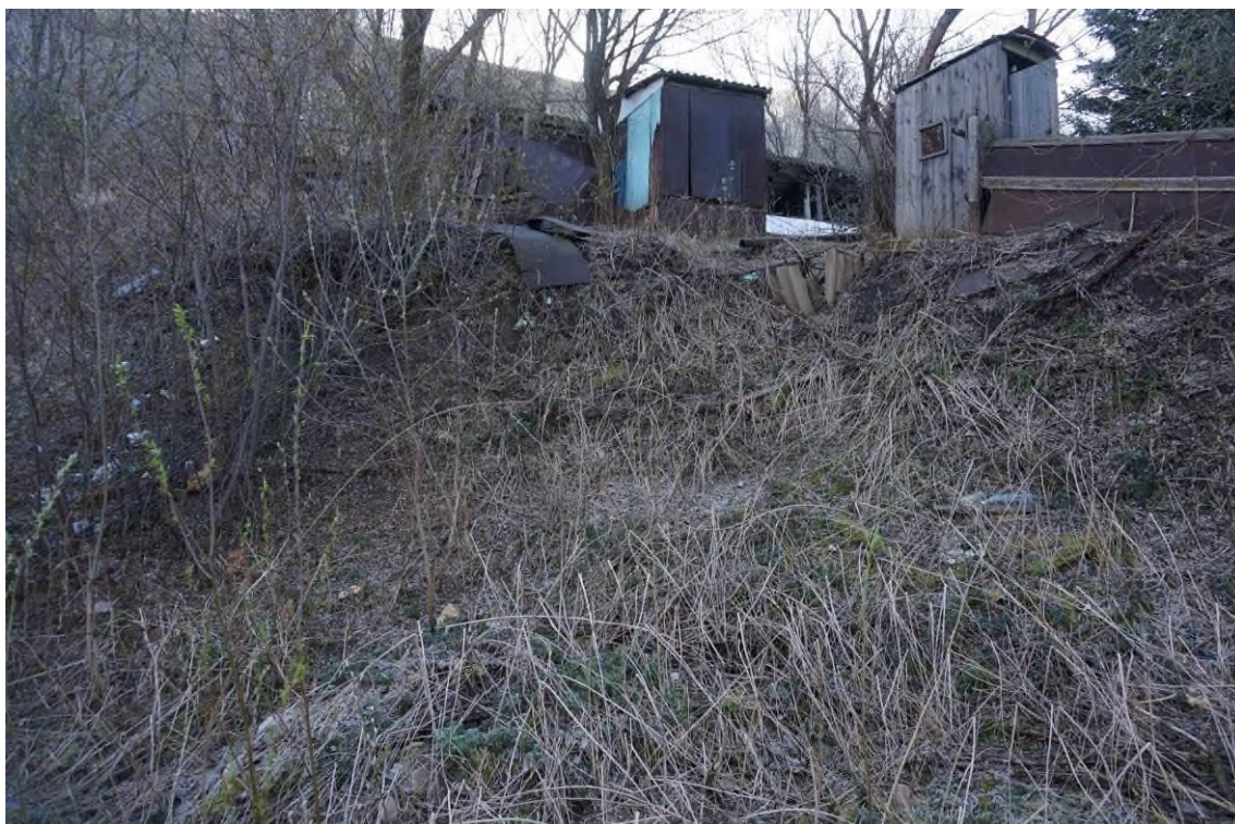
Фото 04-11-00006. Левый фланг оползня, стенка отрыва. Разрушенные ограждения усадьбы по ул. Советская, 2, с. Кызыл-Озек, Майминский район, Республика Алтай, 24.04.2024
