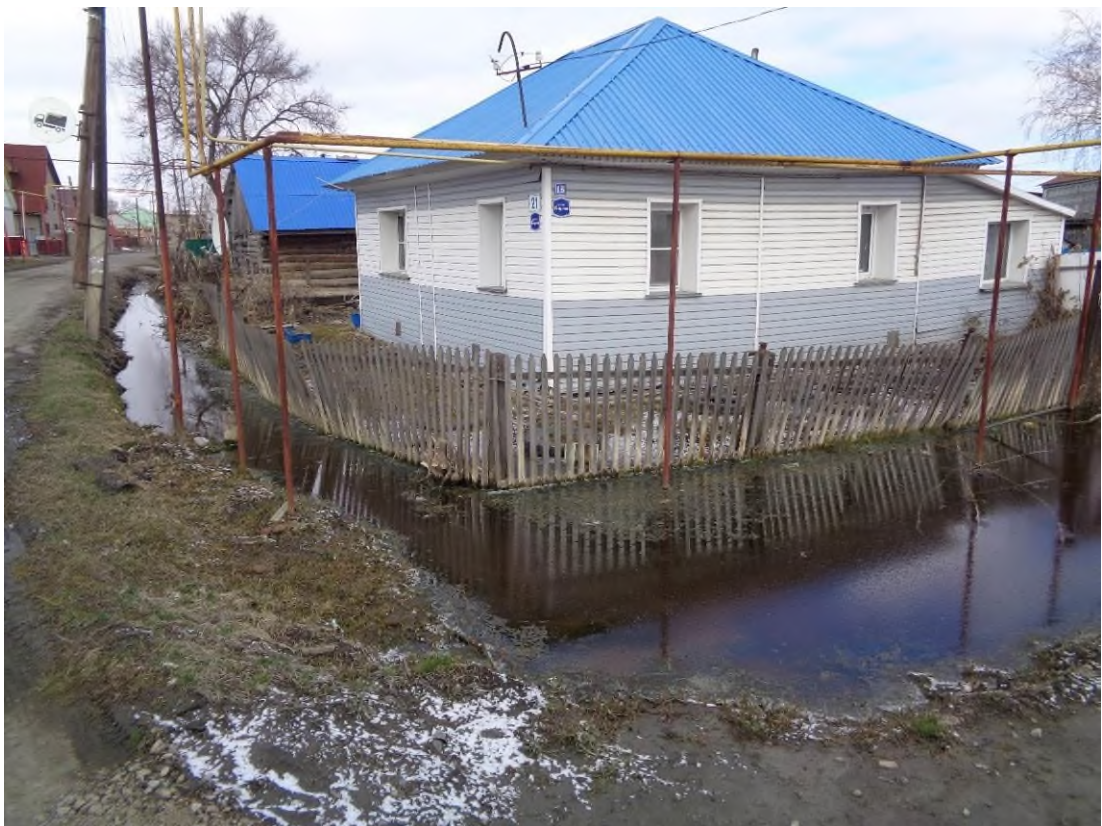
Фото 54-13-00008.б. По ул. Кирова уровни воды в придорожных канавах находятся на тех же отметках, что и уровни грунтовых вод (около 0,5 м от дневной поверхности). г. Чулым, Чулымский район, Новосибирская область, 24.04.2024
