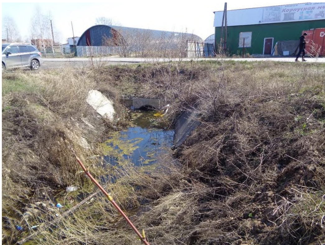
Фото 54-13-00003. Магистральный канал по ул. Октябрьская зарастает болотной растительностью, стенки оплывают, дно заиливается, вода цветёт. Поверхностная и грунтовая вода находится на одной отметке - ниже дневной поверхности на 0,8-1 м. с. Баган, Баганский район, Новосибирская область, 26.04.2024
