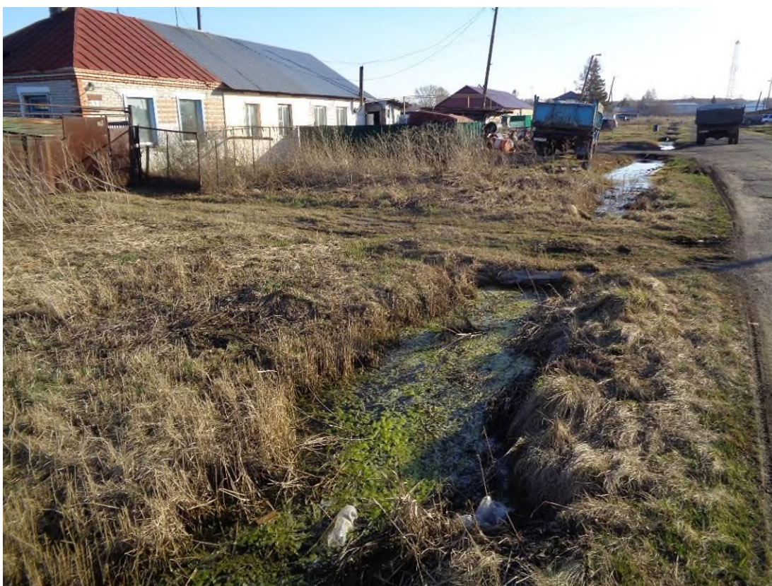
Фото 54-13-00010. По ул. Фабричная уровни воды в придорожных канавах находятся на тех же отметках, что и уровни грунтовых вод (около 0,5 м от дневной поверхности). пгт. Коченёво, Коченёвский район, Новосибирская область, 27.04.2024
