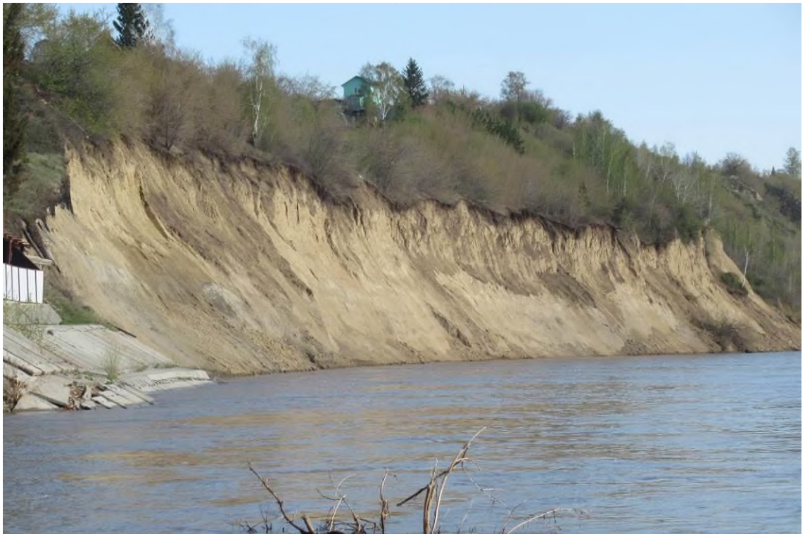
Фото 22-11-00043. Эрозионный оползень на левом береговом склоне долины р. Обь напротив СНТ «Энергетик» в г. Барнаул, Алтайский край, 07.05.2024
