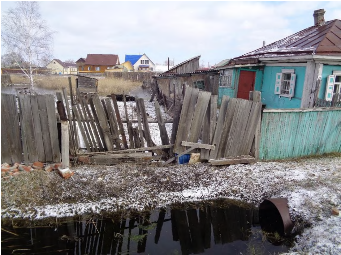
Фото 54-13-00008.а. По ул. Матросова активизация подтопления грунтовыми водами ведёт к неравномерным осадкам частных строений, их деформациям. г. Чулым, Чулымский район, Новосибирская область, 24.04.2024
