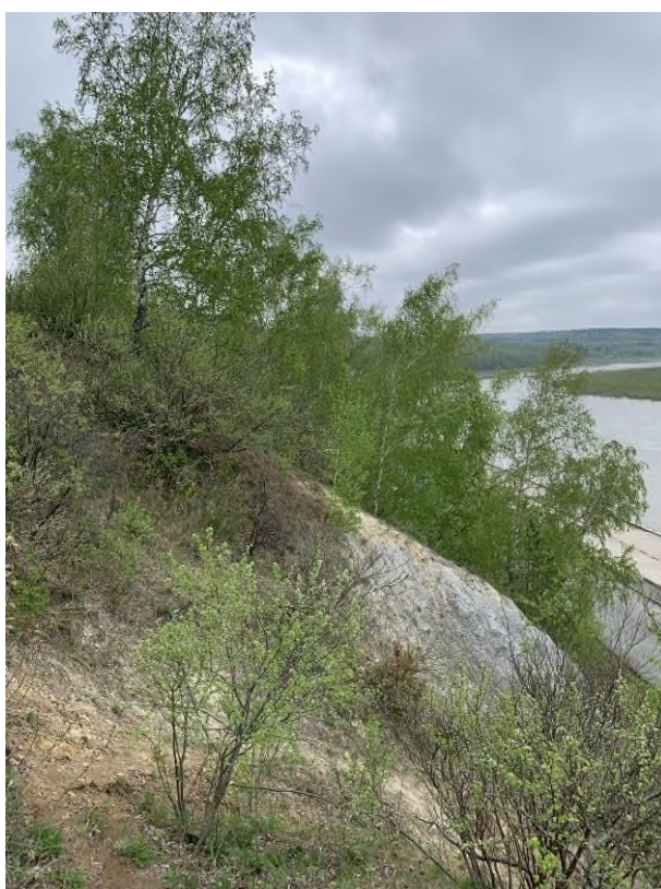
Фото 70-11-00014. Оползень №15а в г. Томске, Лагерный сад, Томская область, 23.05.2024
