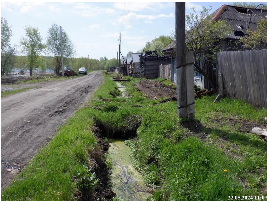
Фото 55-13-00013. Водоотводный канал по ул. Матросова, г. Тара, Тарский район, Омская область, 22.05.2024
