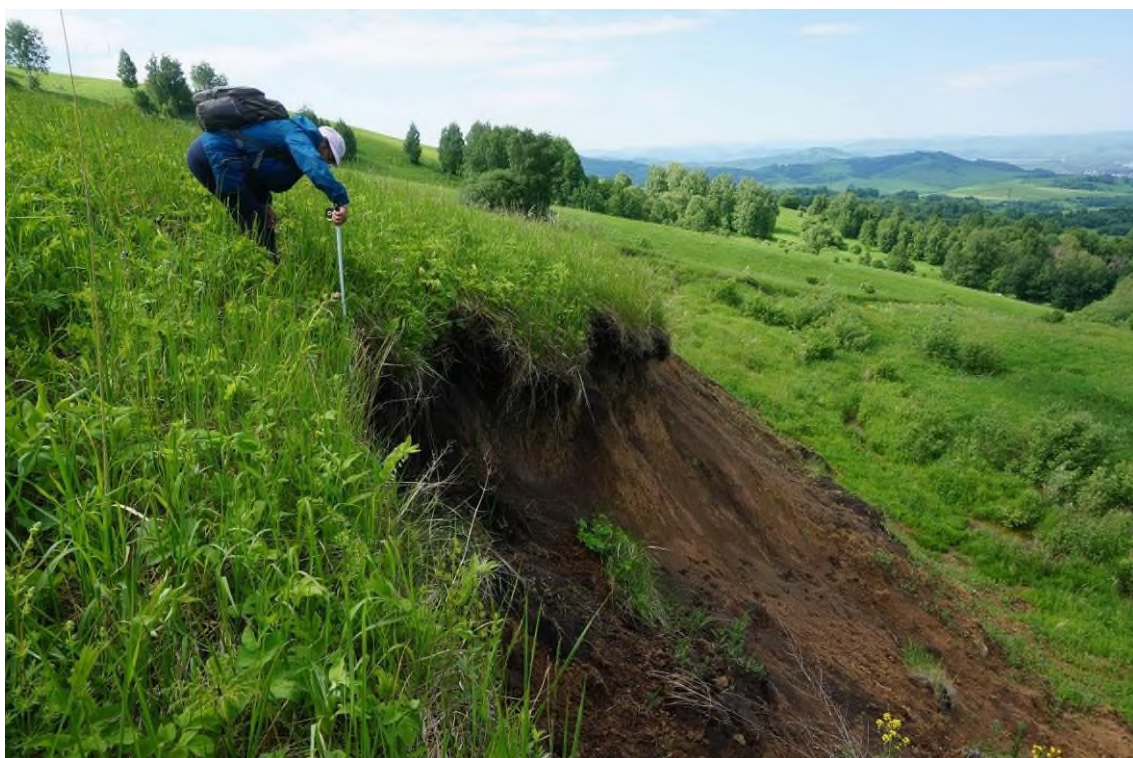
Фото 04-11-00007. Надоползневый уступ оползня со свежими оплывинами в стенке отрыва, окрестности с. Майма, Майминский район, Республика Алтай, 06.06.2024
