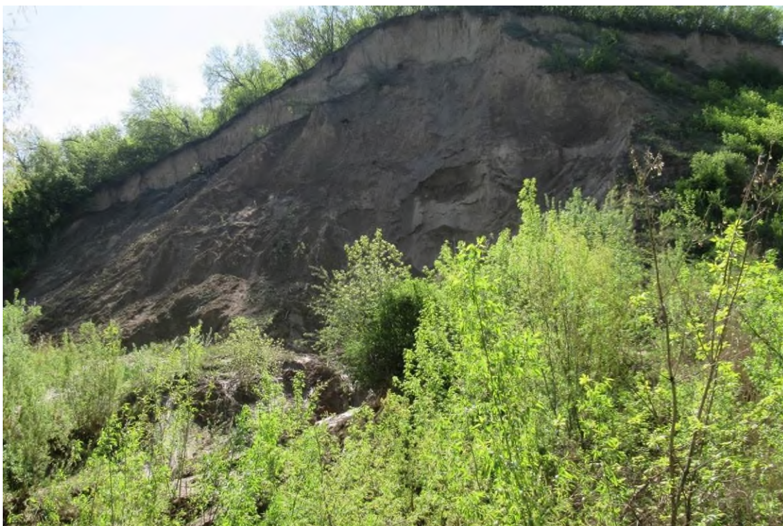
Фото 22-11-00020. Полигенный оползень на левом береговом склоне долины р. Обь на участке ул. Квартал 953а, 380, в г. Барнаул, Алтайский край, 16.05.2024
