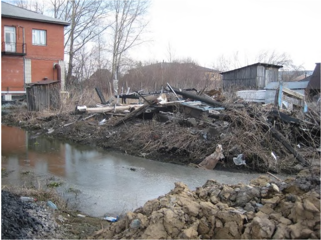
Фото 54-13-00006.а. Уровни грунтовых вод по ул. Народная, 50-54 находятся на глубине менее 0,5 м. пгт. Мошково, Мошковский район, Новосибирская область, 26.04.2024
