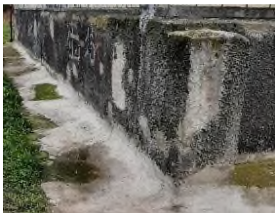
Фото 27. Подтопление подвального помещения д. 25/8 по ул. Ленина, 04.04.2024 г.
