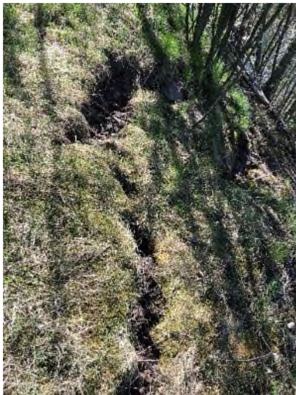
Фото 69. Крупная трещина отрыва на склоне правого берега через р. Вуокса на участке «Лосевский порог» Ромашкинского СП, Приозерского района, Ленинградской области, 17.05.2024 г
