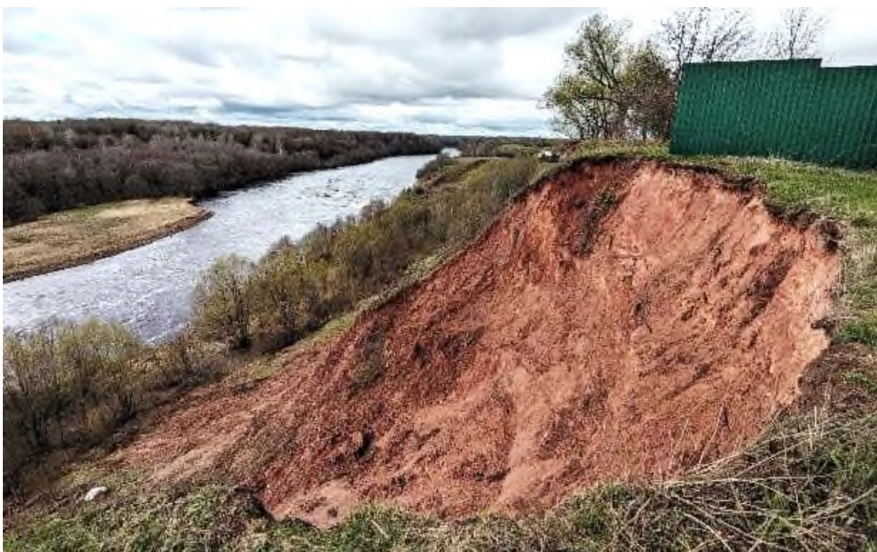
Фото 76. Оползневой цирк вблизи забора с длинным переувлажнённым языком оползня в д. Путилино, 17.04.24 г.
