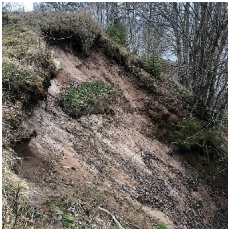
Фото 17. Свежие оползневые массы на берегу сезонного ручья, впадающего в Онежское озеро, п. Каскесручей (ТН 2), 15.05.24 г.
