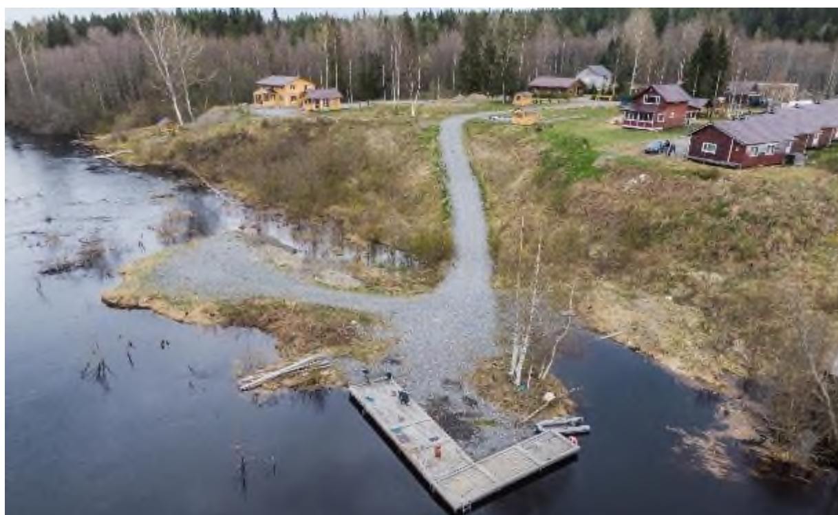
Фото 1, 2. Общий вид оползневого склона в п. Хийденсельга
