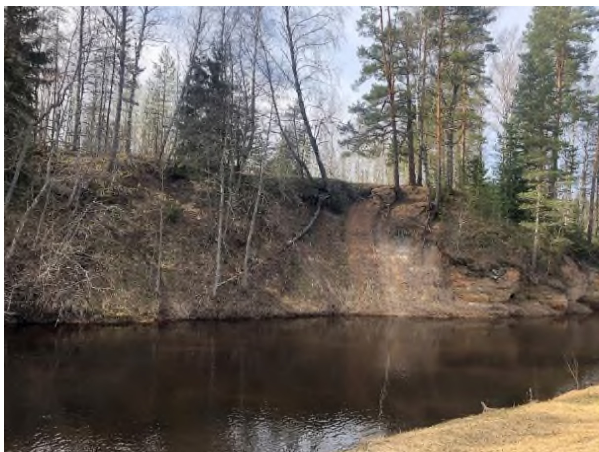
Фото 59. Активизации оползневого процесса на склоне левого берега р. Ящера вверх по течению от моста вблизи д. Долговка Лужского района, Ленинградской области
