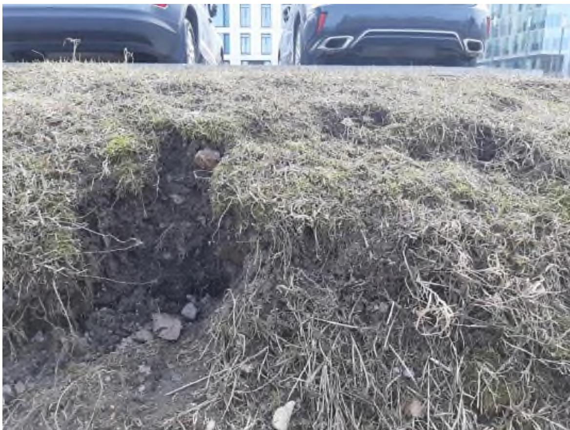
Фото 129. Воздействие суффозионного процесса на зону парковки вблизи бровки склона вдоль набережной Адмирала Лазарева у д. 24 Петроградского района г. Санкт-Петербурга
