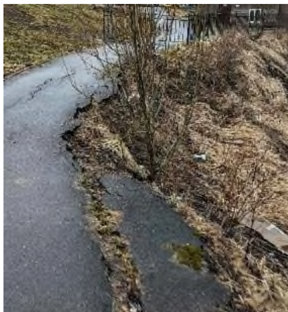
Фото 133. Разрушение асфальтированной пешеходной дорожки в пределах проявления со стороны входа на прогулочную придомовую дорожку вблизи д. 7 по 6-й Жерновской ул. Красногвардейского района г. Санкт-Петербурга
