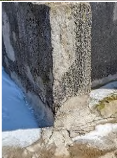
Фото 28. Цементация трещин (а) и маячки (б) просадки грунта по периметру д. 25/8 по ул. Ленина, по состоянию на 19.10.2023 г., (в) и (г) – то же, по состоянию на 04.04.2024 г.
