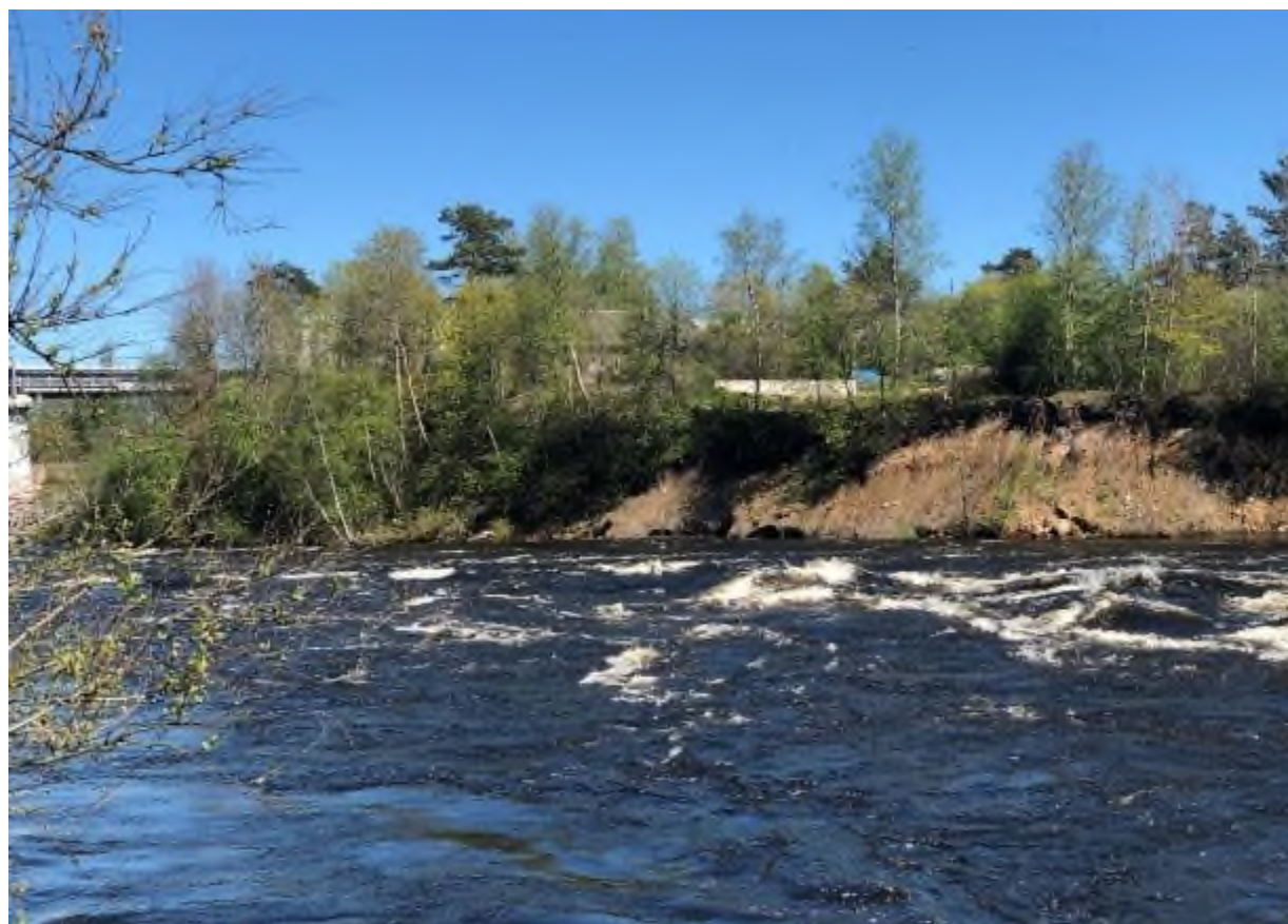
Фото 67. Общий вид на проявление оползневого процесса правого берега у моста «Лосевский порог» через р. Вуокса между д.д. Лосево и Варишко, Ромашкинского СП, Приозерского района, Ленинградской области, 17.05.2024 г.
