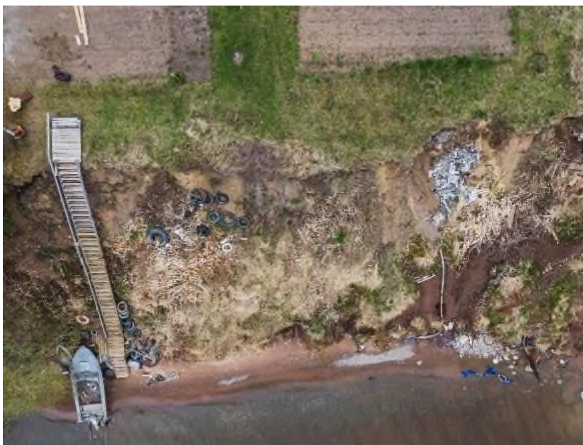
Фото 23, 24. Подпор нижней части оползневого склона и водоотвод, предпринятые местными жителями, п. Каскесручей, ТН 2 по состоянию на 2023 г. (верхнее) и по состоянию на 15.05.24 г.
