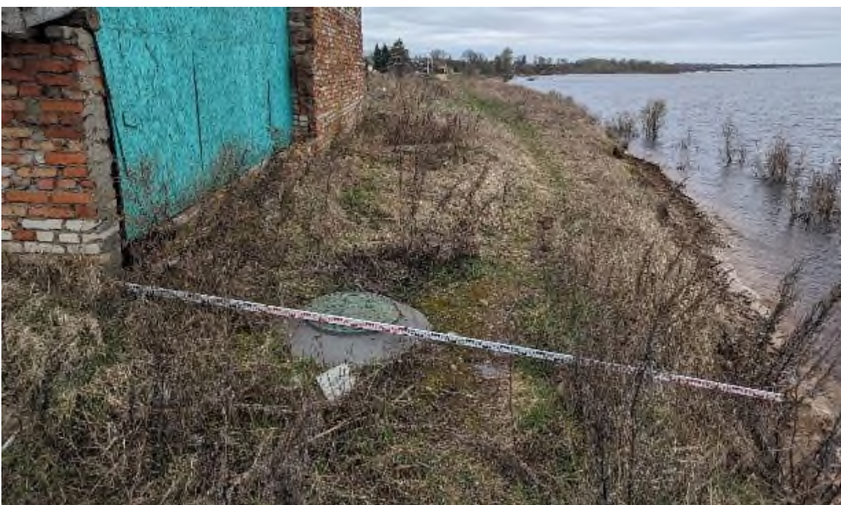
Фото 82. Часть территории Рыбзавода у верхней бровки склона вдоль ул. Набережная в д. Устрека (ТН 2).
