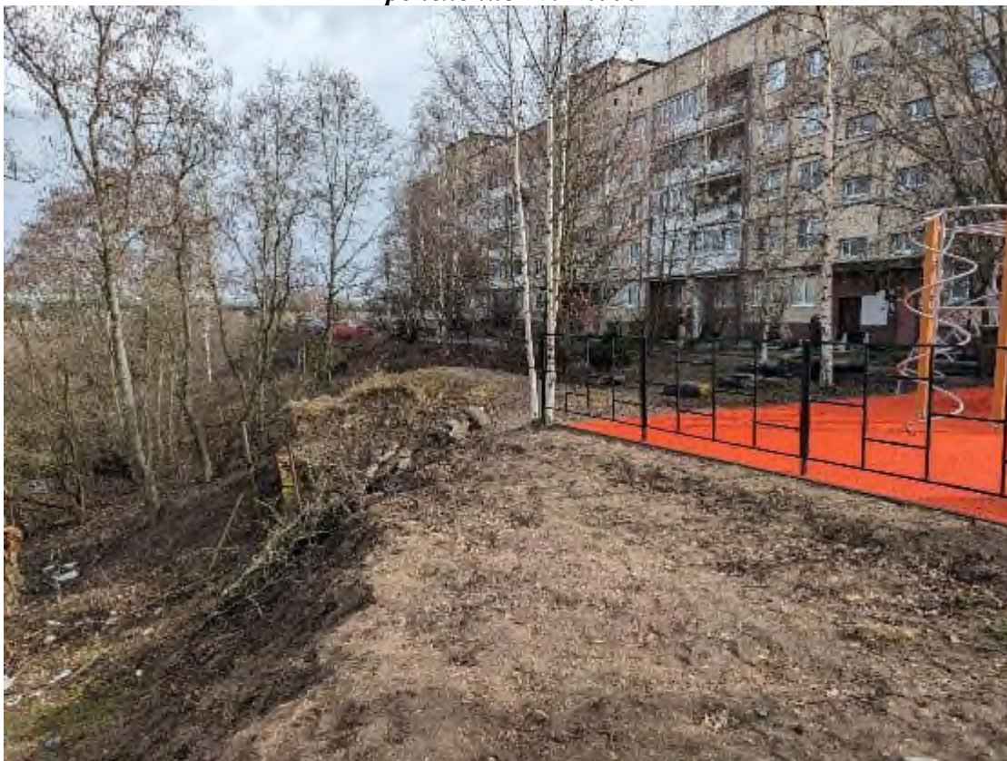
Фото 37. Вид на оползневой склон перед д. № 6 и расположение бровки отрыва проявления вблизи новой детской площадки в пгт. Войсковоро Тосненского района Ленинградской области
