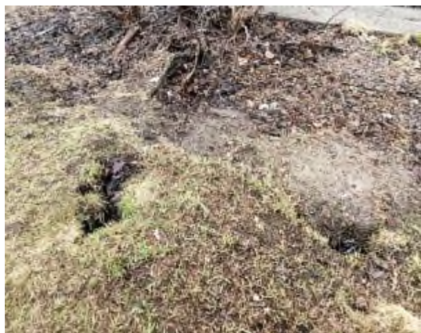
Фото 125. Формирование суффозионных пустот с поверхности (А) и в верхней части склона (Б) в пределах развития проявления на набережной Адмирала Лазарева Петроградского района г. Санкт-Петербурга
