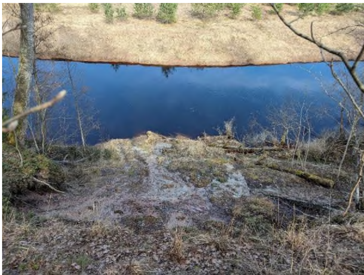
Фото 58. Активизация оползневого процесса на левом берегу р. Ящера вверх по течению от моста вблизи д. Долговка Лужского района, Ленинградской области
