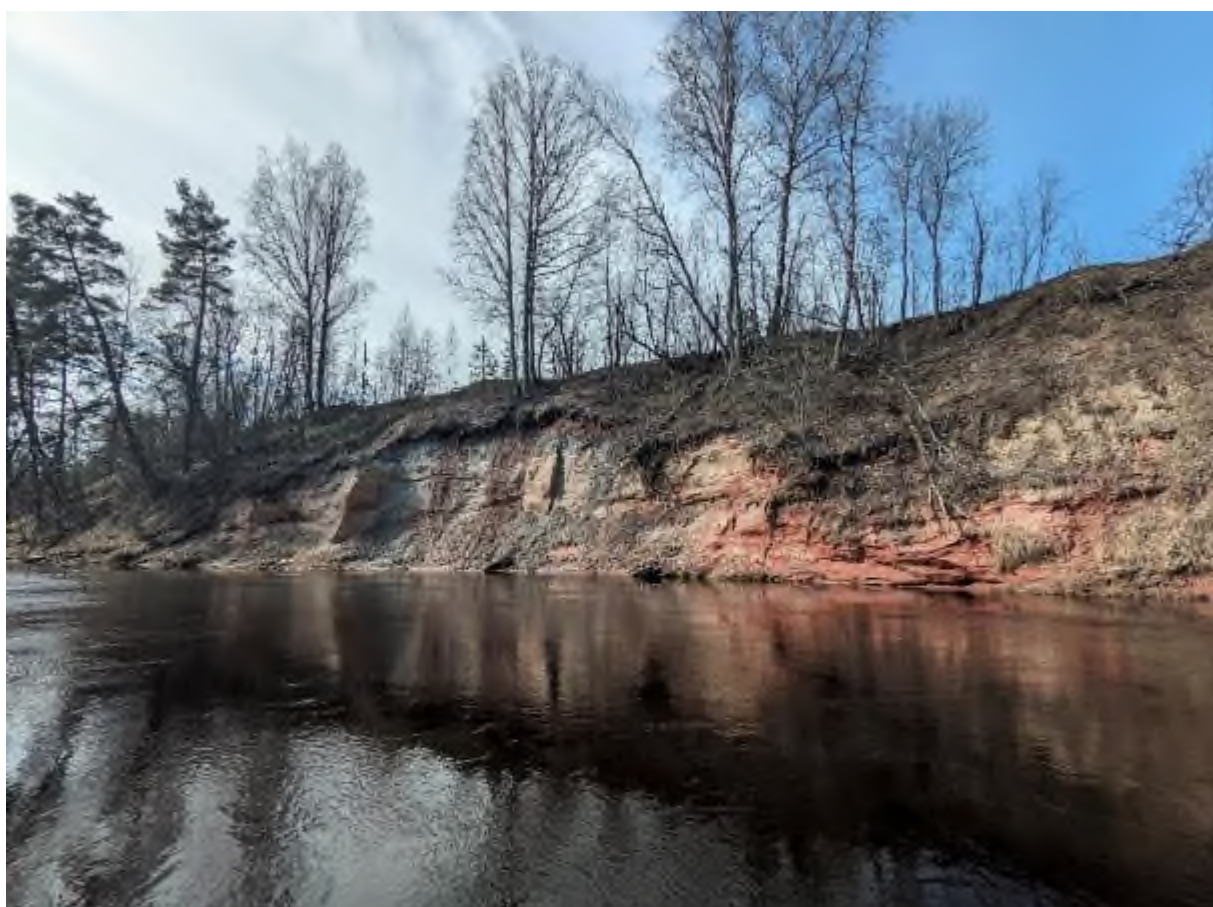
Фото 60. Вид осыпного склона правого берега р. Ящера вниз по течению от моста вблизи д. Долговка Лужского района, Ленинградской области
