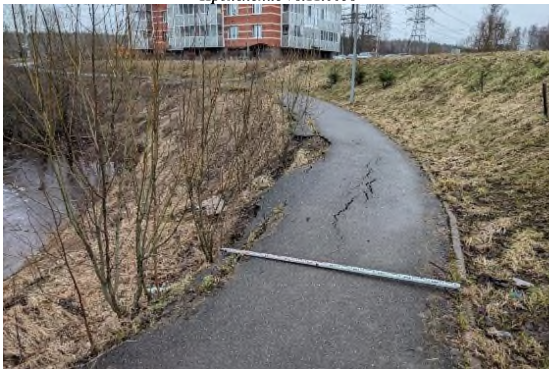
Фото 132. Проявление оползневого процесса вблизи д. 7 по 6-й Жерновской ул. Красногвардейского района г. Санкт-Петербурга (со стороны входной калитки)
