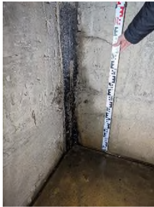
Фото 27. Подтопление подвального помещения д. 25/8 по ул. Ленина, 04.04.2024 г.
