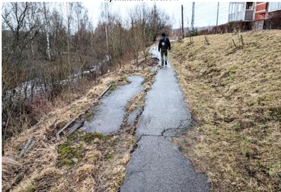
Фото 130. Проявление оползневого процесса вблизи д. 7 по 6-й Жерновской ул. (со стороны ЛЭП) Красногвардейского района г. Санкт-Петербурга
