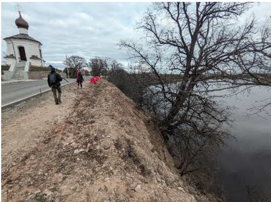
Фото 106. Прокладка пешеходного тротуара вдоль бровки обвального склона при подъезде к Снетогорскому монастырю
