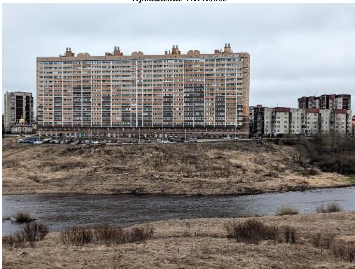
Фото 40. Общий вид на оползневой склон правого берега р. Тосна у д. 16 по ул. Октябрьской в г. Никольское Тосненского района Ленинградской области
