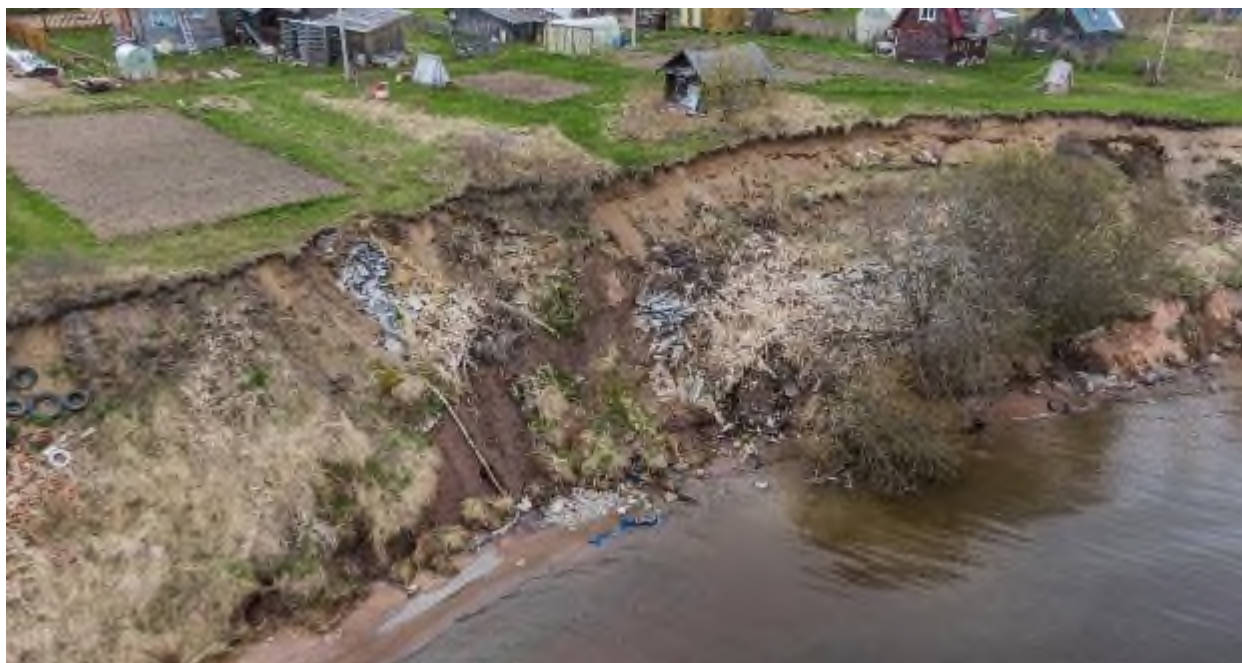
Фото 15, 16. Общий вид оползневого склона в ТН 3 в п. Каскесручей, 15.05.24 г.
