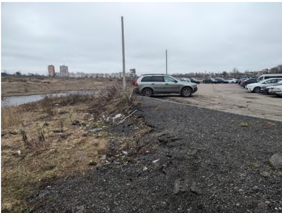
Фото 41. Сползание по склону поребрика и асфальтного покрытия парковочной территории ЖК Прибрежный у д. 16 по ул. Октябрьской в г. Никольское Тосненского района Ленинградской области
