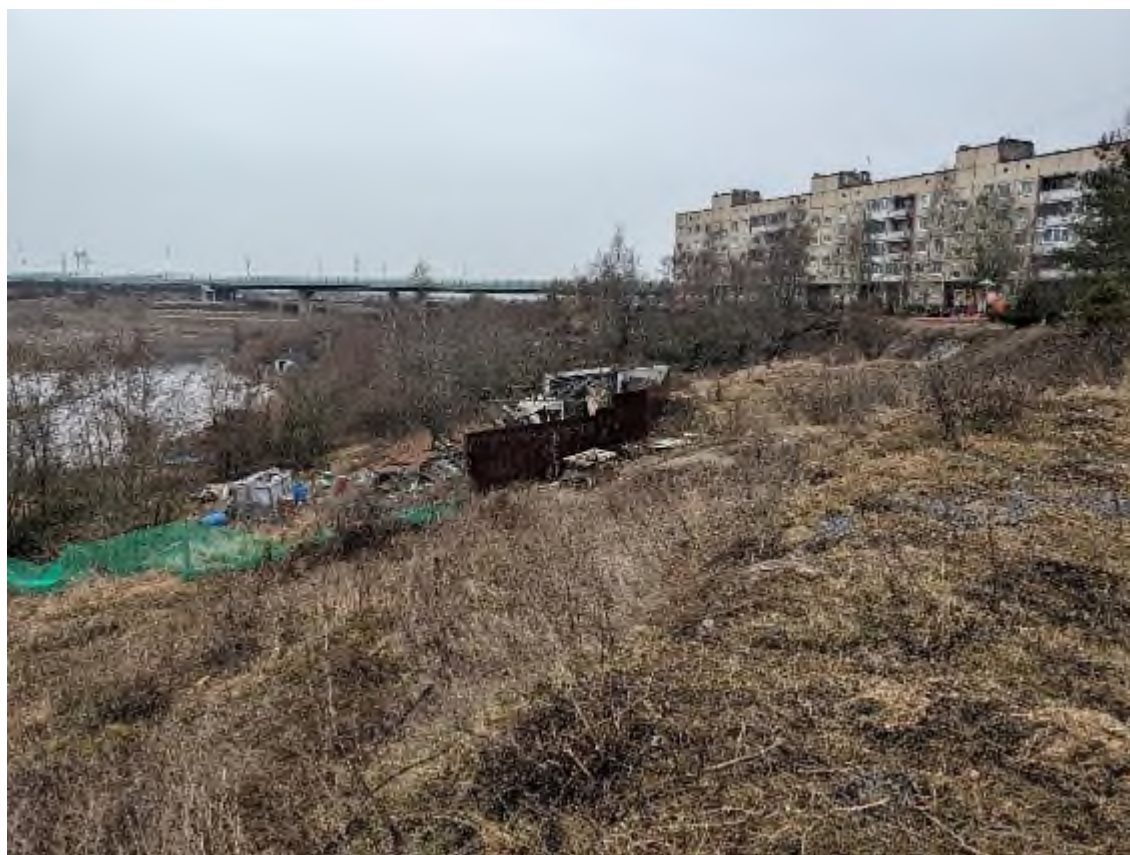
Фото 36. Создание дополнительного давления на оползневой склон в пределах проявления у д. 5 в пгт. Войсковоро Тосненского района, Ленинградской области за счёт насыпи со строительным мусором и строительства хоз. построек
