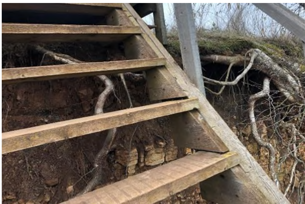
Фото 88. Воздействие оползневого и осыпного процессов на спусковые лестницы вблизи д. Ретлё
