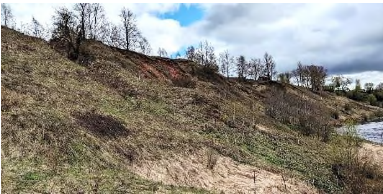
Фото 77. Общий вид на оползневой берег в д. Бобровик, 17.04.24 г.
