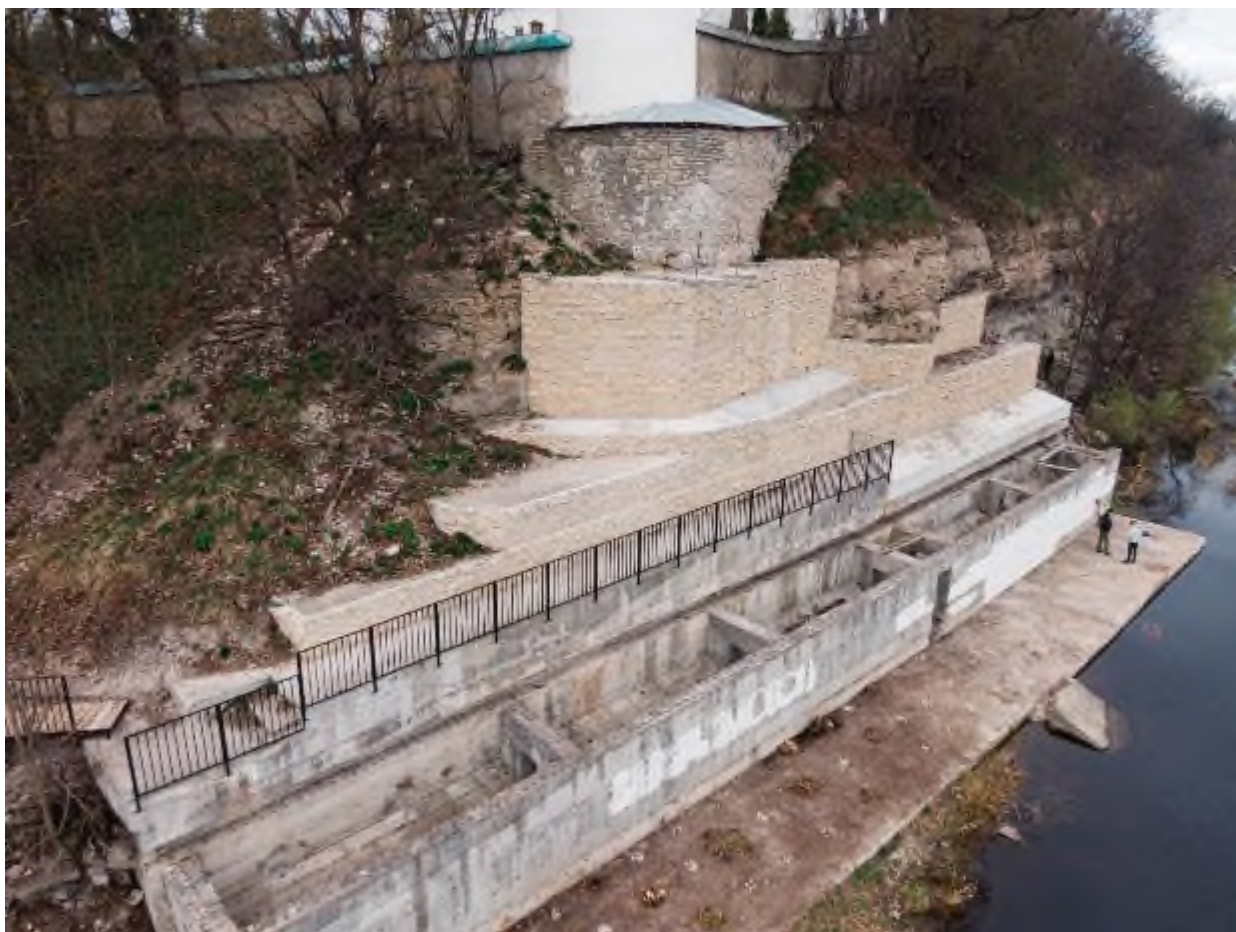
Фото 95. Защитная конструкция обвального берегового склона «Снетогорский монастырь» под Угловой башней в г. Псков (т.н. 0071)
