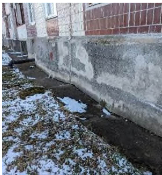
Фото 28. Цементация трещин (а) и маячки (б) просадки грунта по периметру д. 25/8 по ул. Ленина, по состоянию на 19.10.2023 г., (в) и (г) – то же, по состоянию на 04.04.2024 г.
