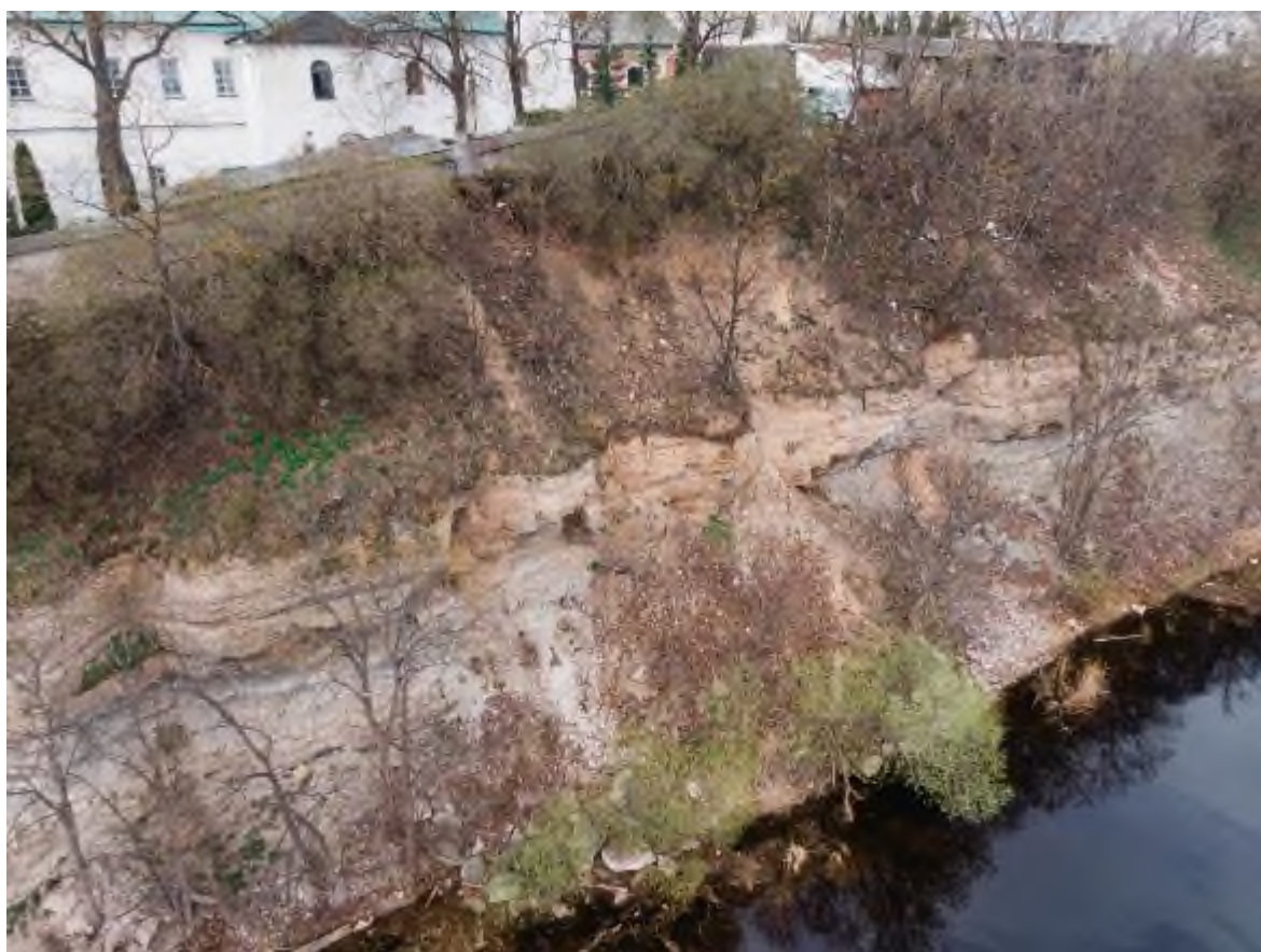
Фото 94. Общий вид участка проявления обвального процесса на склоне Снеогорского монастыря в г. Псков
