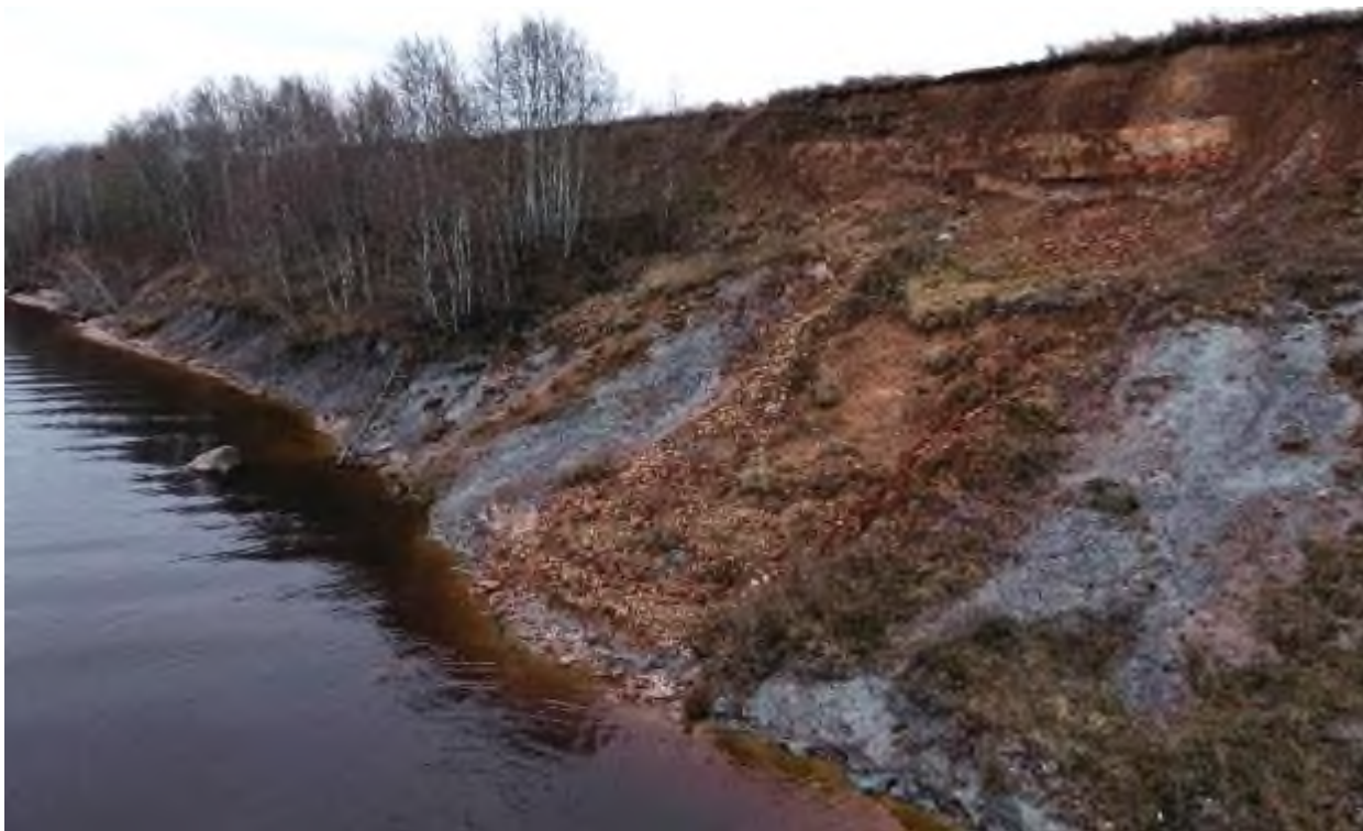
Фото 86. Крупные свежие оползневые тела у подножия склона вблизи д. Пустошь
