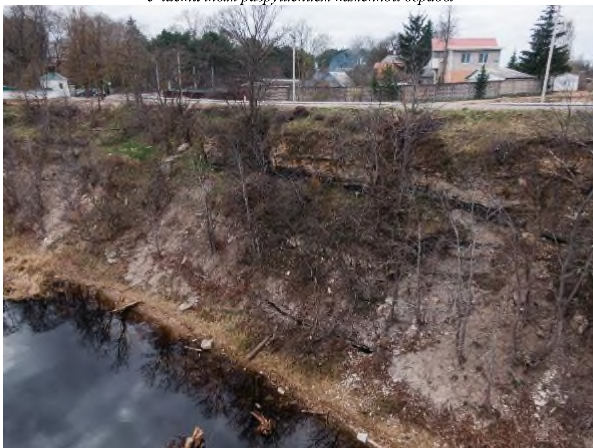
Фото 102. Нависание трещиноватой породы и обвалы в т.н. 0077 на склоне «Снетогорский монастырь» в г. Псков
