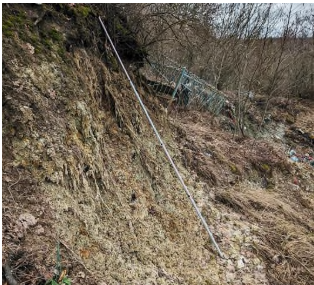
Фото 48. Воздействие оползневого процесса на объекты, расположенные на склоне в пределах Никольского кладбища в г. Никольское Тосненского района Ленинградской области
