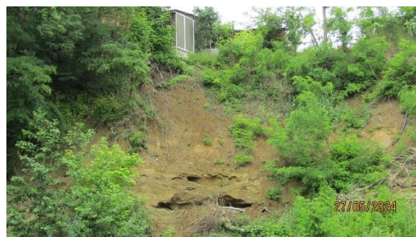
Фото 23-11-00039. Активный оползень на левобережном уступе р.Псекупс в станции Саратовской Фото ЮРЦ ГМСН «Гидроспецгеология» Дата съемки 27.05.2024.
