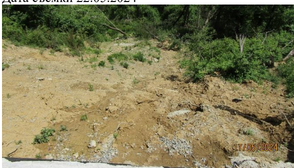
Фото 23-11-00360. Вид на языковую часть оползневой проявления. МО город-курорт Сочи, Центральный район, пер. Вишневый 85Б. Фото ФГБУ «Гидроспецгеология». Дата съемки 16.05.2024.
