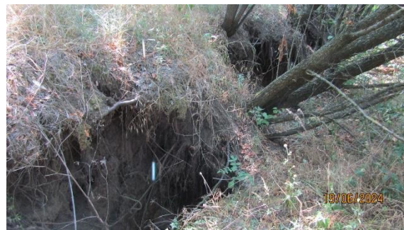
Фото 23-11-00102. Активный процесс отседания оползневой блока на Урупском оползне в 0,6 км к северо-востоку от а.Урупского Фото ЮРЦ ГМСН «Гидроспецгеология» Дата съемки 19.06.2024.
