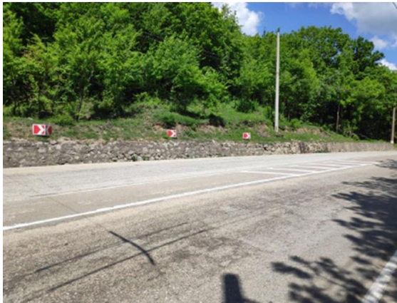
Фото 91-11-04805 Оползень № 285, язычковая часть, у автодороги 35 ОП РЗ 35А-002. Удерживающая бутовая подпорная стена
