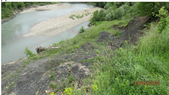
Фото 23-11-00141.Активизация оползневого процесса на левобережном уступе р.Пшехи в п.Цуревском Фото ЮРЦ ГМСН «Гидроспецгеология» Дата съемки 29.05.2024.
