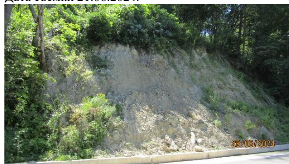
Фото 23-11-00206. Активизация оползня в верхнем откосе автодороги А147 у юго-восточной окраины с.Зубова Щель Фото ЮРЦ ГМСН «Гидроспецгеология» Дата съемки 26.06.2024.
