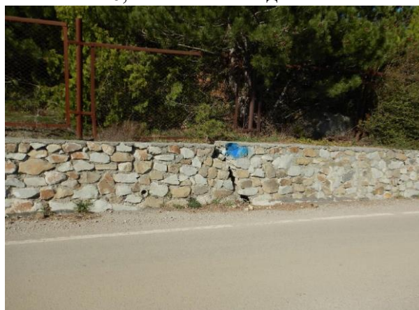
Фото 91-11-02802 Деформация верхней стены, приуроченные к локальному очагу. Величина раскрытия 3,0 см.
