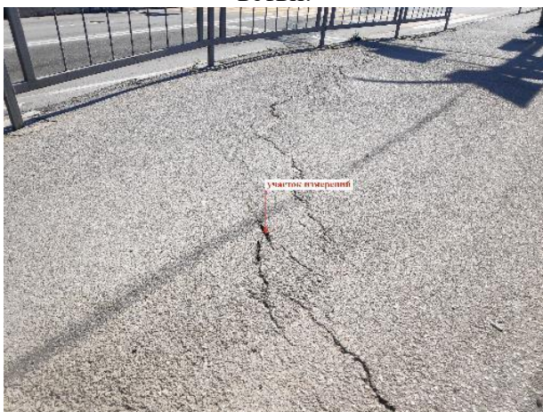
Фото 91-11-04201. Оползень № 408, головная часть, правый борт. Трещины на асфальте а/д 35 ОП РЗ 35А-002.
