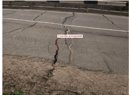
Фото 91-11-04901 А/д 35 ОП МЗ 35Н-012. Левый борт локального оползневого очага. Участок измерения, трещина шириной 8,5 см. Многочисленные трещины шириной 5-8 см на дорожном полотне.
