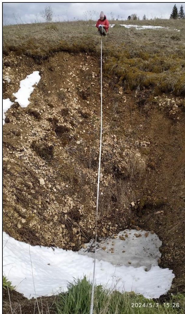
Фото 66-31-00137. Т.н. 412, Красноуфимский участок, Свердловская область
