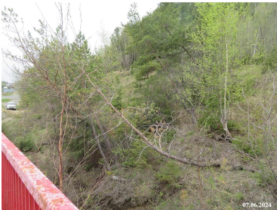
Фото 86-11-00076. Проявление оползневых процессов, Ханты-Мансийск, восточная объездная дорога, участок «Пьяный лес». ХМАО-Югра
