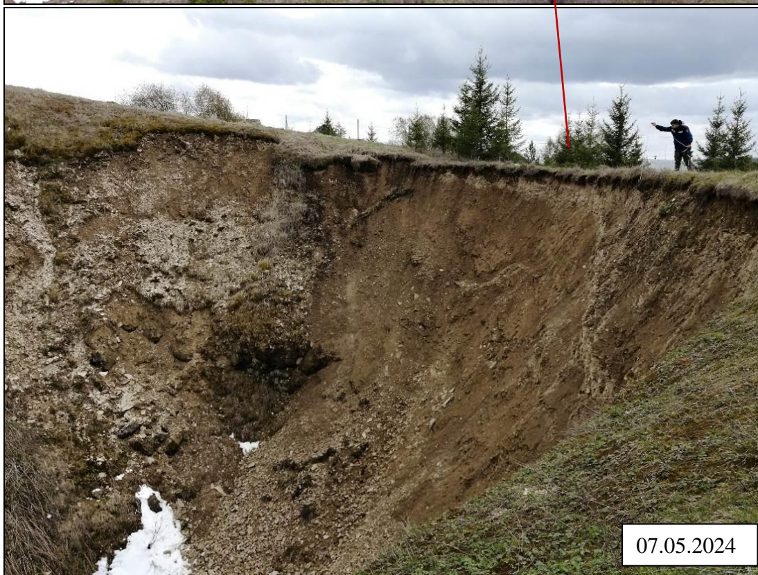
Фото 66-31-00121. Т.н. 264. Красноуфимский участок, Свердловская область
