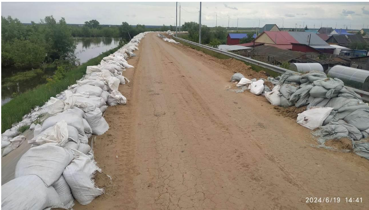
Фото 72-13-00344. Гидротехническое сооружение на р. Ишим. Абатский участок, Тюменская область
