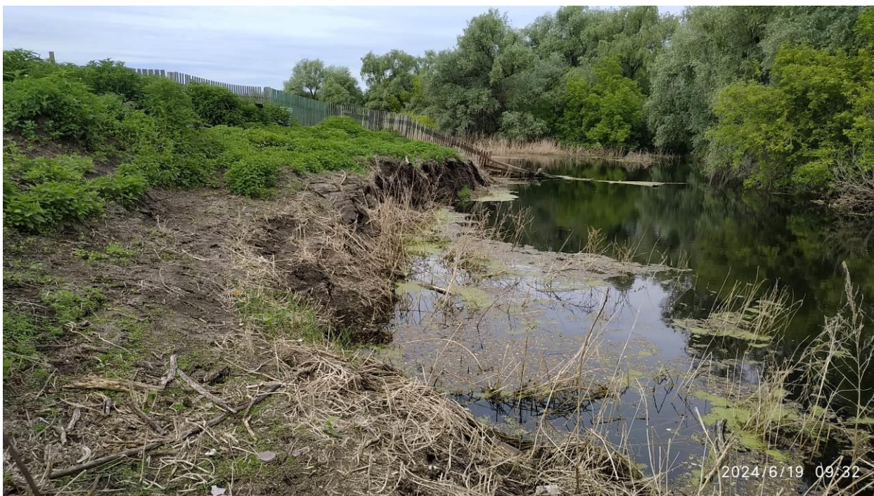
Фото 72-2024-01-001-1. Подтопленная территория д. Черная. Участок д. Черная, Тюменская область
