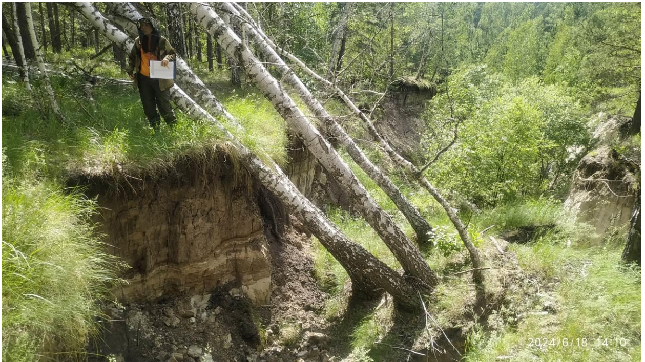
Фото 72-22-00330. Участок развития процесса овражной эрозии. Марковский участок, Тюменская область
