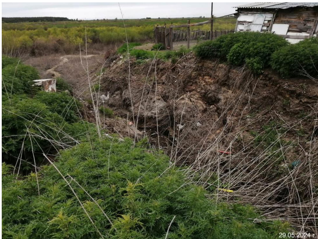
Фото 45-2024-01-001-3. Хозяйственные постройки на борту оврага по адресу: ул.Красноармейская,1. Участок Звериноголовский, Звериноголовский МО, Курганская область
