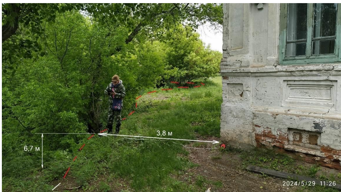
Фото 45-2024-01-001-1. Здание бывшей школы по адресу: ул. Кравченко, 45 вблизи борта оврага. Участок Звериноголовский, Звериноголовский МО, Курганская область
