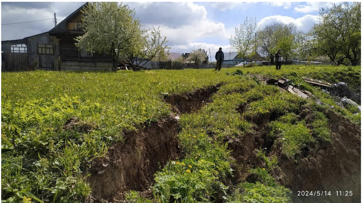
Фото 74-11-00049. Бровка отрыва оползня в 140 м западнее кладбища г. Аша. Участок Ашинский, Челябинская область
