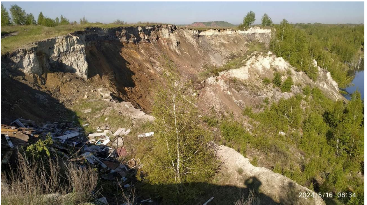
Фото 74-11-00072. Общий вид на активное оползание стенки отрыва. Участок Копейский, Челябинская область
