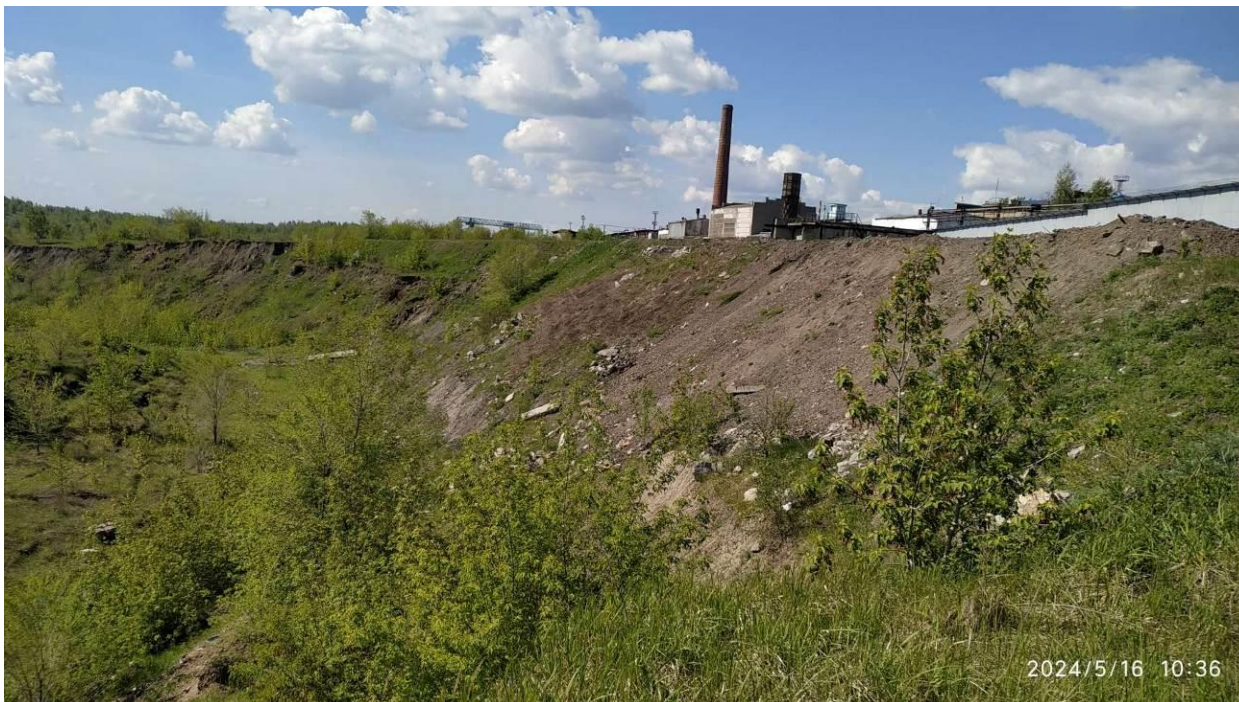
Фото 74-11-00069. Оползневой склон на участке Копейский, Челябинская область
