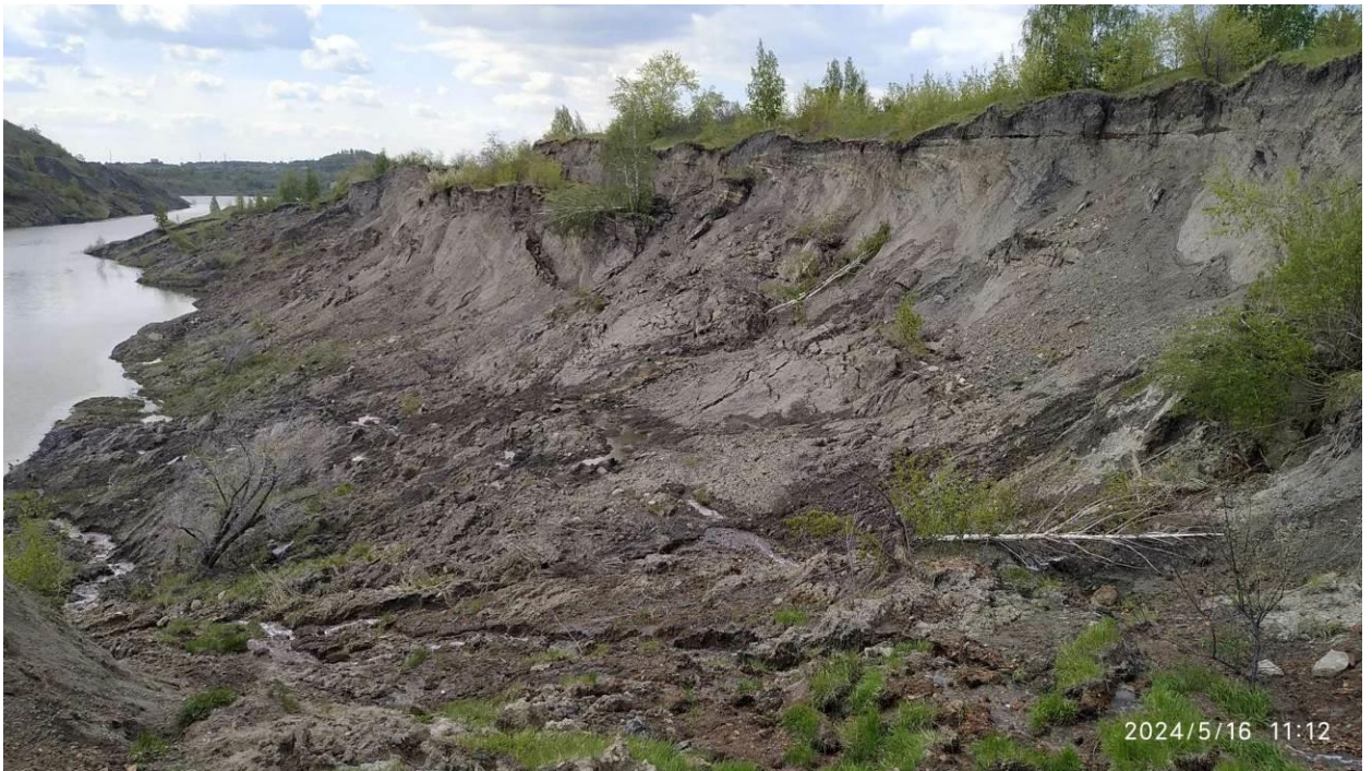
Фото 74-11-00067. Свежее оползание борта. Участок Копейский, Челябинская область
