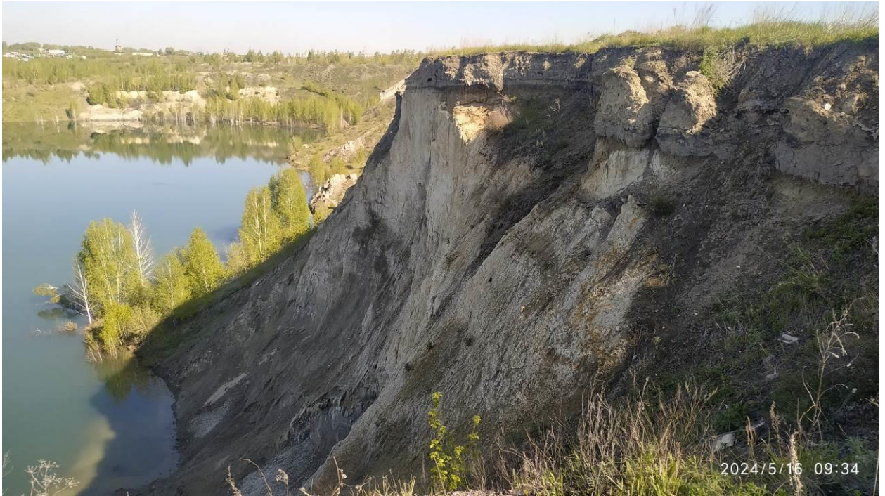
Фото 74-11-00075. Осыпные процессы на борту карьера в в ТН 21а. Участок Копейский, Челябинская область
