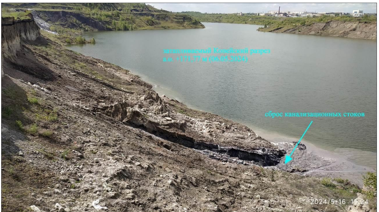
Фото 74-11-00068. Оползание восточного борта Копейского разреза. Участок Копейский, Челябинская область
