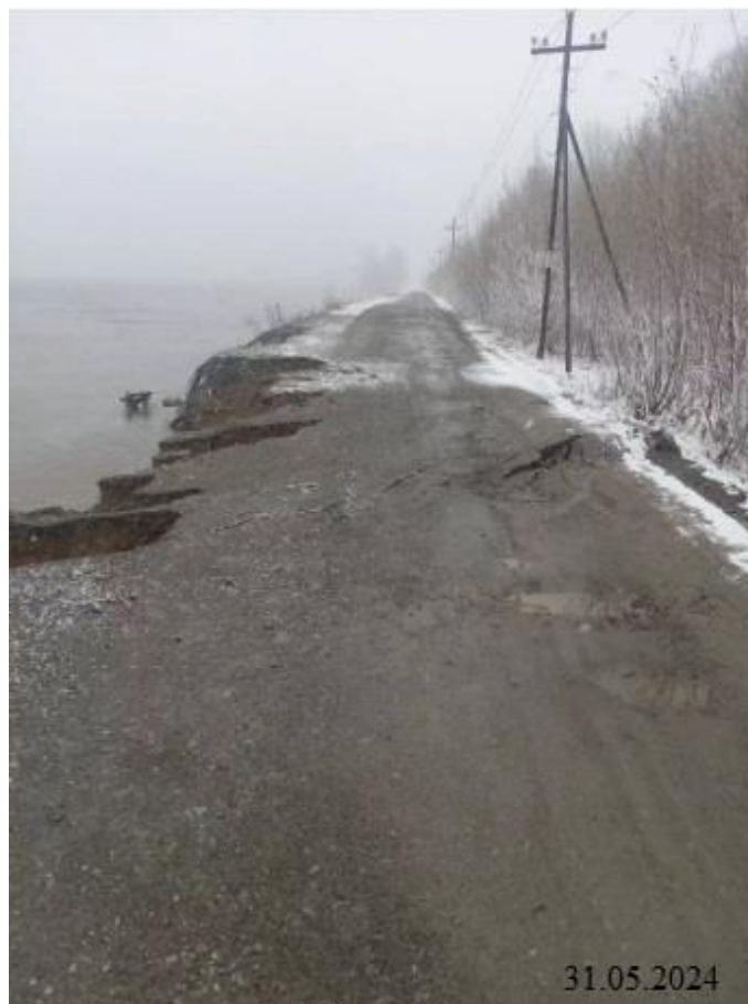
Фото 2. Граница Нижневартовского района ХМАО-Югры и Томской области, деформация участка дороги Стрежевой – Соснина 31.05.2024 г. (фото интернет СМИ «Muksun»). ХМАО-Югра
