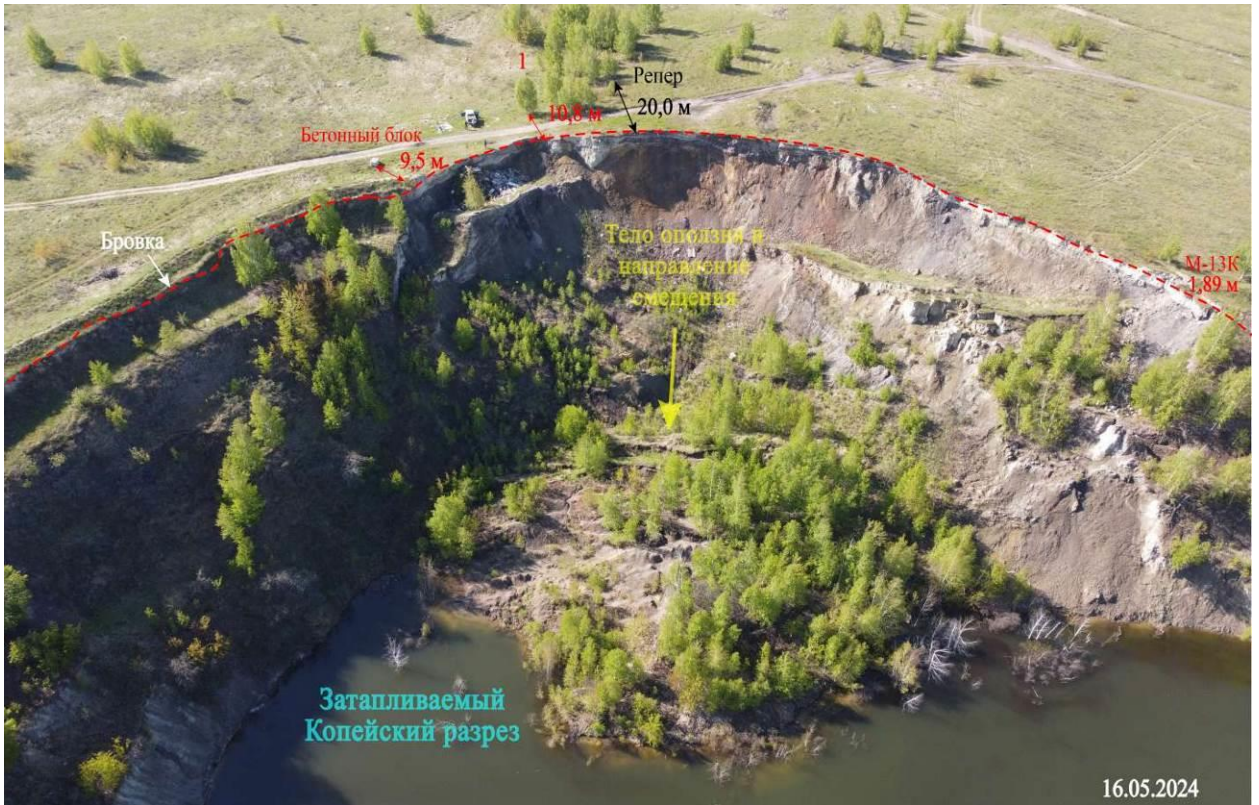
Фото 74-11-00072. Оползание южного борта разреза по отработке целиков шахт 201 и 204. Участок Копейский, Челябинская область
