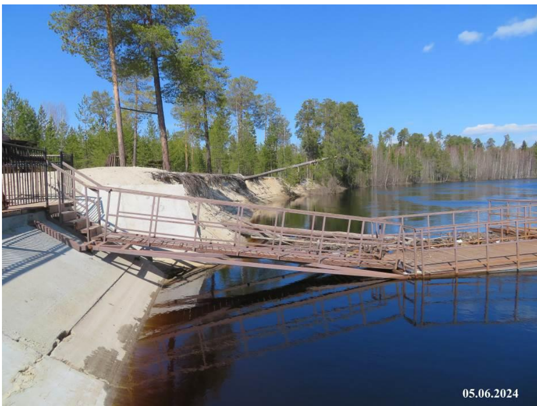
Фото 86-1110-0003-2. Когалымский участок. Проявление гравитационного комплекса процессов, берег р. Ингу-Янгун, причал Этнодеревни. ХМАО-Югра
