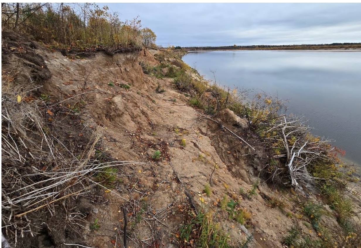
Фото 9, 10. Общий вид поражённого оползневым процессом берегового склона вблизи д. Пускино.
