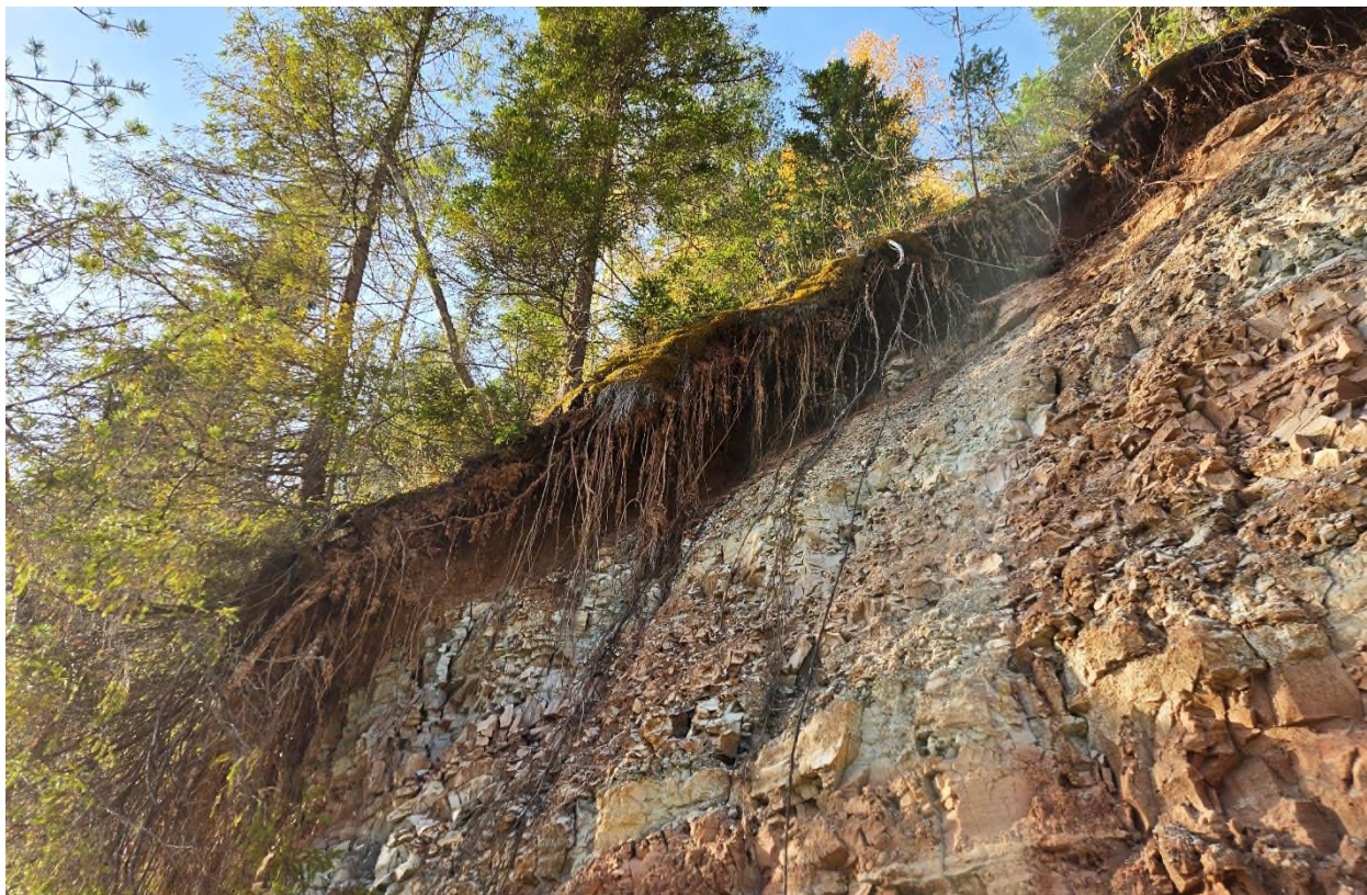
Фото 74. Нависание дернины над оголёнными частями склона в пределах проявления вблизи д. Студёное Великоустюгского района.
