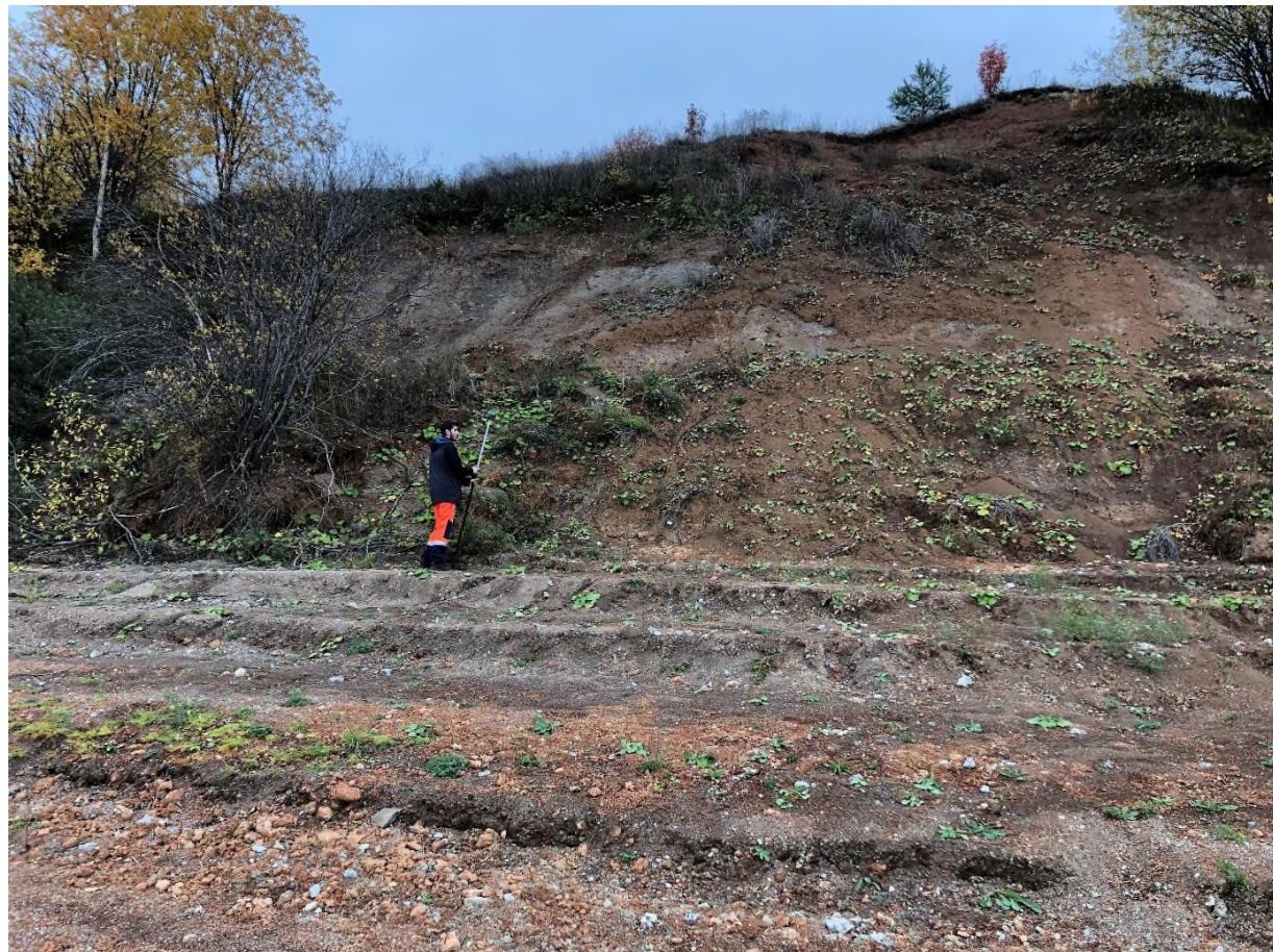
Фото 25. Свежие оползневые тела на склоне в ТН 3.2 вблизи ж/д ст. Заовражье.
