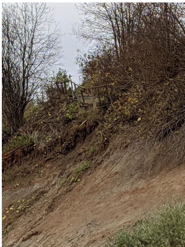
Фото 26, 27. Воздействие оползневого процесса на спусковую лестницу в районе ДОКа, 14.10.2023 г. и 04.10.2024 г. (лестница практически полностью разрушена) ТН 3.3.
