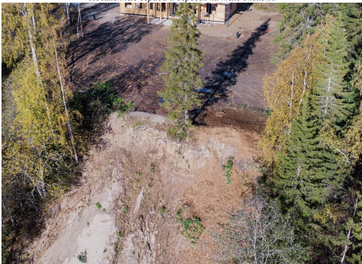
Фото 60. Строящееся здание вблизи бровки склона, в потенциальной зоне воздействия оползневого процесса КИЗ Волна.
