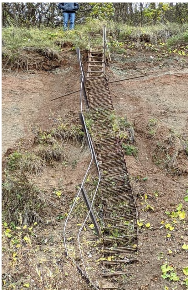
Фото 21, 22. Воздействие оползневого процесса на спусковую лестницу у ж/д ст. Заовражье, 14.10.2023 г. и 04.10.2024 г. соответственно.
