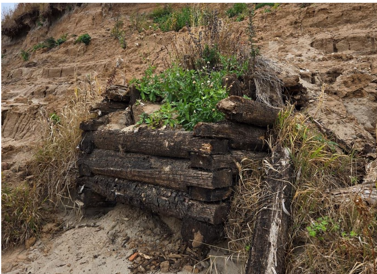
Фото 17, 18. Старые колодцы, разрушенные в результате оползания берегового склона и деградации земель вблизи д. Пускино.
