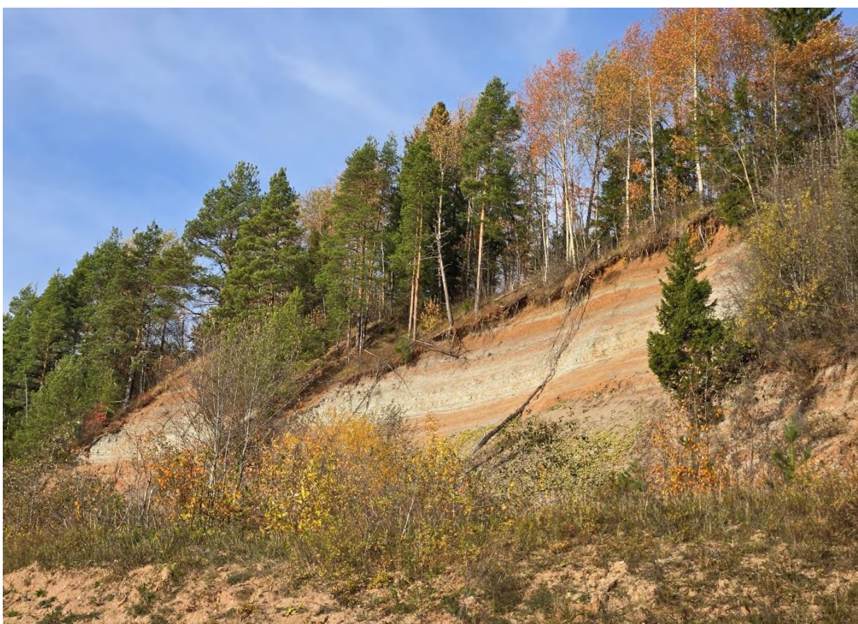
Фото 66, 67. Общий вид на оползневой склон в д. Красное Поле Великоустюгского района.
