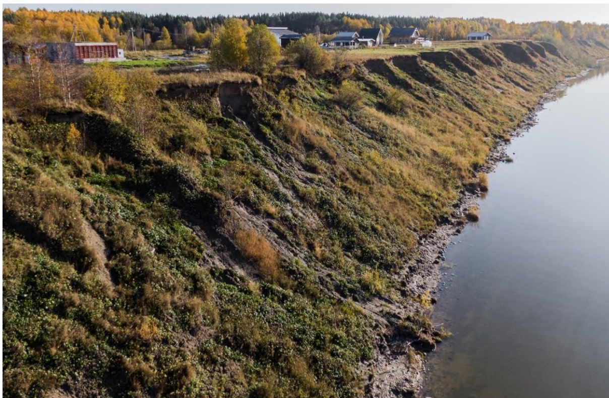
Фото 51, 52. Общий вид на правый береговой склон р. Северная Двина между д. Черный Яр и д. Бабанегово. Свежие оползневые массы на склоне и у подножья. Нависание ПРС у верхней бровки.
