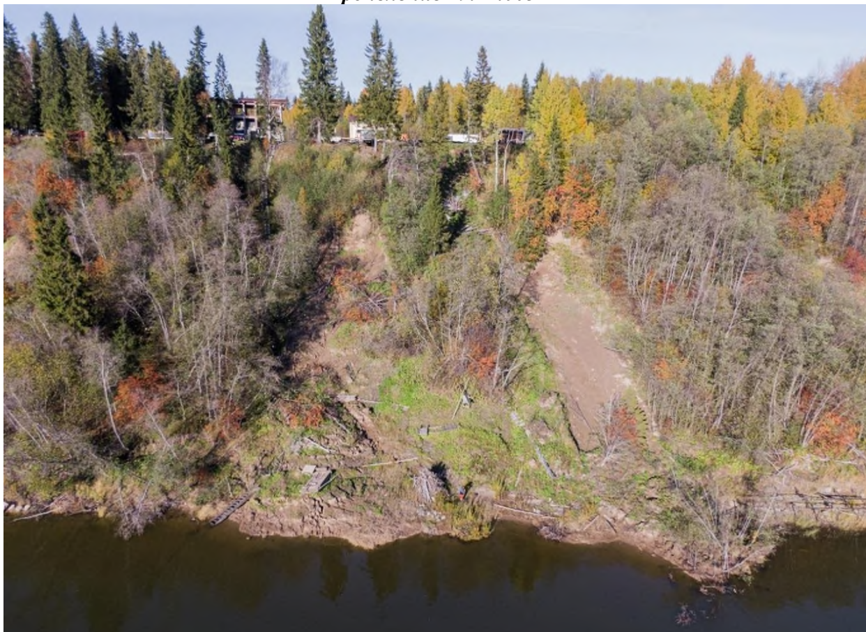
Фото 61. Общий вид свежего оползня в посёлке Боброво на территории Базы отдыха Мостострой, ТН 4.1.
