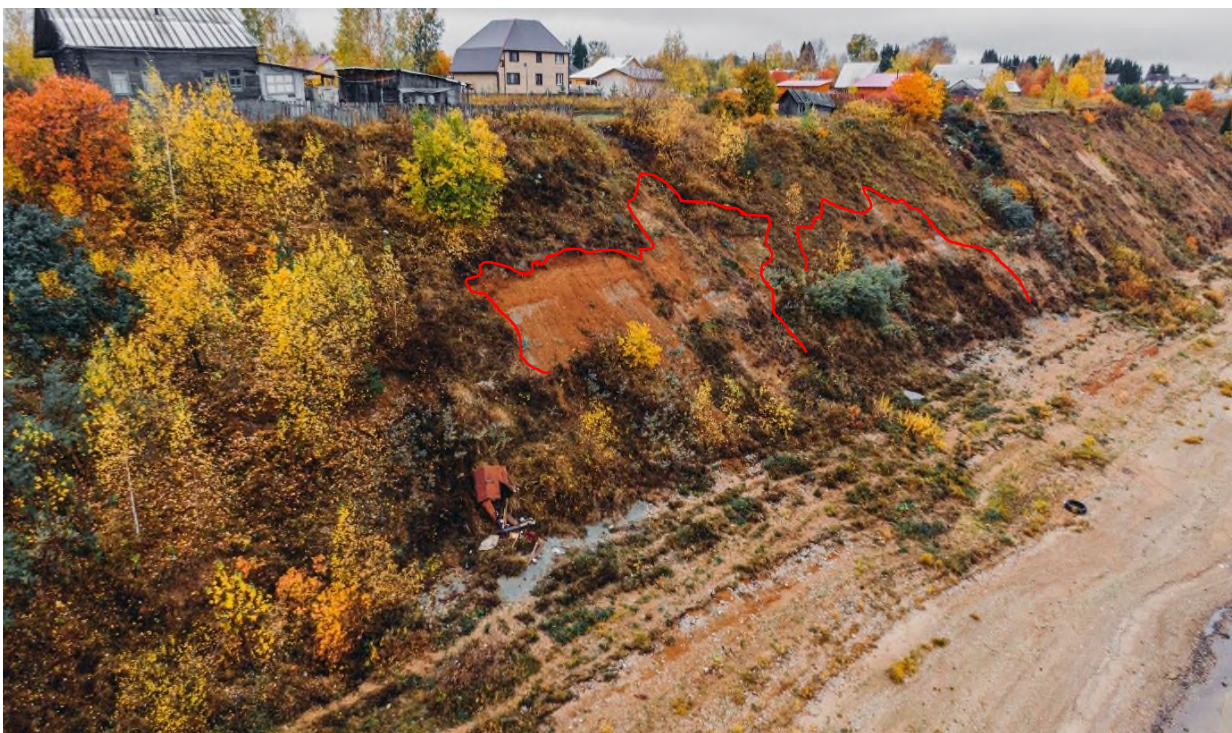
Фото 46. Общий вид оползневого склона в д. Марковская
