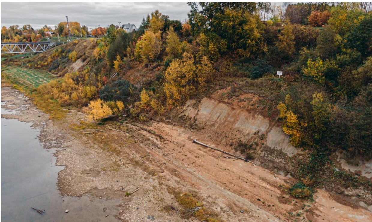
Фото 19. Частично заросшая часть оползневого склона с поваленными деревьями у ж/д ст. Заовражье.
