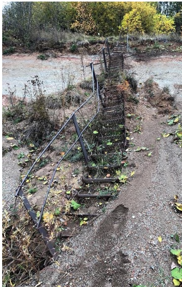
Фото 21, 22. Воздействие оползневого процесса на спусковую лестницу у ж/д ст. Заовражье, 14.10.2023 г. и 04.10.2024 г. соответственно.
