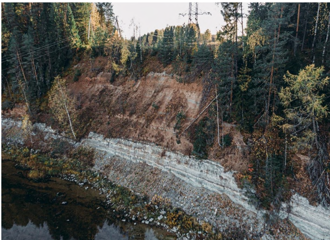
Фото 71. Высоковольтные линии, проходящие через р. Стрельна, опоры у бровки оголённого склона вблизи д. Студёное Великоустюгского района.
