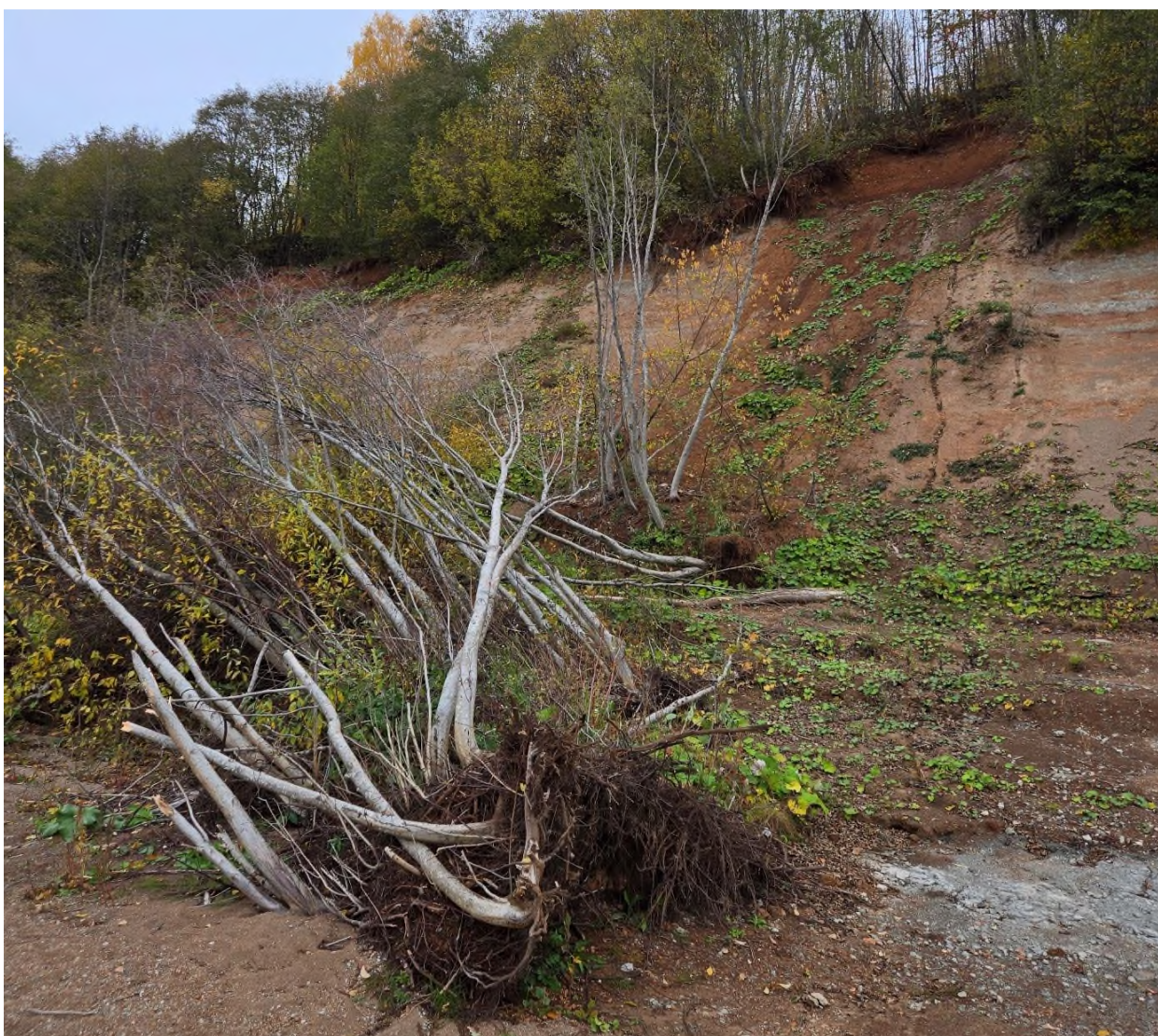
Фото 35, 36. Сползшиє деревья у подножья склona, вблизи д/ж ст. Заовражье, ТН 4.1.
