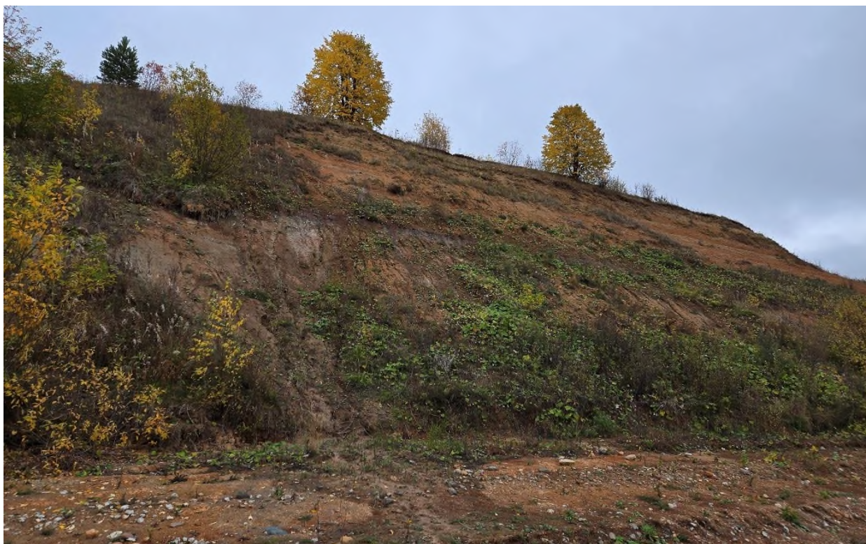
Фото 23. Береговой склон вблизи ж/д ст. Заовражье с оползшим дёрном, промоинами и делювием в ТН 1.1.
