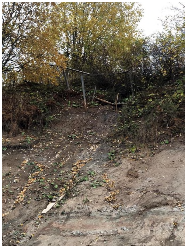
Фото 26, 27. Воздействие оползневого процесса на спусковую лестницу в районе ДОКа, 14.10.2023 г. и 04.10.2024 г. (лестница практически полностью разрушена) ТН 3.3.
