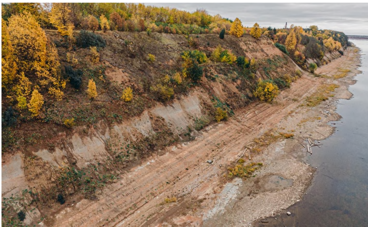
Фото 20. Оголённая часть оползневого склона с небольшими свежими сплывами грунта у ж/д ст. Заовражье.
