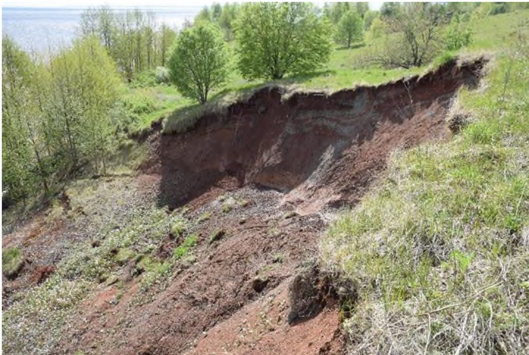
Фото 37.11.00094. Оползень северо-восточнее д. Красная Гора Пучежского района, правобережный склон р. Волга (Горьковское вдхр.), Ивановская область
