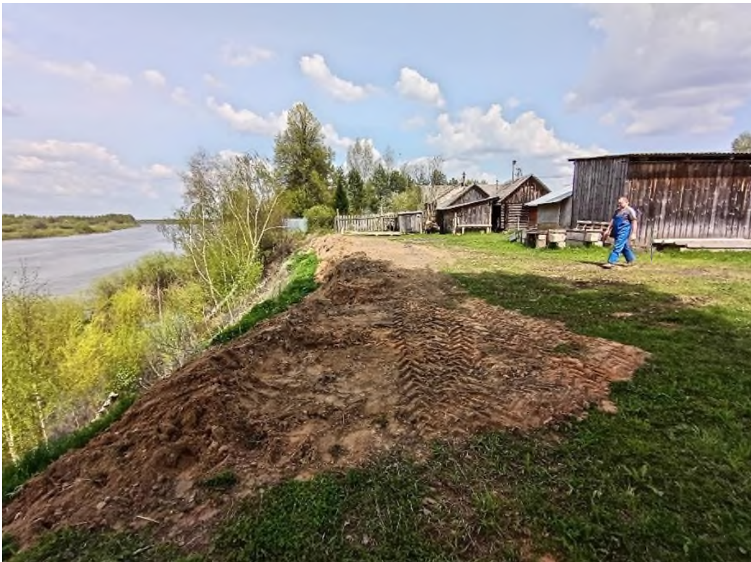
Фото 44.11.00015. Оползень на левом склоне р.Кострома, с.Сандогора, Костромской район, (придомовая территория д. №15 по ул.Центральная)
