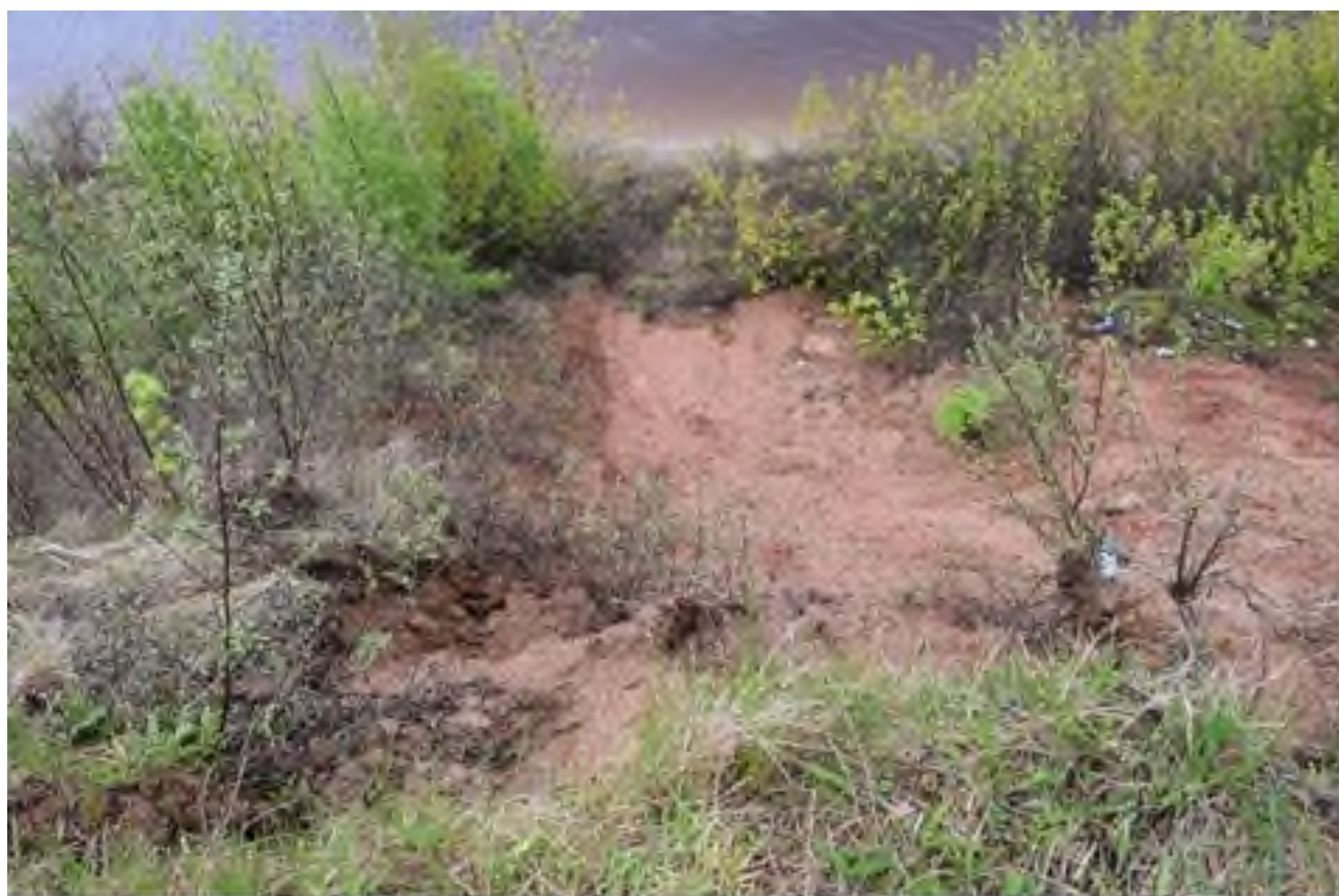
Фото 37.11.00095. Оползень на северной окраине г. Пучеж Пучежского района, вдоль лесной зоны отдыха городского парка (в районе ул. Ульяны Громовой), северо-западнее спортивной площадки «Воркаут», правобережный склон р. Волга (Горьковское вдхр.) Ивановская область
