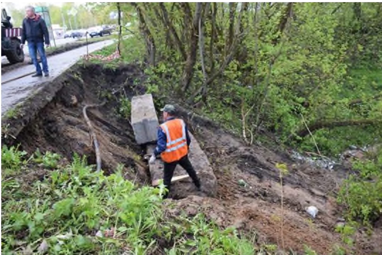
Фото 37.11.00127. Оползень в г. Кинешма, ул.50-летия Комсомола, на склоне Лесозаводского оврага, Ивановская область
