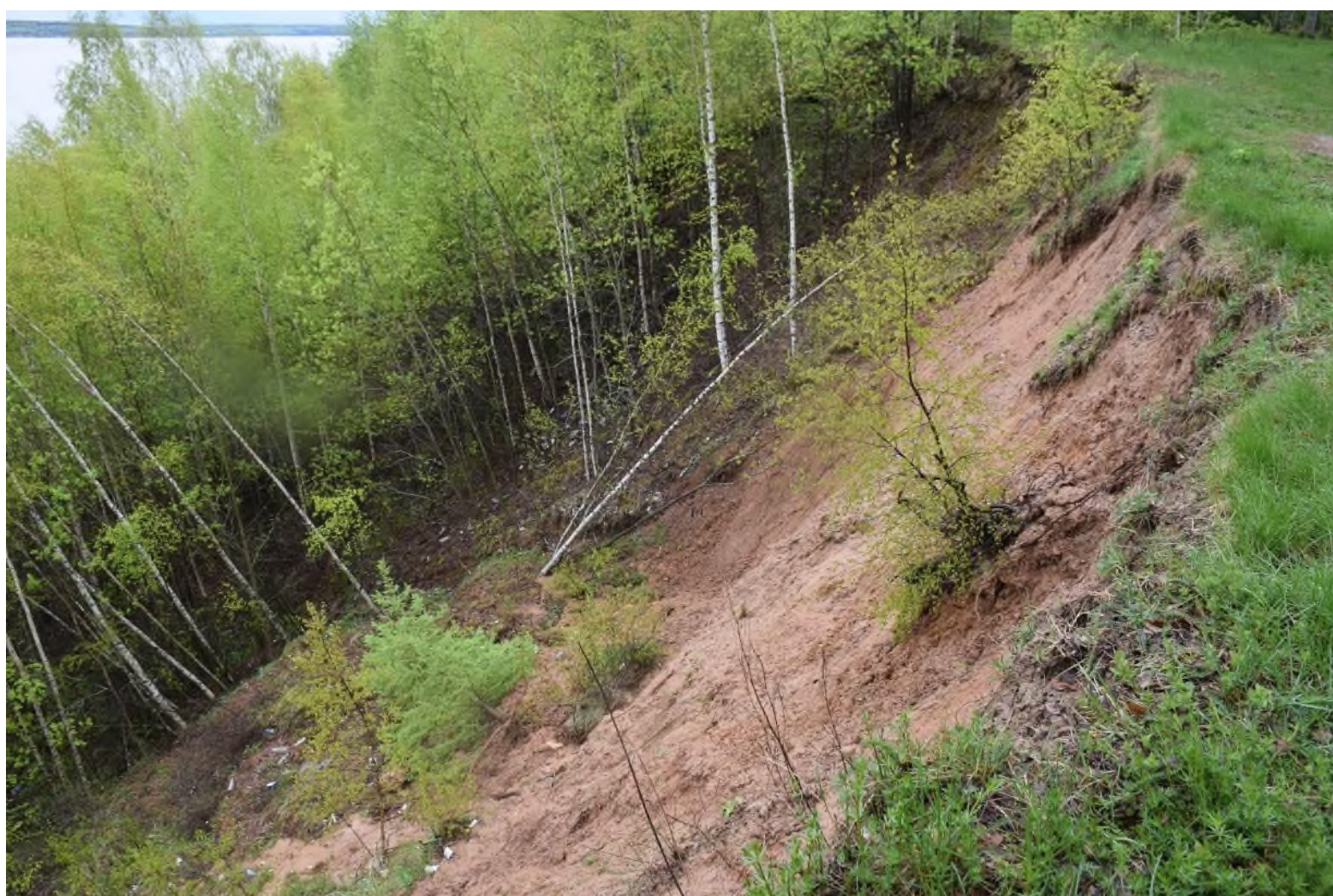
Фото 37-11-00004 Активный оползень в г. Пучеж, Пучежский район, Ивановская область
