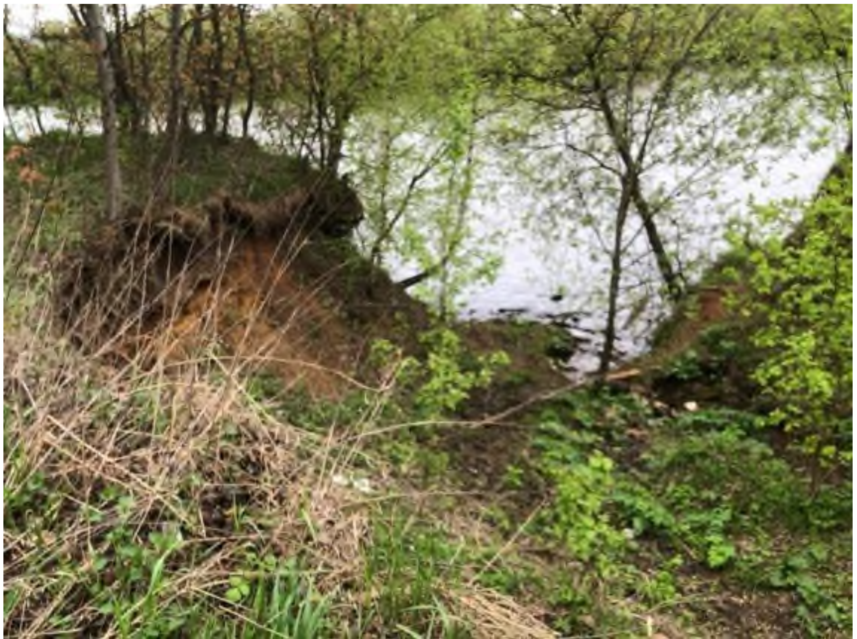
Фото 50-11-00858. Оползневой процесс в д. Слобода, Ленинский район, Московская область
