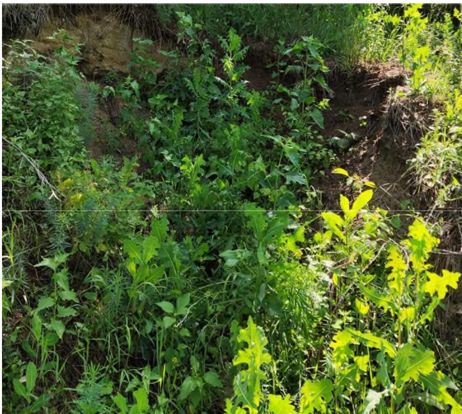
Фото 68-11-00041. Активное проявление оползневого процесса в г. Тамбове Тамбовская область
