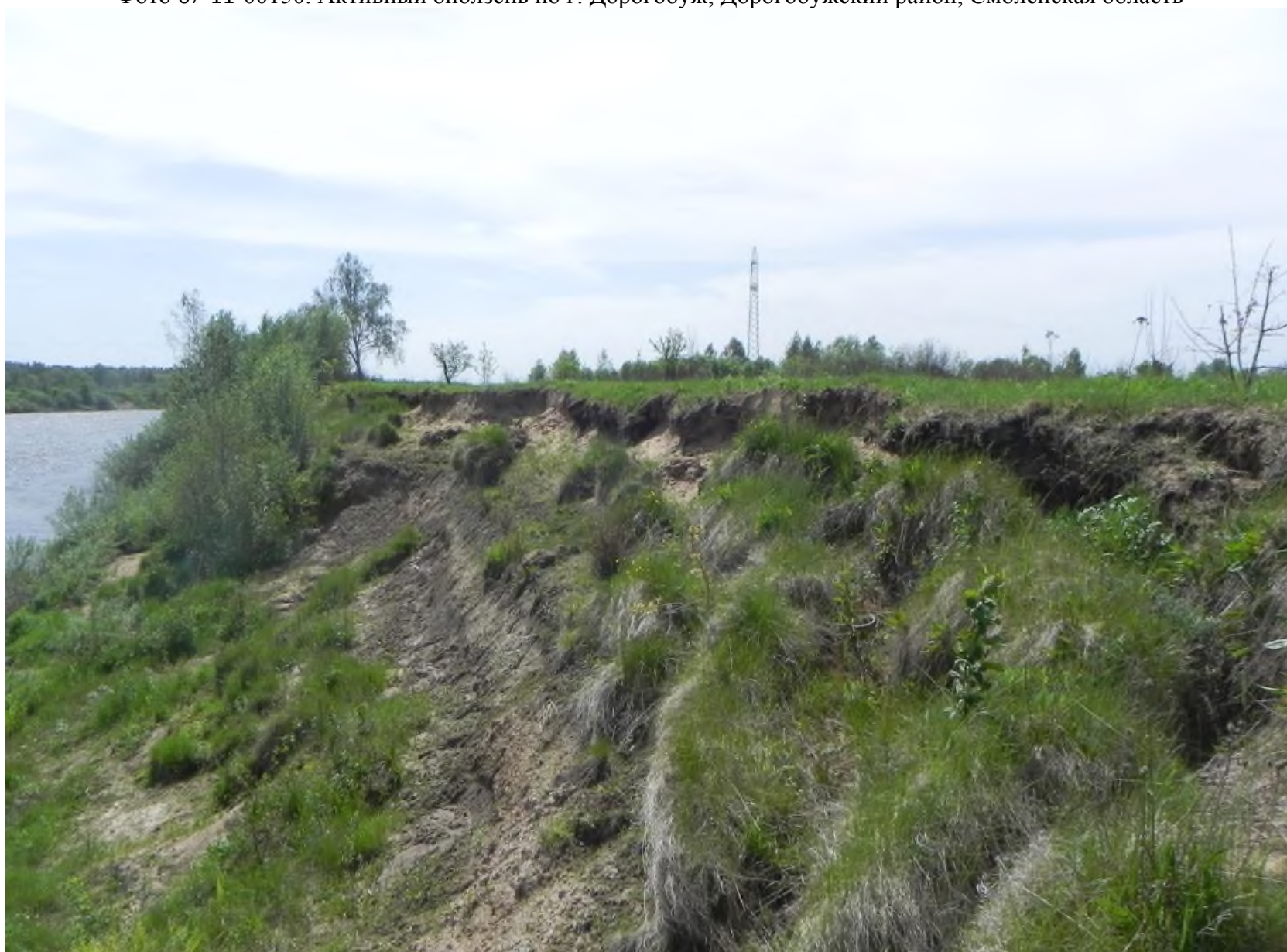
Фото 67-11-00150. Активный оползень по д. Соловьево, Кардымовский район, Смоленская область
