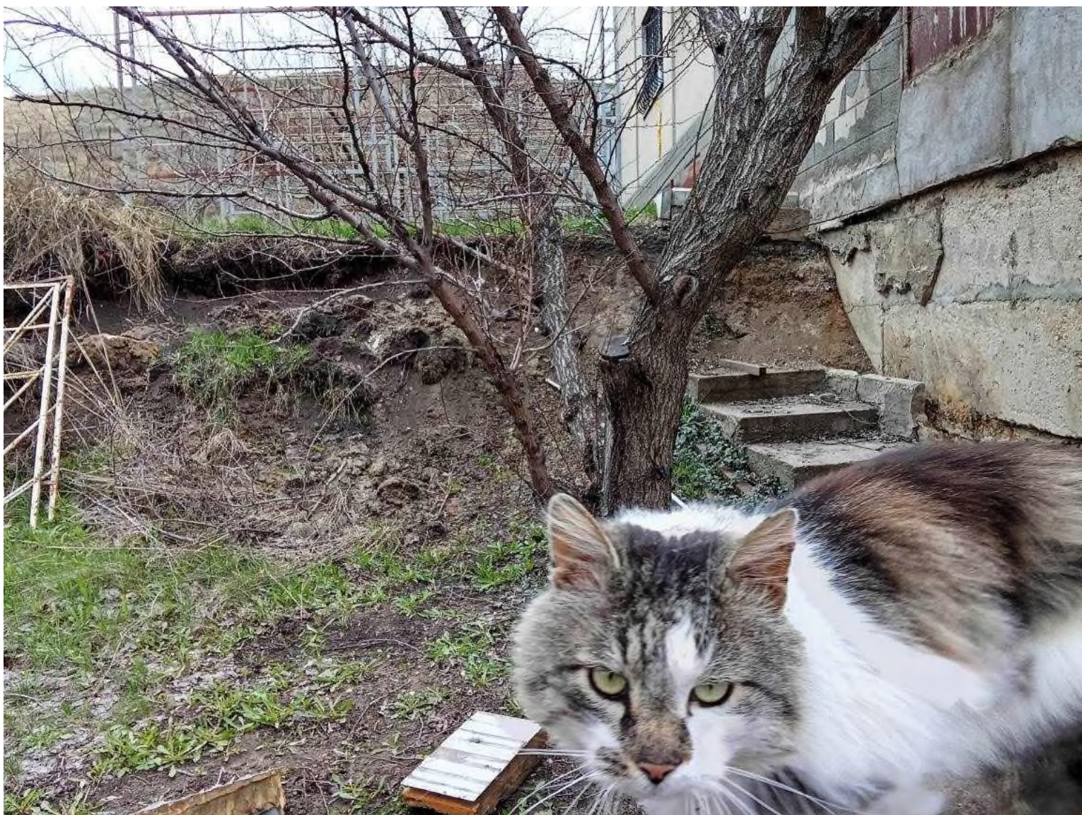
Фото 48-11-00117 Активный оползень ул. Речная, д. 24, 25, 26, 27, 28 с. Сырское Липецкий район Липецкая область
