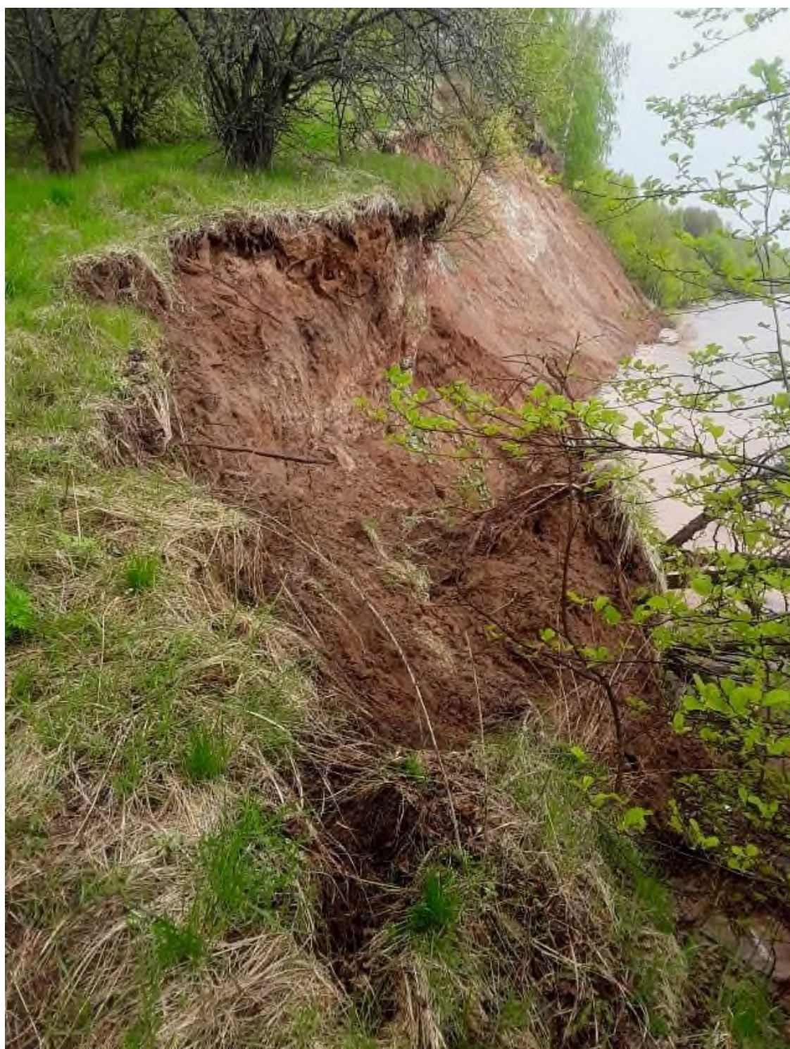
Фото 48-11-00117 Активный оползень. Ивановская область, Пучежский район, д. Безводново.
