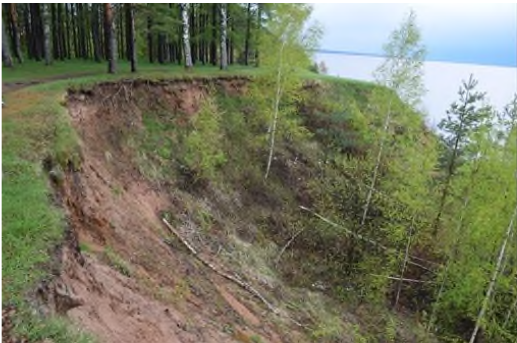
Фото 37.11.00005. Оползень на северной окраине г. Пучеж Пучежского района, вдоль лесной зоны отдыха городского парка, севернее спортивной площадки «Воркаут», правобережный склон р. Волга (Горьковское вдхр.) Ивановская область
