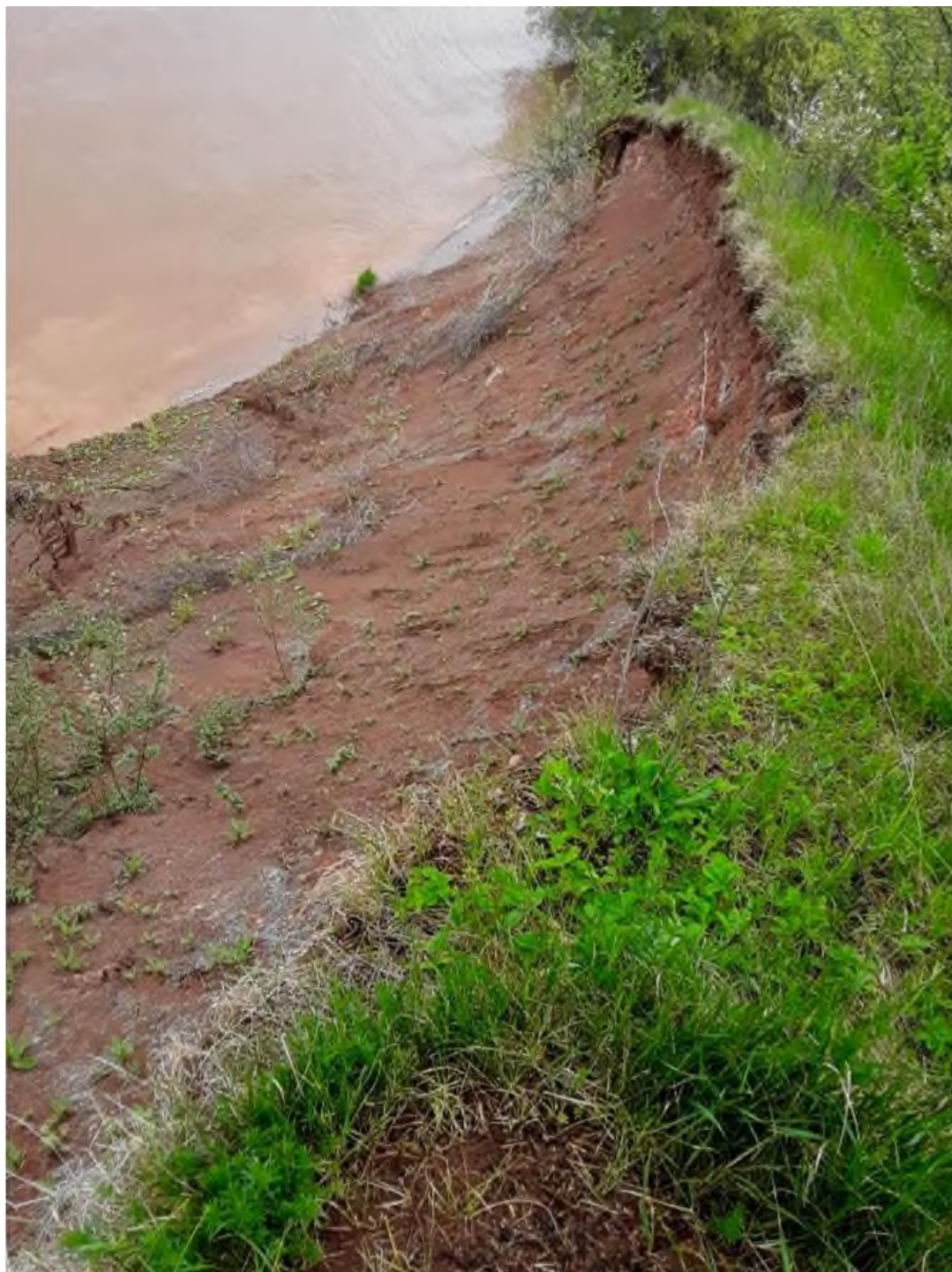
Фото 37-11-00014 Активный оползневой склон между д. Красная Гора и д. Юшково Пучежский район Ивановская область
