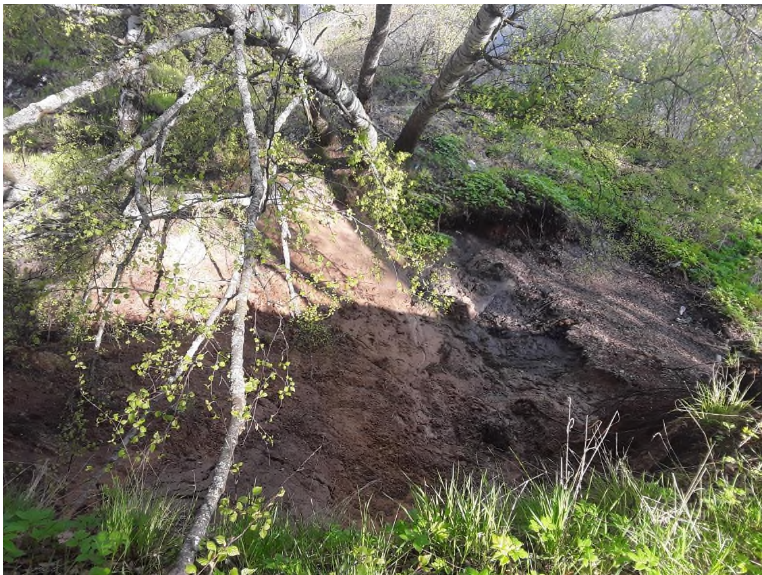
Фото 37-11-00126 Активный оползень в г. Кинешма, Кинешемский район, Ивановская область
