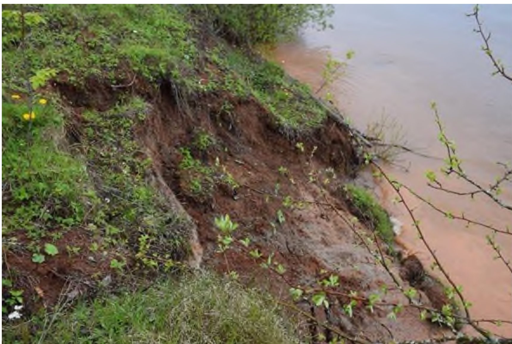
Фото 37.11.00017. Оползень на южной окраине д. Попереково Пучежского района, правобережный склон р. Волга (Горьковское вдхр.), Ивановская область
