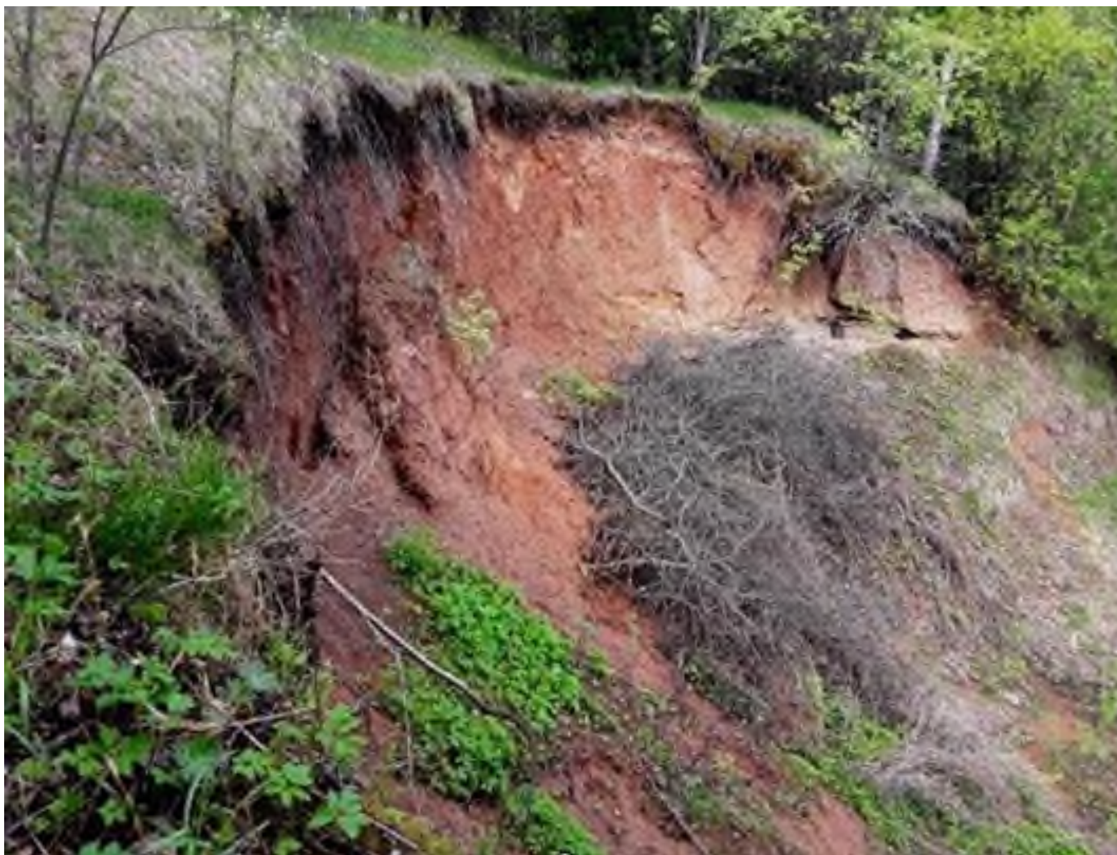
Фото 37.11.00011. Оползень в д. Бакланиха Пучежского района, северо-восточнее д.№11, правобережный склон р. Волга (Горьковское вдхр.), Ивановская область
