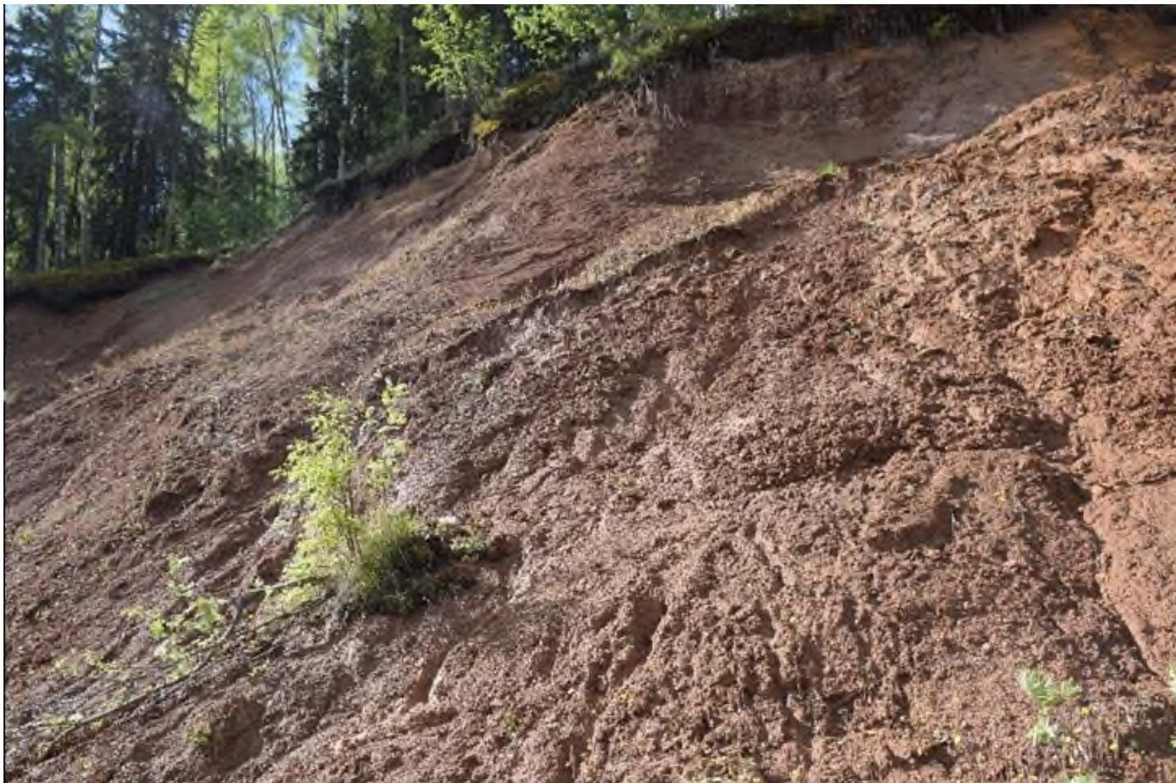
Фото 37.11.00007. Оползень у д. Девкина Гора, Пучежского района, вдоль правобережного склона р. Волга (Горьковское вдхр.), Ивановская область
