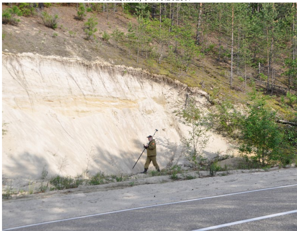
Фото 28-12-00003. Оголение корневой системы растений по кромке осыпи на 103 км автодороги Свободный-Благовещенск, 04.06.2025 г.
