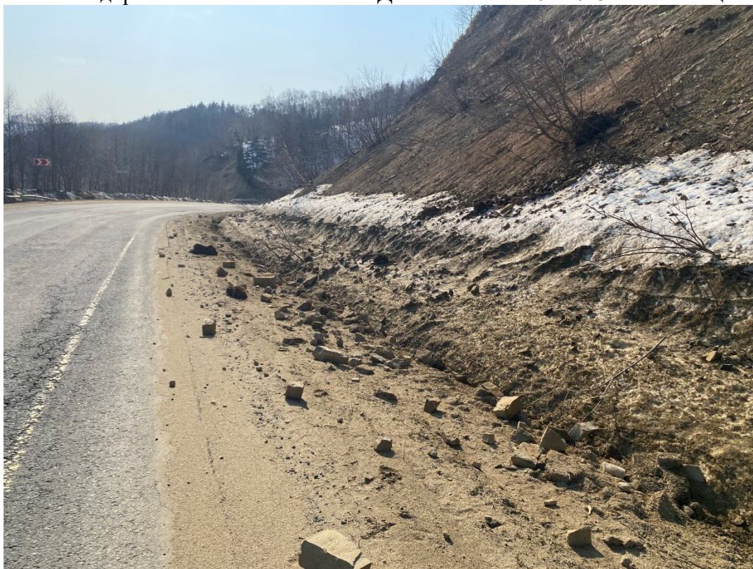
Фото 65-10-0003. № проявления 65-10-0003. Обвально-осыпной склон. 39 км автомобильной дороги Огоньки – Невельск. Дата съемки: 11.04.2025. Фото: Ващенко Д.А.
