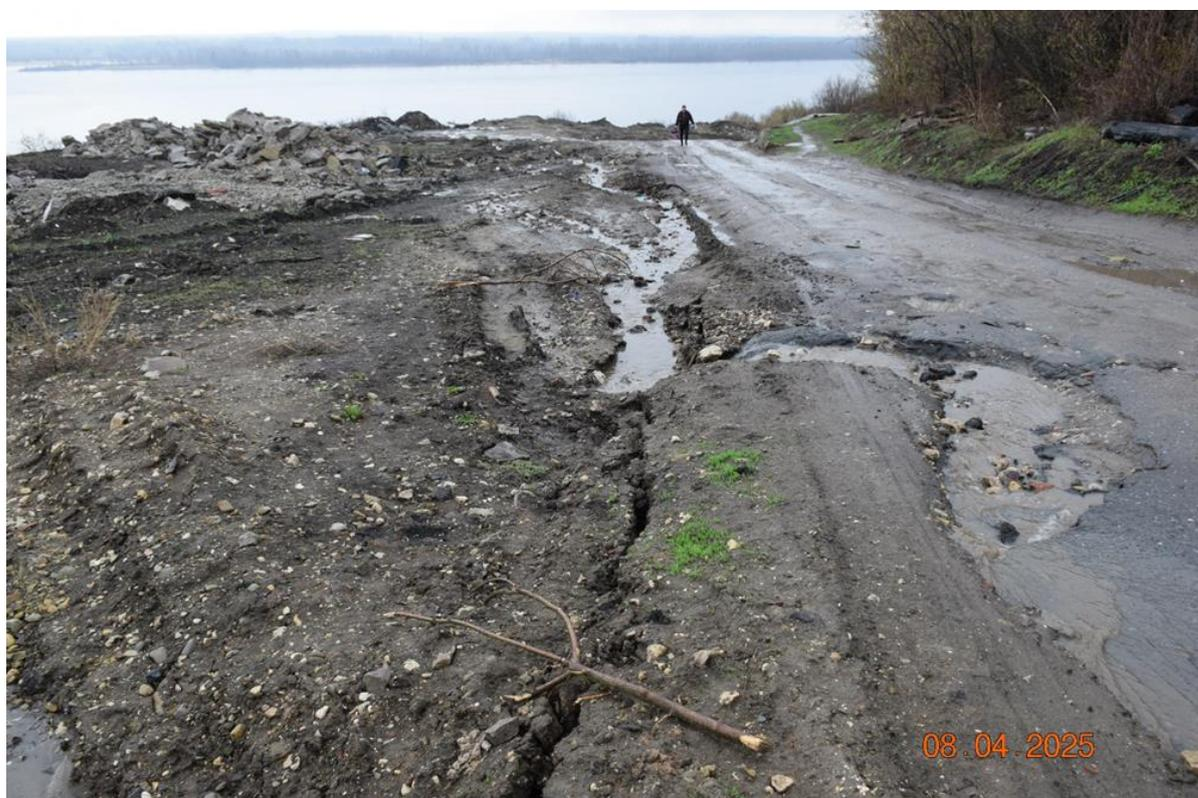
Фото 64-11-00047. Трещины с вертикальным смещением на улице Красноармейской оползень расположен в г. Вольск, Саратовская область
