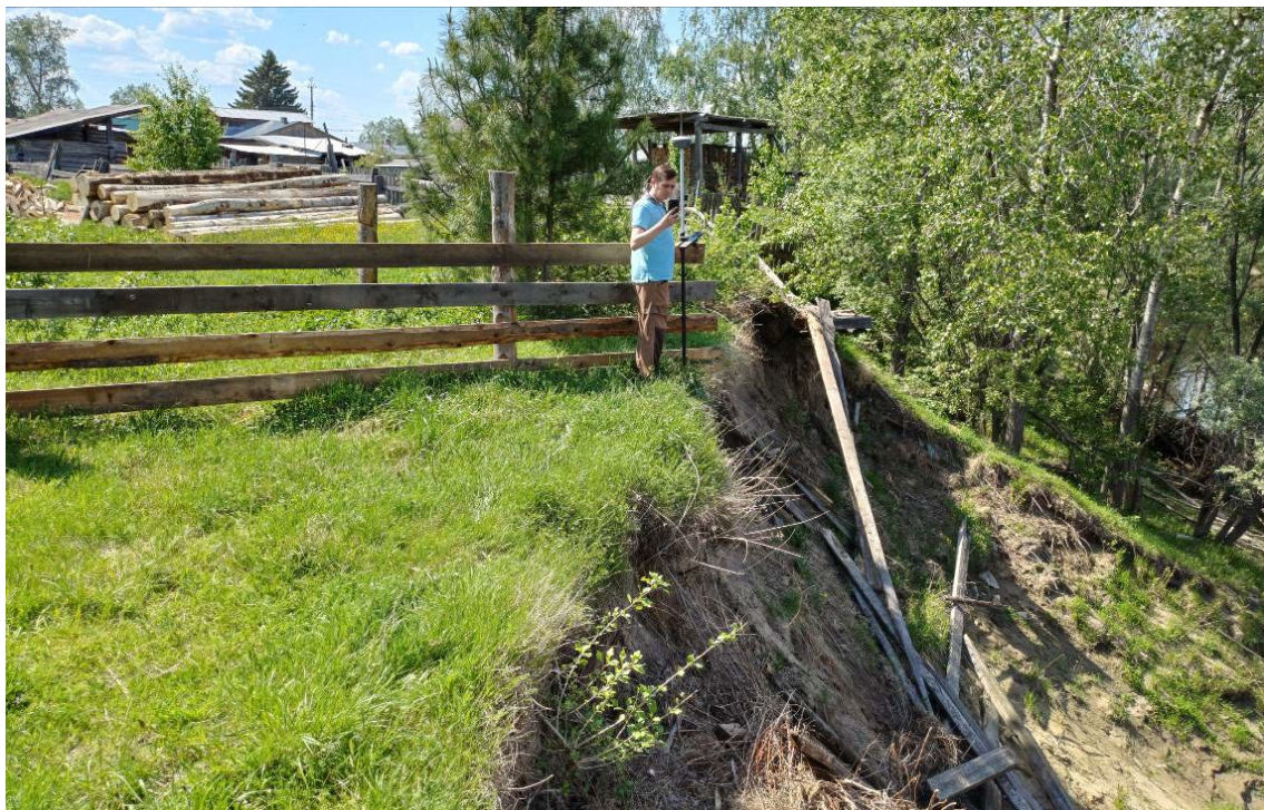
Фото 70-10-00005. Разрушение оползневым процессом приусадебного участка по ул. Лермонтова, 20, с. Подгорное, Чаинский район, Томская область, 02.06.2025
