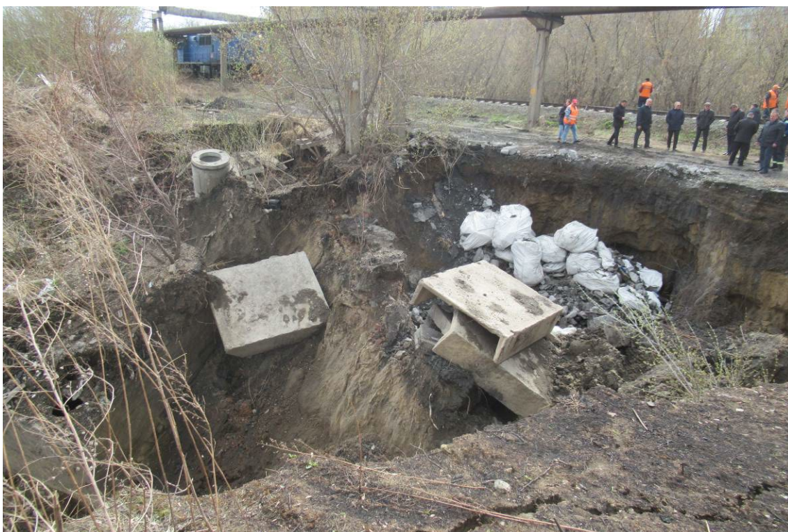
Фото 22-11-00054. Последствия схода оползня на участке ул. Бриллиантовая, 2, г. Барнаул, Алтайский край, 15.04.2025
