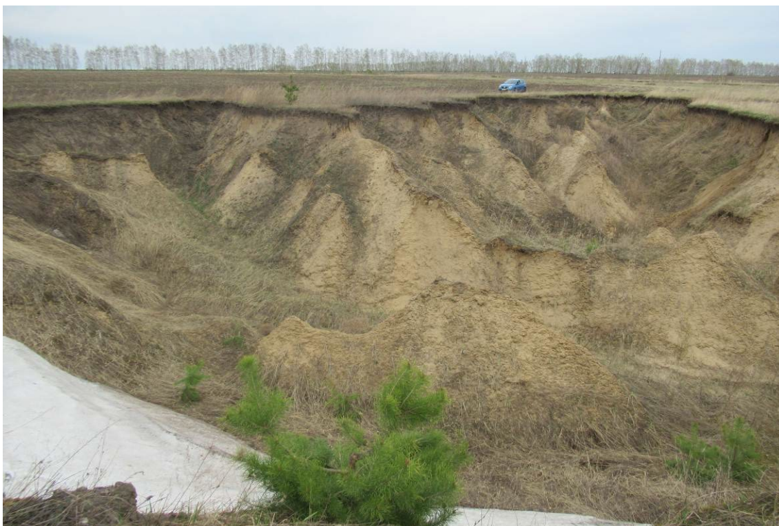
Фото 22-22-00049. Овраг № 2 в окрестностях с. Батурово, Шелаболихинский район, Алтайский край, 27.04.2025
