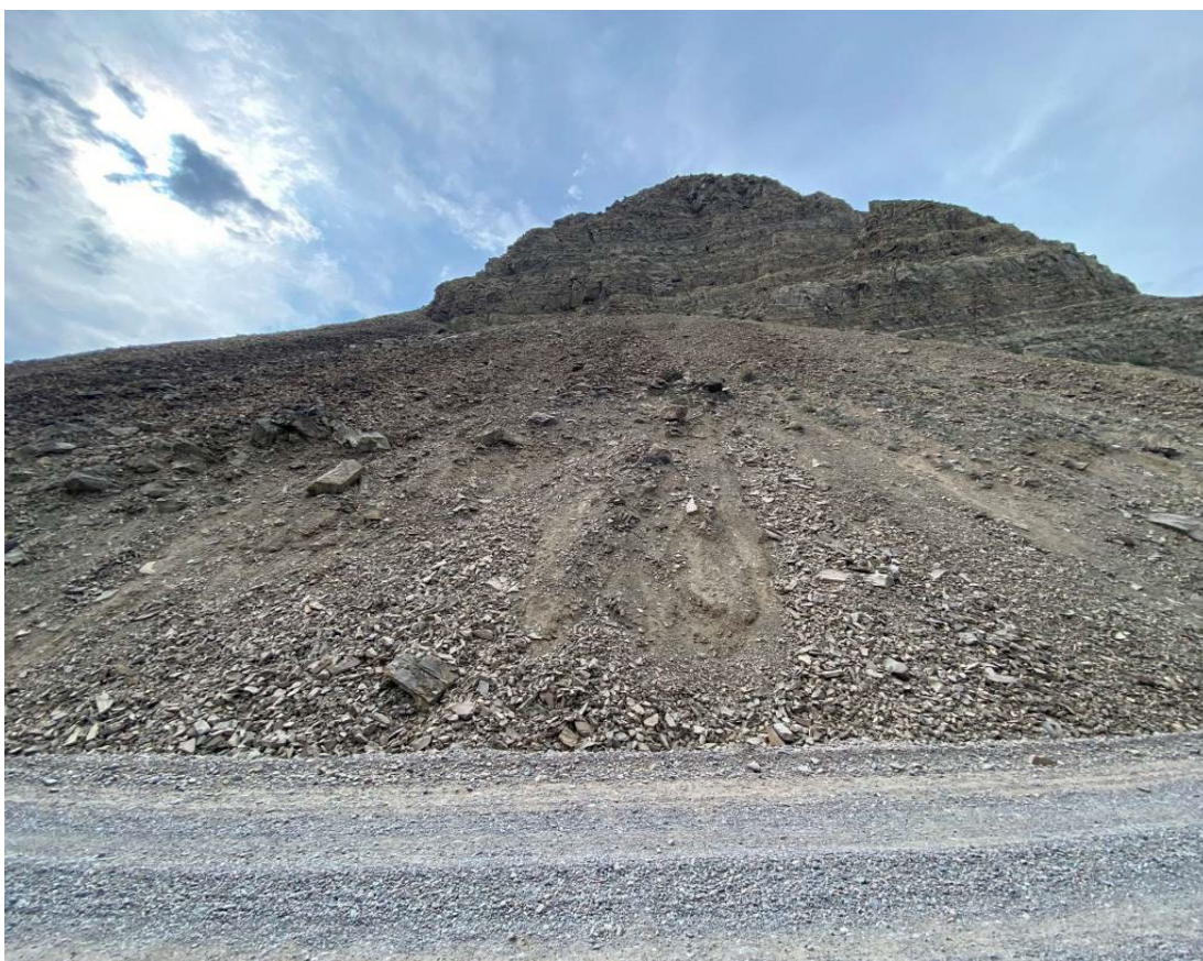
Фото 17-12-00002. Осыпной склон на уч. а/дороги Кызыл – Баян-Кол, 23-24 км, Кызылский район, Республика Тыва, 15.06.2025
