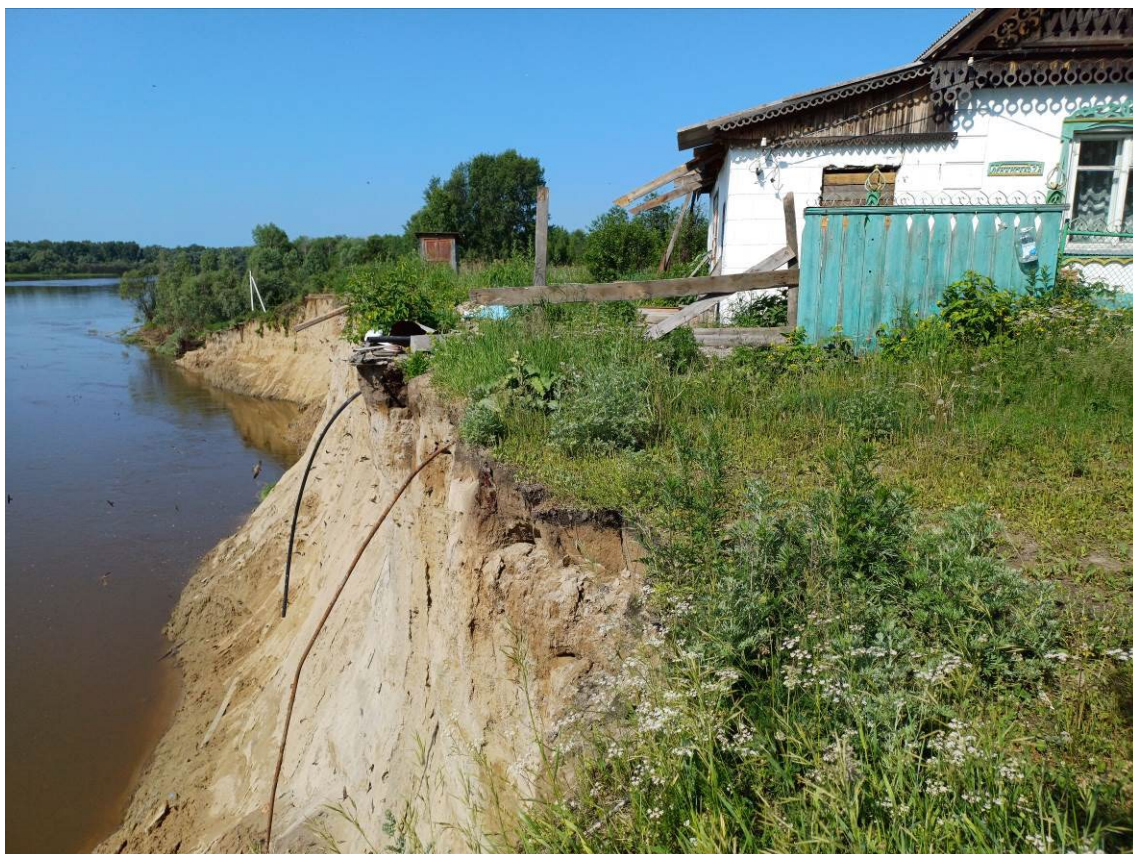
Фото 70-10-00006. Разрушение жилых домов в с. Первомайское, Первомайский район, Томская область, 18.06.2025
