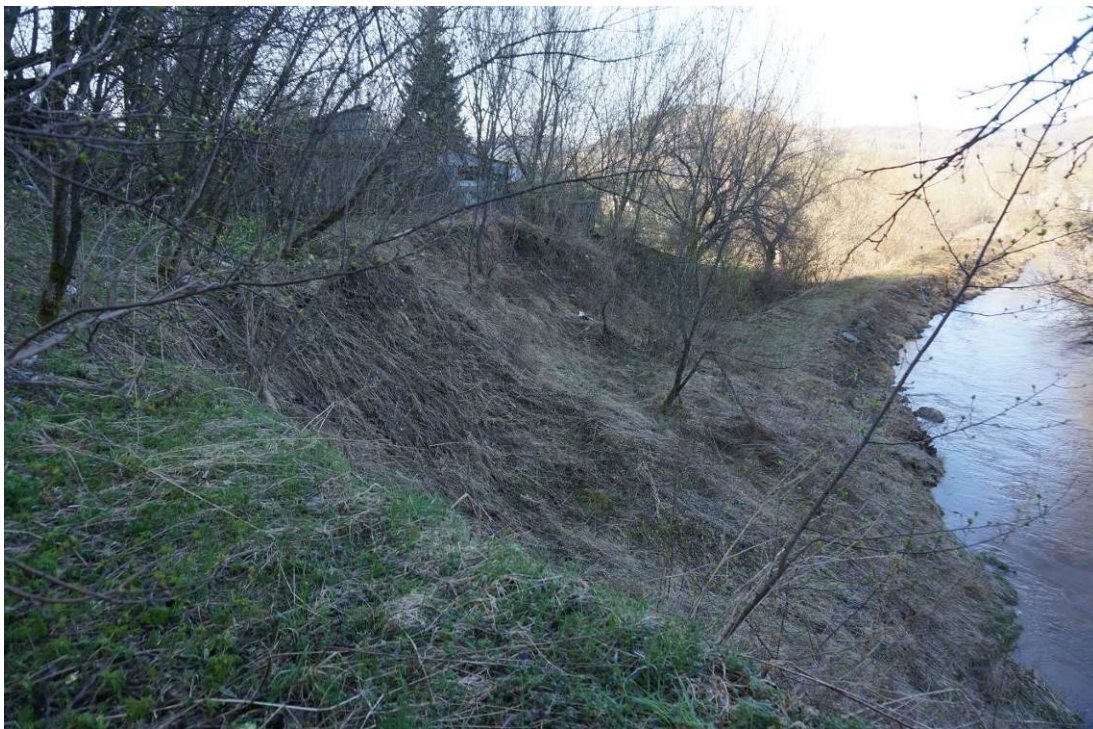
Фото 04-11-00006. Стенка отрыва оползня. На втором плане – усадьба по ул. Советская, 2, с. Кызыл-Озек, Майминский район, Республика Алтай, 22.04.2025
