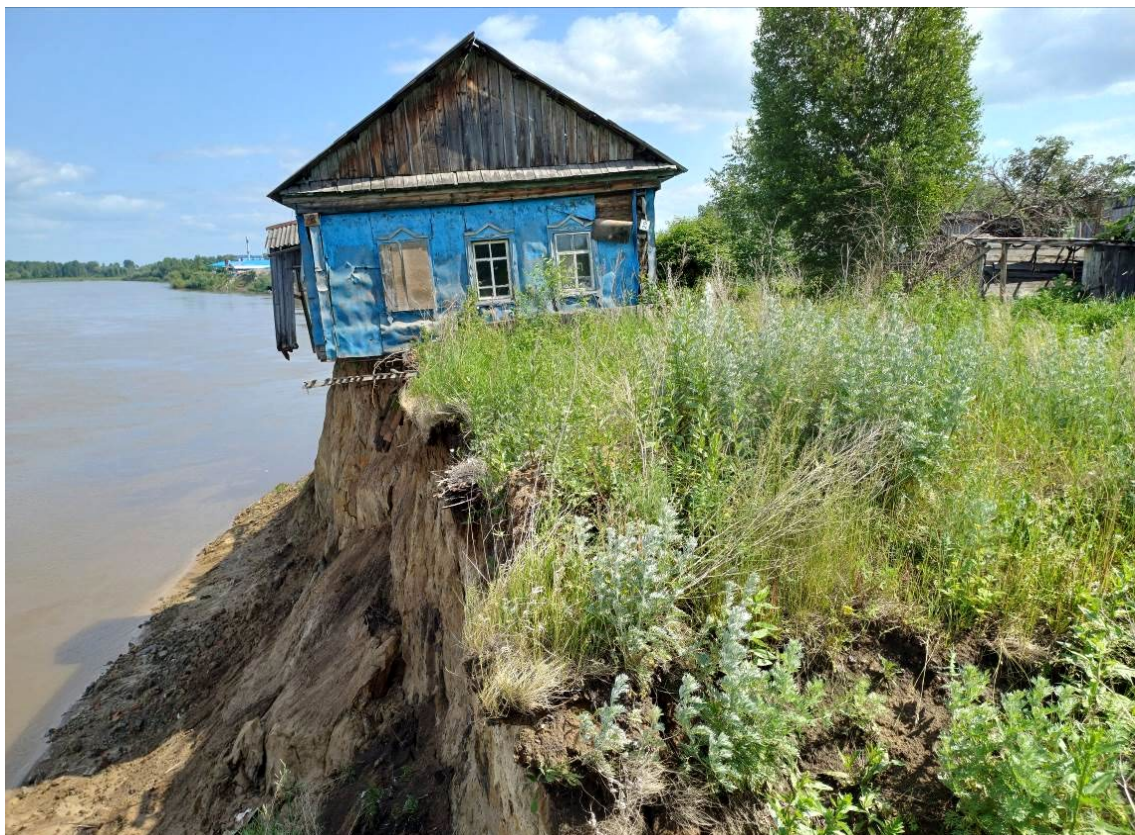
Фото 70-10-00002. Разрушение жилого дома по ул. Дзержинского, 20, с. Зырянское, Зырянский район, Томская область, 16.06.2025
