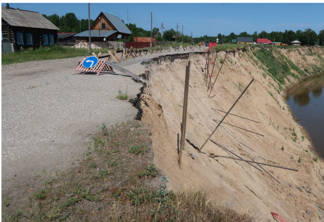
Фото 70-10-00009. Разрушение автодороги и защитного ограждения по ул. Центральная, с. Городок, Первомайский район, Томская область, 18.06.2025
