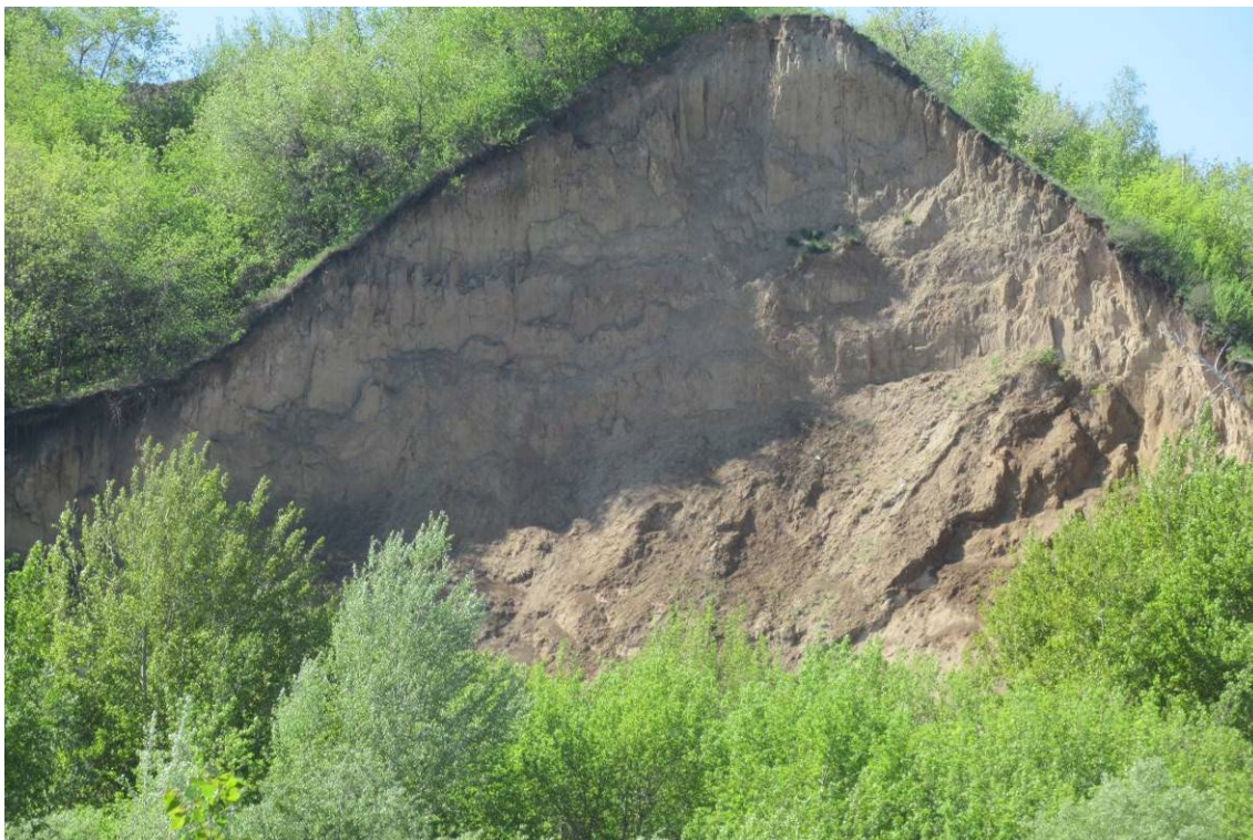
Фото 22-11-00011. Стенка отрыва оползня на участке ул. Квартал 953а, 21-34, г. Барнаул, Алтайский край, 06.05.2025
