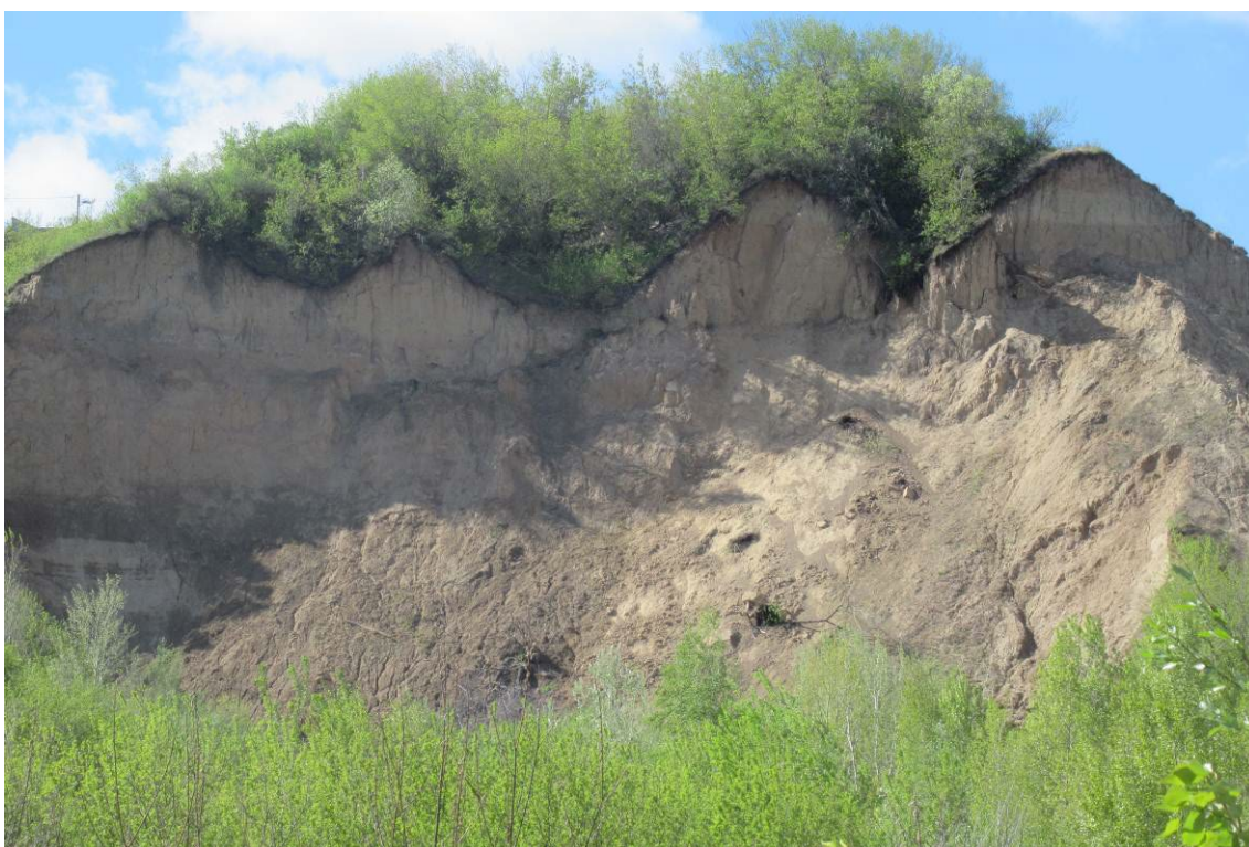
Фото 22-11-00041. Стенка отрыва оползня на участке ул. Квартал 953а, 19, г. Барнаул, Алтайский край, 06.05.2025
