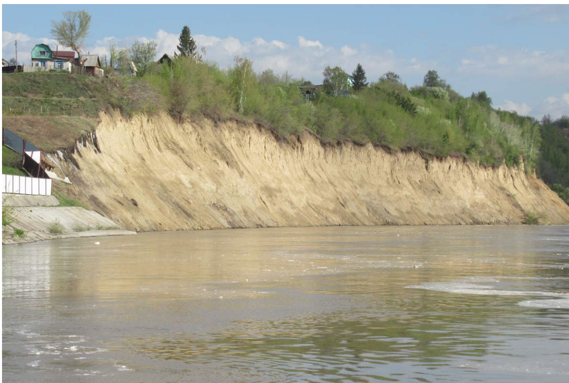
Фото 22-11-00043. Стенка отрыва оползня на левом берегу р. Обь вблизи СНТ «Энергетик», г. Барнаул, Алтайский край, 05.05.2025
