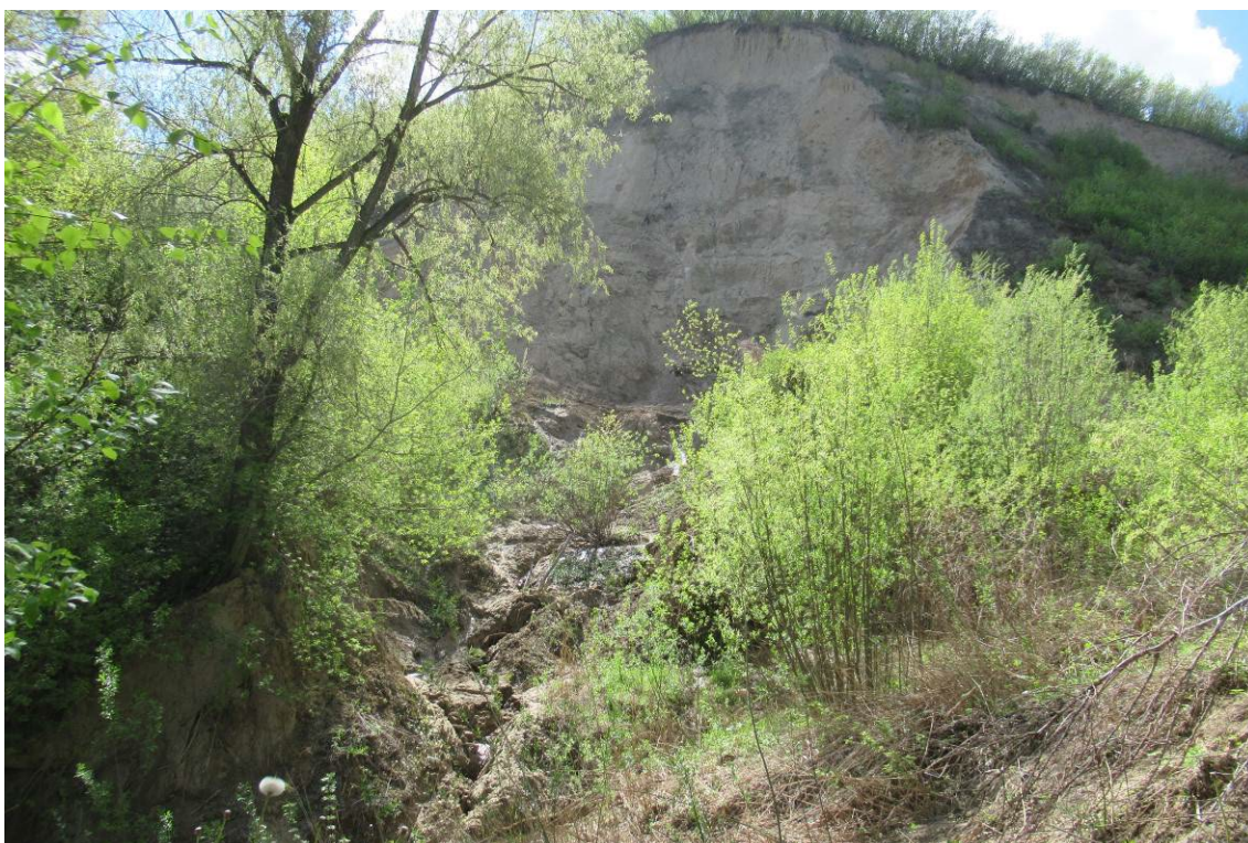
Фото 22-11-00020. Стенка отрыва оползня на участке ул. Квартал 953а, 380, г. Барнаул, Алтайский край, 06.05.2025
