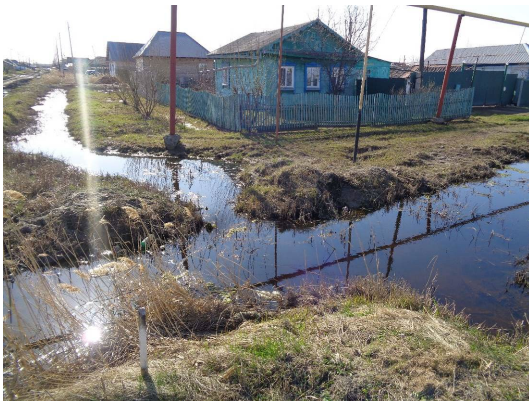
Фото 54-13-00002.б. Магистральный канал по ул. Краснознаменная, г. Татарск, Татарский округ, Новосибирская область, 25.04.2025
