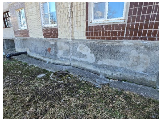
Фото 80. Цементация трещин (а) и маячки (б) просадки грунта по периметру д. 25/8 по ул. Ленина, по состоянию на 04.04.2024 г., (в) и (г) – то же, по состоянию на 02.04.2025 г.
