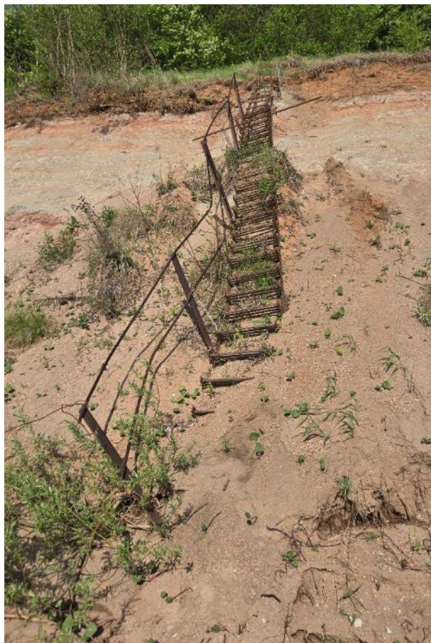
Фото 45, 46. Воздействие оползневого процесса на спусковую лестницу у ж/д ст. Заовражье, 04.10.2024 г. (слева), 27.05.2025 г. (справа).
