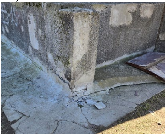
Фото 80. Цементация трещин (а) и маячки (б) просадки грунта по периметру д. 25/8 по ул. Ленина, по состоянию на 04.04.2024 г., (в) и (г) – то же, по состоянию на 02.04.2025 г.
