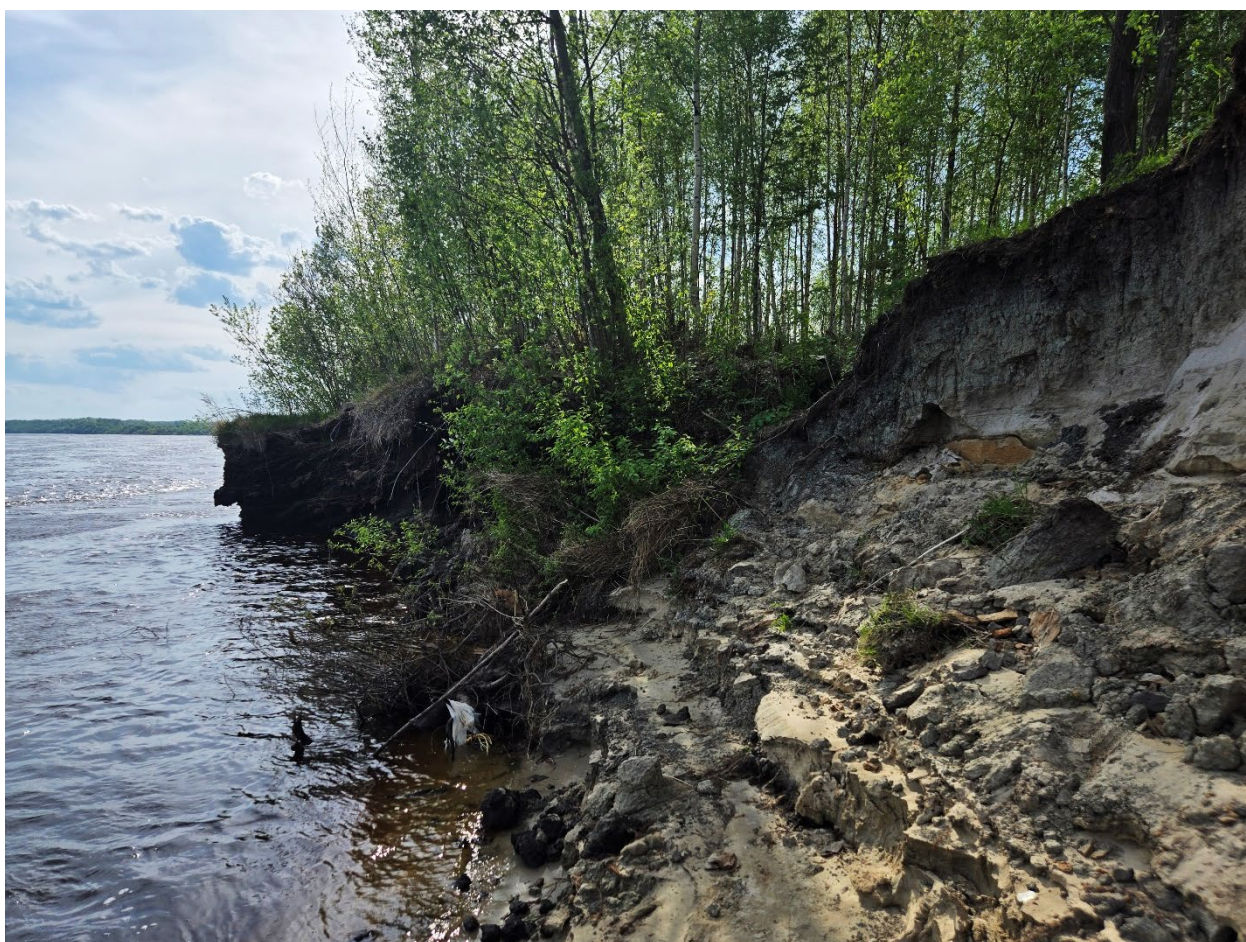
Фото 36, 37. Вывалы и нависание торфяных отложений, оползание деревьев с ПРС.
