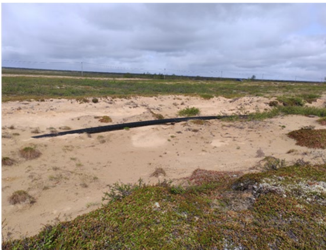
Фото 123. Проявления дефляционного процесса вдоль газопровода Василково -Нарьян-Мар, 17.06.2025 г.
