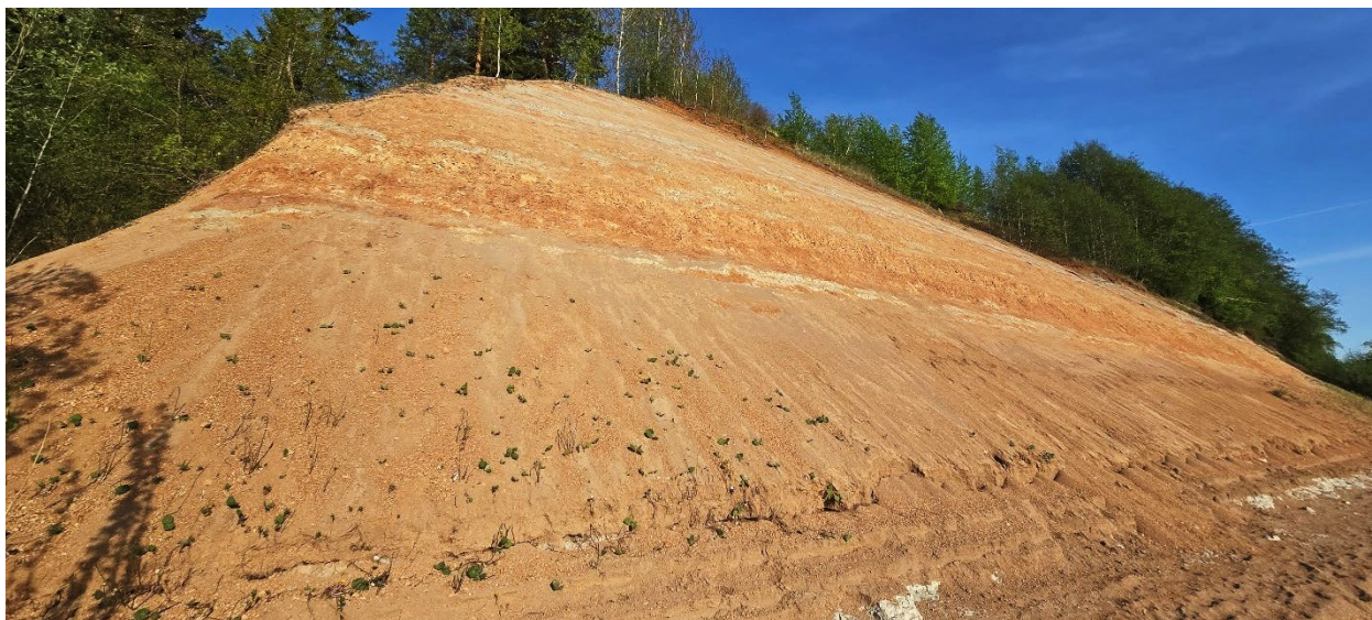
Фото 50. Вид на оползневой склон в деревне южнее ДОКа, ж/д ст. Заовражье.
