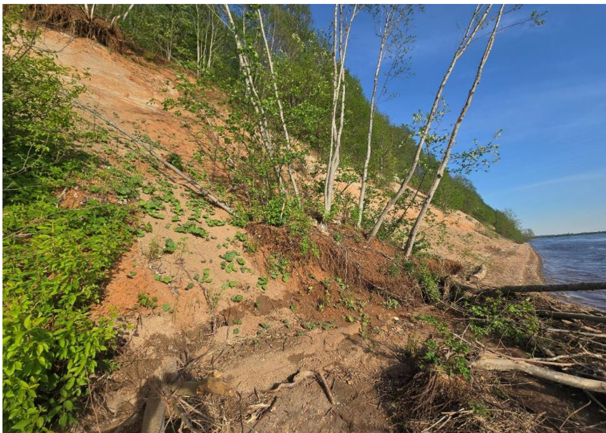
Фото 53. Сползшие деревья у подножья склона
