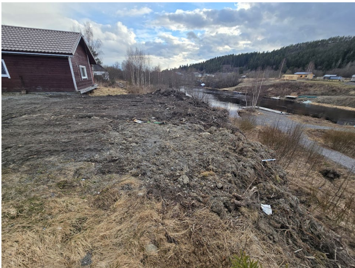
Фото 6. Свежая подсыпка на деформированной части склона, произведённая силами собственника гостиничного комплекса турбазы.
