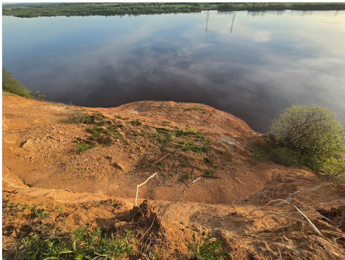
Фото 56. Свежий оползень на береговом склоне ж/д ст. Заовражье, вблизи пер. Строителей.
