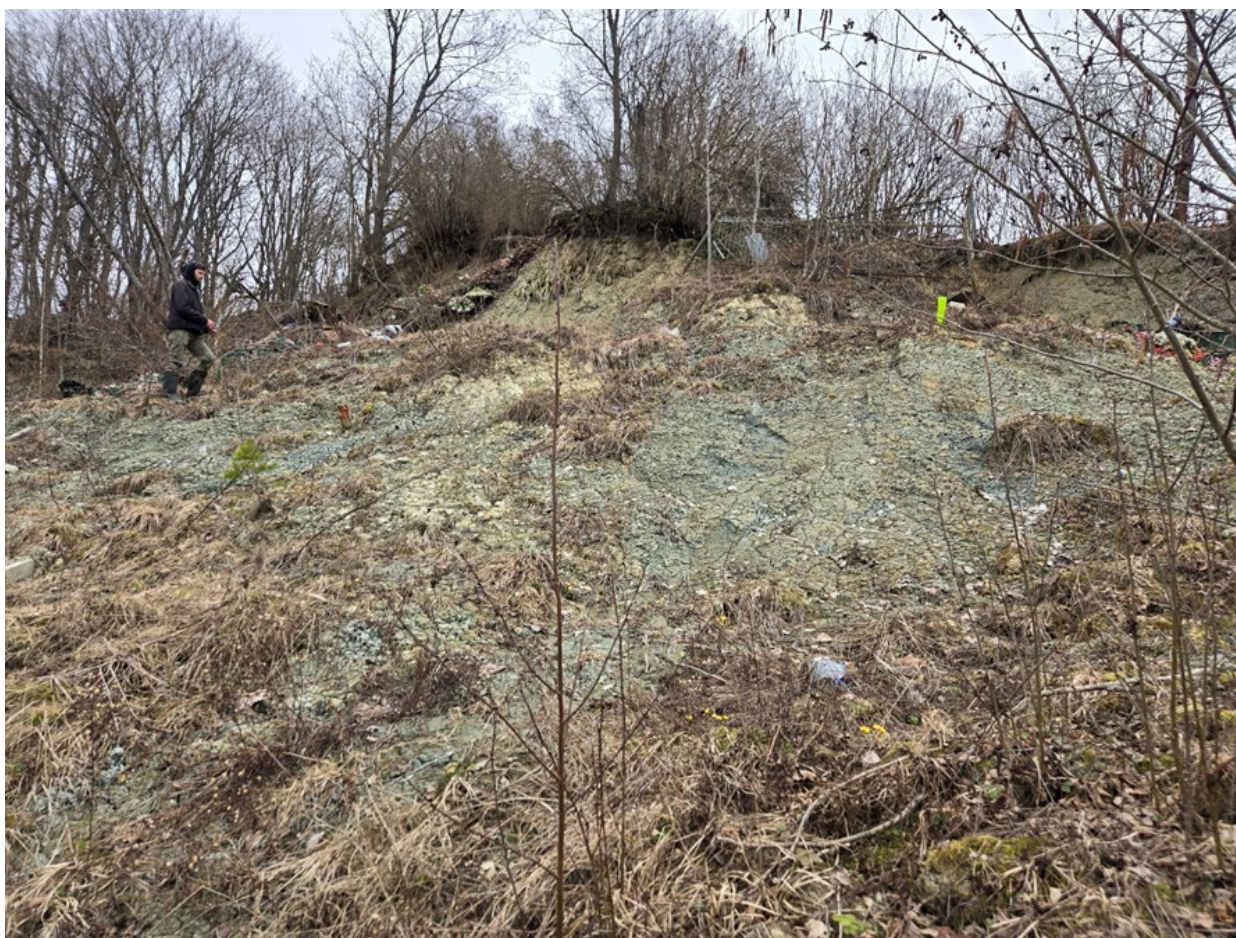
Фото 96. Общий вид на проявление оползневого процесса на правом берегу р. Тосна в пределах Никольского кладбища в г. Никольское Тосненского района Ленинградской области
