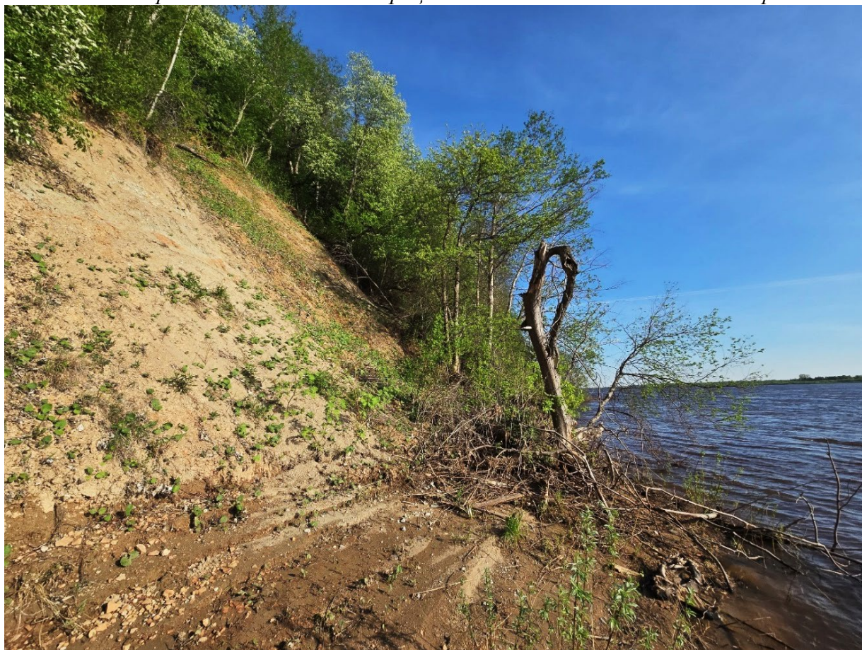
Фото 49. Сползшие деревья у подножья склона вблизи ж/д ст. Заовражье
