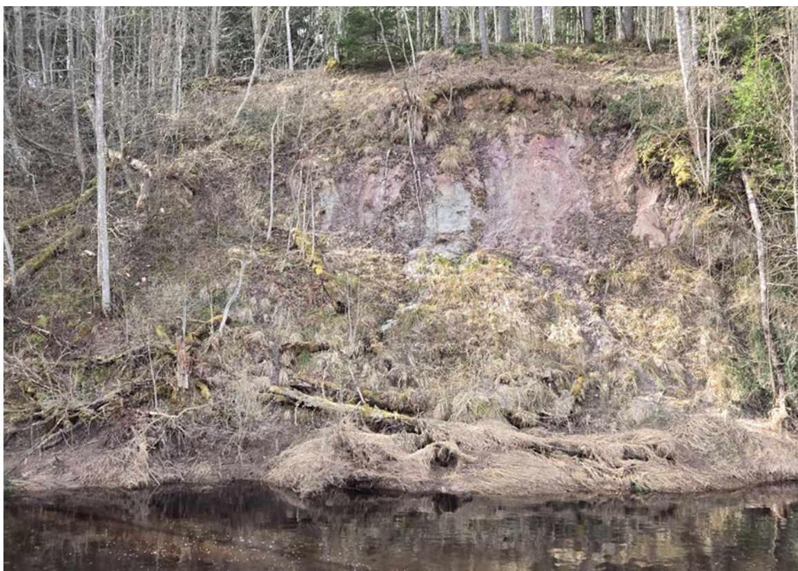
Фото 102. Вид проявления на оползневом склоне левого берега р. Яцера вверх по течению вблизи д. Долговка Лужского района, Ленинградской области
