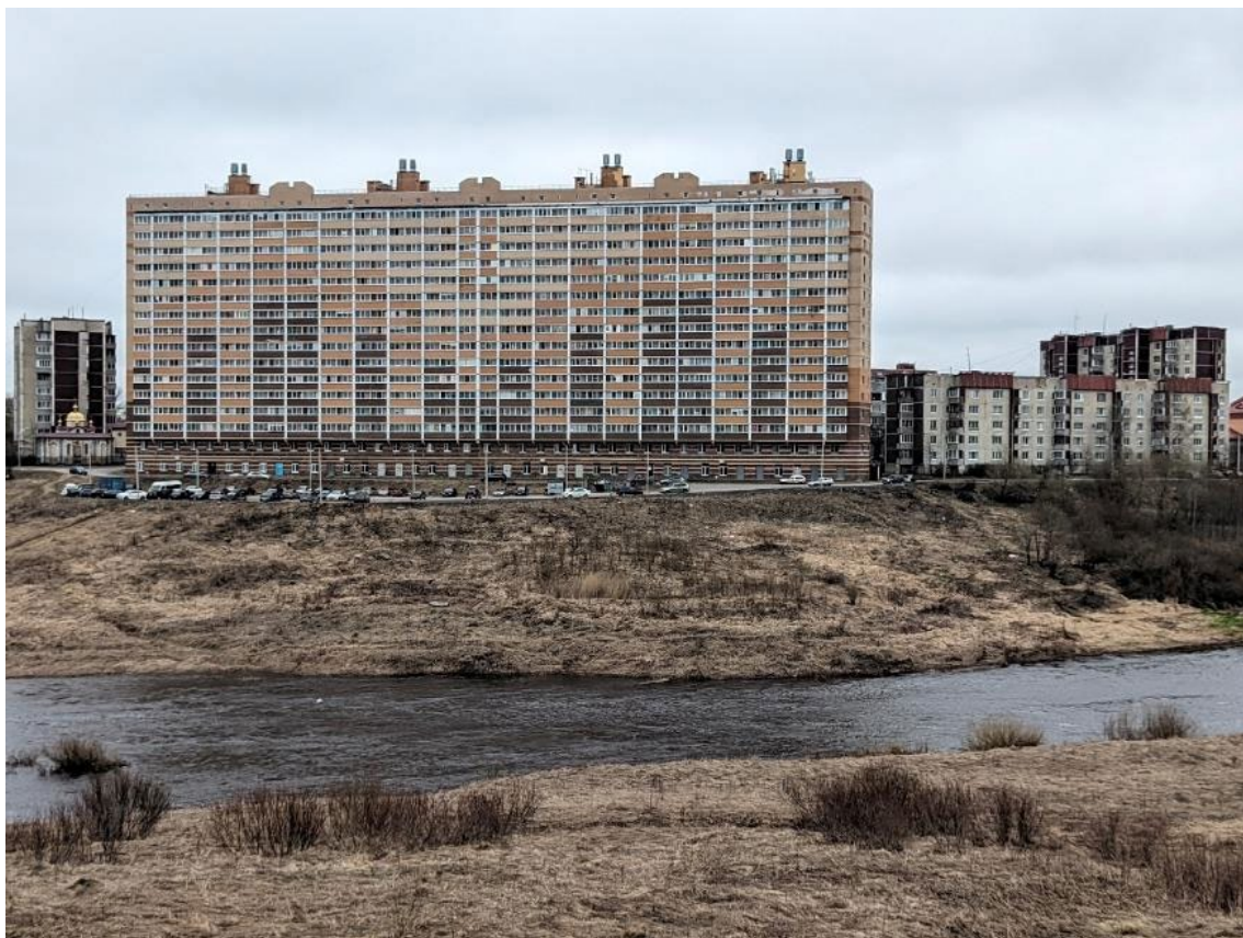
Фото 89. Общий вид на оползневой склон правого берега р. Тосна у д. 16 по ул. Октябрьской в г. Никольское Тосненского района Ленинградской области
