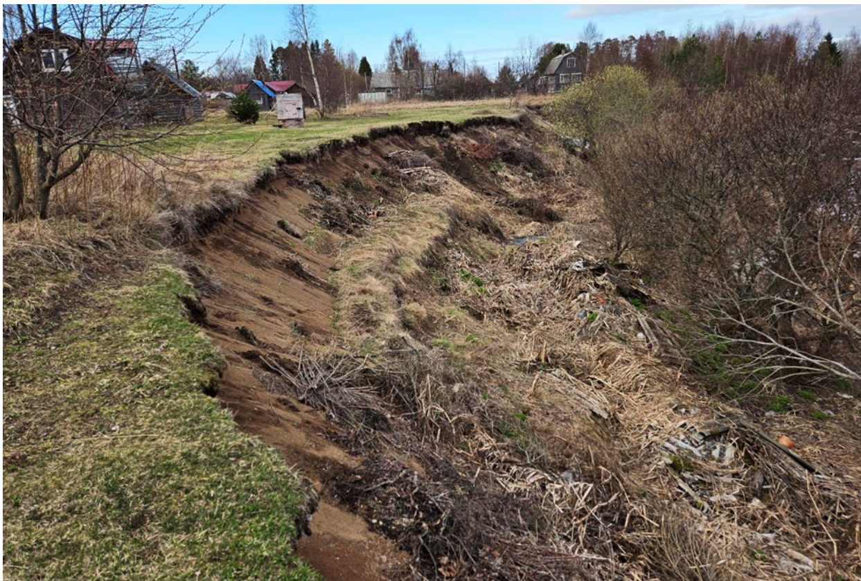
Фото 15. Террасированная часть оползневого склона.
