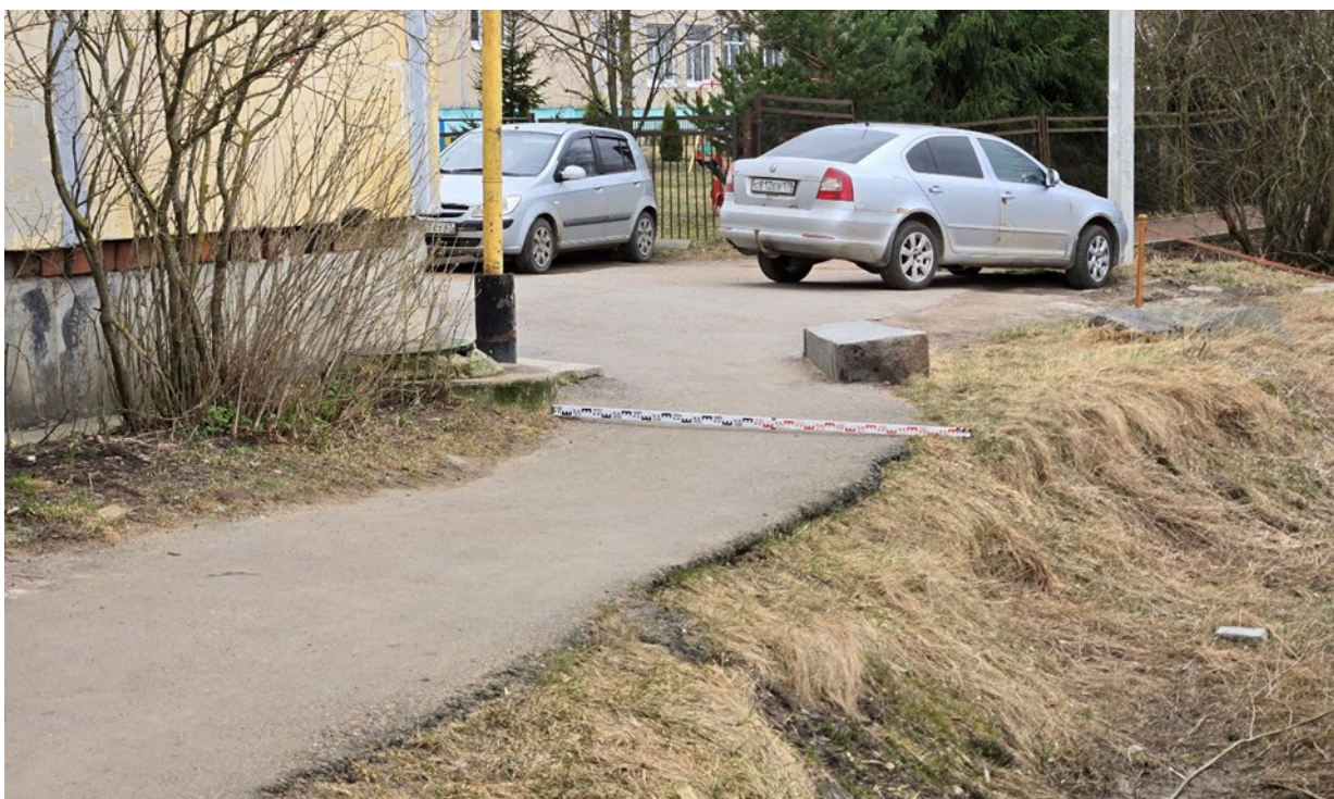
Фото 84. Бровка оползневого склона и восстановленное асфальтное полотно с угловой части д. № 5 в пгт. Войсковоро Тосненского района Ленинградской области
