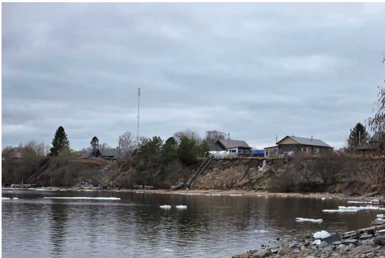
Фото 17. Общий вид проявления на береговом склоне в п. Каскесручей.
