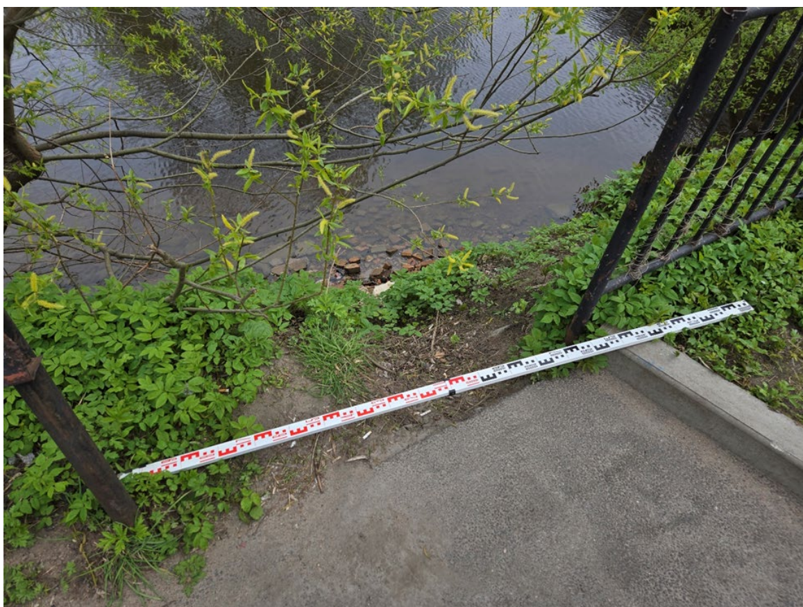
Фото 109. Ограждение парковочной площадки в пределах участка наблюдений в зоне воздействия оползневого процесса на склоне у пешеходного Ново-Андреевского моста в Василеостровском районе г. Санкт-Петербурга
