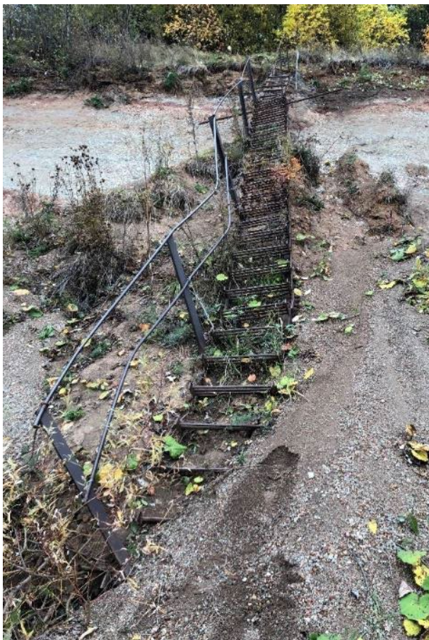
Фото 45, 46. Воздействие оползневого процесса на спусковую лестницу у ж/д ст. Заовражье, 04.10.2024 г. (слева), 27.05.2025 г. (справа).
