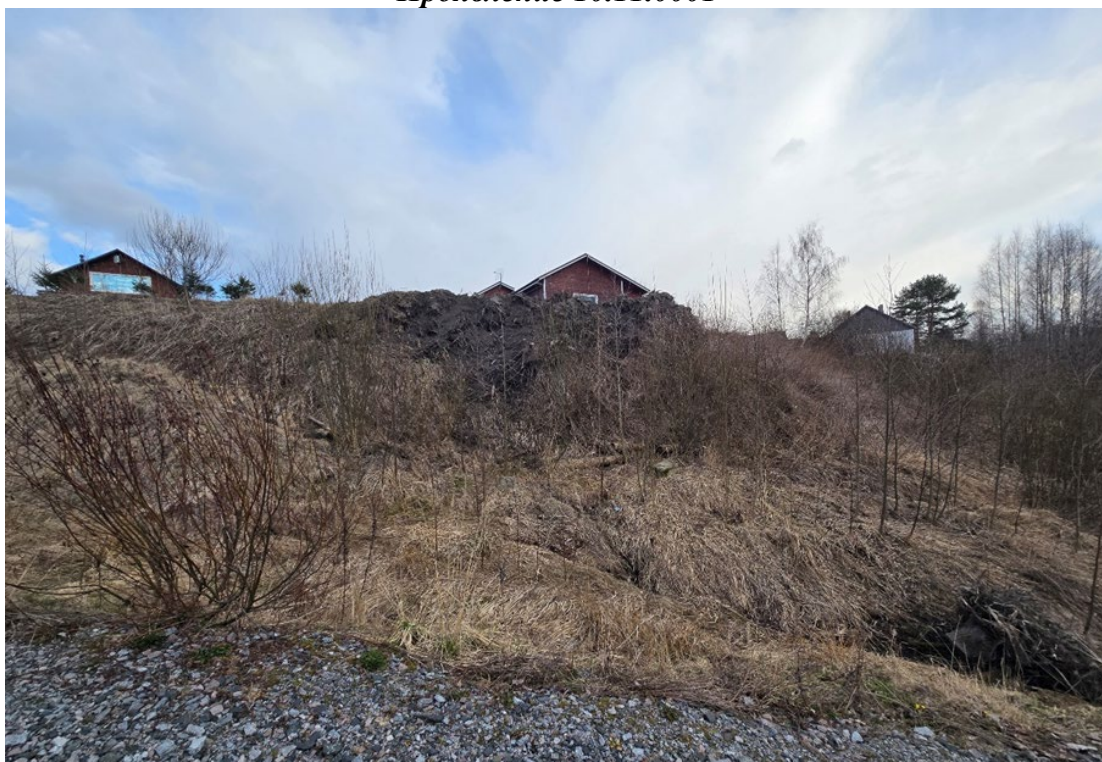
Фото 1. Общий вид на оползневой склон со свежей подсыпкой активной части в п. Хийденсельга
