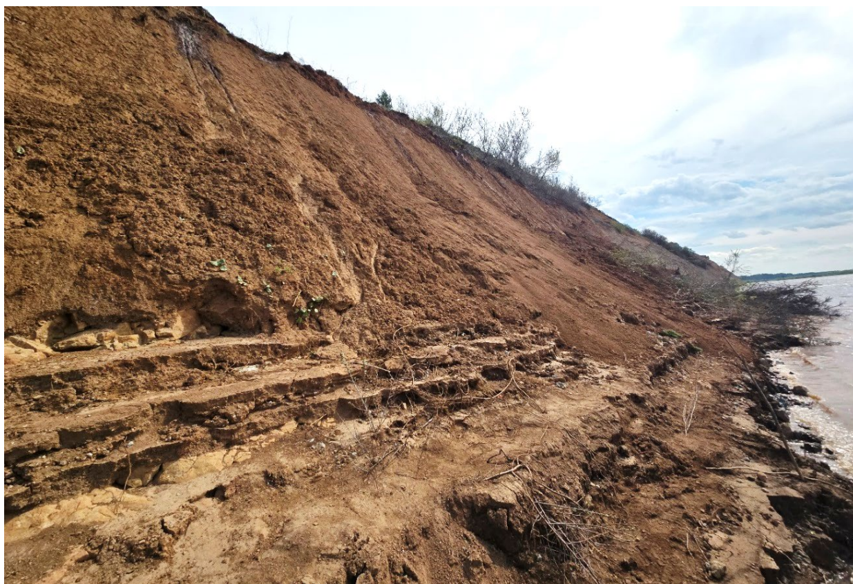
Фото 54. Общій вид берегового склона в д. Заовражъе
