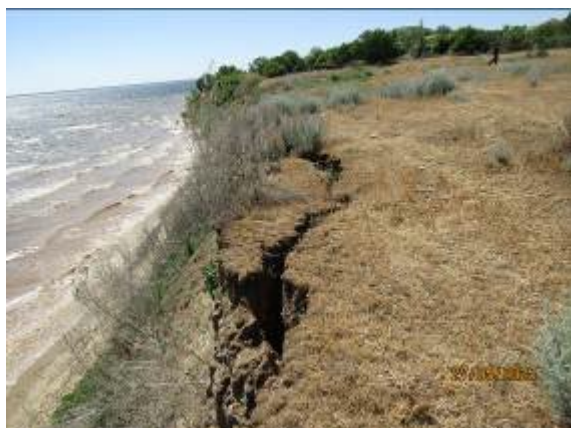
Фото 34-10-00014. Обвальный берег напротив северной части ст-цы Суводской Дубовского района. с- трещинами закола, по которым происходит отделения блоков пород. (Фото филиала ЮРЦ ГМСН ФГБУ «Гидроспецгеология»)
