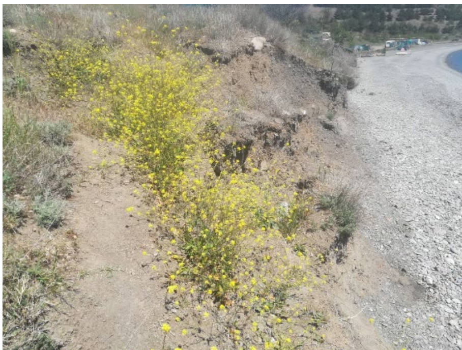
Фото 12. Проявление 91-10-05801. Стенка срыва по верхнему заколу в западном замыкании оползня.
