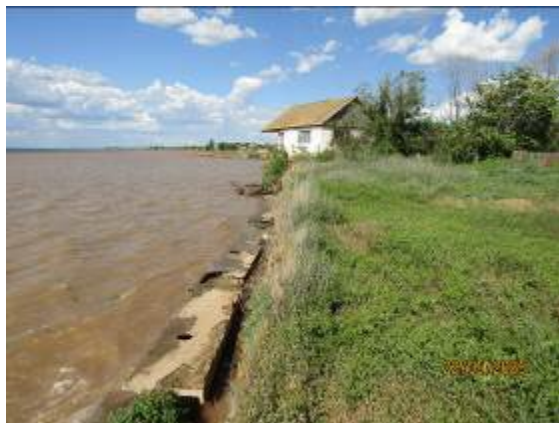
Фото 34-10-00006. Обвальный берег напротив средней части с. Кислово. Быковского района. Берег укреплен защитными бетонными блоками. В зоне потенциального воздействия находится нежилой дом.
