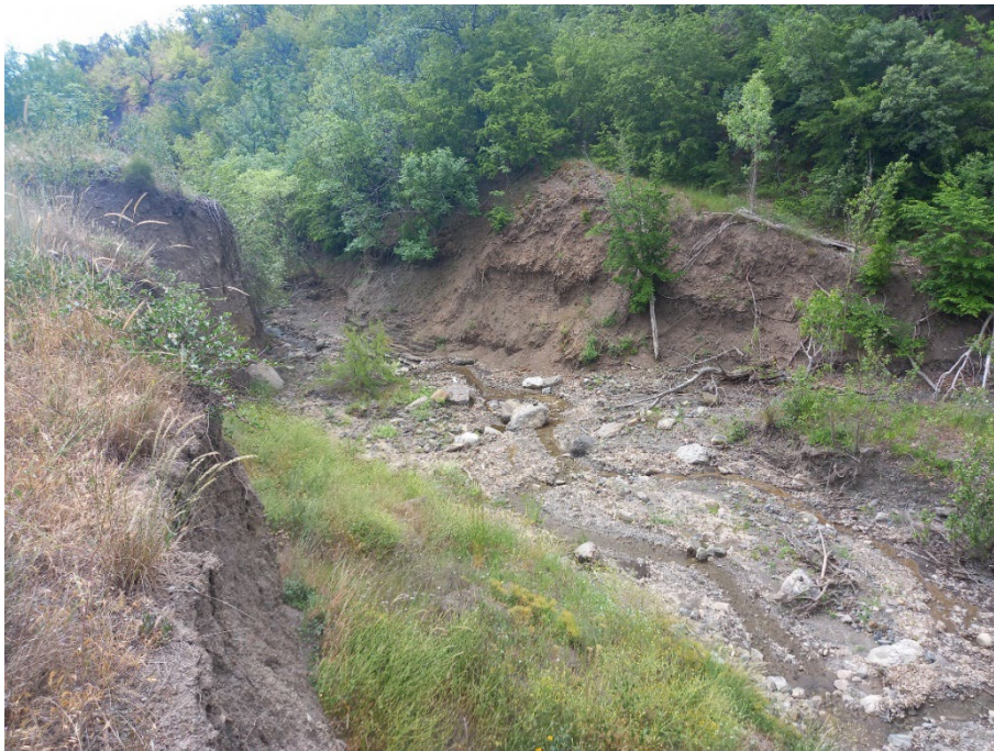
Фото 11. Проявление 91-11-05302. Оползень № 820, языковая часть, левый борт, вид на долину р. Тапшан- Гя.
