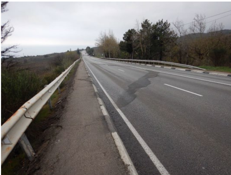
Фото 5. Проявление 91-11-02213. Деформации асфальтового покрытия Южнобережного шоссе в районе левого борта головной части оползня № 423
