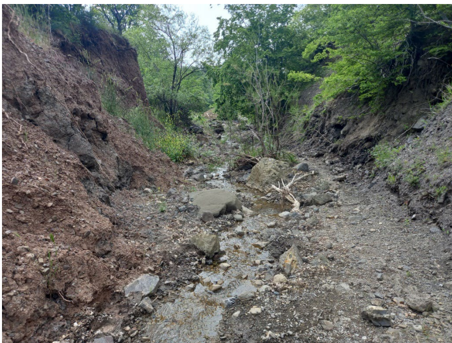
Фото 10. Проявление 91-11-05301. Оползень № 816, языковая часть, правый борт, русло р. Тапшан-Гя. Контакт флишевых пород с оползневыми отложениями.
