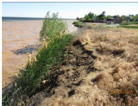
Фото 34-10-00018. Обвальный вдоль берегового уступа южнее залива г. Дубовка Дубовского района.
