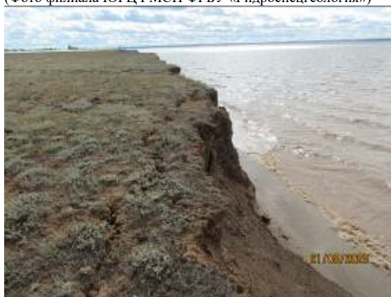
Фото 34-10-00026. Обвальный берег напротив с. Верхнепогромное Среднеахтубинского района. Наблюдаются трещины закола вдоль берегового уступа.
