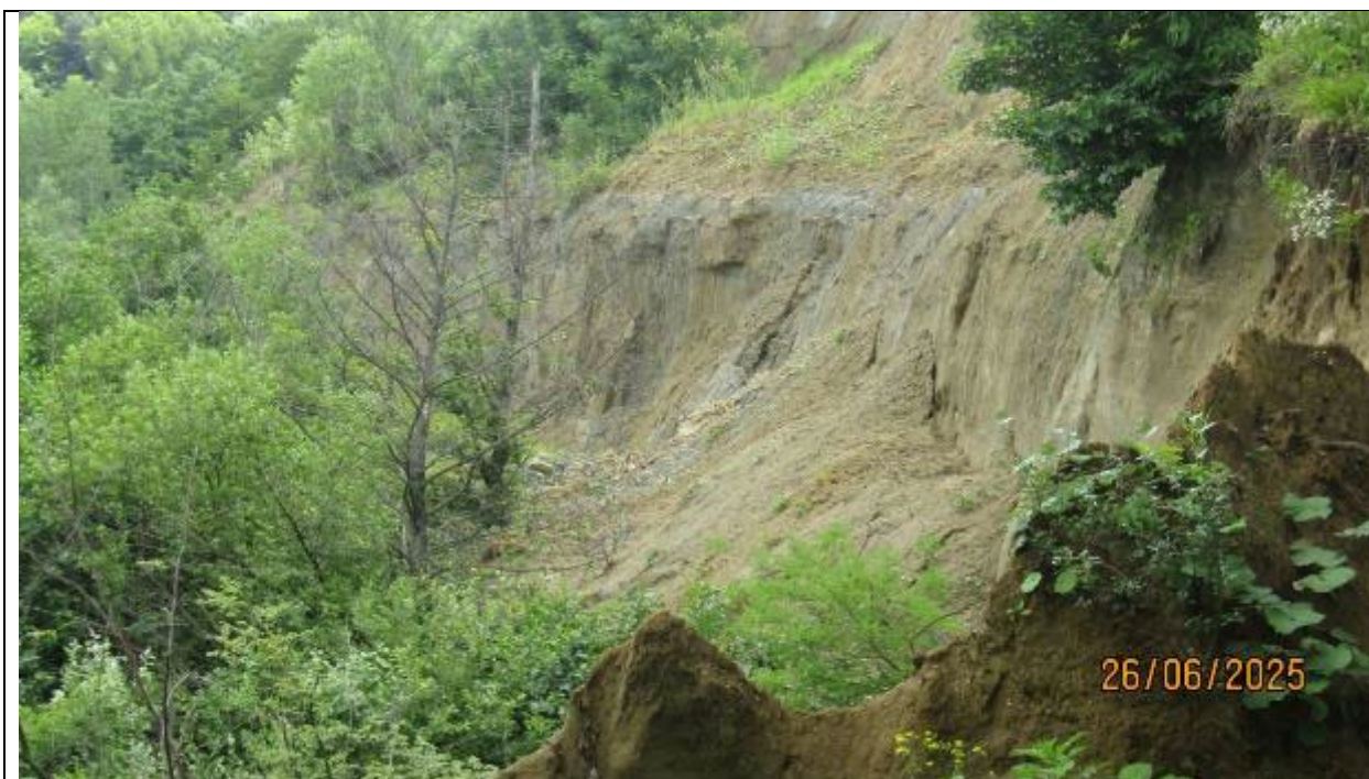
Фото 01-11-00001. Активизация оползневой процесса на Краснооктябрьском оползне. Юго-западная окраина г. Майкоп, в 2 км к северу от пос. Краснооктябрьский. Фото ЮРЦ ГМСН «Гидроспецгеология»
