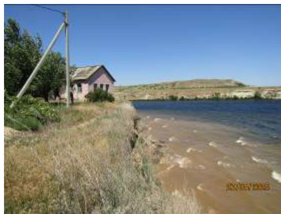
Фото 34-10-00015. Обвальное проявление вдоль берегового уступа в с. Горноводяное Дубовского района. В зоне потенциального воздействия находятся нежилые дома по улице Набережной. (Фото филиала ЮРЦ ГМСН ФГБУ «Гидроспецгеология»)
