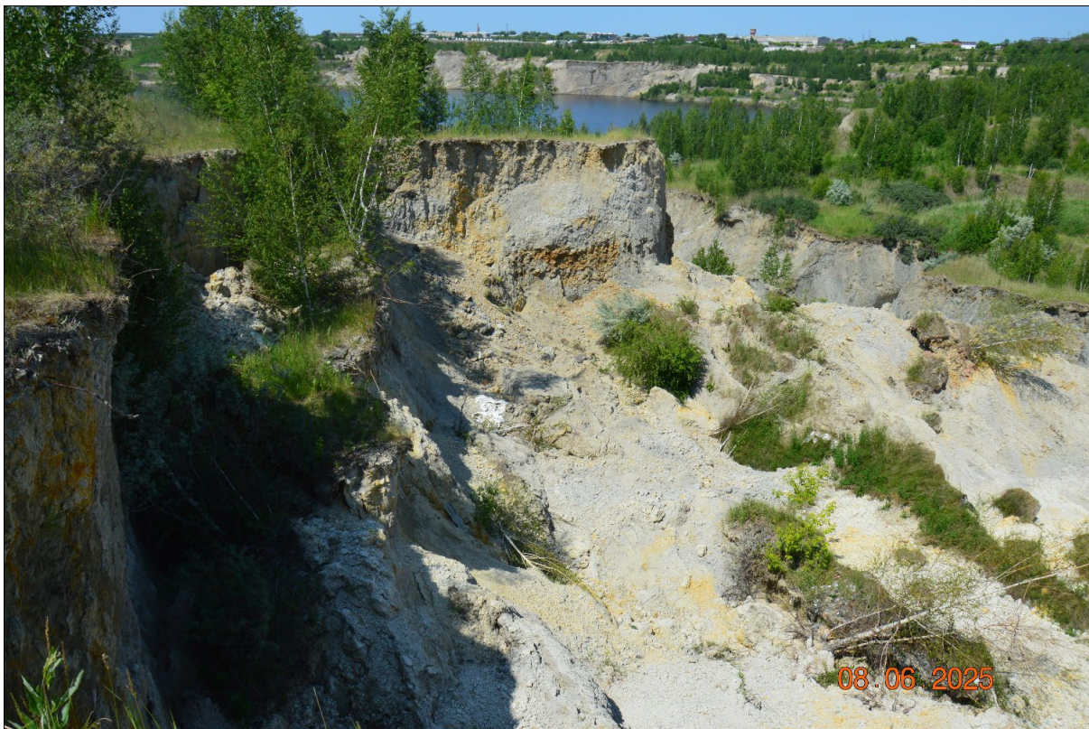
Фото 74-22-00023. Активное оползание и разрушение по левому борту в устье оврага в ТН 4. Еманжелинский ПН, Еманжелинский МР, Челябинская область
