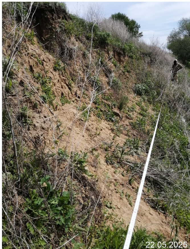
Фото 45-2025-01-001-1. Осыпной участок на северном берегу оз. Жидки, протяженностью 15 м. Высота бровки от уреза воды 6 м. Участок Жидкинский, Петуховский район, Курганская область
