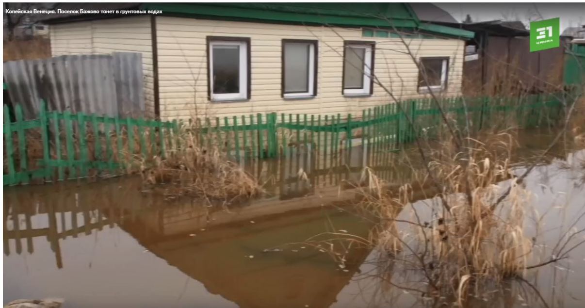
Фото 74-2025-22-05. Подтопление пос. Бажова в г. Копейске Челябинской области
