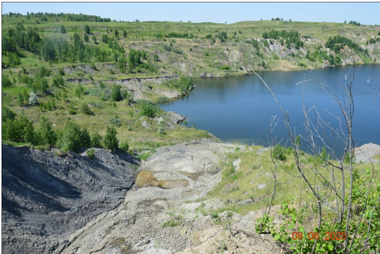
Фото 74-11-00059. Оползень-поток № 2в районе п. Батуринский в ТН 11. Участок Еманжелинский Челябинской области
