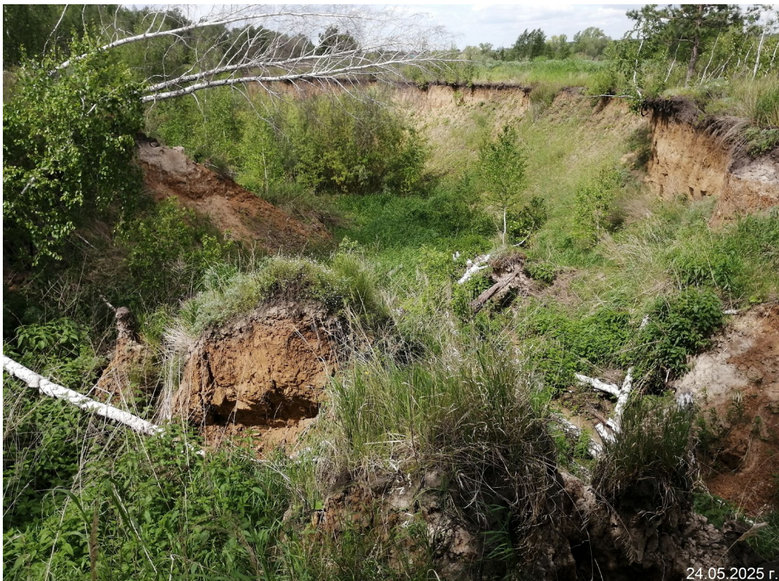
Фото 45-22-00006. Активный откос II порядка на Раскатихинском овраге. Раскатихинский участок, Притобольный район, Курганская область
