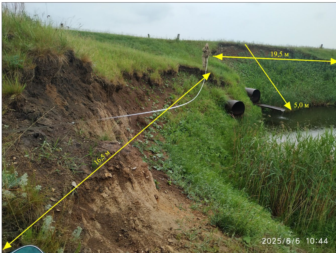
Фото 74-2025-01-001-2. Гравитационные процессы на дамбе и рядом с ней в ТН 2. Чесменский плановый участок, Челябинская область
