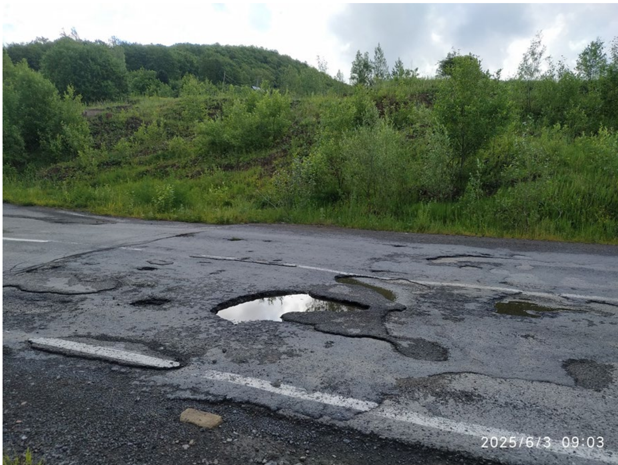
Фото 74-11-00048. Разрушение оползневым процессом асфальтового покрытия автодороги на горнолыжный комплекс Аджигардак. Участок Ашинский, г. Аша, Челябинская область
