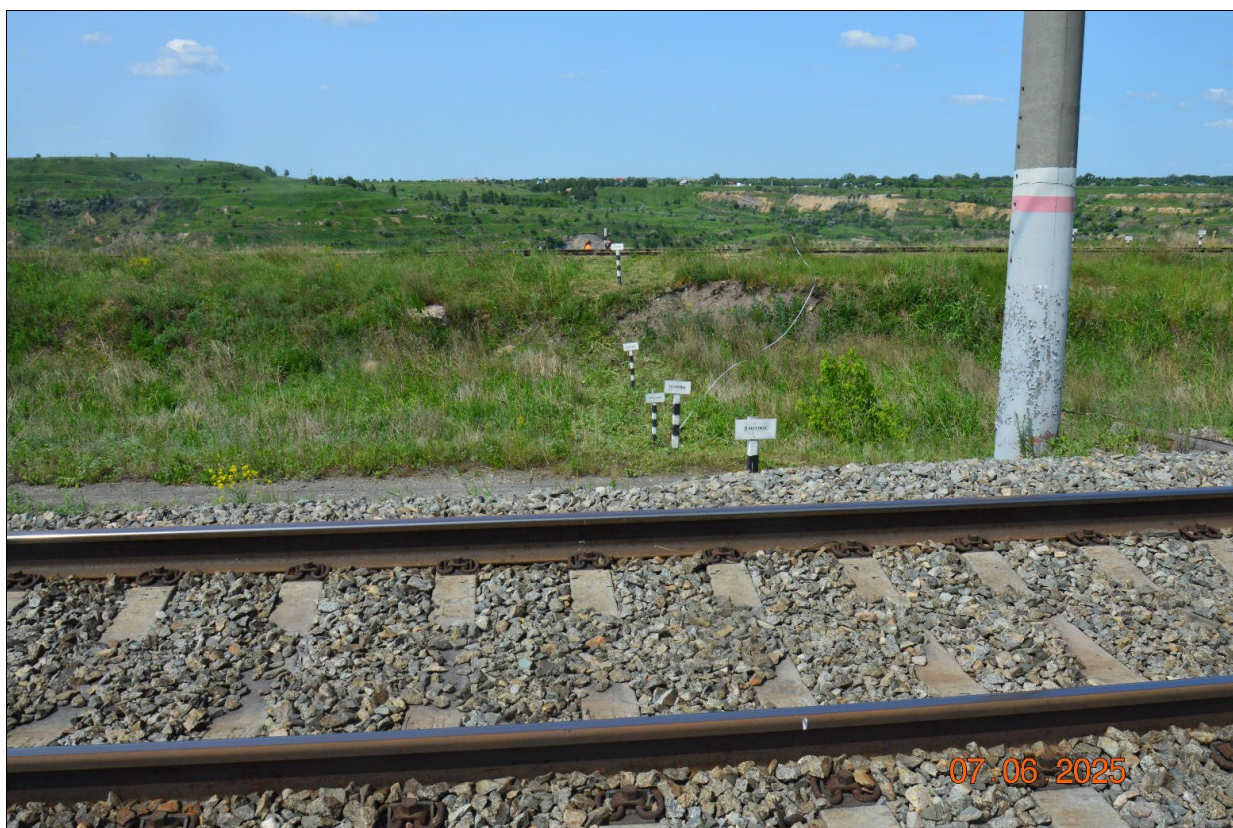
Фото 74-11-00172. Таблички с расстояниями до основного железнодорожного пути. Мониторинговые наблюдения выполняются эксплуатационной службой ЮУЖД. Красногорский пункт наблюдений, ТН 2. Челябинская область
