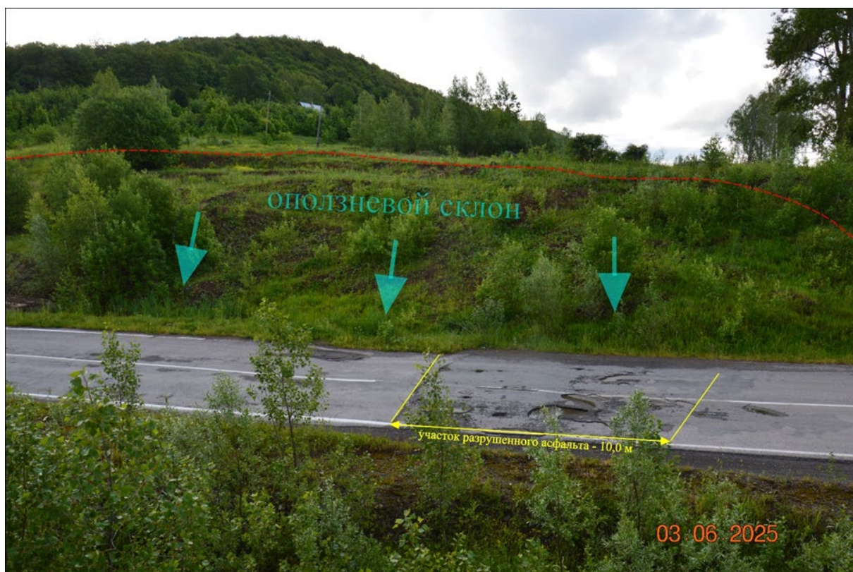
Фото 74-11-00048. Техногенный оползень по автодороге на горнолыжный комплекс Аджигардак. Участок Ашинский, г. Аша, Челябинская область
