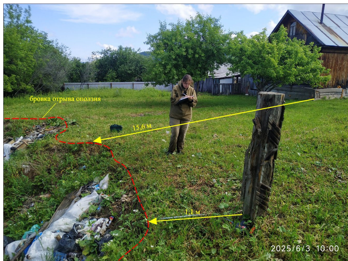
Фото 74-11-00049. Положение бровки отрыва оползня в ТН 4 в районе дома № 30 по ул. Набережная. Участок Ашинский Челябинская область
