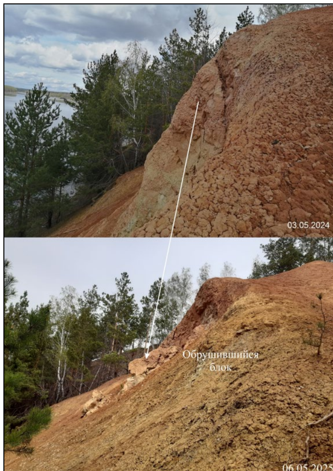
Фото 66-11-00289. Оползень на Каменском участке, северная стенка срыва. Свердловская область
