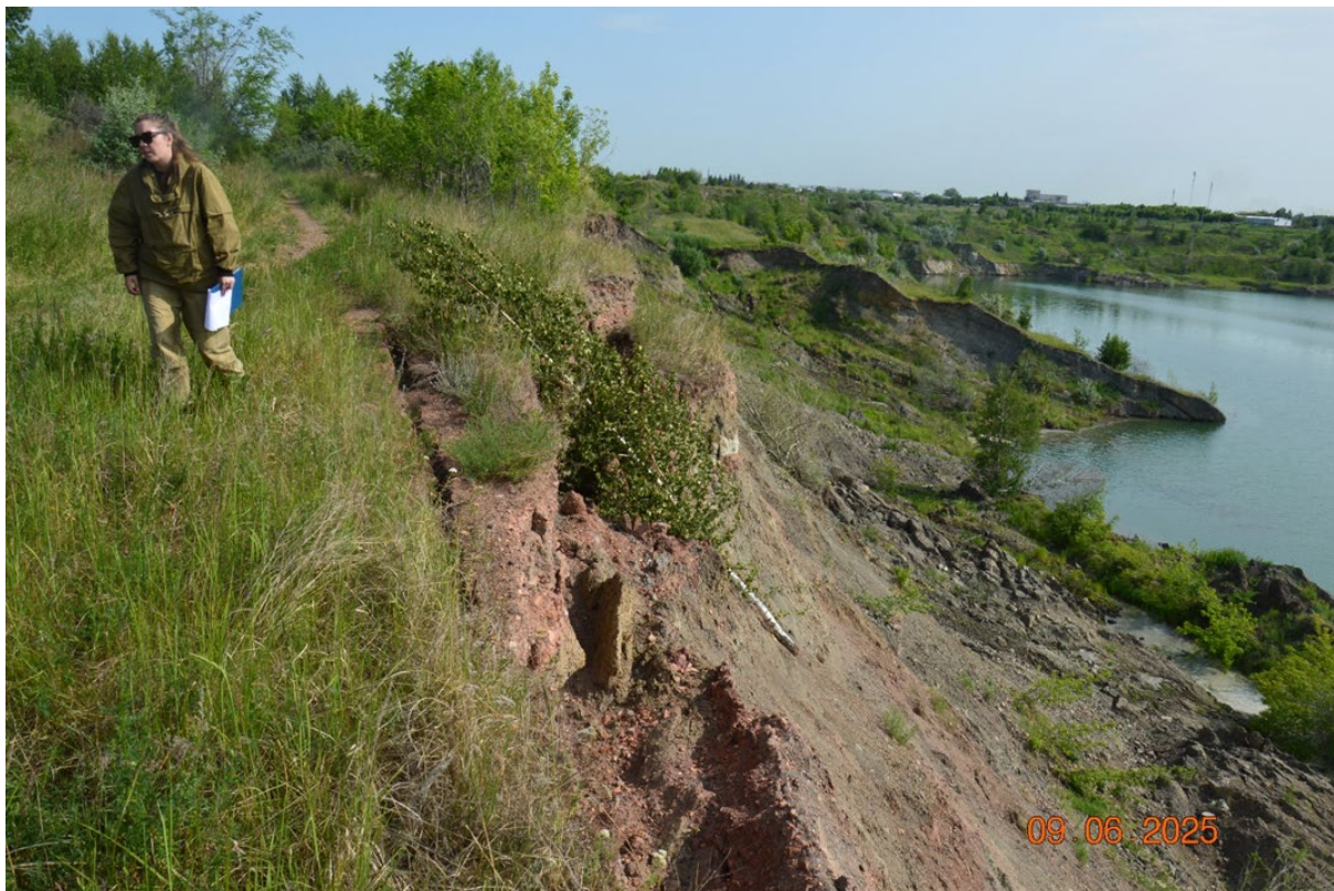
Фото 74-11-00067. Оползание борта Копейского разреза в ТН 12. Копейский участок оперативного обследования, г. Копейск, Челябинская область
