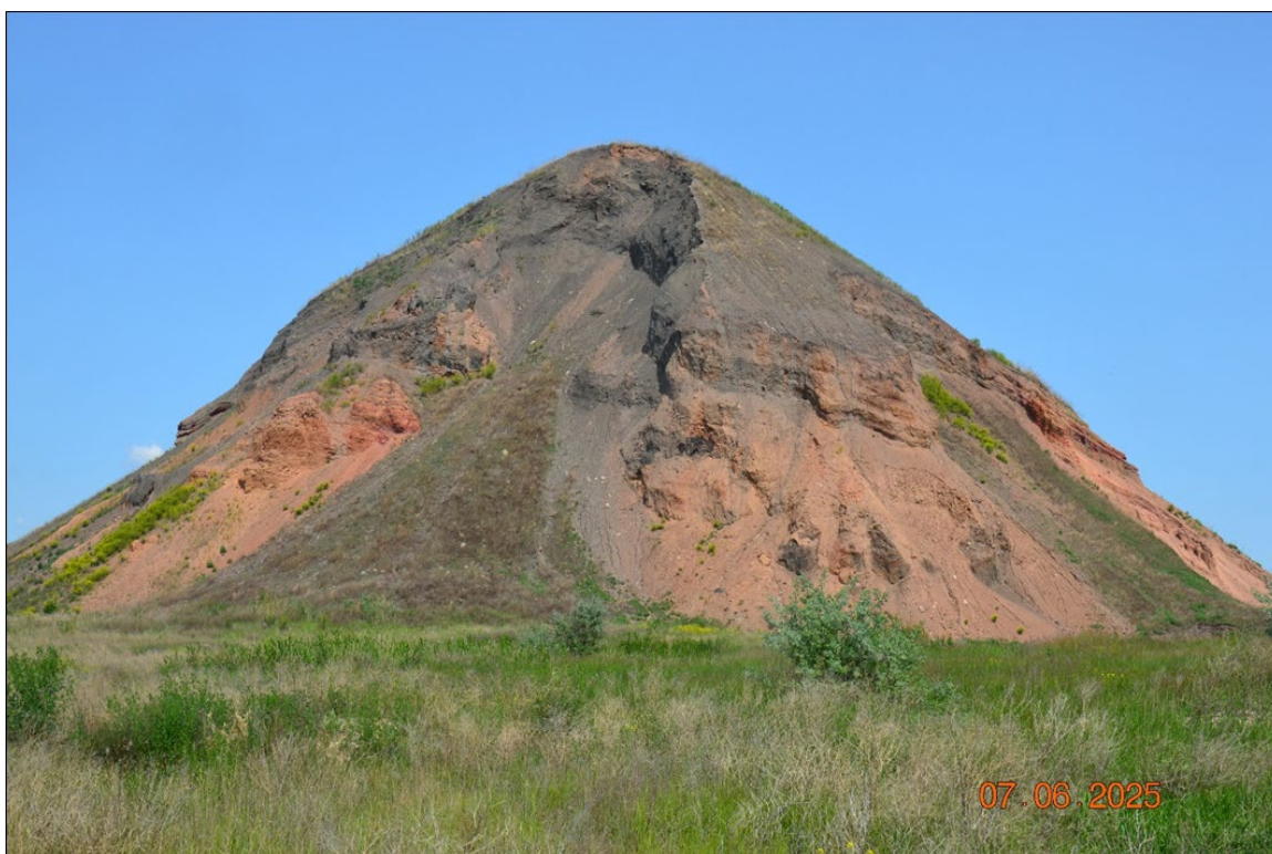
Фото 74-11-00233. Оползание и осыпание склонов террикона бывшей угольной шахты Куллярская. Красногорский пункт наблюдений, Челябинская область
