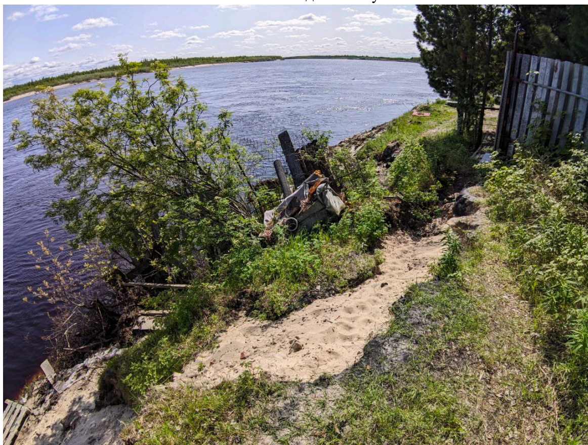
Фото 89-12-00259. Осыпной процесс вдоль берегового склона р. Надым, расположен в южной части п. 107 км. Надымский участок ЯНАО
