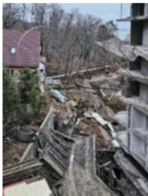
Фото 23-11-00647. Активизация оползневого процесса по ул.Есауленко 6А (город-курорт Сочи).
