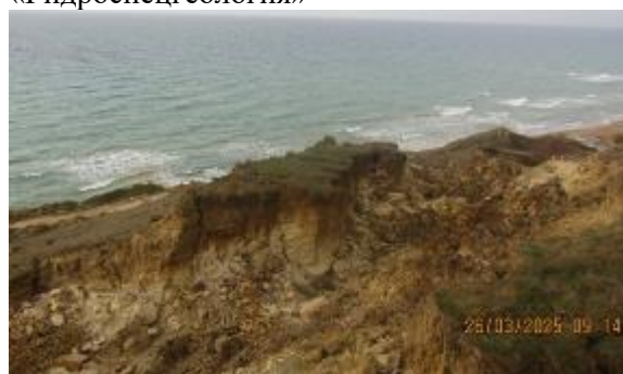
Фото 23-11-00032. Активизация оползнего процесса у западной окраины коттеджного поселка Янтарный берег (участок побережья Черного моря в п. Веселовка)
