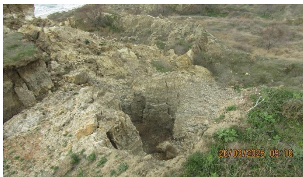
Фото 23-11-00032. Активизация оползневого процесса вдоль стенки срыва на западном фланге старого оползня в 2,53 км к западу от оз.Соленого
