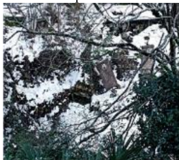
Фото 23.11.00650. Активизация оползневого процесса на территории Успенского кладбища. Центральный район города-курорта Сочи.
