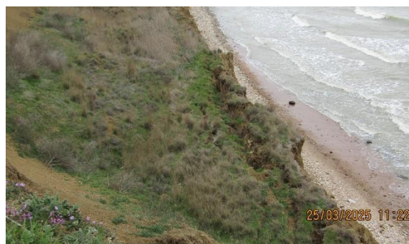
Фото 23-11-00023. Оползневая активизация в нижней части уступа, в 1,6 км от м. Панагия
