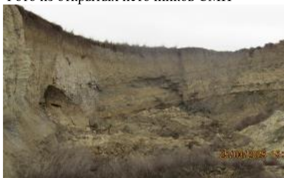
Фото 23.11.00018. Активный оползень в центральной части ст-цы Тамань у этно-туристического комплекса «Атамань». Фото Южного отделения ЮРЦ ГМСН «Гидроспецгеология»
