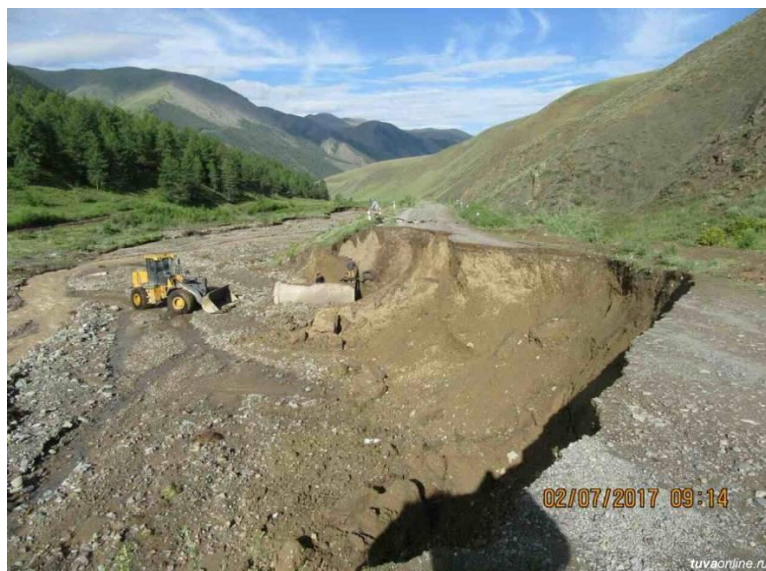
Рис. 2.34 Разрушение автодороги Хандагайты–Мугур-Аксы, Республика Тыва
