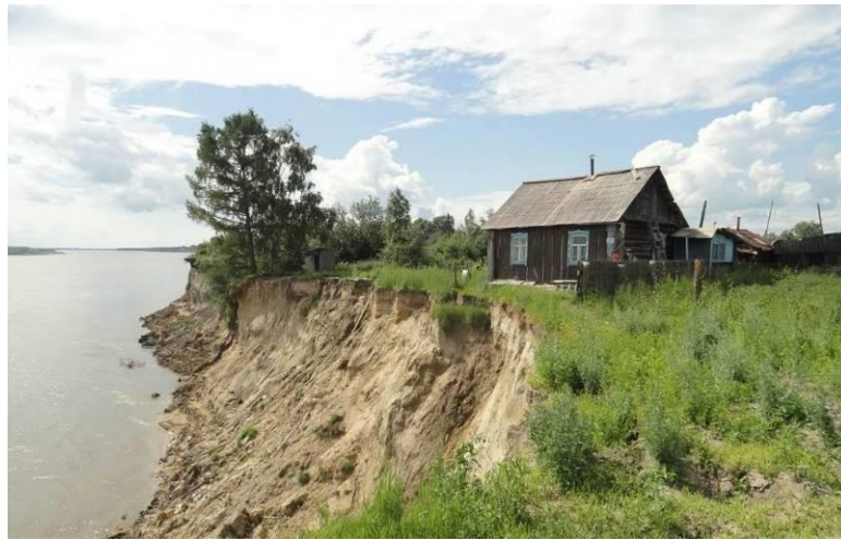
Рис. 2.39 Береговой склон в районе ул. Центральная, 15/1, г. Колпашево, Томская область
