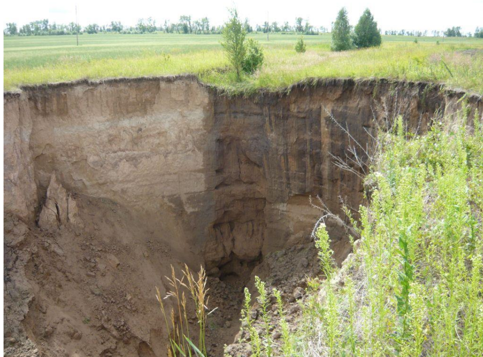
Рис. 2.29 Русло основного оврага на участке автодороги Минусинск-Беллык (98 км), Красноярский край
