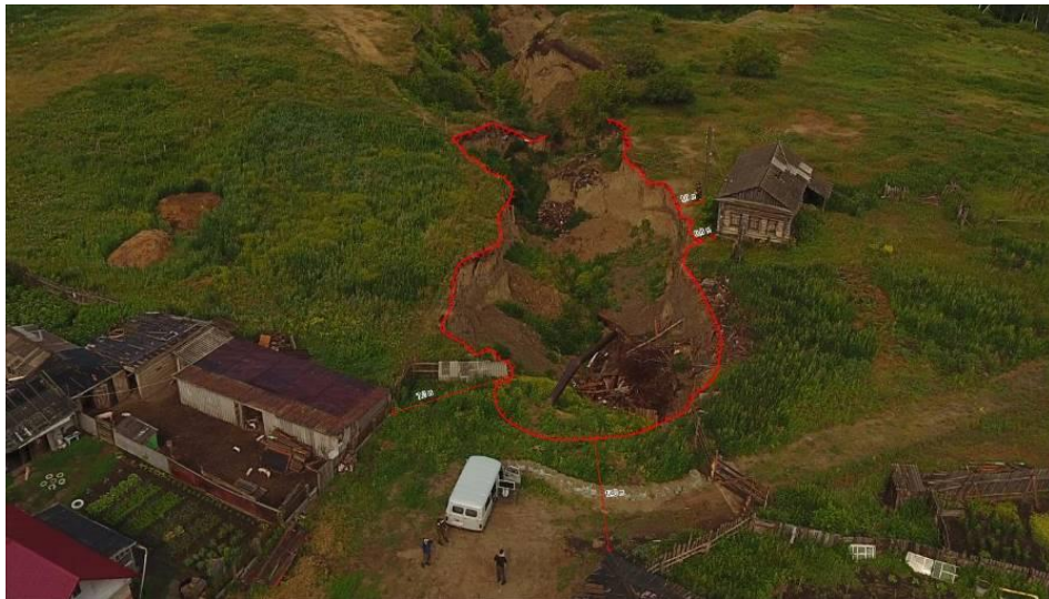
Рис. 2.38 Разрушение жилой застройки в д. Исаковка, Омская область
