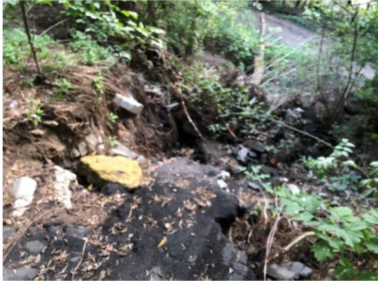
Рис. 2.18 Деформированное асфальтированное дорожное покрытие на левом берегу р. Москва, ниже от Карамышевского гидроузла, г. Москва
