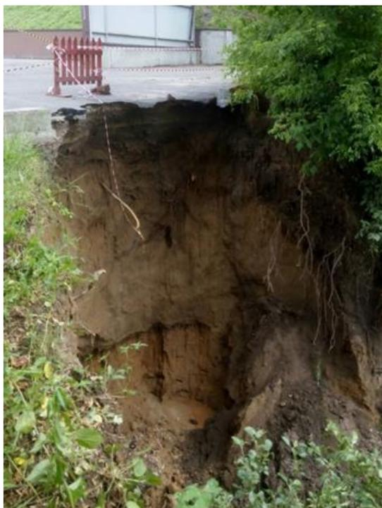
Рис. 2.7 Сместившийся оползневой блок породы, а также деформированное асфальтированное дорожное покрытие по ул. Фокина, г. Брянск, Брянская область
