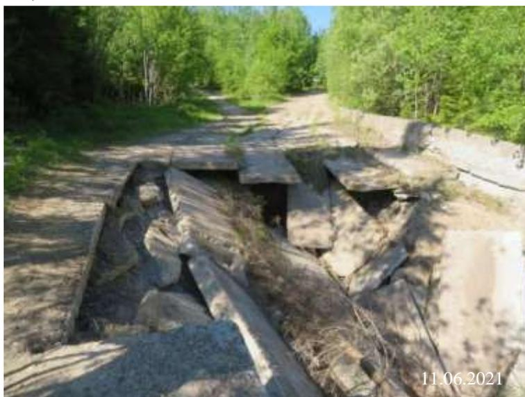
Рис. 2.91. Разрушенный мост через овраг на участке заброшенной автодороги по ул. Сутормина в г. Ханты-Мансийске
