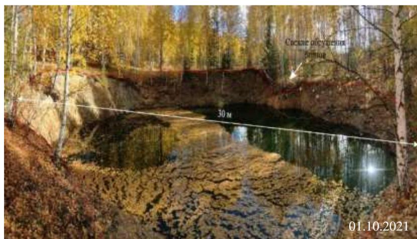
Рис. 2.56. Провал над старой горной выработкой в ТН С285-3, Левихинский участок Свердловская область
