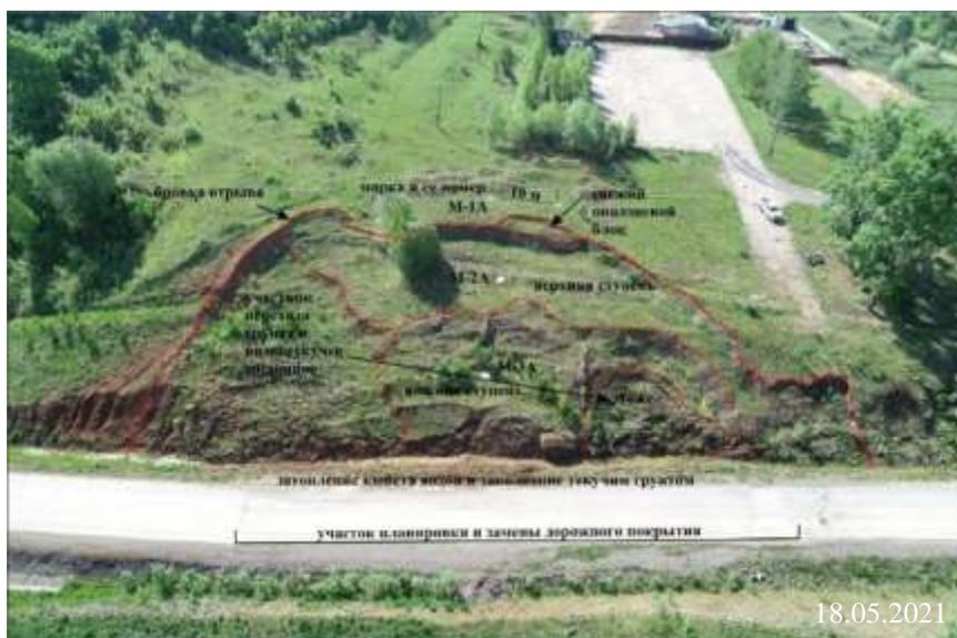
Рис. 2.69. Стрoение оползня по автодороге на ГЛК «Аджигардак» (ТН 1).
