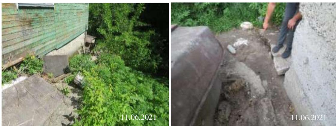
Рис. 2.90. Деформация и провисание отмостки жилого дома по ул. Садовая, д. 1
