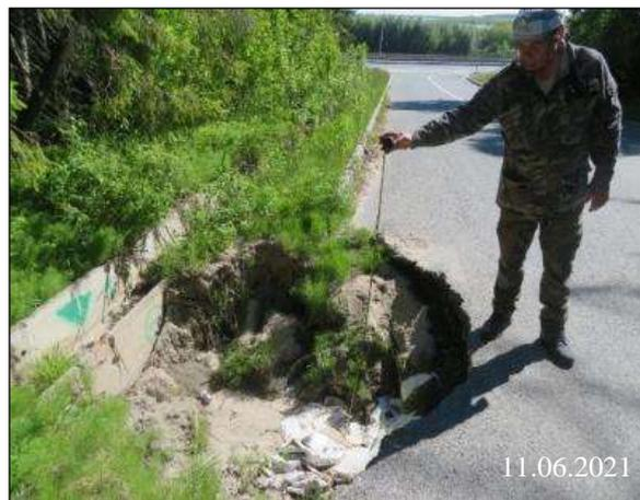
Рис. 2.105. Деформация дорожного покрытия (справа) и облицовки насыпи моста (слева) в районе перекрестка ул. Сутормина - ул. Восточная объездная в г. Ханты-Мансийске
