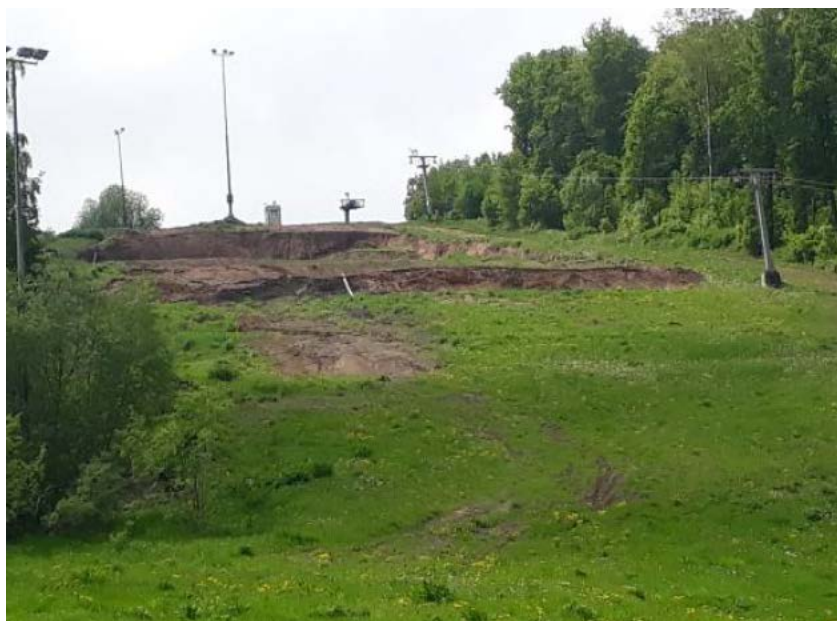
Рис. 2.12 Сместившийся оползневой блок породы на территории горнолыжного комплекса «Квань», вблизи д. Квань, г. Калуга, Калужская область
