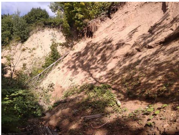
Рис. 2.18 Оползневой процесс, ул. Шевченко, г. Смоленск, Смоленская область
