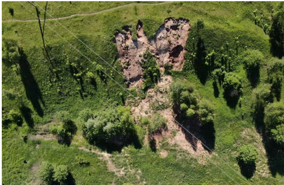
Рис. 2.11 Оползневой процесс, г. Вязники, правый склон долины р. Свистишна, Вязниковский район, Владимирская область
