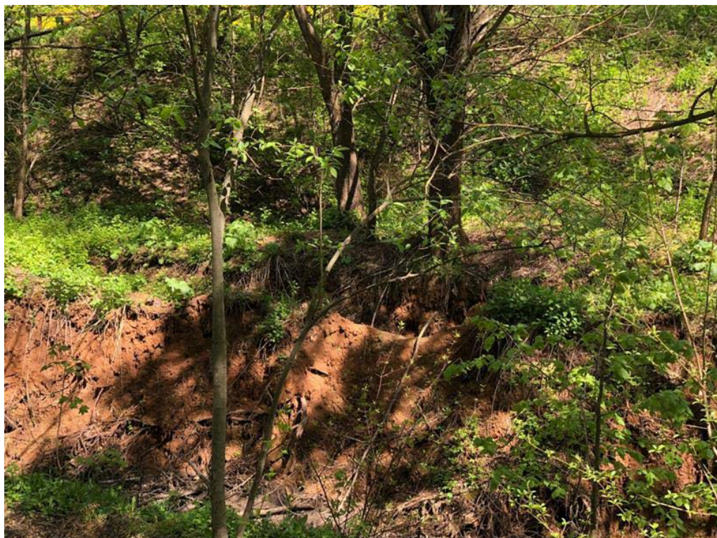
Рис. 2.15 Оползневой процесс правый берег р. Раменка, восточная часть парка им. 50-летия Октября, г. Москва
