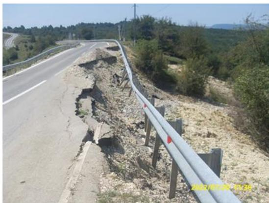
Рис. 2.15 Автодорога с.Мехкешты - с.Зандак – 4,7км. Разрушено полотно дороги с покрытием на участке длиной 60м, шириной 3м.
