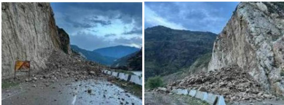
Рис. 2.8 Активизировавшийся обвально-осыпной процесс в 4,3км ЮВ с. Могох.
