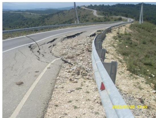
Рис. 2.16 Автодорога с.Мехкешты - с.Зандак – 5,01км. Разрушено полотно дороги с покрытием на участке длиной 60м, шириной 3м.
