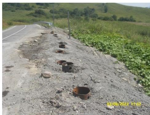
Рис. 2.9. Автодорога с.Даттых - с.Галашки, 5,26км. Разрушено полотно дороги с покрытием на участке длиной 20м, шириной 1,5м (фото ООО «Центр ГИДИС»).
