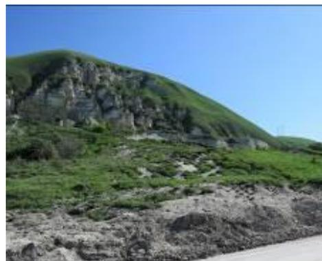
Рис. 2.18 Смещения оползневых масс на полотно автодороги от п. Белореченский к верхнему спортивному комплексу ФГБУ «Юг Спорт» в результате подрезки склона при реконструкции дороги, г. Кисловодск Фото ЮРЦ ГМСН «Гидроспецгеология»
