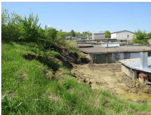
Рис. 2.17 Смещения высокой интенсивности в языке левой части оползня 37 (уч-к Ташлянский). Частичное разрушение нескольких гаражей, здесь же был участок бывшего газопровода (г. Ставрополь). Фото ГБУ СК «Ставропольский ЦГЭМ»
