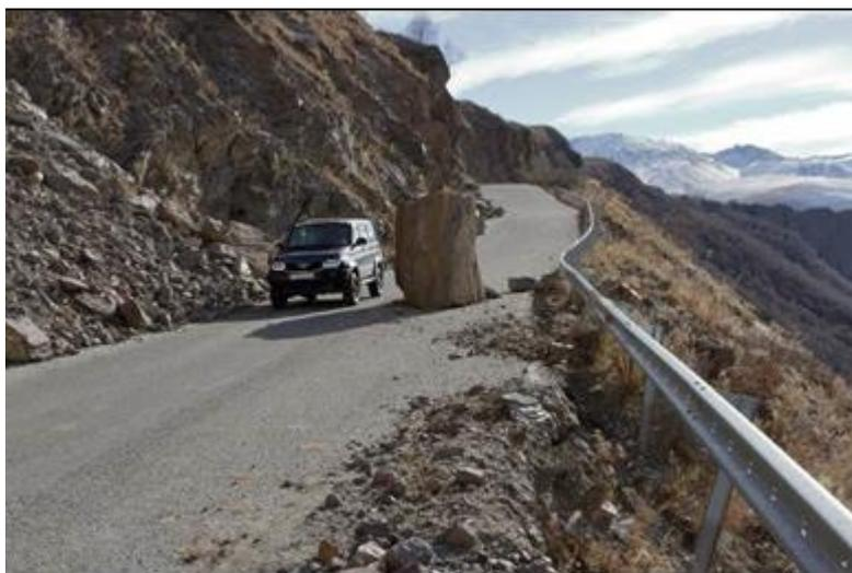
Рис. 2.11 Обвальный участок на верховом откосе а/д Кисловодск - Долина нарзанов - Джилысу в правом борту р. Малка, в 0,4 км выше моста (29.10.2022г., фото ООО «Каббалкгеомониторинг»)
