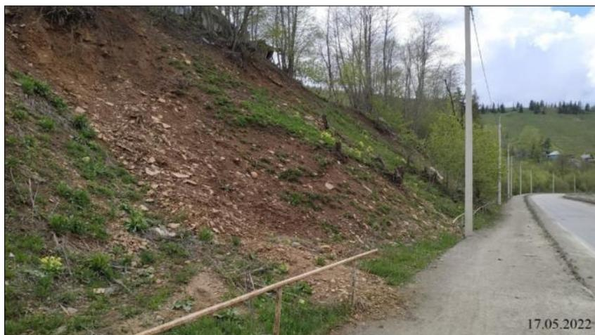
Рис. 2.61. Осыпь грунта с оползневого склона на автодорогу.
