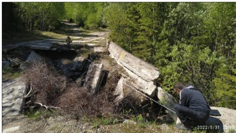
Рис. 2.75. Разрушенный процессом овражной эрозии мост на ул. Сутормина. Участок Ханты-Мансийский-2, ХМАО-Югра
