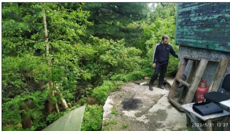
Рис. 2.74. Разрушение отмостки жилого дома № 1 по ул. Садовая на участке Ханты-Мансийский-1, ХМАО-Югра
