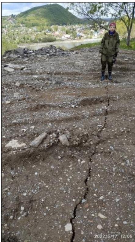
Рис. 2.60. Трещины отрыва на отсыпанном оползневом участке в ТН 5 по ул. Набережная в г. Аша. Ашинский участок, Челябинская область
