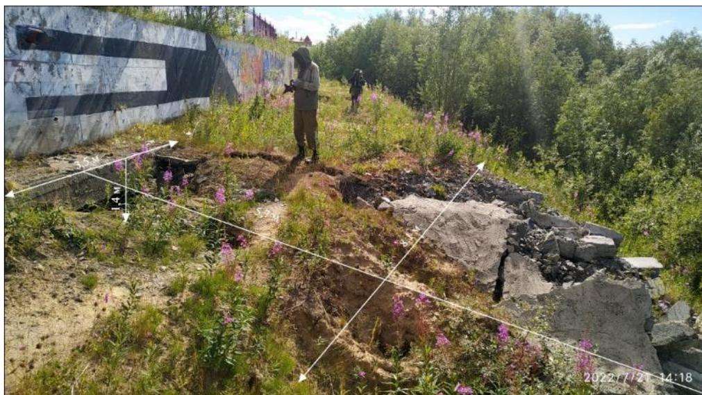
Рис. 2.80. Развитие процесса овражной эрозии в техногенно-нарушенных условиях по периметру ЯМПК. Участок Салехардский, ЯНАО
