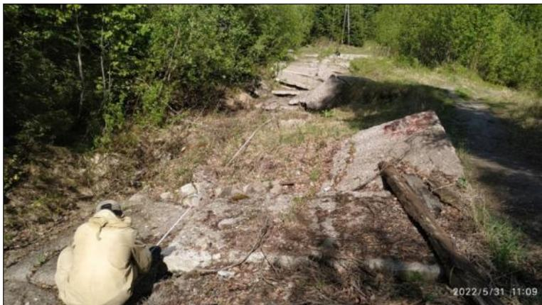
Рис. 2.77. Разрушение суффозионным процессом неэксплуатируемой автодороги по ул. Сутормина. Участок Ханты-Мансийский-2, ХМАО-Югра
