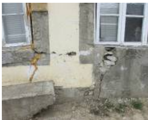
Рис. 2.2.68. Воздействие оползневого процесса на сооружения: деформации в доме по ул. Газопроводная, пос. Сепараторов, ГО Махачкала (а); участок по ул. 1-й Яблоневый тупик 17 пос. Сепараторов ГО Махачкала (б)
