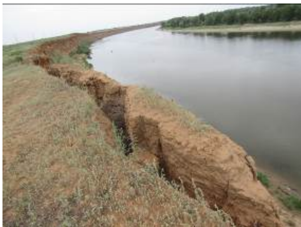
Рис. 2.2.62. Обвальное проявление в с. Владимировка Енотаевского района, Астраханская область
