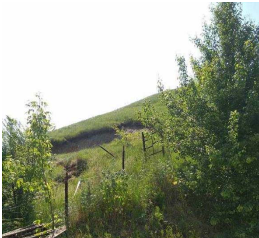
Рис. 2.2.39 Сместившийся оползневой склон ул. Речная, д. 26-28, с. Сырское, Липецкий район, Липецкая область
