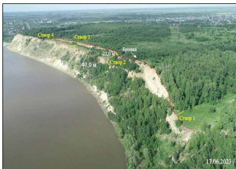
Рис. 2.2.115. Участок развития оползневой процесса на высоком берегу р. Иртыш. г. Тобольск, Тюменская область
