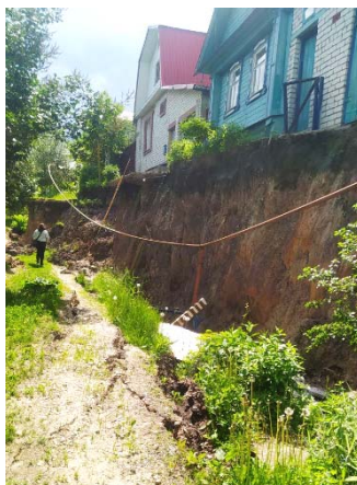
Рис. 2.2.97. Активизация оползневого процесса в с. Работки, Кстовский район, Нижегородская область
