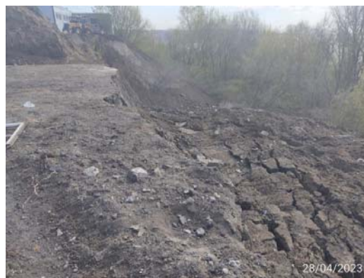
Рис. 2.2.100. Отсевший блок насыпных грунтов в верхней части оползня в районе магазина «Светофор» по ул. Декабристов, 82. г.Сызрань, Самарская область
