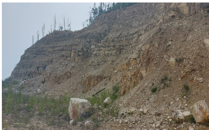
Рис. 2.2.163. Обвально-осыпной склон на участке автодороги 823 км А-360. Алданский район, Республика Саха (Якутия)
