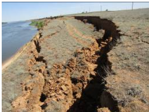
Рис. 2.2.60. Оползень в с. Пришиб, Енотаевский район, Астраханская область
