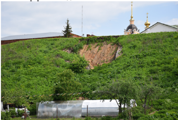
Рис. 2.2.35. Оползень на левобережном склоне р. Каменка, г. Суздаль, у смотровой площадки торговых рядов Гостиного Двора (над приусадебной территорией д. №1 по ул. Набережная), Владимирская область
