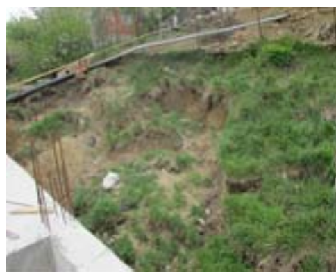
Рис. 2.2.68. Воздействие оползневого процесса на сооружения: деформации в доме по ул. Газопроводная, пос. Сепараторов, ГО Махачкала (а); участок по ул. 1-й Яблоневый тупик 17 пос. Сепараторов ГО Махачкала (б)
