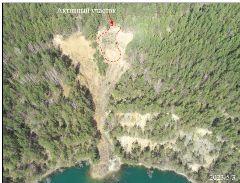
Рис. 2.2.110. Активный оползневой участок северного борта карьера. В 2,5 км западнее с. Липовской Режевского ГО, Свердловская область
