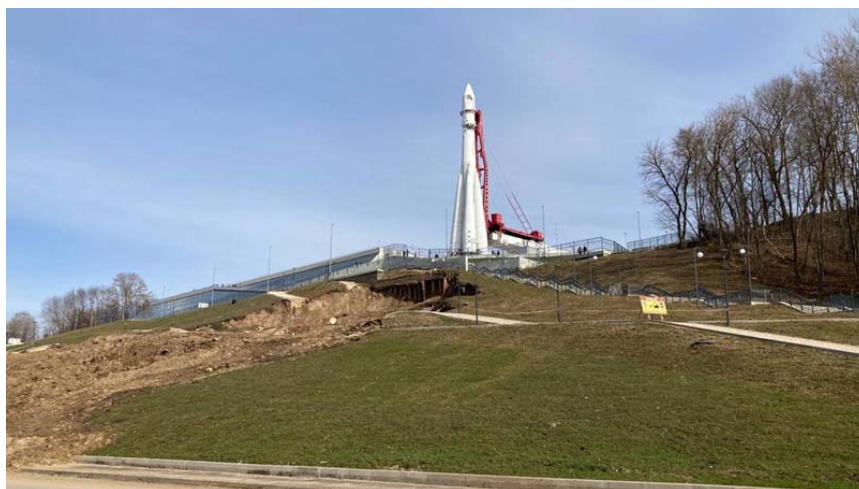
Рис. 2.2.37 Оползень у Государственного музея истории космонавтики имени К.Э. Циолковского, Яченская набережная, Ленинский округ, г. Калуга, Калужская область
