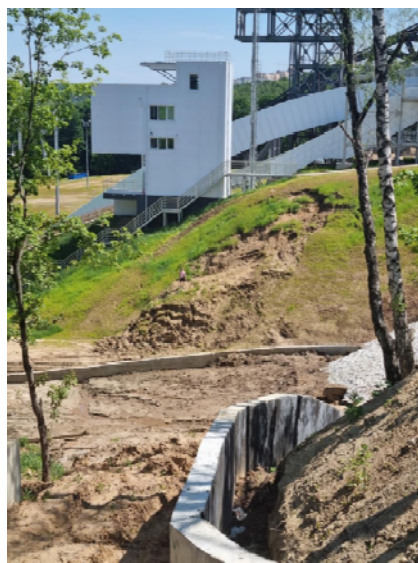
Рис. 2.2.42 Оползень на территории природного заказника Воробьёвы Горы вдоль улицы Косыгина, район Раменки, Западный административный округ, г. Москва
