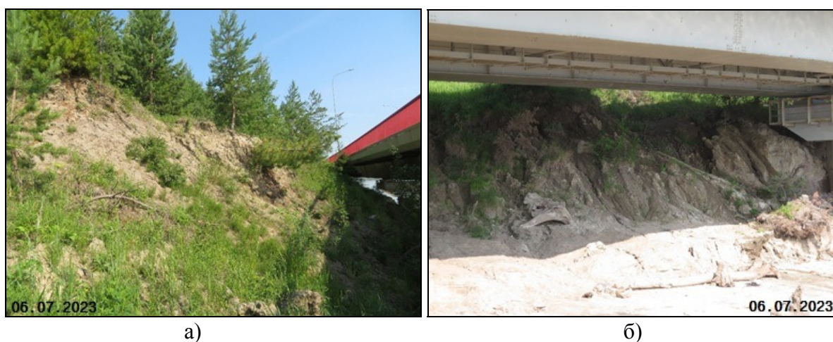
Рис. 2.2.127. Оползневой участок на Восточной объездной дороге: вид на оползневой склон (а); заполнение оползневыми массами пространства под эстакадой (б). г. Ханты-Мансийск, ХМАО-Югра
