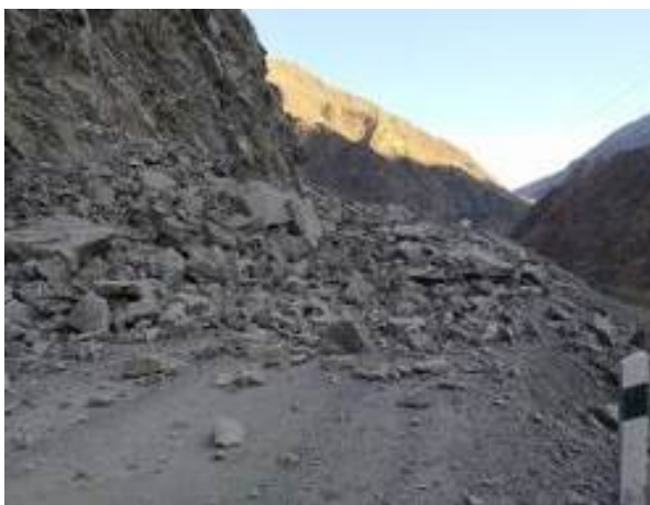
Рис. 2.2.69. Перекрытие породами участка автодороги «Курукал – Хнов в результате обвала. Ахтынский район, Республика Дагестан
