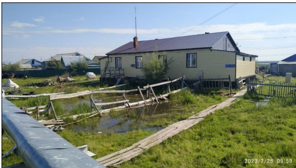
Рис. 2.2.133. Развитие процесса подтопления на локальном участке территории п. Белоярск по ул. Оленеводов, д. 9, 13
