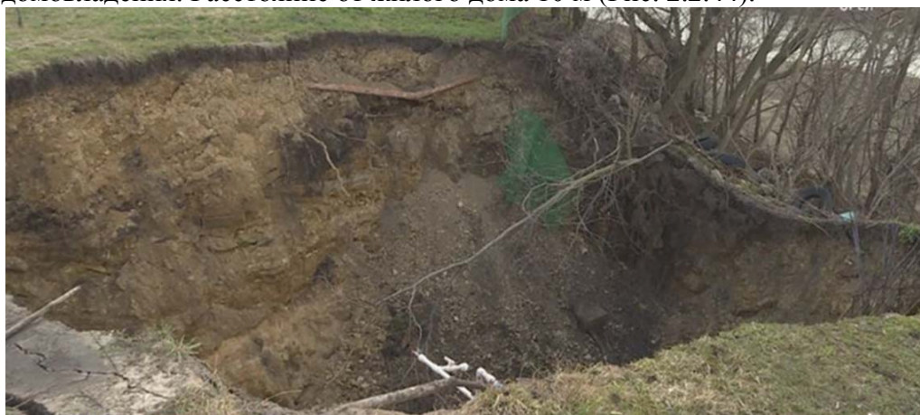
Рис. 2.2.44 Карстово-суффозионный провал, ул. Пятницкая, д. 28, г. Орел, Орловская область
