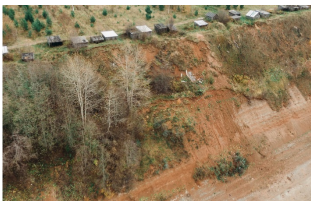
Рис. 2.2.11. Проявление оползневого процесса у д. Заовражье, Котласский район, Архангельская область
