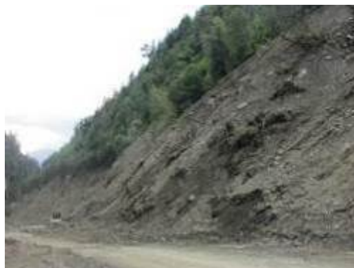
Рис. 2.2.67. Перекрытие оползнем полотна автодороги «Анцух - Тлярата». Республика Дагестан
