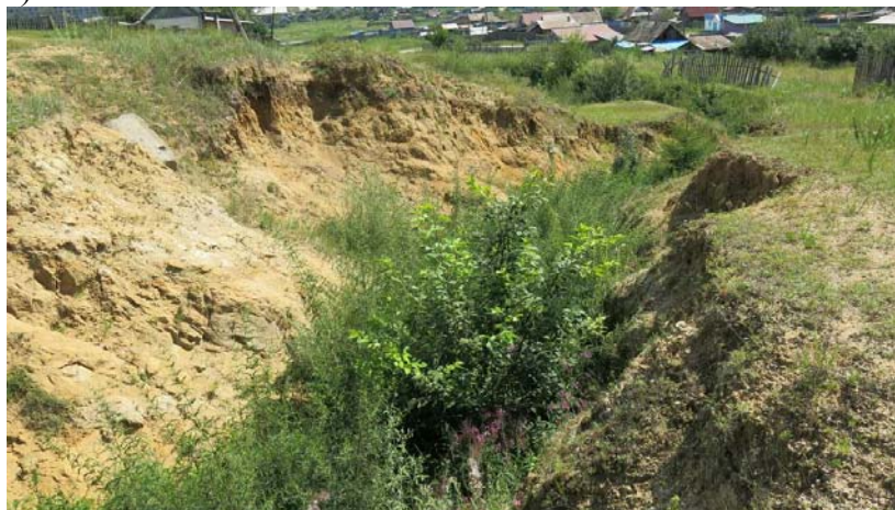
Рис. 2.2.173. Устьевая часть овраг по ул. Лазо, 47, п. Дарасун. Карымский район, Забайкальский край
