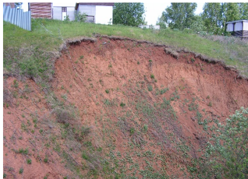
Рис. 2.2.89. Оползень в д. Дулесово, Сарапульский район, Удмуртская Республика
