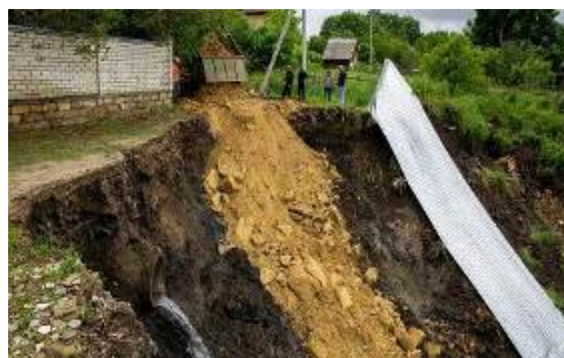
Рис. 2.2.77. Оползень в г. Ставрополь на ул. Монастырский тупик, Ставропольский край
