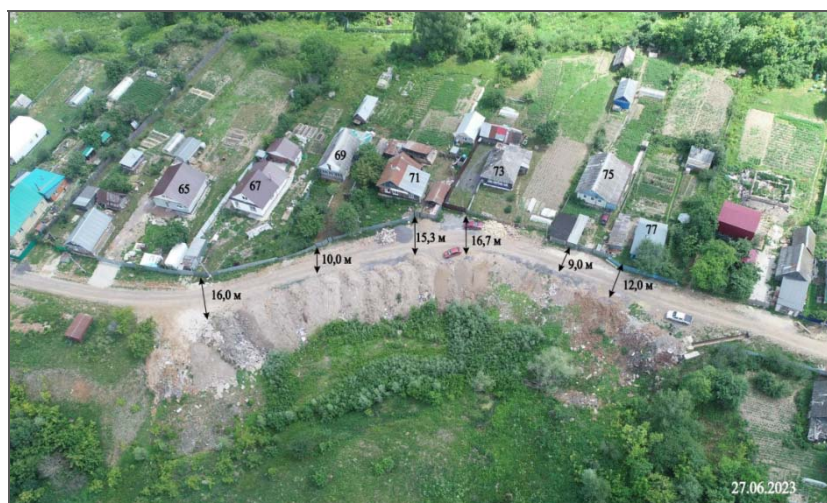
Рис. 2.2.123. Оползневой участок по ул. Набережная в г. Аша. Челябинская область
