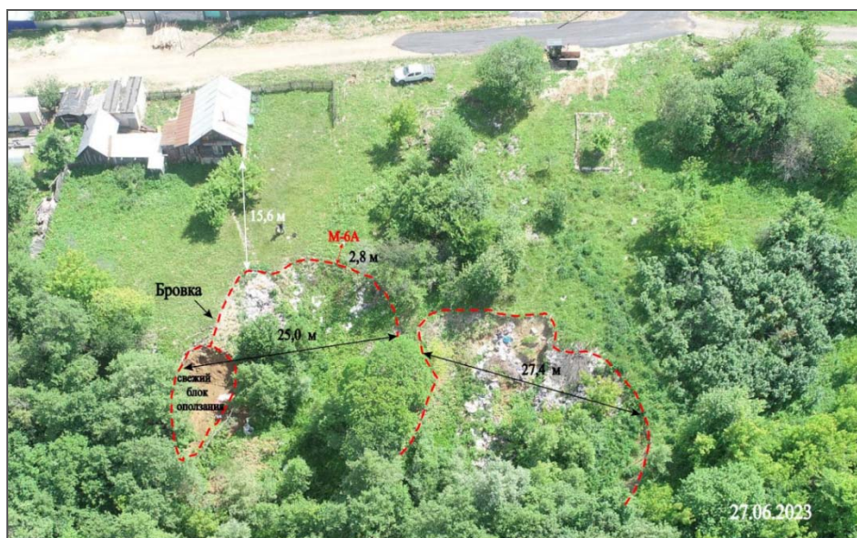
Рис. 2.2.122. Оползневой участок в районе дома № 30 по ул. Набережная. г. Аша, Челябинская область
