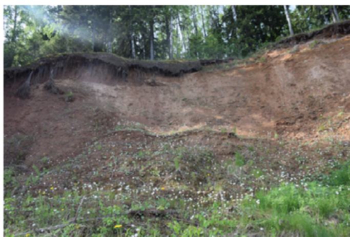
Рис. 2.2.36. Стенка срыва оползня, севернее д. Девкина Гора, вдоль правобережного склона р. Волга (Горьковское вдхр.), Пучежский район, Ивановская область
