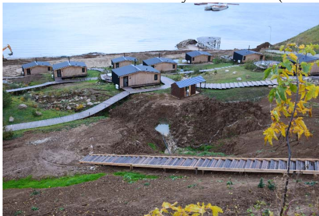
Рис. 2.2.86. Гостиничный комплекс на оползневом склоне в пгт. Камское Устье, Республика Татарстан
