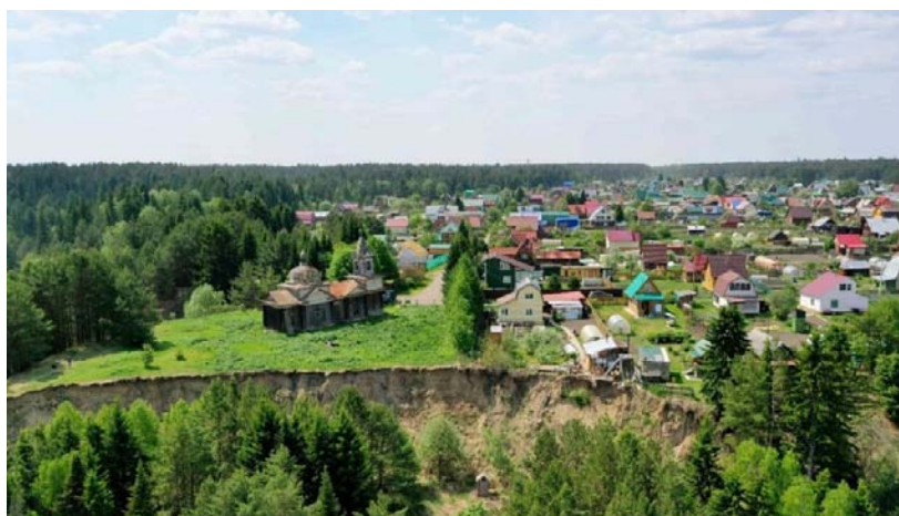
Рис. 2.2.157 Стенка отрыва оползня в д. Нагорный Иштан, Томская область
