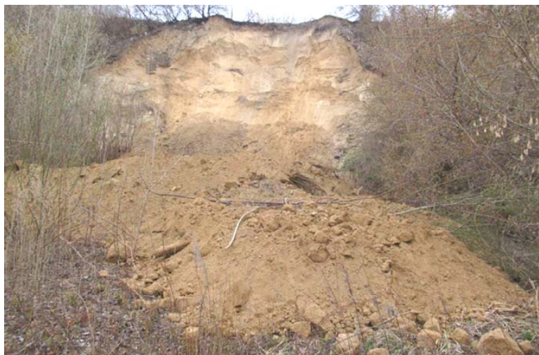
Рис. 2.2.142. Оползень в г. Барнаул, Алтайский край
