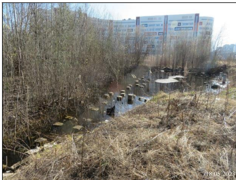
Рис. 2.2.129. Участок подтопления по ул. Пролетарский Проспект, 15. г. Сургут, ХМАО-Югра
