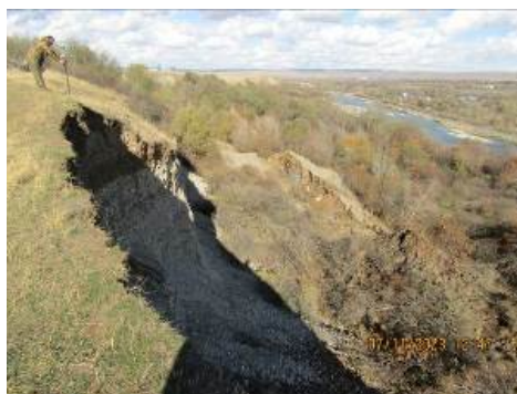
Рис. 2.2.72. Стенка срыва оползня на северо-восточной окраине а. Псыж, Абазинский район, Карачаево-Черкесская Республика
