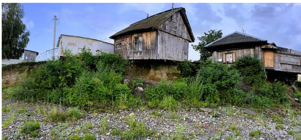
Рис. 2.2.150 Склон подверженный гравитационным процессам в с. Боровково, Кемеровская область-Кузбасс
