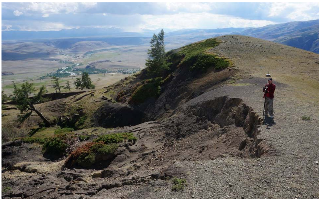
Рис. 2.2.138 Надоползневый уступ оползня. В районе участка а/дороги Р-256 Чуйский тракт 862-863 км, Кош-Агачский район, Республика Алтай
