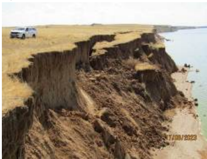
Рис. 2.2.63. Активизация оползневой процесса в пределах берегового уступа Цимлянского водохранилища, район х. Алдабульский. Дубовский район, Ростовская область
