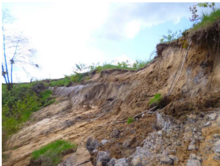
Рис. 2.2.45 Стенка срыва оползня в д. Соловьево, Кардымовский район, Смоленская область
