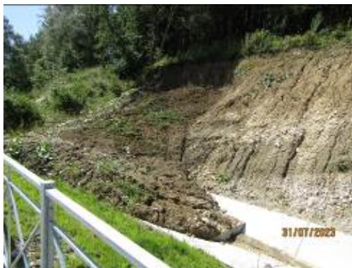
Рис. 2.2.78. Активизация оползня в верховом откосе автодороги к верхнему спортивному комплексу ФГБУ «Юг Спорт»
