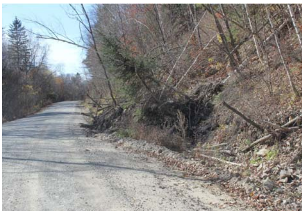
Рис. 2.2.165. Оползень на 268, 2 км автодороги Р-447 Находка-Ольга-Кавалерово. Ольгинский МО, Приморский край
