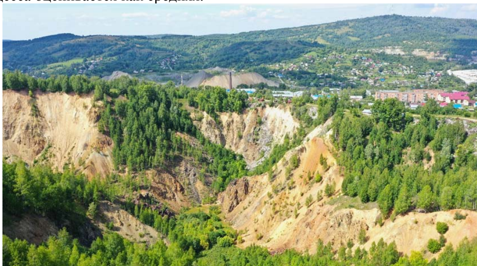
Рис. 2.2.151 Осыпные склоны на борту провала в пгт Темиртау, Кемеровская область-Кузбасс
