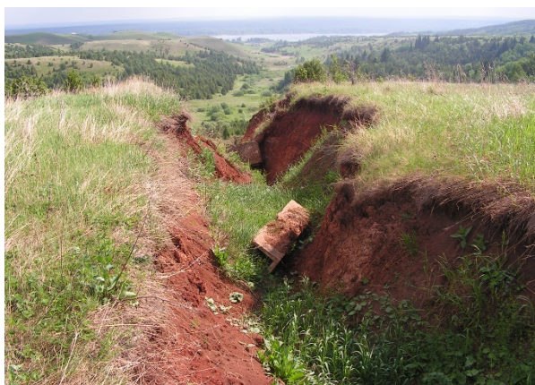
Рис. 2.2.90. Вершина оврага с разрушенными фрагментами противоэрозионных сооружений в д. Соколовка, Сарапульский район, Удмуртская Республика
