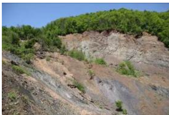
Рис. 2.2.59. Оползневой склон. Верховья р. Кепши, городской округ Сочи, Краснодарский край
