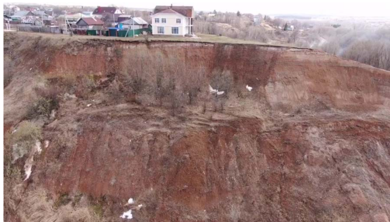
Рис. 2.2.91. Оползневой склон на северной окраине г. Мариинский Посад, Чувашская Республика
