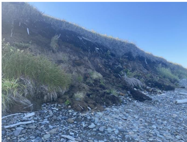
Рис. 2.46. Обвал морской террасы, вследствие ее подмыва.
