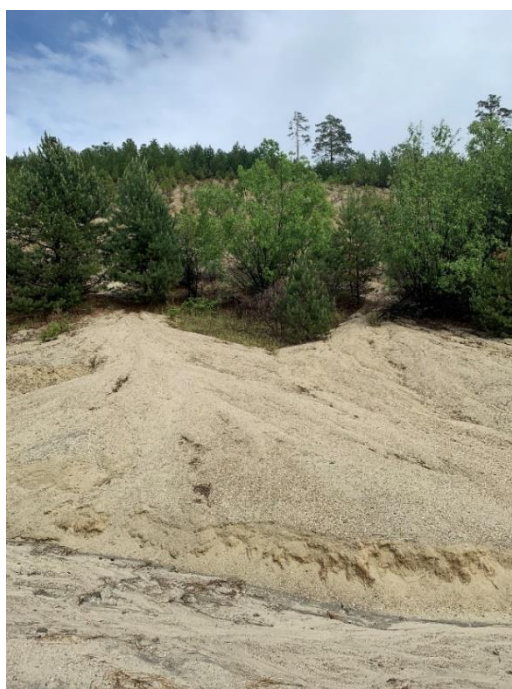
Рис. 2.30. Осыпные проявления на 89 км автодорога Свободный-Благовещенск Благовещенский район 31.05.2023г.
