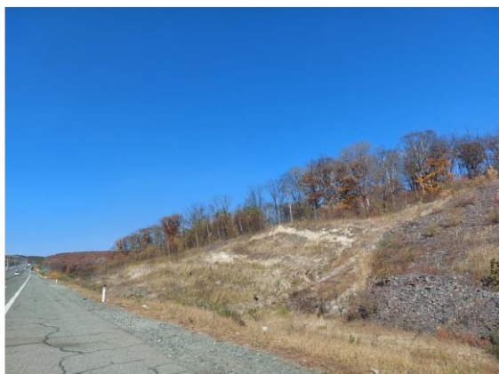
Рис. 2.12. Участок 677,7 км автодороги А370 «Уссури»
