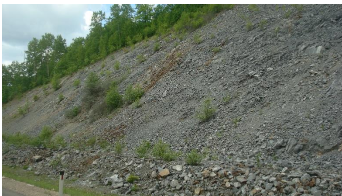
Рис. 2.29. Осыпные проявления на 1836 км автодороге Р-297.
