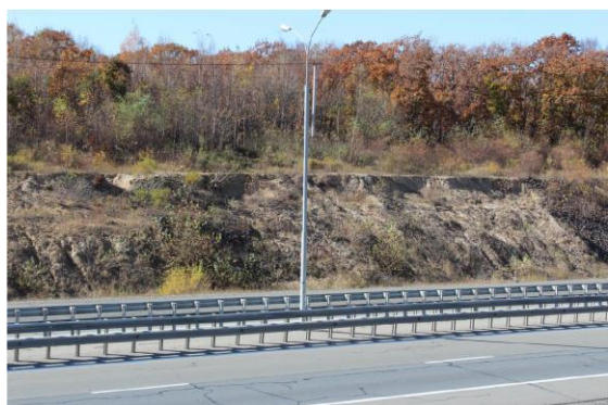
Рис. 2.14. Участок 678,05-681,24 км автодороги А-370 «Уссури»
