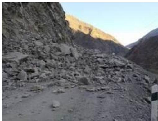
Рис. 2.14. Перекрытие обвалом скальных пород участка автодороги «Курукал - Хнов». Фото ООО «Даггеомониторинг»
