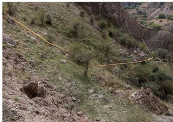
Рис. 2.18. Деформация трубы газопровода и опор. Фото ООО «Каббалкгеомониторинг»
