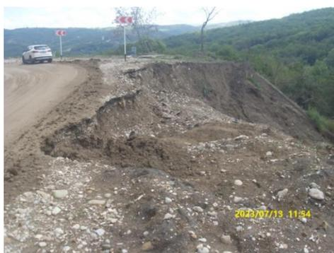
Рис. 2.23. Разрушение оползнем полотна автодороги с. Шуани - с. Саясан, 2,43 км. Фото ООО «Центр ГИДИС»
