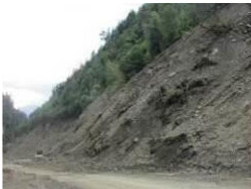
Рис.2.11. Повреждение активизировавшимся оползнем полотна автодороги «Анцух - Тлярата». Фото ООО «Даггеомониторинг»
