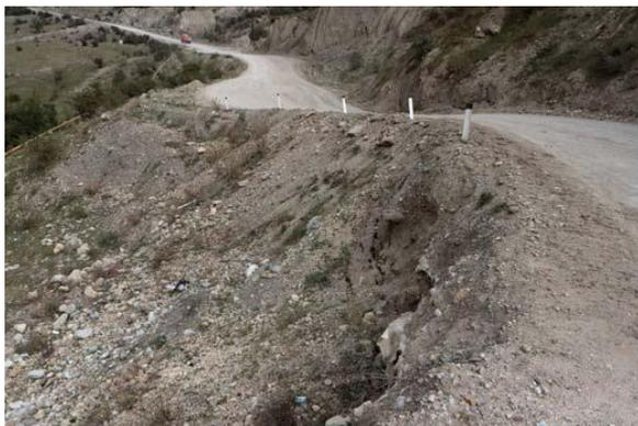
Рис. 2.17. Деформация и повреждение полотна автодороги Урвань - Уштулу (А-154). Фото ООО «Каббалкгеомониторинг»
