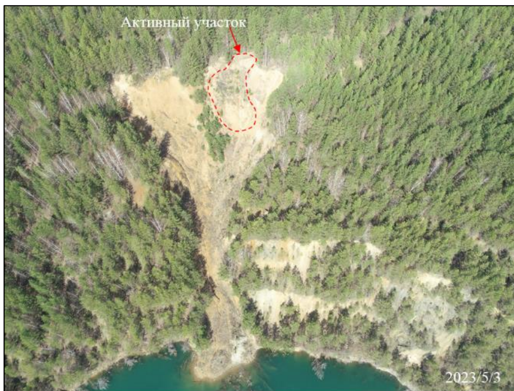
Рис. 2.27. Оползание северного борта карьера залежей 3, 4, 5. ТН С68-1. Участок Липовский, Свердловская область
