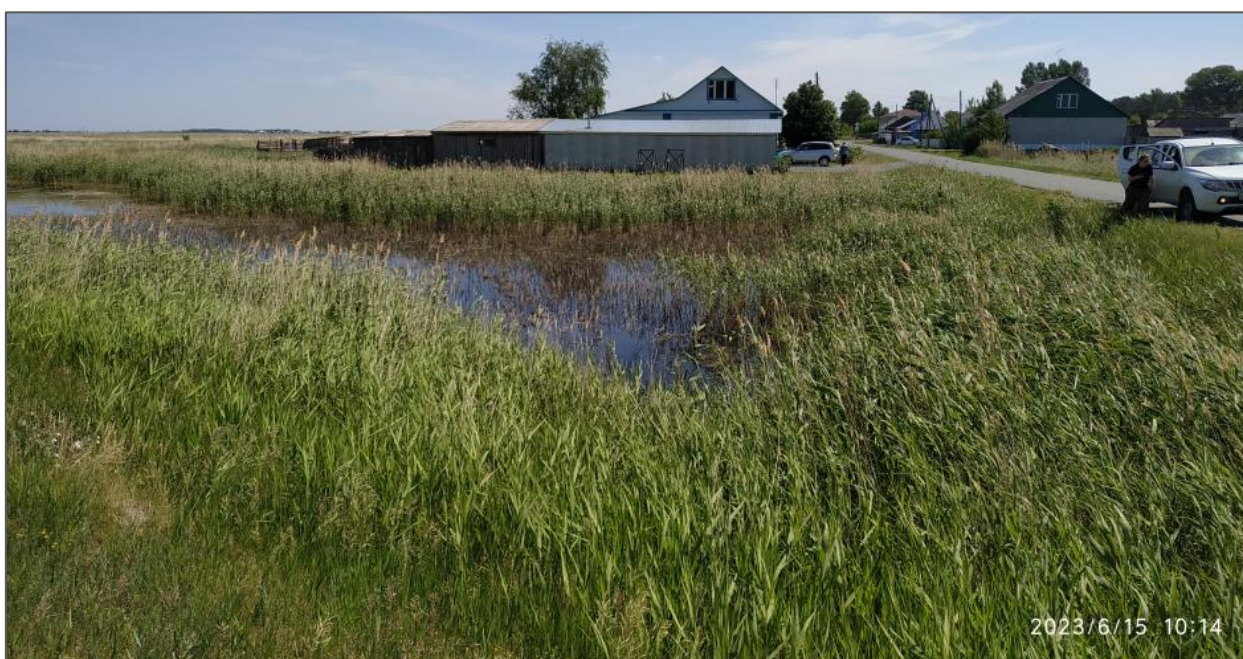
Рис. 2.42. Подтопленная территория по ул. О.Кошевого в с. Сладково. Сладковский участок, Тюменская область
