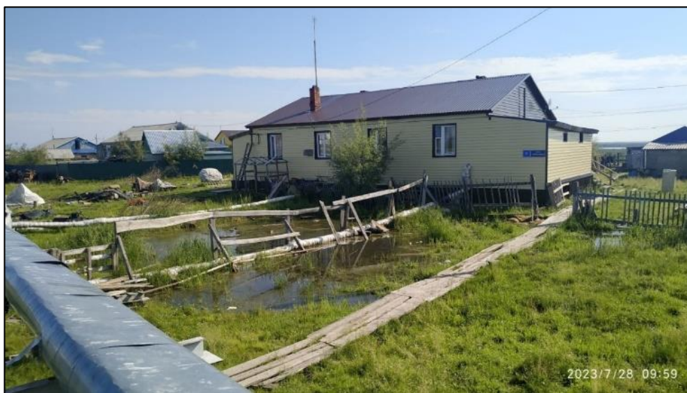
Рис. 2.63. Развитие процесса подтопления на локальном участке территории п. Белоярск по ул. Оленеводов, д. 9, 13
