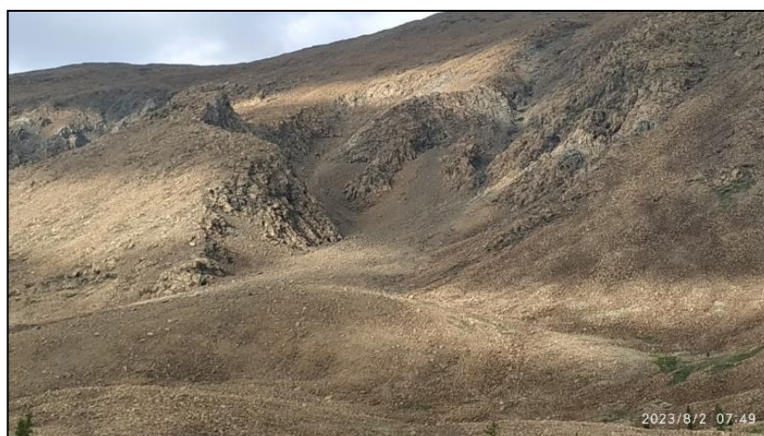
Рис. 2.59. Вид снизу осыпи на склоне массива Рай-Из (ТН 1). ЯНАО
