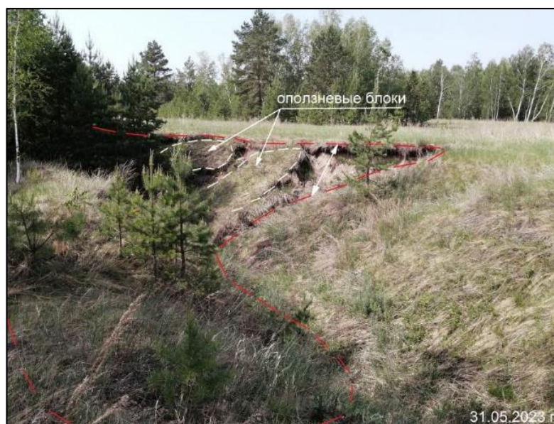
Рис. 2.20. Активный отвершек с оползневыми блоками на правом борту оврага. Участок Становой, Курганская область
