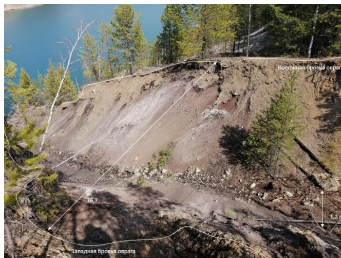
Рис. 2.34. Развитие овражной эрозии на южной стенке карьера залежей 3,4,5 (ТН С68-2). Липовский участок, Свердловская область
