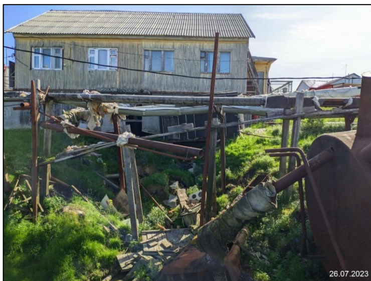
Рис. 2.60. Развитие процесса термоэрозии угрожает дому № 20 по ул. Константина Вануйто (ТН 15). Сеяхинский участок, ЯНАО
