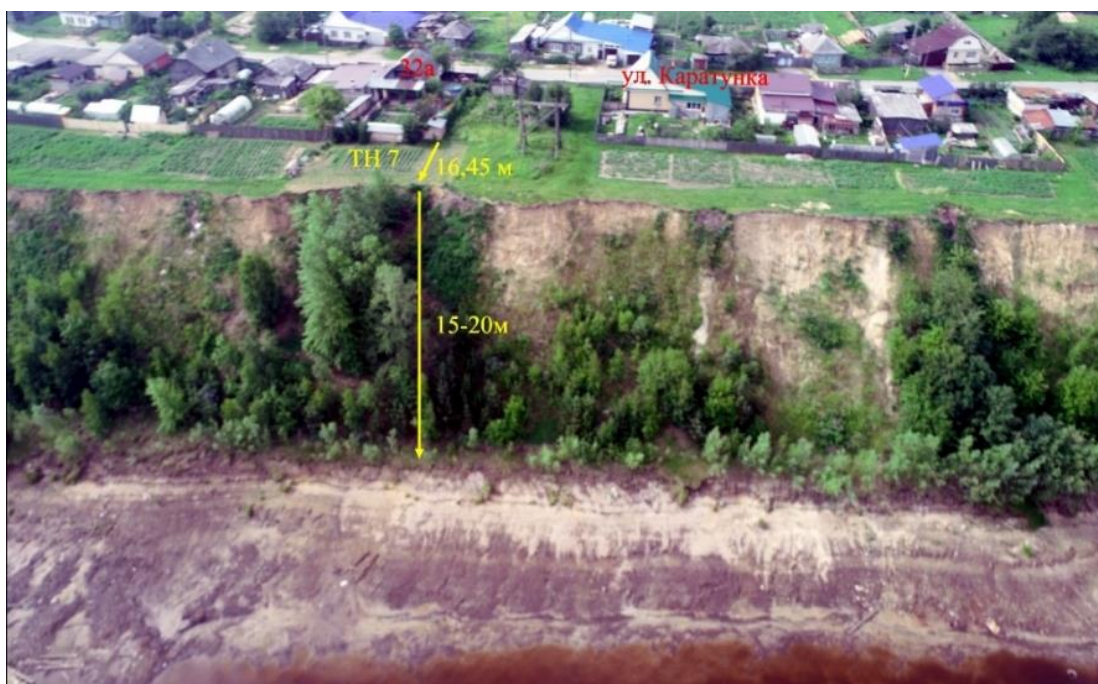
Рис. 2.28. Общий вид гравитационного склона в створе дома № 32а по ул. Каратунка, п. Заморозково. Участок Заморозковский, Свердловская область
