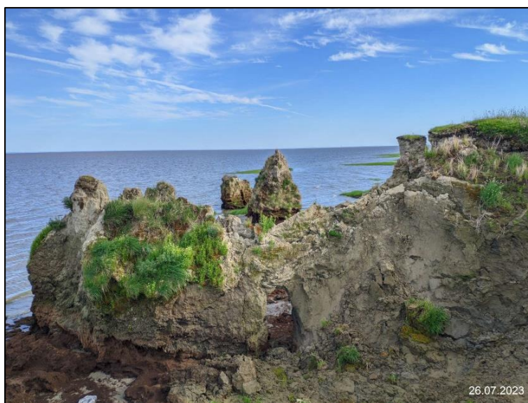
Рис. 2.61. Разрушение процессом термоабразии берегового склона Обский Губы (ТН 20). Сеяхинский участок, ЯНАО
