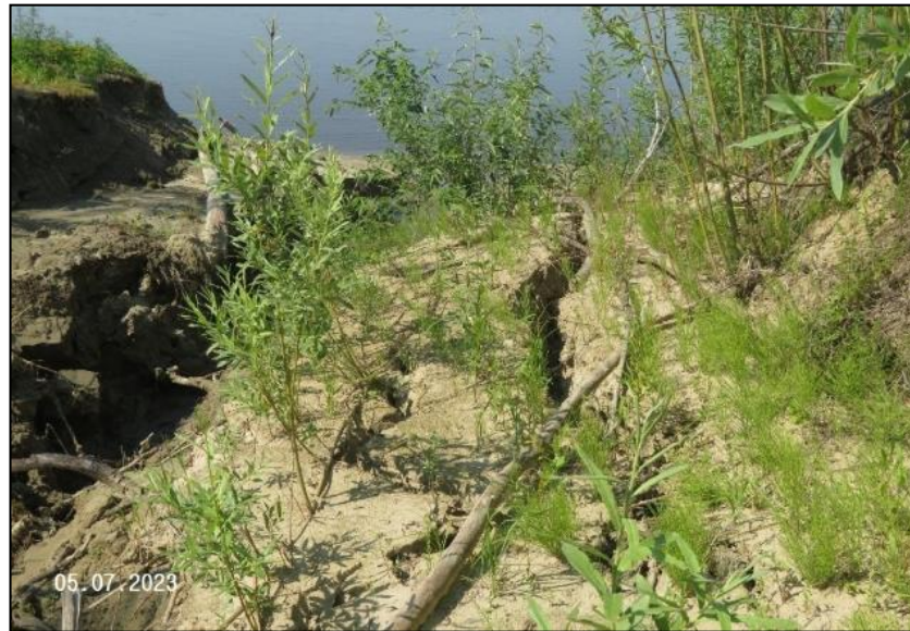
Рис. 2.55. Трещины отрыва на правом борту оврага (ТН 744-1). Участок Горноправдинский, ХМАО-Югра
