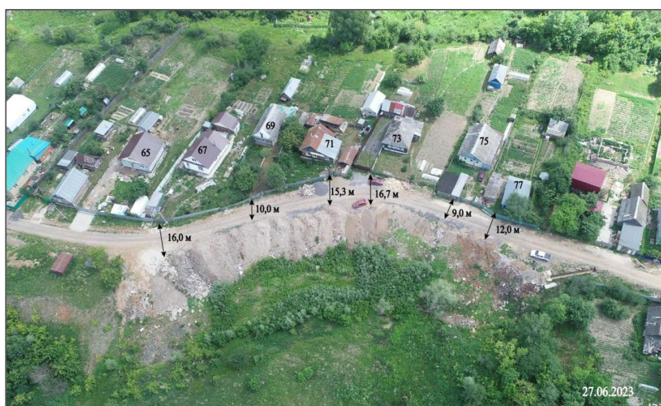
Рис. 2.44. Оползневой участок в районе домов № 65-77 по ул. Набережная в г. Аша. Участок Ашинский, Челябинская область
