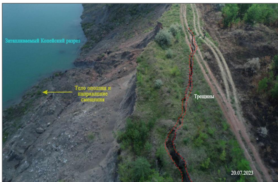
Рис. 2.46. Трещины отрыва в ТН 12 на западном борту Копейского разреза. Копейский участок, Челябинская область
