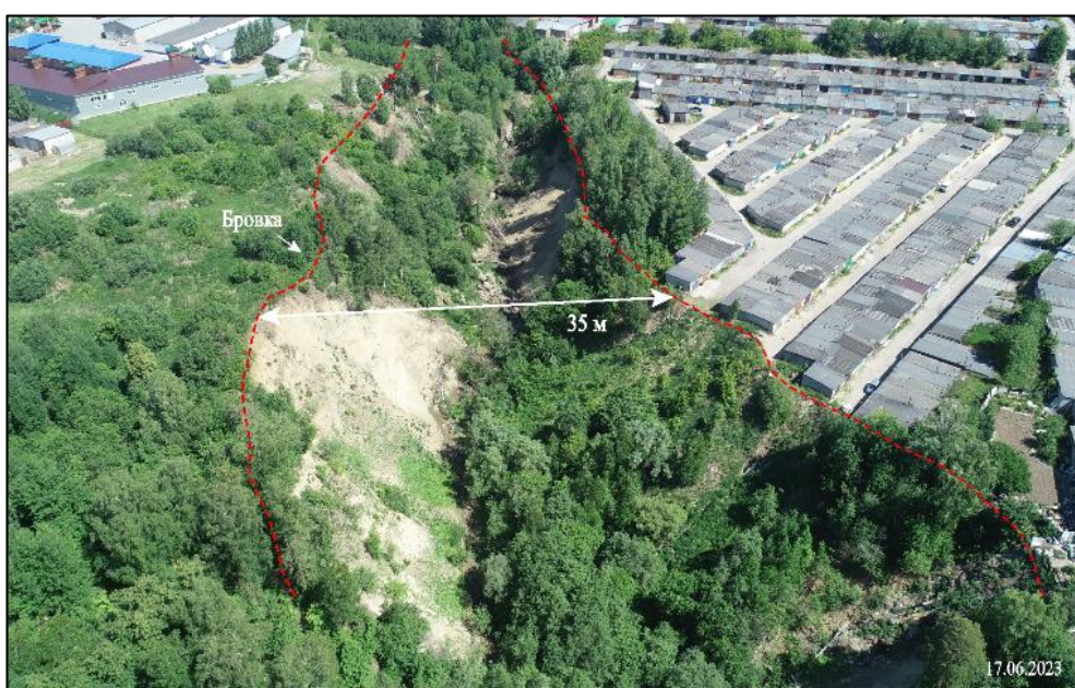
Рис. 2.39. Участок развития овражной эрозии №1 по ул. С. Ремезова в районе ГСК «Сталкер» г. Тобольска. Участок Тобольский, Тюменская область
