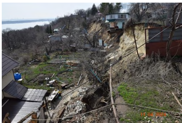
Рис. 2.2.108. Стенка срыва, блок с вертикальным смещением с постройками «СНТ Труженник-65» на участке «Питомник», г. Саратов, Саратовская область
