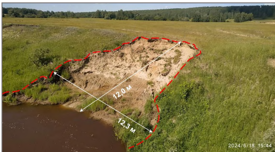
Рис. 2.2.132. Развитие оползневого процесса на правом берегу р. Кизак в д. Маркова. Марковский участок, Тюменская область
