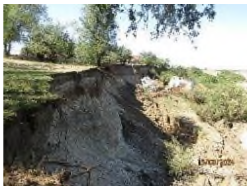
Рис. 2.2.71. Стенка срыва оползня на северо-восточной окраине а. Псыж, Абазинский район, Карачаево-Черкесская Республика
