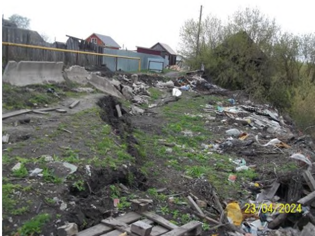
Рис. 2.2.84. Активный участок оползневой цирка по ул. Матросова, г. Ардатов, Республика Мордовия
