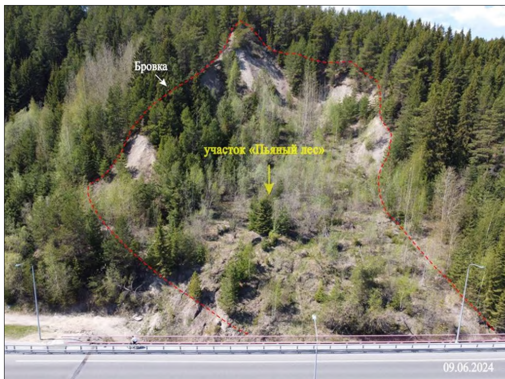
Рис. 2.2.153. Оползневой участок на Восточной объездной дороге. Ханты-Мансийский участок, ХМАО-Югра
