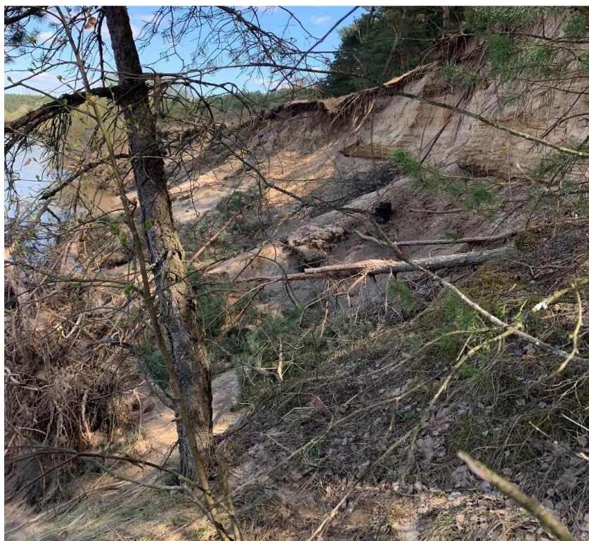
Рис. 2.2.36. Оползень в д. Корекозово, Перемышльский район, Калужская область
