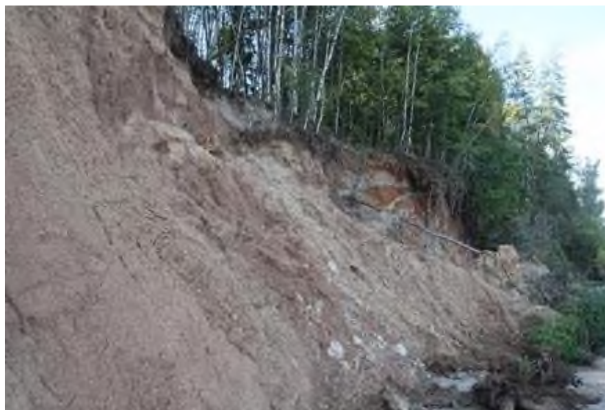
Рис. 2.2.35. Оползень северо-восточнее д. Юшково, вдоль правобережного склона р. Волга (Горьковское вдхр.), Пучежский район, Ивановская область
