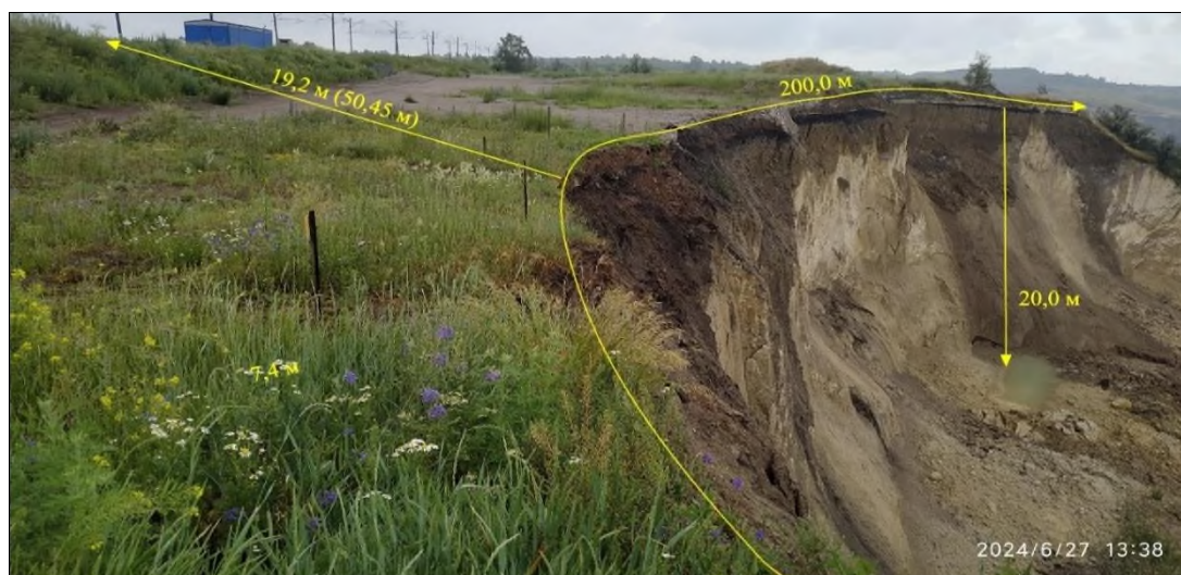
Рис. 2.2.141. Оползень, угрожающий железнодорожной линии. Красногорский участок, Челябинская область
