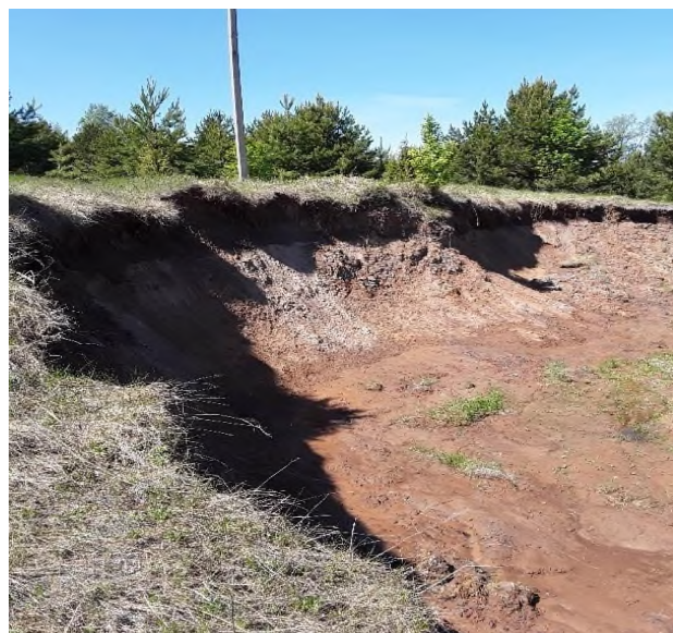
Рис. 2.2.83. Развитие овражной эрозии на Варангужском участке в Моркинском районе, Республика Марий Эл
