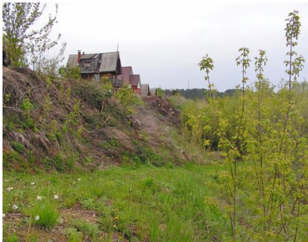
Рис.2.2.90. Южный фланг оползня, д. Докша, Завьяловский район, Удмуртская Республика
