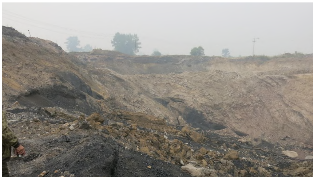
Рис. 2.2.211. Блоковый оползень, сформированный по трещине бортового отпора Букачачинский каменноугольный карьер Забайкальский край
