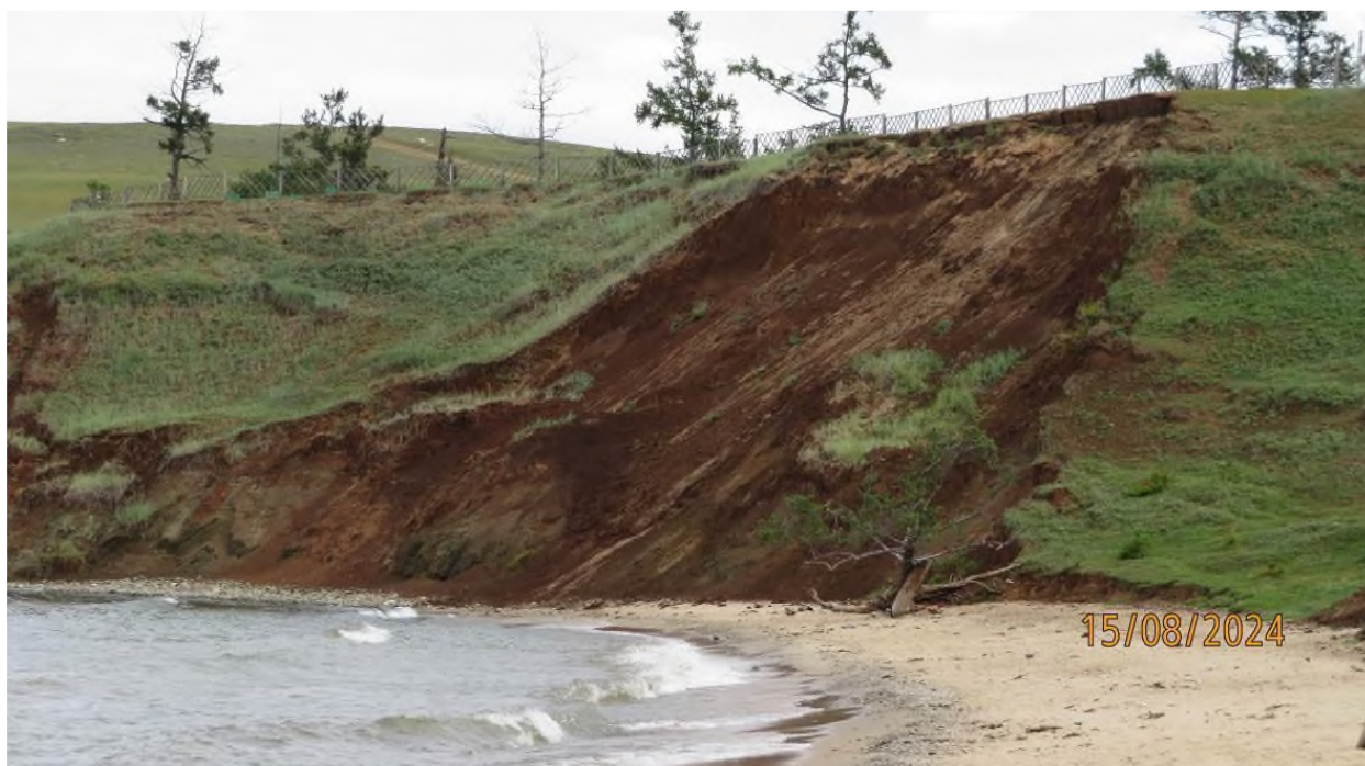
Рис. 2.2.181 Оползневые процессы на пункте наблюдений Сарайский, о. Ольхон, Иркутская область
