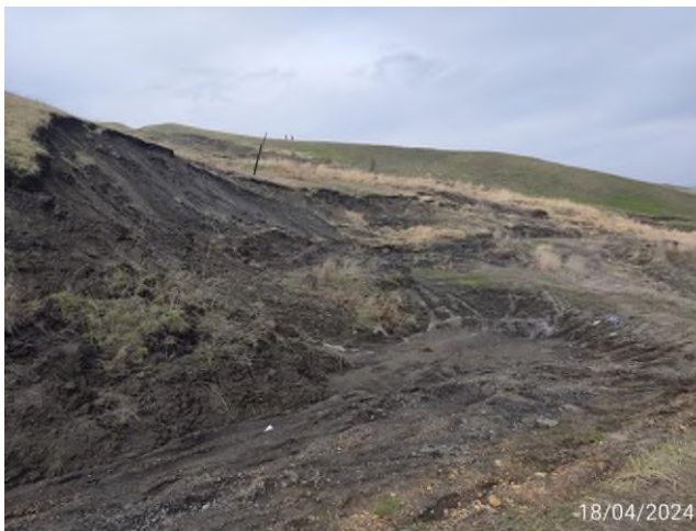
Рис. 2.2.104. Разрушенная грунтовая дорога и линия ЛЭП в районе лодочной станции «Шахтёр», г. Сызрань, Самарская область
