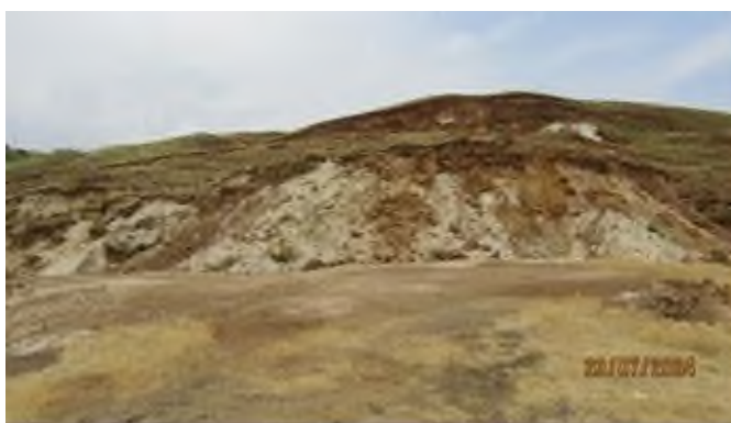
Рис. 2.2.64. Активный оползневой склон. Северная окраина станицы Раздорская, Донецкий район, Ростовская область
