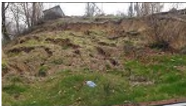
Рис. 2.2.61. Головная часть оползня в с. Каштаны. Адлерский район, г.о. Сочи, Краснодарский край. Дата съемки 27.02.2024 г.
