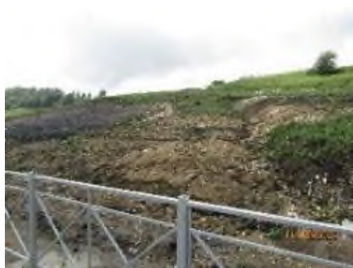
Рис. 2.2.75. Оползневой склон в верхнем борту дороги п. Белореченский – Верхняя база центр Спортивной Подготовки на 5,0 км (г. Кисловодск), Ставропольский край
