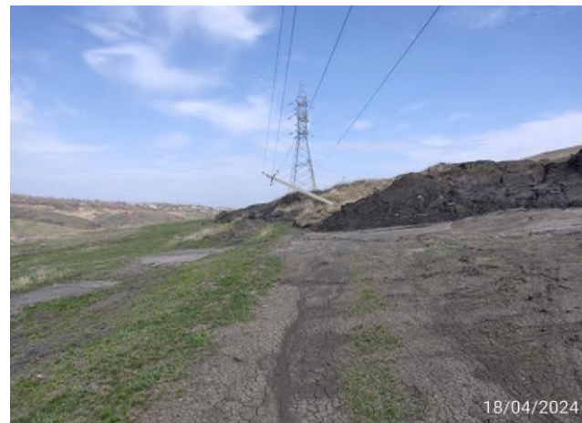
Рис. 2.2.103. Деформированная грунтовая автодорога и опоры ЛЭП. п. Кашпир, г.Сызрань, Самарская область
