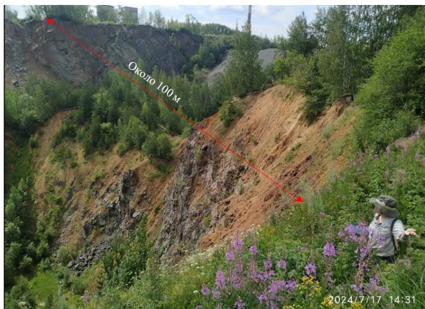
Рис. 2.2.128. Провал над шахтой Магнетитовая, вид со стороны ул. М. Горького. Нижнетагильский участок, Свердловская область
