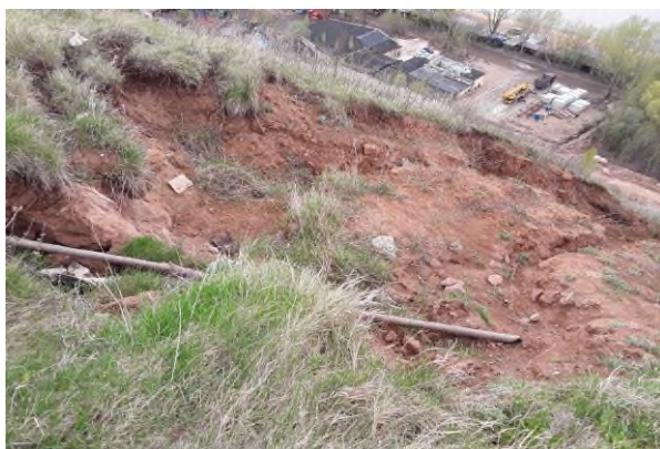
Рис. 2.2.96. Проявление оползневого процесса на Окском склоне, ниже ул. Елецкая, г. Нижний Новгород, Нижегородская область
