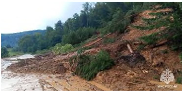
Рис. 2.2.79. Активизация оползневой массы. Автодорога с. Байназарово -д. Мурадымово, Бурзянский район, Республика Башкортостан
