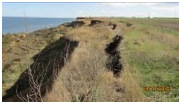
Рис. 2.2.56. Активизация оползневой оползневой процесса на побережье Темрюкского залива
