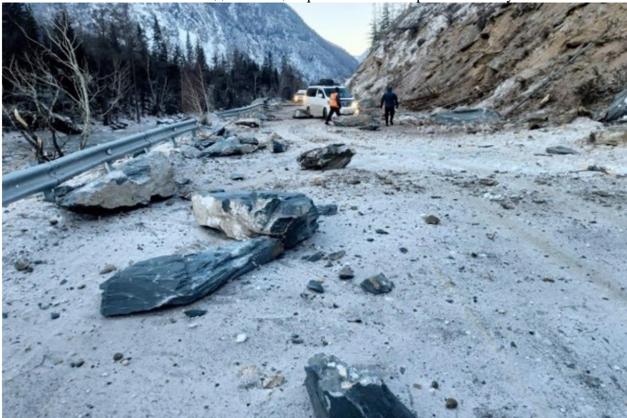
Рис. 2.2.166 Обвалившиеся глыбы на участке автодороги Р-256 (764-765км), Республика Алтай
