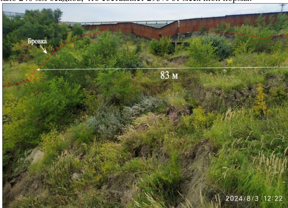
Рис. 2.2.151. Активизация оползневого процесса на борту Копейского разреза. Копейский участок оперативного обследования, г. Копейск Челябинская область
