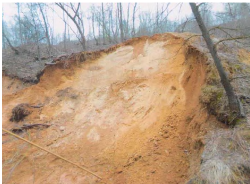
Рис. 2.2.43. Стенка срыва оползня на ул. Шевченко, г. Смоленск, Смоленская область
