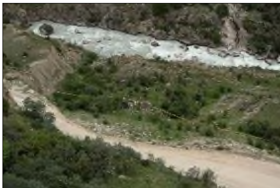
Рис. 2.2.70. Активный участок оползня на нижнем откосе а/д Урвань-Уштулу (А-154), Черекский район, Кабардино-Балкарская Республика
