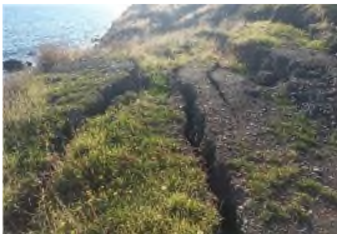
Рис. 2.2.53. Трещины закола в правом борту оползня с. Морское, г.о. Судак, Республика Крым.
