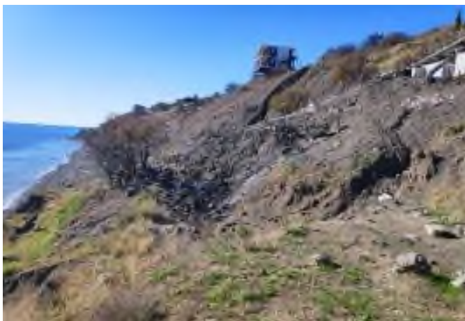
Рис. 2.2.52. Оползневой склон (общий вид). с. Приветное, г.о. Алушта, Республика Крым
