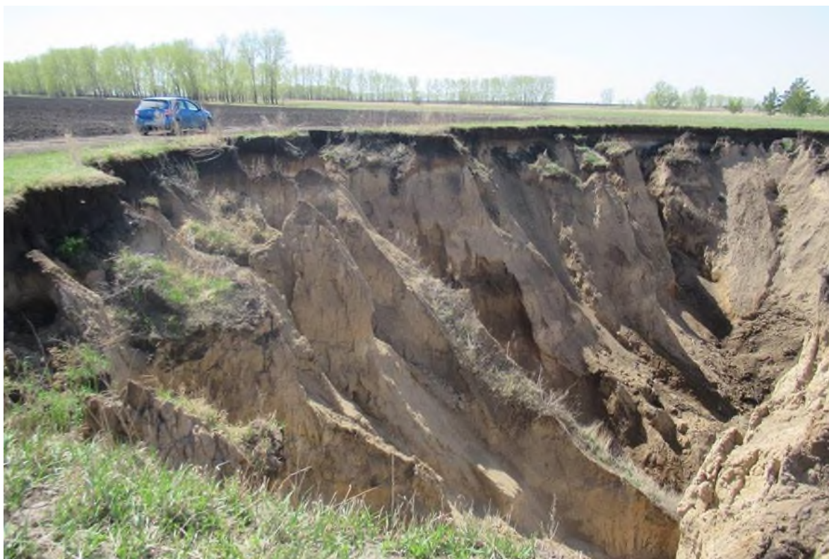
Рис. 2.2.173 Разрушение бортов оврага № 2 в с. Чернопятово Павловского района, Алтайский край
