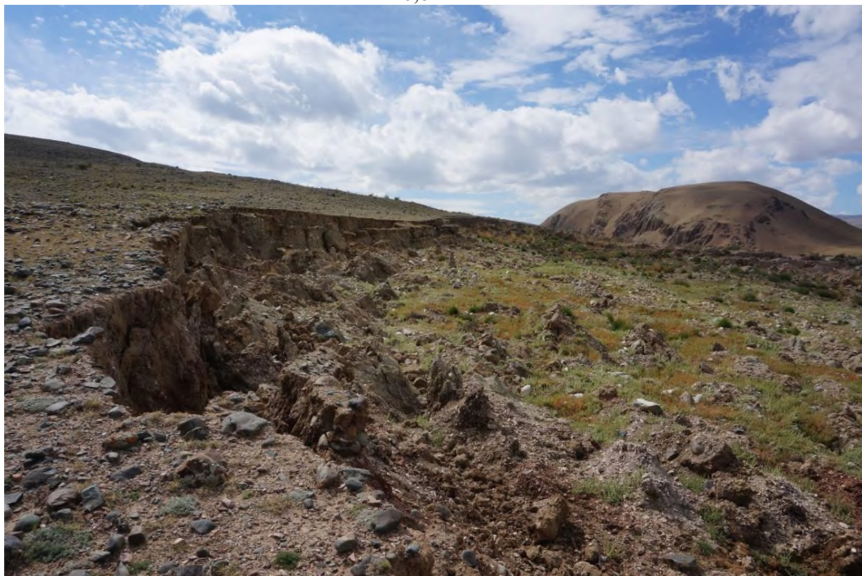
Рис. 2.2.163 Надоползневый уступ оползня. Пункт наблюдений Чуйский, Республика Алтай
