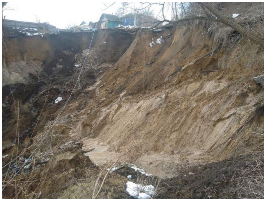
Рис. 2.2.34. Активный оползень в г. Новохоперск, Воронежская область
