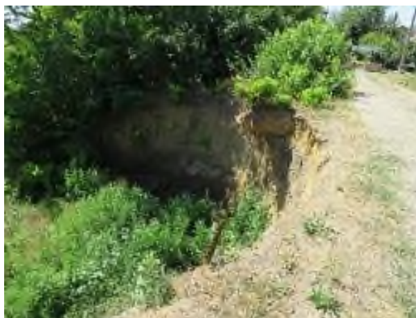
Рис. 2.2.74. Оползень на ул. Егорлыкской в станице Новотроицкой Изобильненского МО, Ставропольский край
