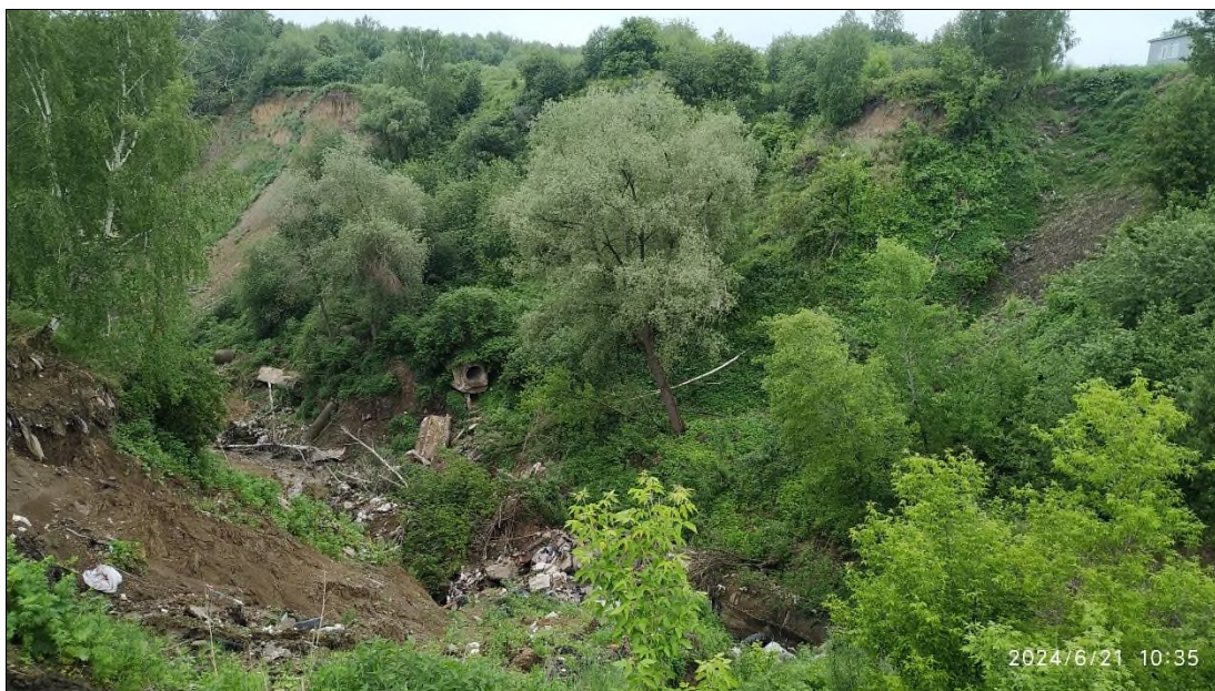
Рис. 2.2.133. Участок развития овражной эрозии по ул. С. Ремезова в районе ГСК «Сталкер» г. Тобольска. Участок Тобольский, Тюменская область
