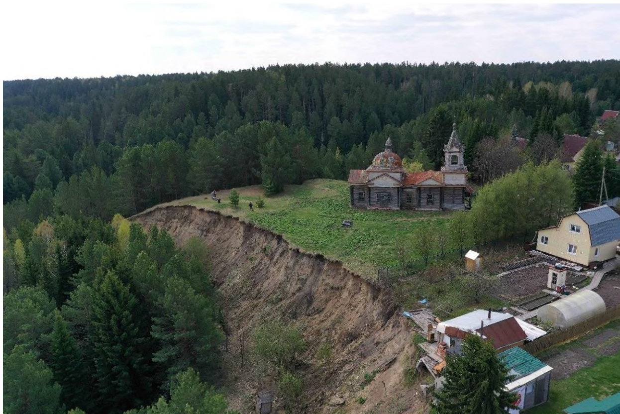
Рис. 2.2.188 Стенка отрыва оползня в д. Нагорный Иштан, Томская область
