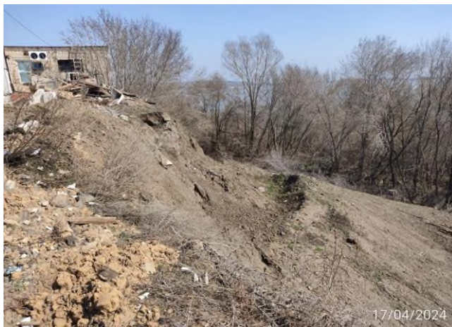
Рис. 2.2.102. Отсевший блок насыпных грунтов в верхней части оползня в районе магазина «Светофор» по ул. Декабристов, 82. г.Сызрань, Самарская область
