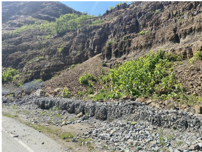
Рис. 2.47. Обвално-осыпной склон на 86 км автодороги Сахалинск – Холмск
