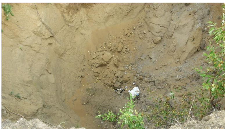
Рис. 2.52. Провал над старым шурфом на Тасеевском шахтном поле Забайкальский край
