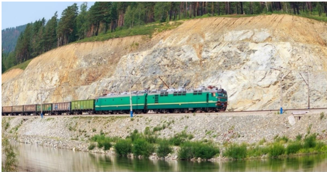
Рис. 2.59. Односторонняя железнодорожная выемка на 6226 км Забайкальский край
