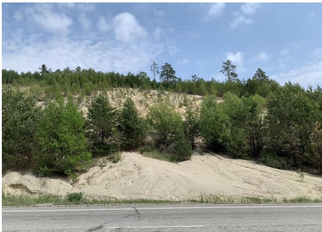
Рис. 2.29. Осыпные проявления на 88 км автодорога Свободный-Благовещенск Благовещенский район Амурской области 06.06.2024г.
