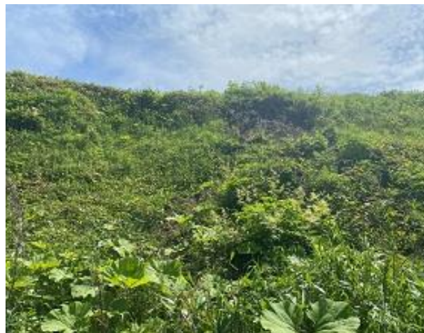
Рис. 2.41. Старый оползень без признаков активизации на ПН «Фабрициуса» Сахалинская область
