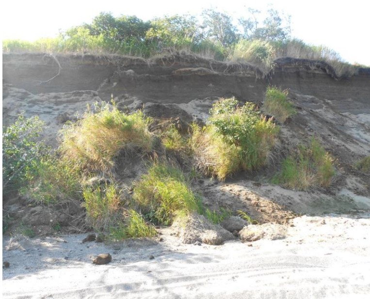
Рис. 2.35. Оползневые процессы на берегу Толмачевского озера Камчатский край
