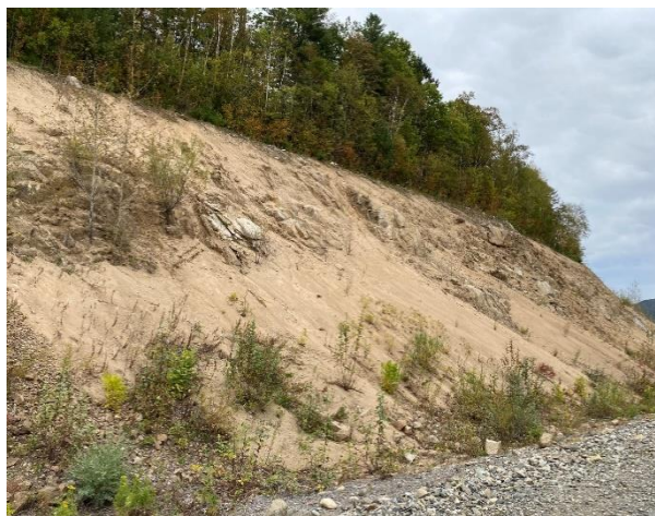
70 км А 376, ПН 27-1110-007, Нанайский район
