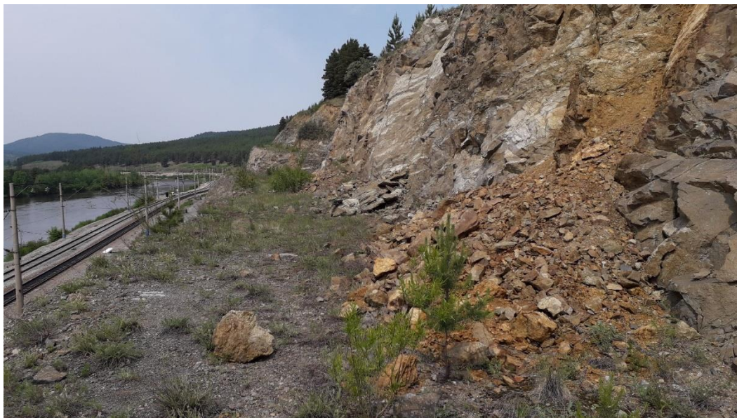
Рис. 2.60. Формирование обвальных и осыпных шлейфов у основания уступа на первой технологической полке выемки Забайкальский край
