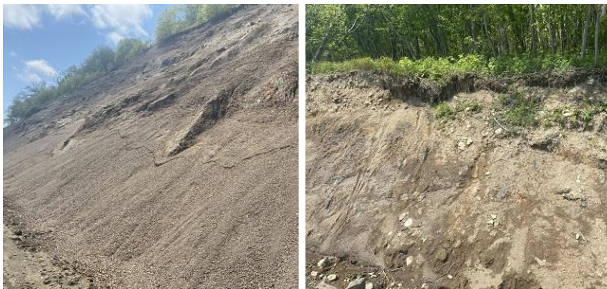
Рис. 2.42-2.43. Осыпные процессы на склонах вдоль дороги, идущей к карьёру на ПН «Угледарский»
