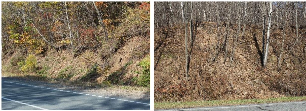
Рис. 2.13. Вид на проявления оползневой процесса на ПН «Шкотовский и «Кравцовский» Приморский край
