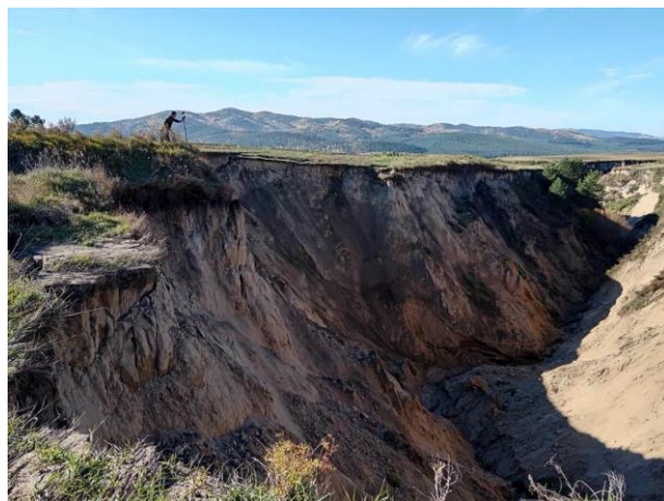
Овраг №2 Вид с вершины оврага. Оползание грунта
