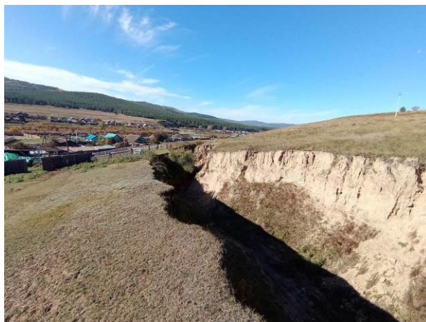
Вид на стенку оврага №1
