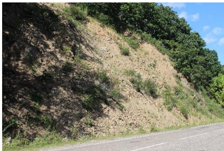
Рис. 2.20 Проявление осыпного процесса на участке 404, 1 км автодороги Находка-Лазо-Ольга-Кавалерово в 3.9 км с-в с. Синегорье Кавалеровского МО Приморского края, по состоянию на 28.08.2024 г.
