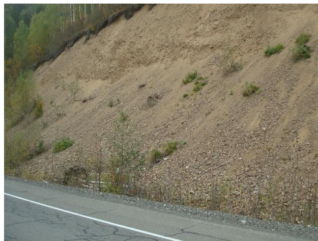
130 км А 376 ПН 27-1110-008 Нанайский район
