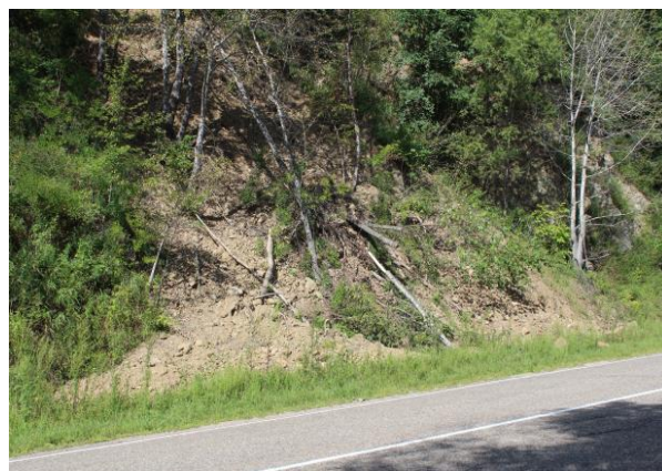
Рис. 2.16. Активизация оползневой процесса на участке 404,2 км автодороги Находка-Ольга-Кавалерово, 3,8 км с-с- в. Синегорье Кавалеровского района
