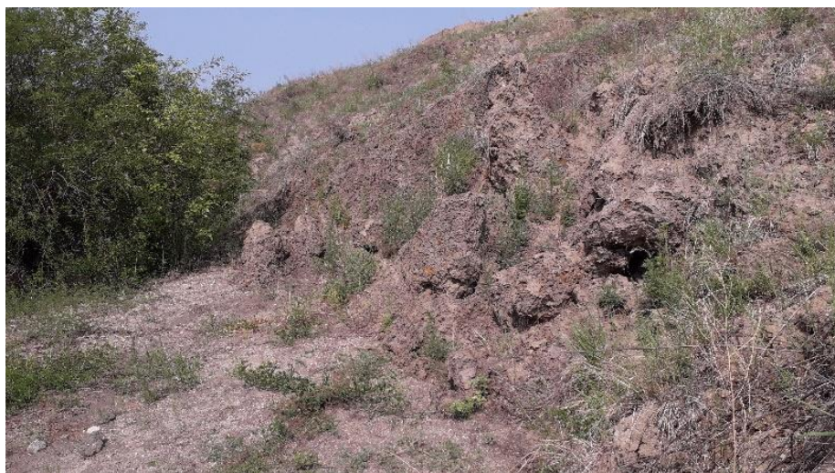
Рис. 2.55. Фронтальная часть оползня на Засопкинском карьере Забайкальский край
