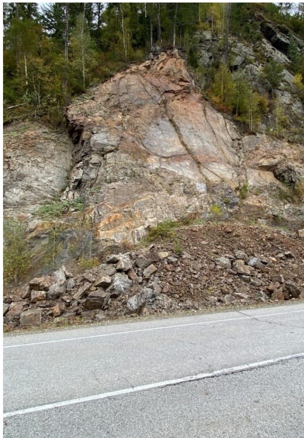
80 км А 376 , ПН 27-1110-008 Нанайский район
