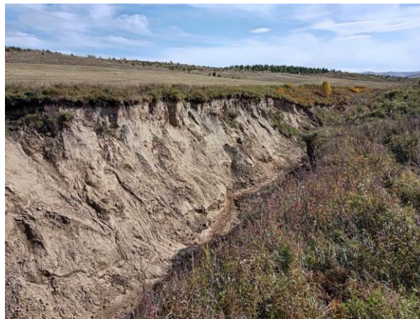
Вид на стенку оврага № 2
