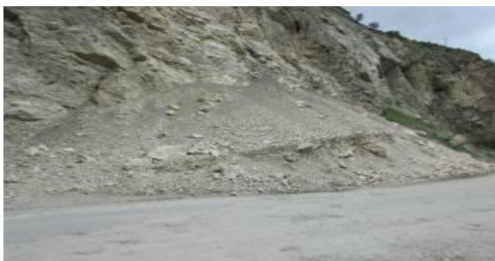
Рис.2.12. Перекрытие обвалом скальных пород участка автодороги «Карадах - Голотль» (км 24 + 950 м) Фото ООО «Даггеомониторинг»
