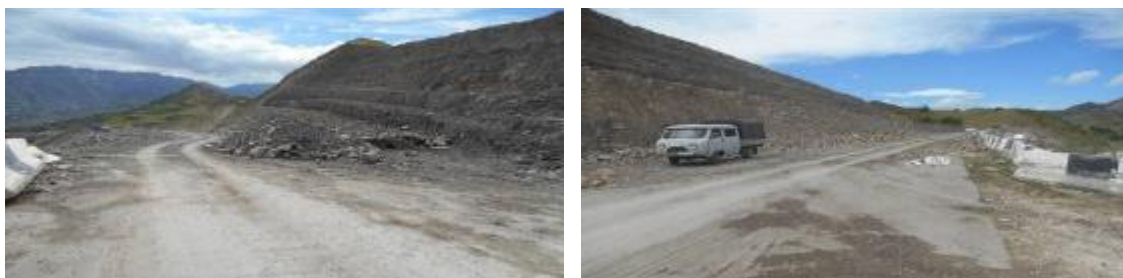
Рис.2.11. Оползневой процесс на участке автодороги Гуниб-Ругуджа км 4,4. Фото ООО «Даггеомониторинг»
