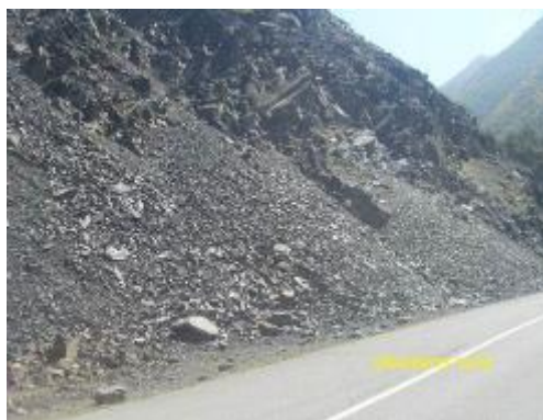
Рис. 2.13. Автодорога с.Галашки – с.Мужичи – 2,96 км Фото ООО «Центр ГИДИС»
