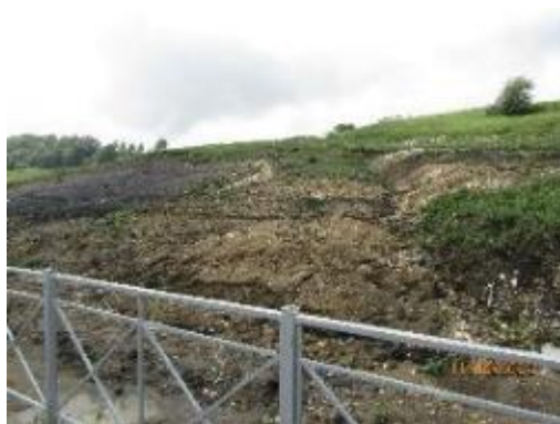
Рис. 2.25. Активизация оползневой процесса в верхнем борту дороги п. Белореченский – Верхняя база центр Спортивной Подготовки на 5,0 км (г. Кисловодск) Фото филиала ЮРЦ ГМСН ФГБУ «Гидроспецгеология»
