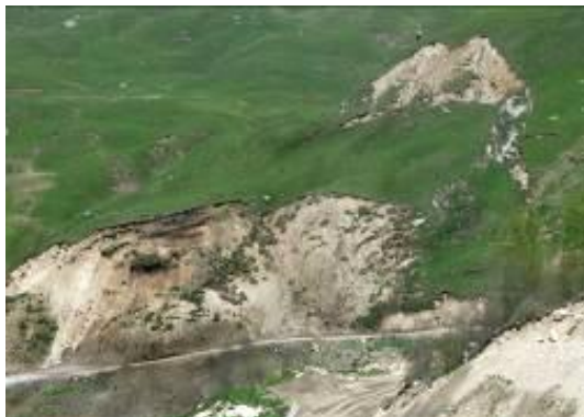
Рис. 2.18. Оползень на участке автодороги Камунта – В. Згид (16,5 км), Алагирский район. Фото ООО «Севосгеомониторинг»
