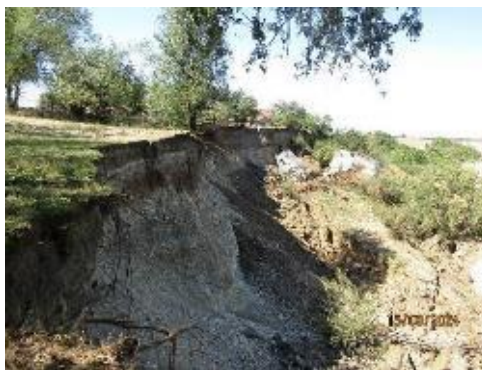
Рис. 2.17. Стенка срыва оползня на северо-восточной окраине а. Псыж, Абазинский район.
