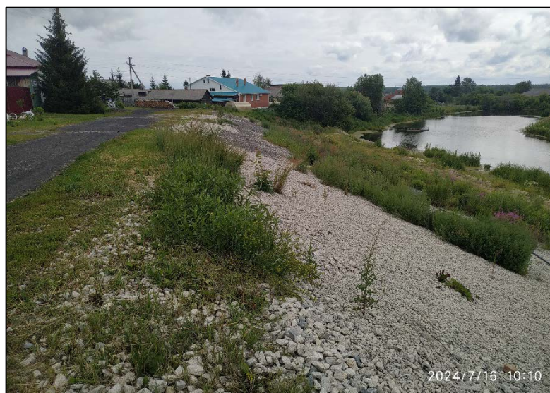
Рис. 2.28. Рекультивированный оползневой склон в пер. Южный с. Усть-Ницинское, Свердловская область
