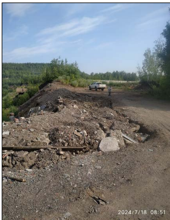
Рис. 2.31. Оползень на борту Меднорудянского карьера. Участок Нижнетагильский, Свердловская область
