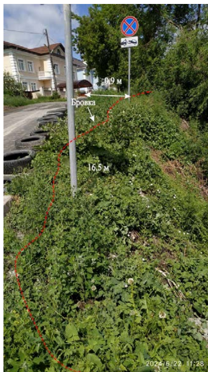
Рис. 2.43. Оползневой участок на ул. Фридриха Энгельса в г. Тюмень.
