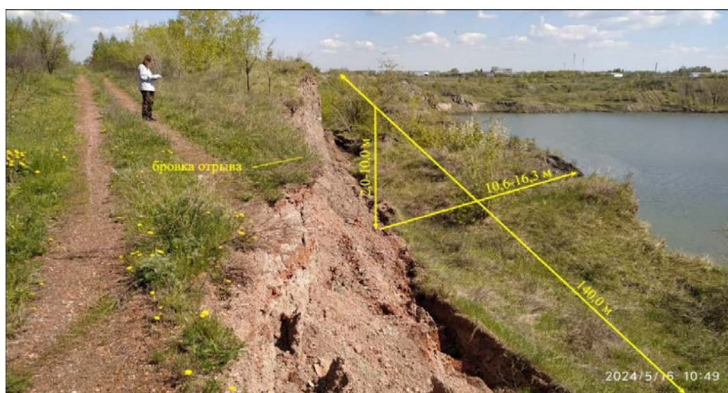
Рис. 2.57. Оседание блока по борту Копейского разреза в ТН 12.
