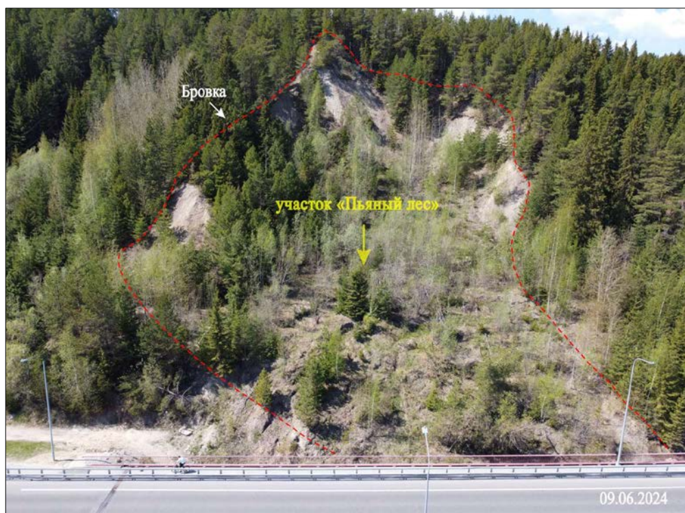
Рис. 2.71. Оползневой участок на Восточной объездной дороге. Ханты-Мансийский участок, ХМАО-Югра
