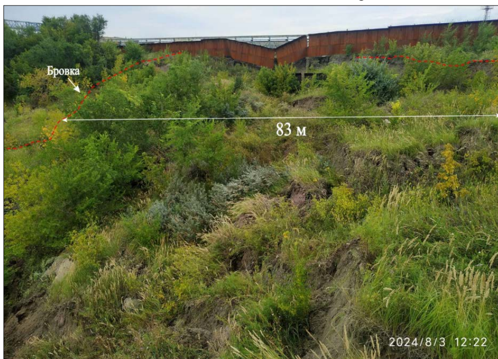
Рис. 2.69. Активизация оползневого процесса на борту Копейского разреза. Копейский участок оперативного обследования, г. Копейск Челябинская область
