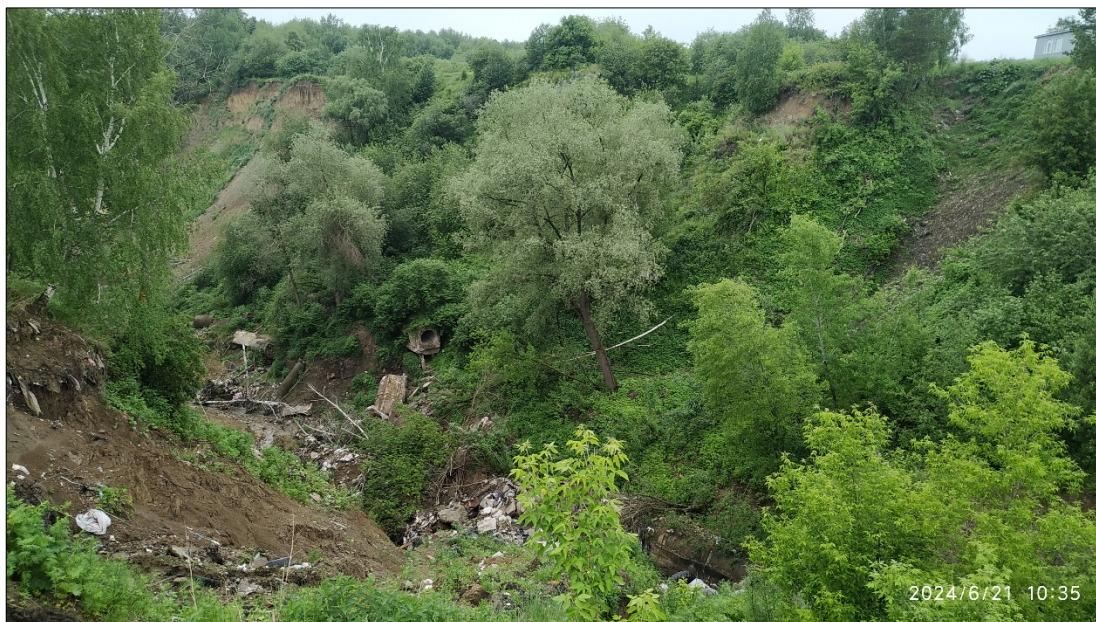
Рис. 2.47. Участок развития овражной эрозии №1 по ул. С. Ремезова в районе ГСК «Сталкер» г. Тобольска. Участок Тобольский, Тюменская область
