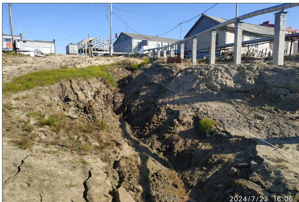
Рис. 2.79. Овражная термоэрозия на участке поверхностного водозабора в с. Сеяха (ТН 13а). Сеяхинский пункт наблюдений, ЯНАО
