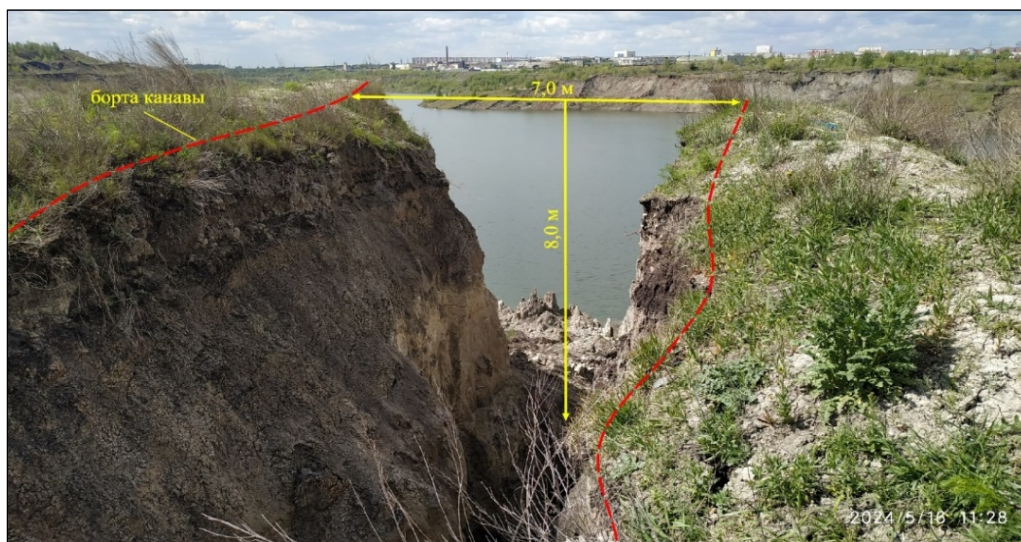
Рис. 2.67. Активизация процесса овражной эрозии на участке сброса сточных вод в Копейский разрез (ТН 13). Копейский участок, Челябинская область
