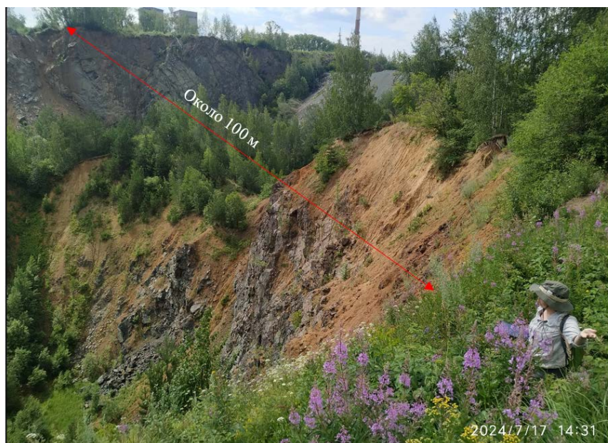
Рис. 2.40. Провал над шахтой Магнетитовая, вид со стороны ул. М. Горького. Нижнетагильский участок, Свердловская область
