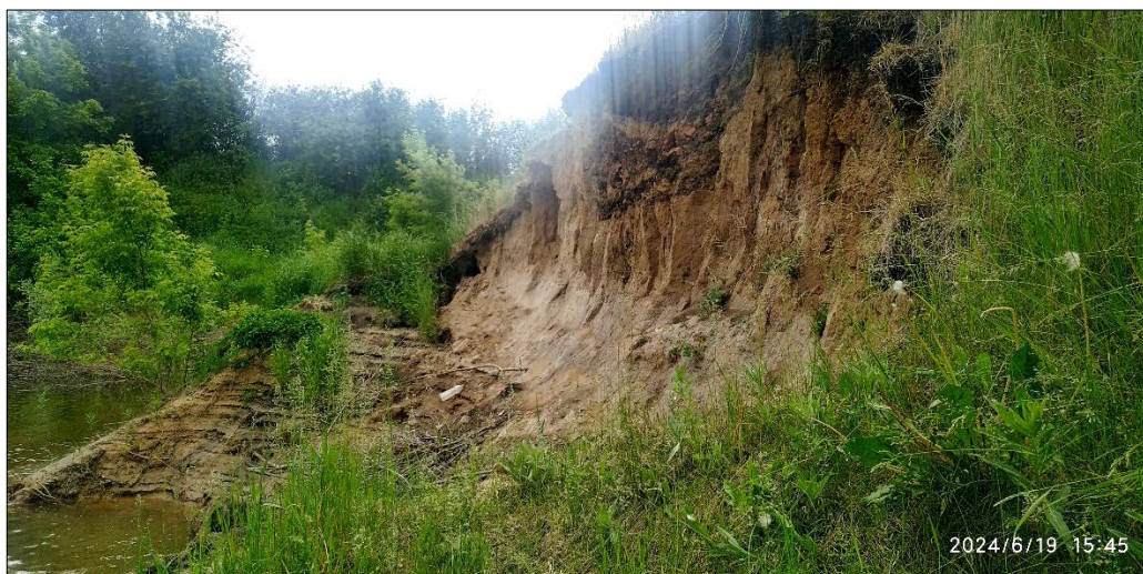
Рис. 2.44. Участок развития оползневого процесса вдоль ул. Береговая, на левом берегу р. Ишим. Участок Абатский, Тюменская область
