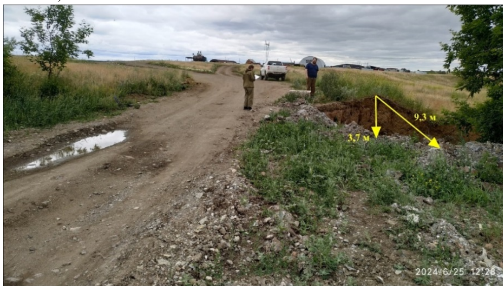
Рис. 2.68. Вершина оврага в пос. Тогузак в районе дома № 2 по ул. Правобережная (ТН 25). Троицкий участок Челябинская область
