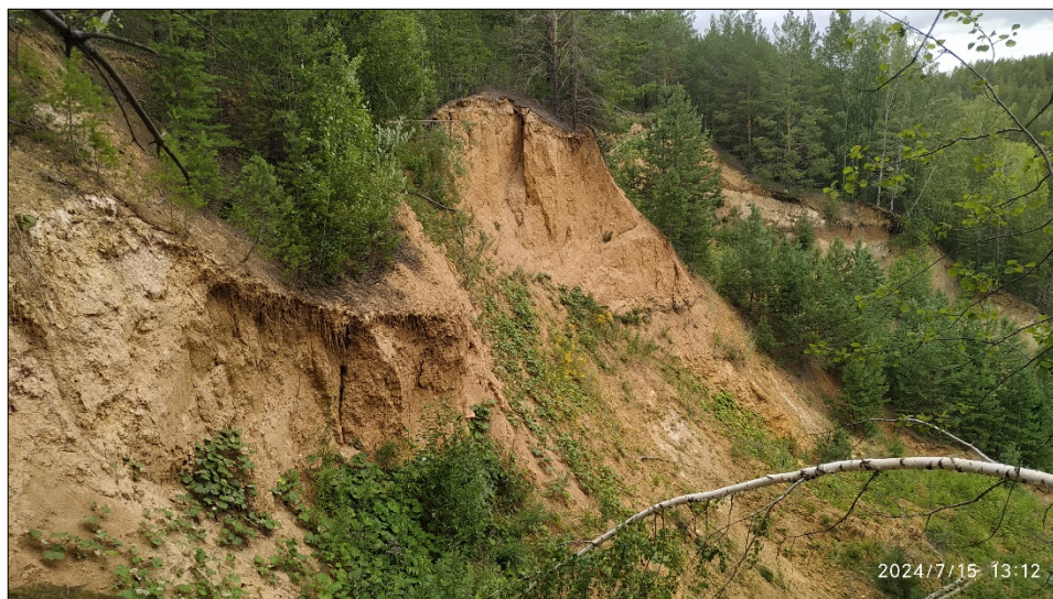
Рис. 2.30. Оползание северного борта карьера залежей 3, 4, 5. ТН С68-1. Участок Липовский, Свердловская область
