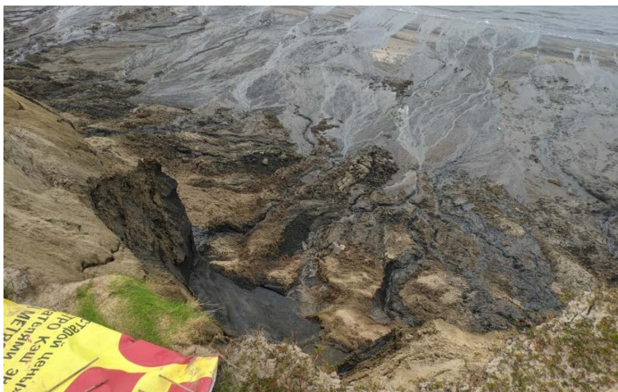
Рис. 2.87. Пораженность криогенными процессами берегового уступа на площадке «3-99». Геокриологический полигон Марре-Сале, ЯНАО
