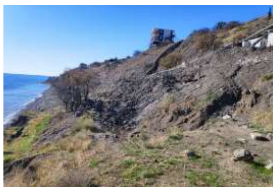
Рис. 2.50. г.о. Алушта, с. Приветное. Оползень «Приветное III» (746), нижняя часть. Зона активных оползневых проявлений. Общий вид
