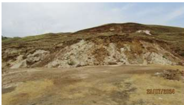
Рис. 2.26. Крупная активизация оползневого процесса. Усть-Донецкий район, северная окраина станицы Раздорская.
