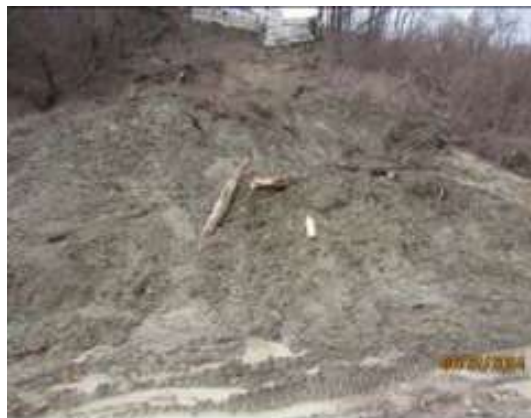
Рис. 2.16. Оползневая активизация в районе улиц Калараша и Кириченко на северо-западной окраине г. Туапсе
