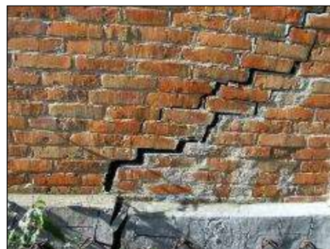
Рис. 3.11 Возникновение разрывных смещений и крупных трещин на побережье при извержении подводного грязевого вулкана Голубицкий, 2015 г. а - смещение на песчаном пляже; б - трещины в фундаменте и стенах зданий.
