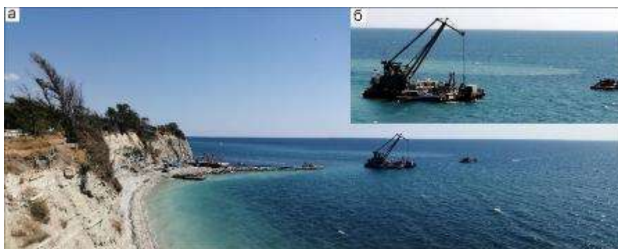
Рис. 3.55. Ремонтные работы на подводном выпускном коллекторе с очистных сооружений
