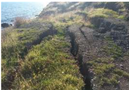
Рис. 2.53 г.о. Судак, с. Морское. Оползневые смещения в правом борту оползня
