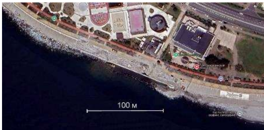
Рис. 3.56. Ремонтные работы по восстановлению набережной на участке ФТ «Сириус» (мыс Константиновский, космоснимок с ресурса https://yandex.ru/maps/ )
