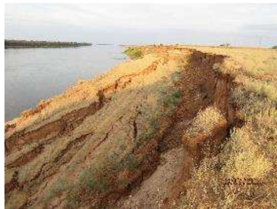
Рис. 2.22. Оползень в 5 км от с. Пришиб. Активный оползень на западном фланге оползневой ступени. Происходит разрушение оползневой ступени.
